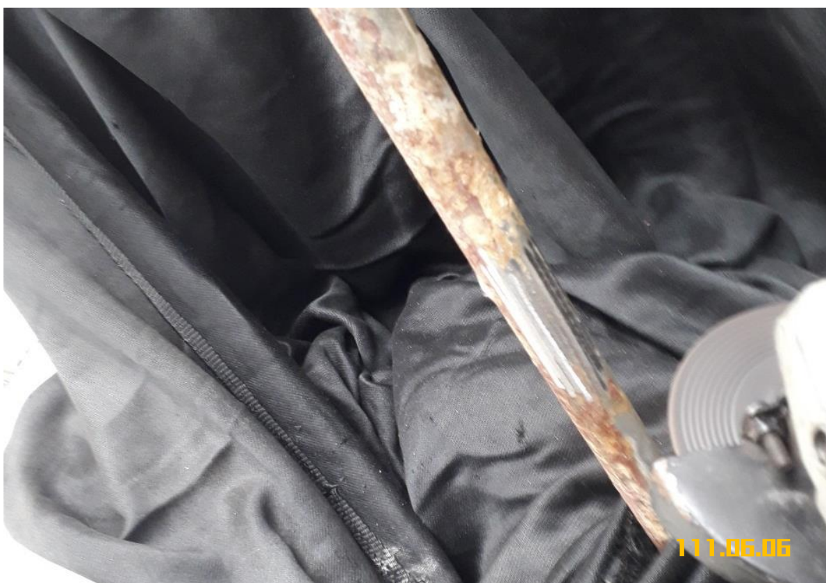
2. 施工位置管線研磨作業
