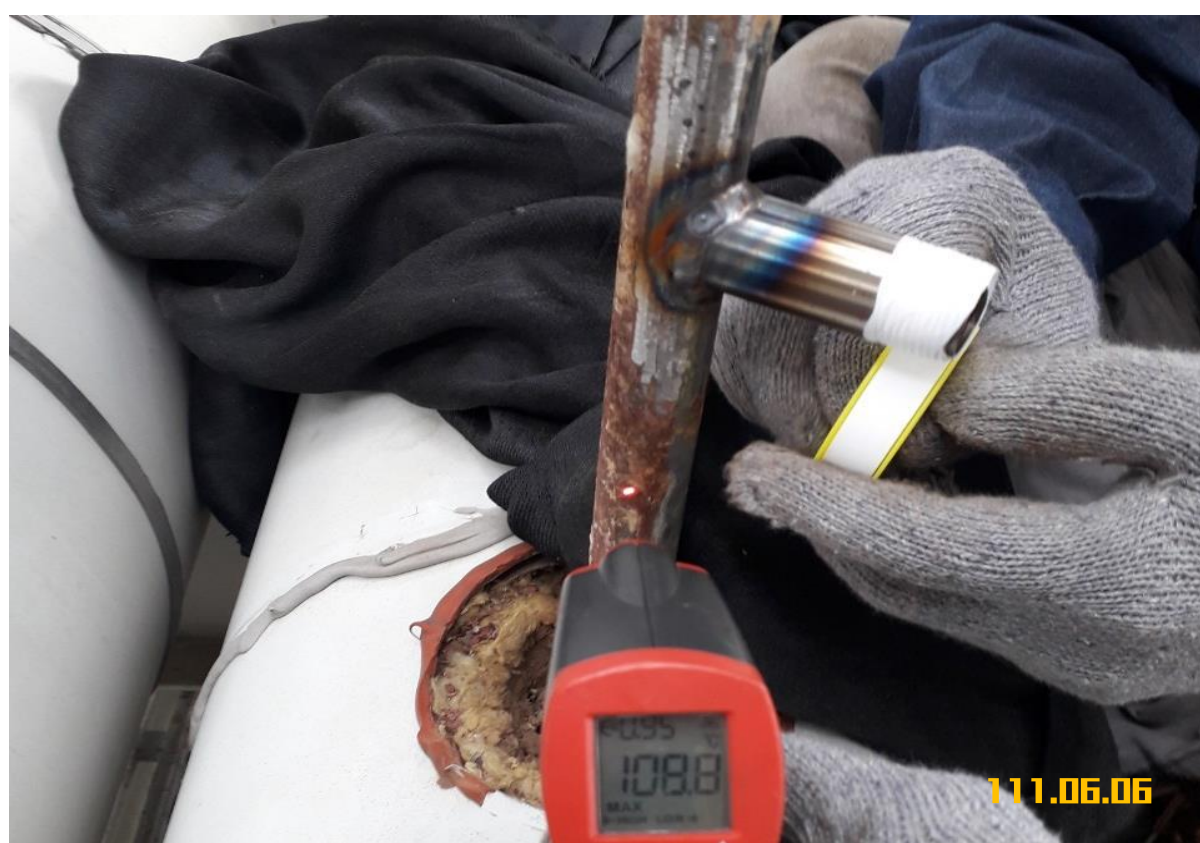
3. 模具焊接及管線溫度測量作業
