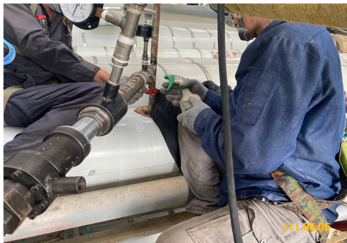
4. 人員試壓後進行開孔作業
