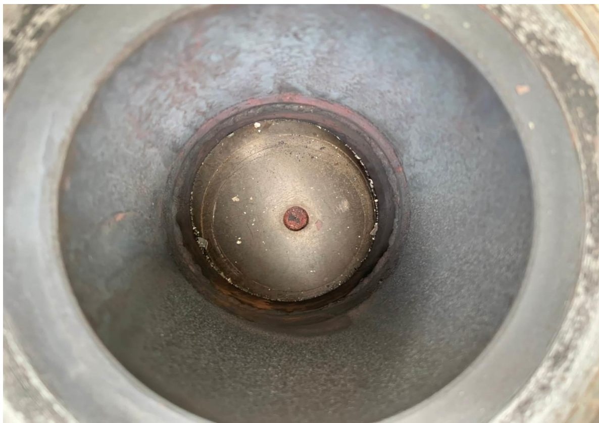
7. 阻斷完成管內情形，阻斷率 99%
