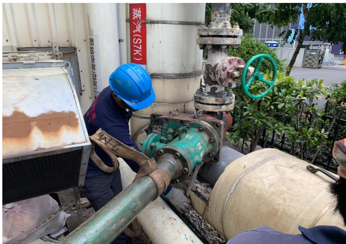
6. 安裝阻斷機具後進行阻斷作業
