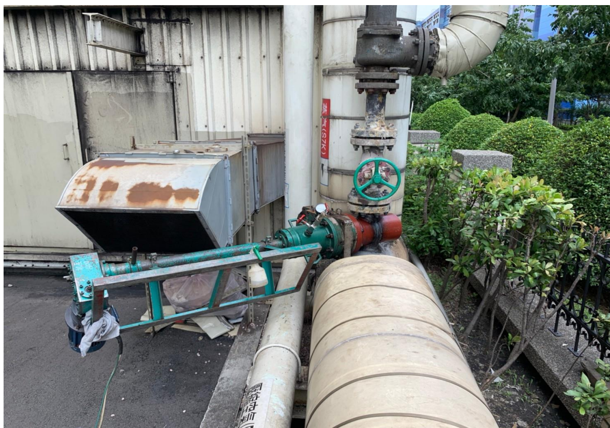
4. 開孔機具安裝作業
