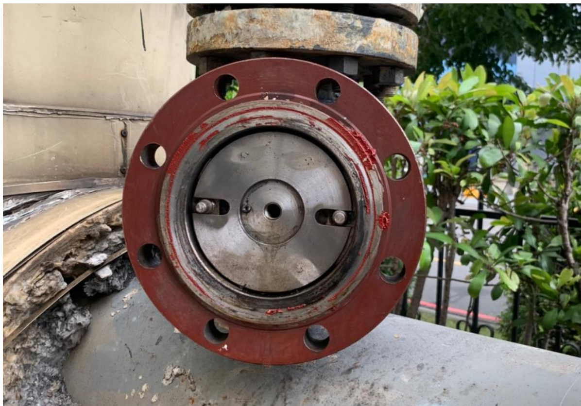
10. 安裝內塞頭完成
