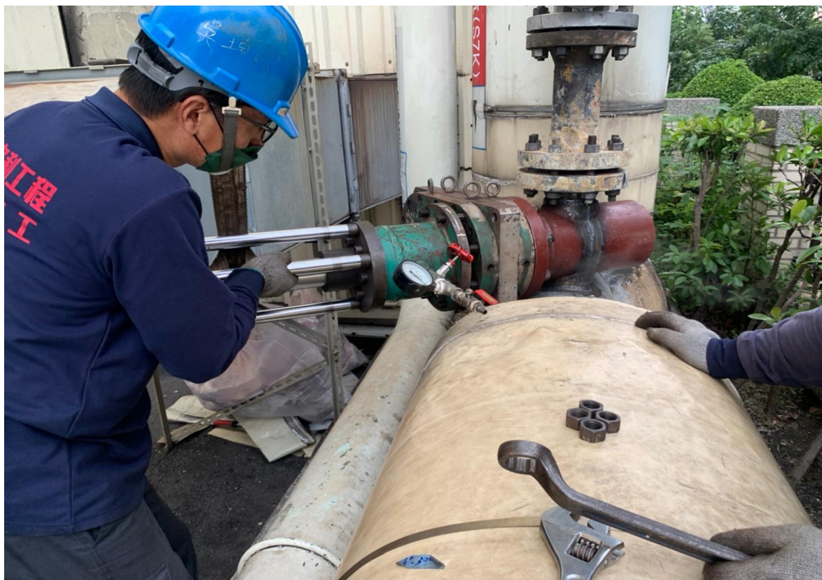
9. 人員進行下堵作業
