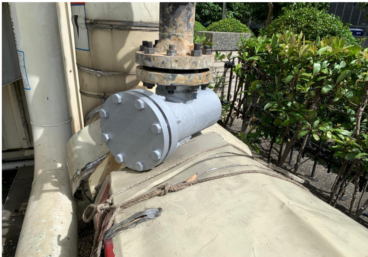
12. 施工後油漆作業完成
