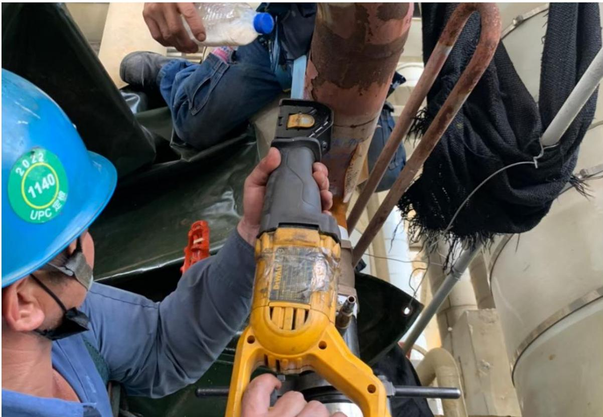
18. 阻斷後交由配管進行切管作業
