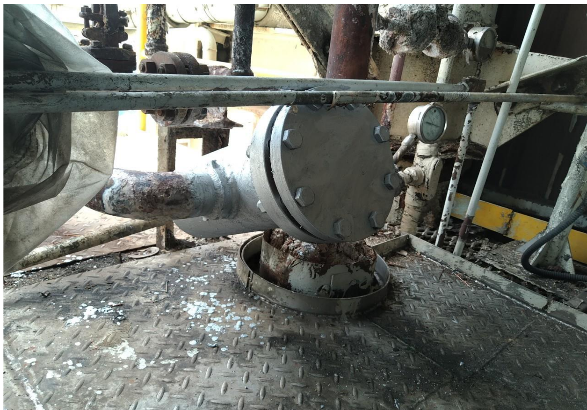
13. 施工完成安裝盲法蘭
