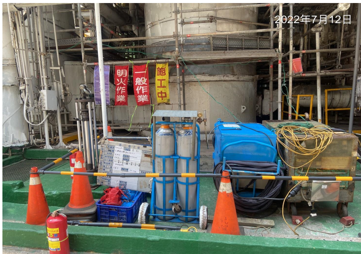
1. 施工機具定位情形
