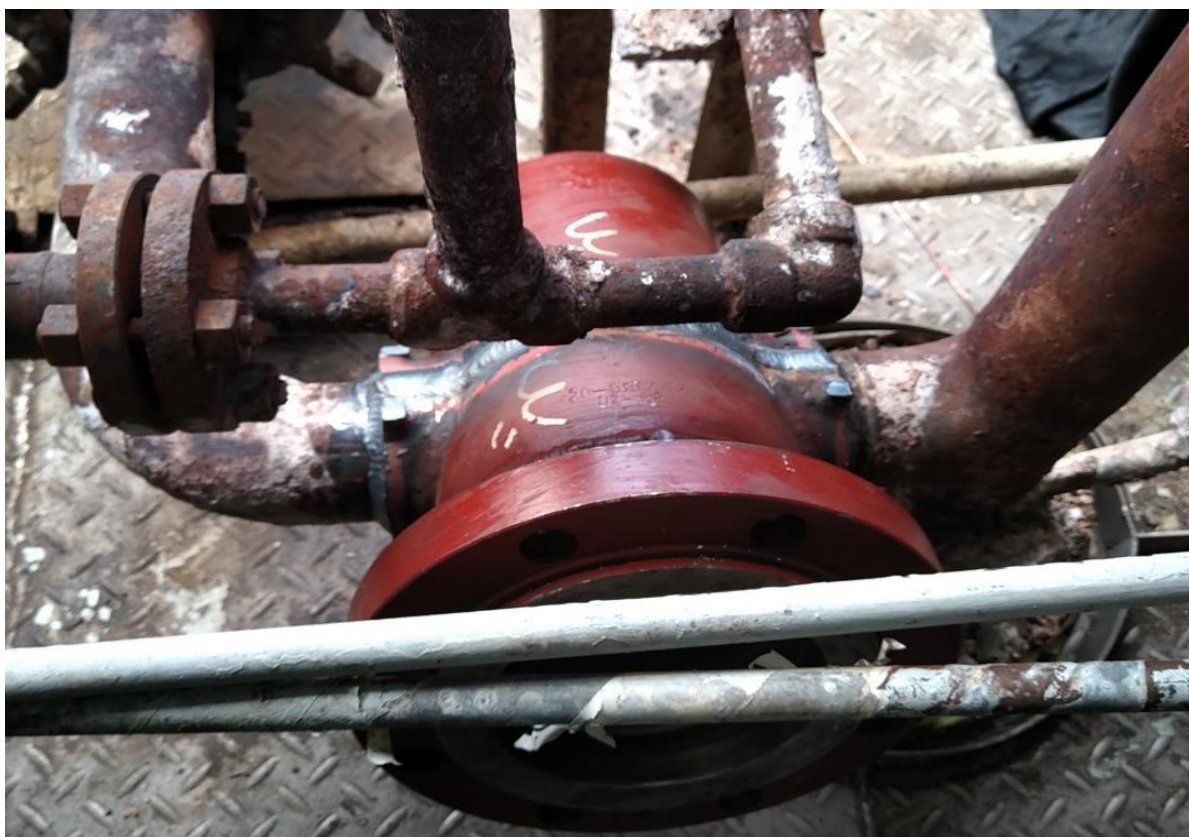
4. 模具焊接完成
