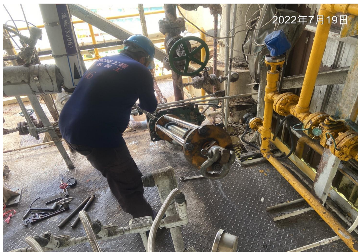
10. 人員進行下堵作業(1)
