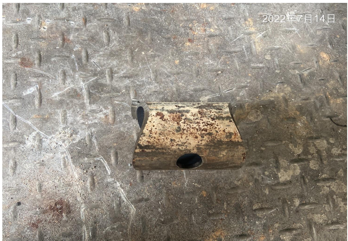
6. 斷管完成，確認料塊取出
