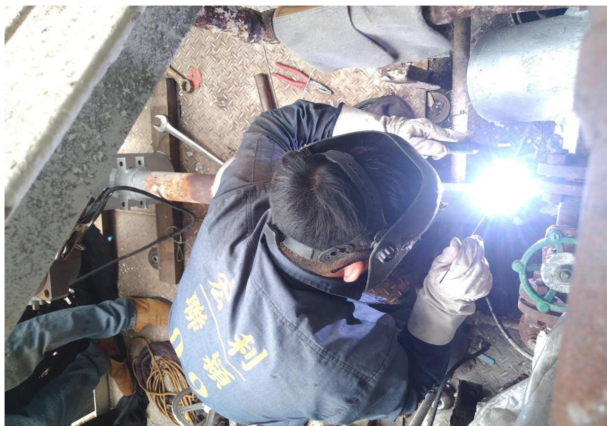
9. 新管焊接作業
