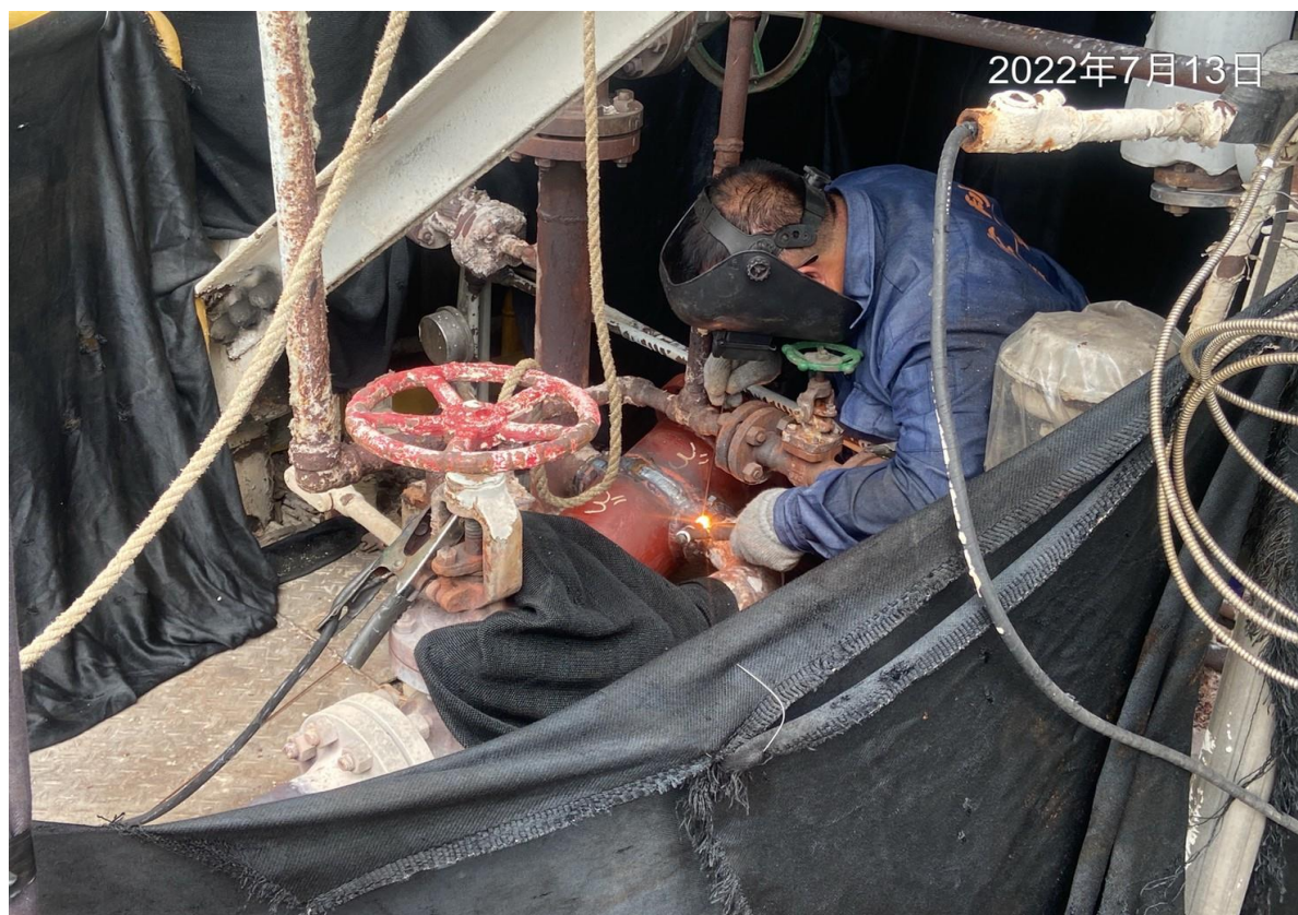
3. 焊接防火毯防護情形
