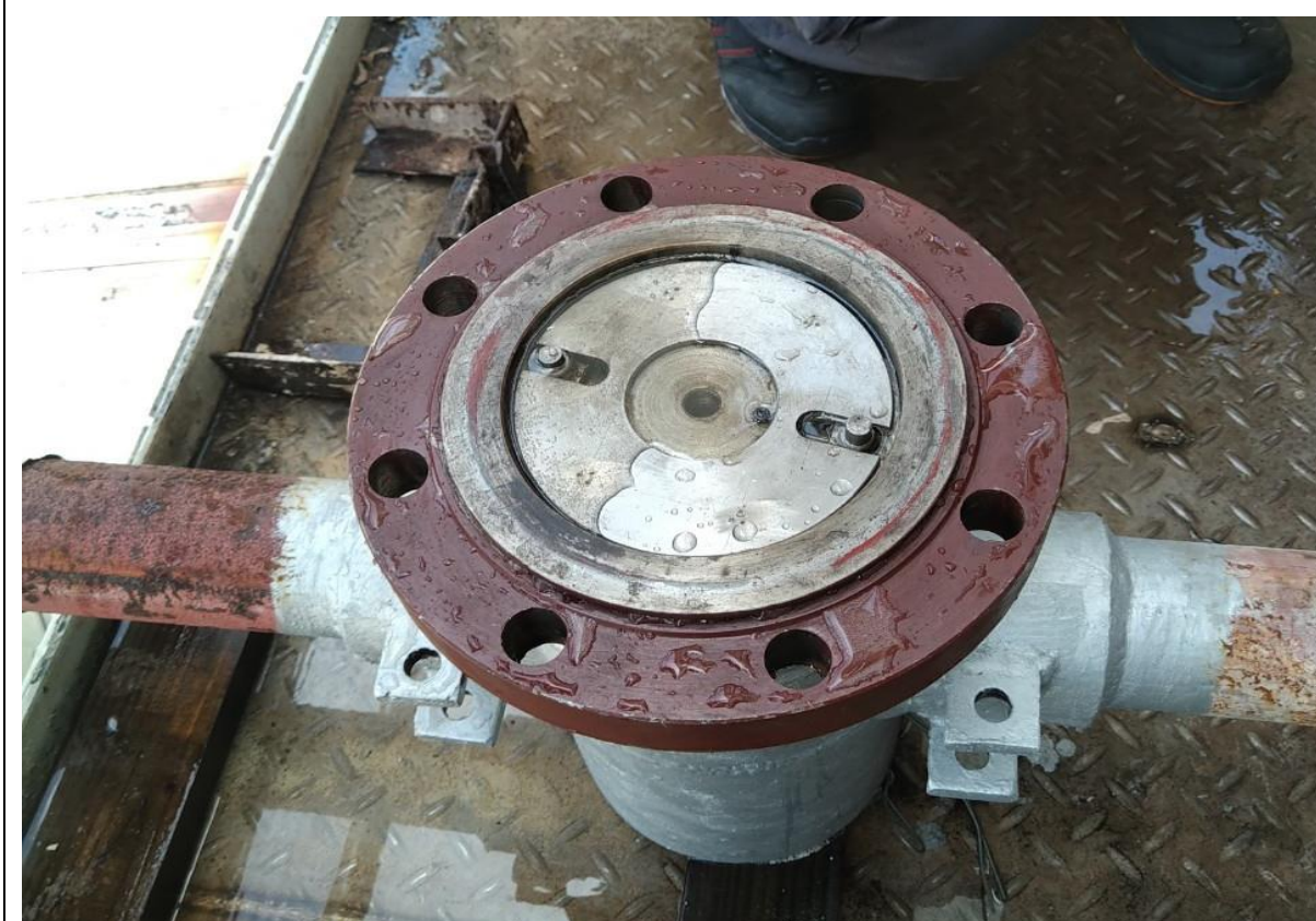
12. 施工完成油漆作業
