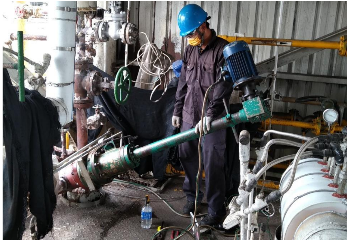
5. 開孔機具安裝並進行斷管作業
