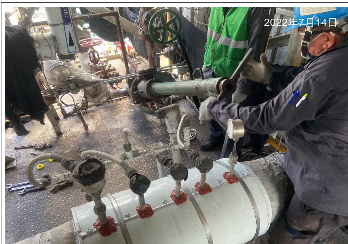
7. 安裝阻斷器後進行阻斷作業並排壓
