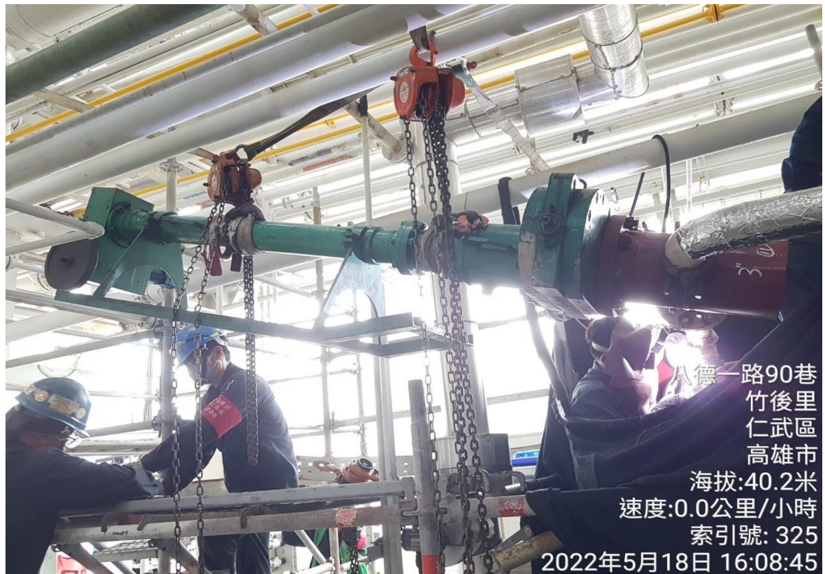
3. 安裝夾板閥及開孔機具
