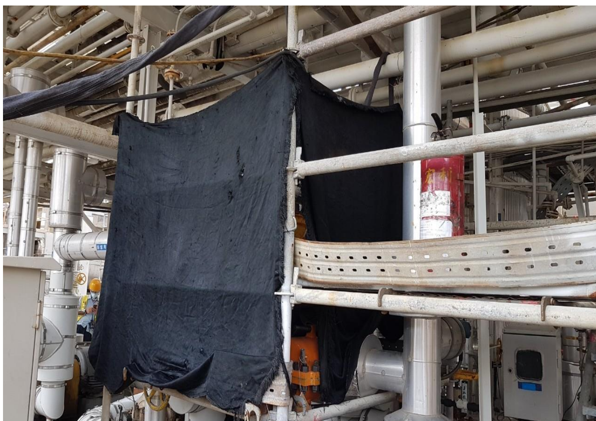
2. 防火毯鋪設情形
