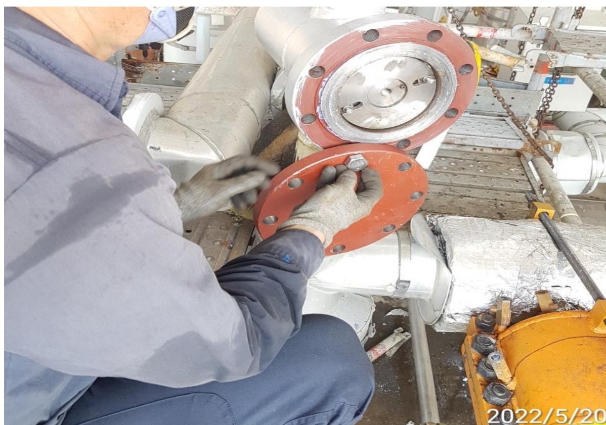
8. 下堵完成，機具移除
