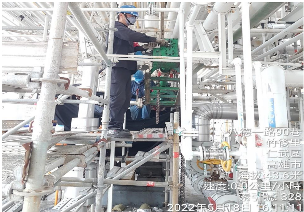
4. 試壓作業後進行斷管作業
