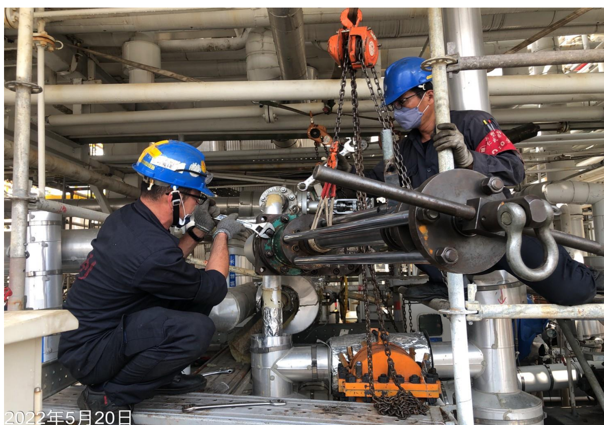
7. 安裝下堵器作業
