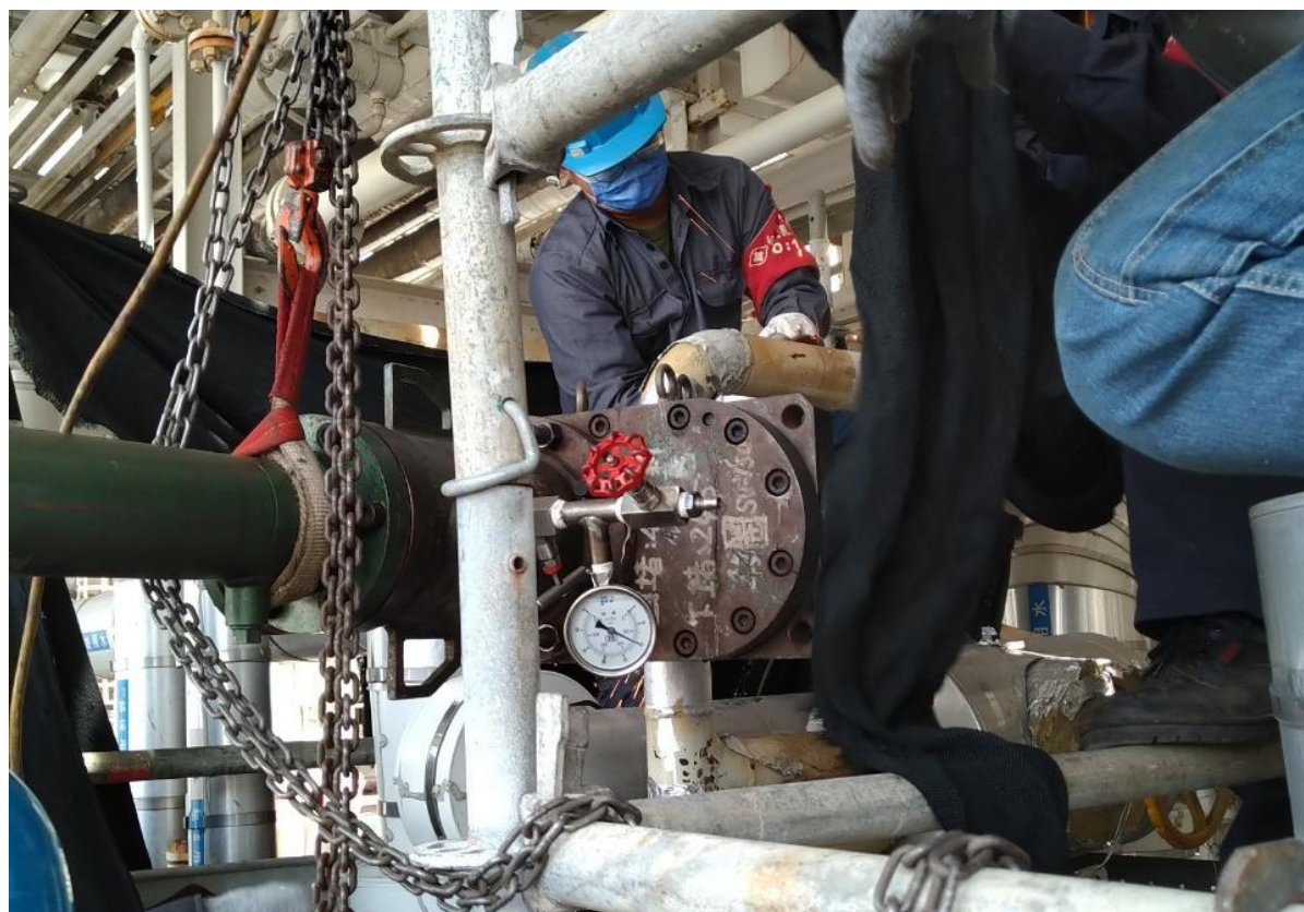
5. 安裝阻斷器進行阻斷作業
