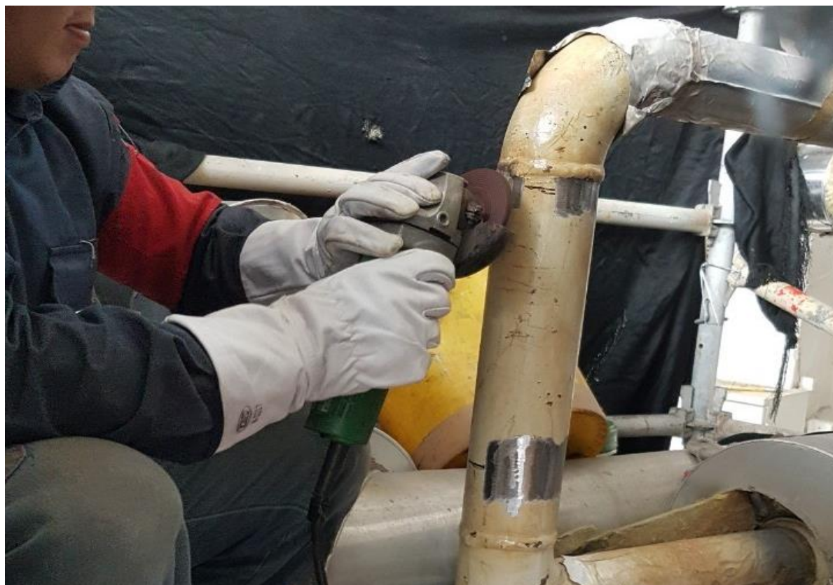
1. 管線研磨後進行模具焊接作業
