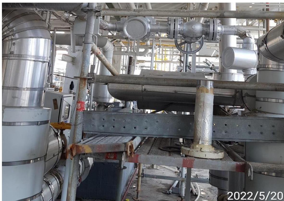
10. 高壓鍋爐水 3"雙阻斷增設閥件施工完成
