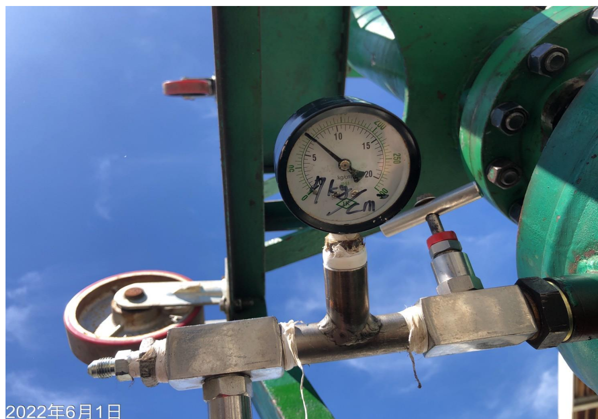
6. 開孔前試壓作業
