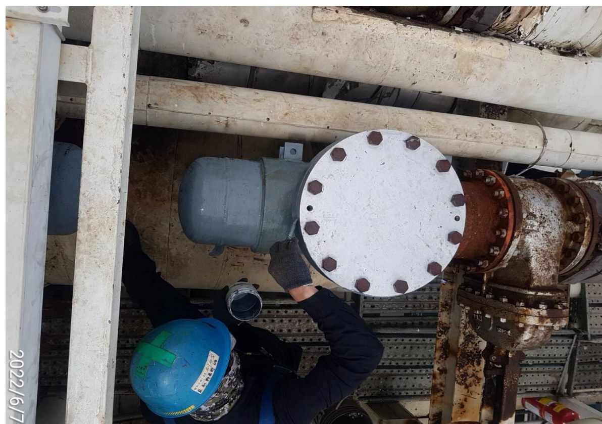
12. 施工完成進行油漆作業
