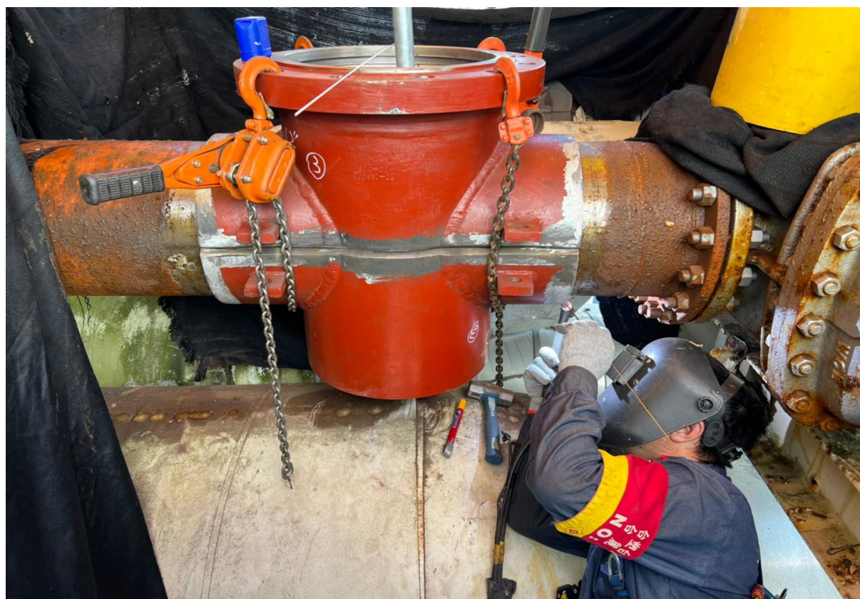
3. 管線研磨後進行組焊作業
