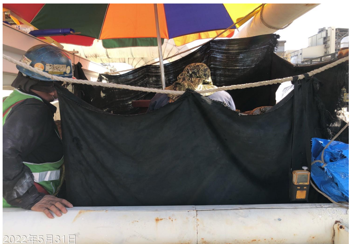
4. 防火毯鋪設情形
