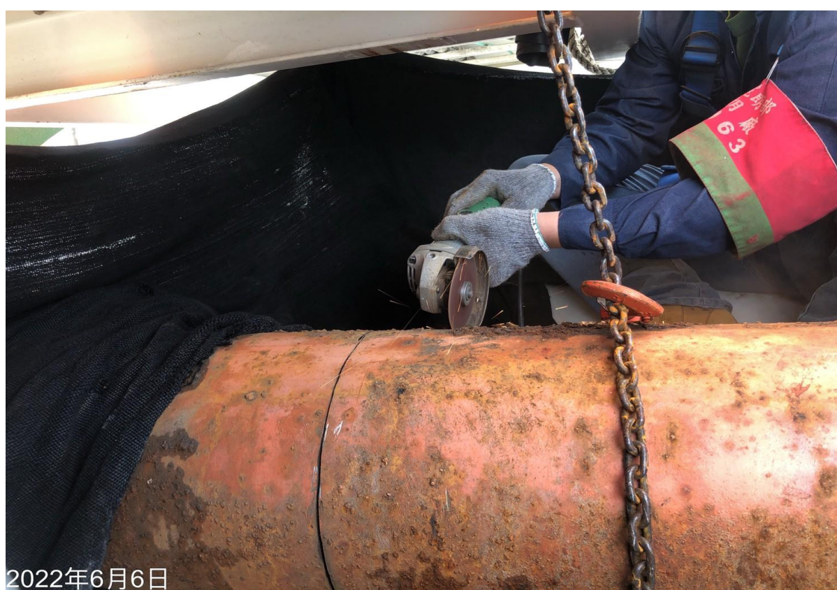
9. 阻斷完成進行切管作業
