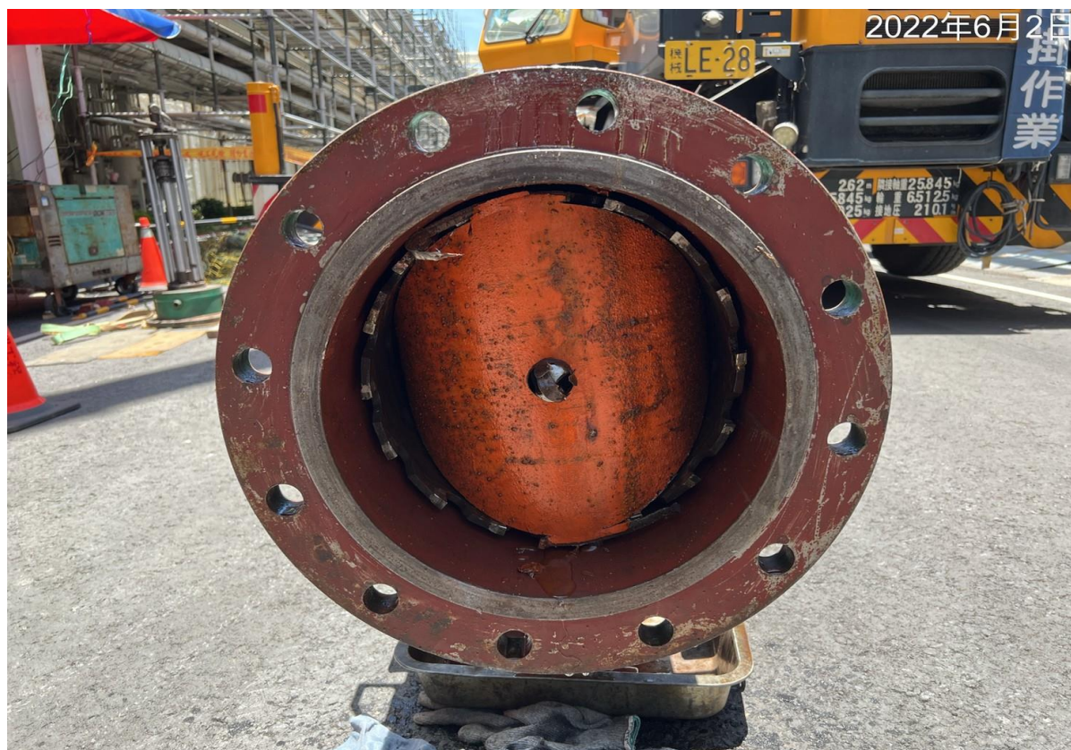
7. 斷管完成確認料塊取出
