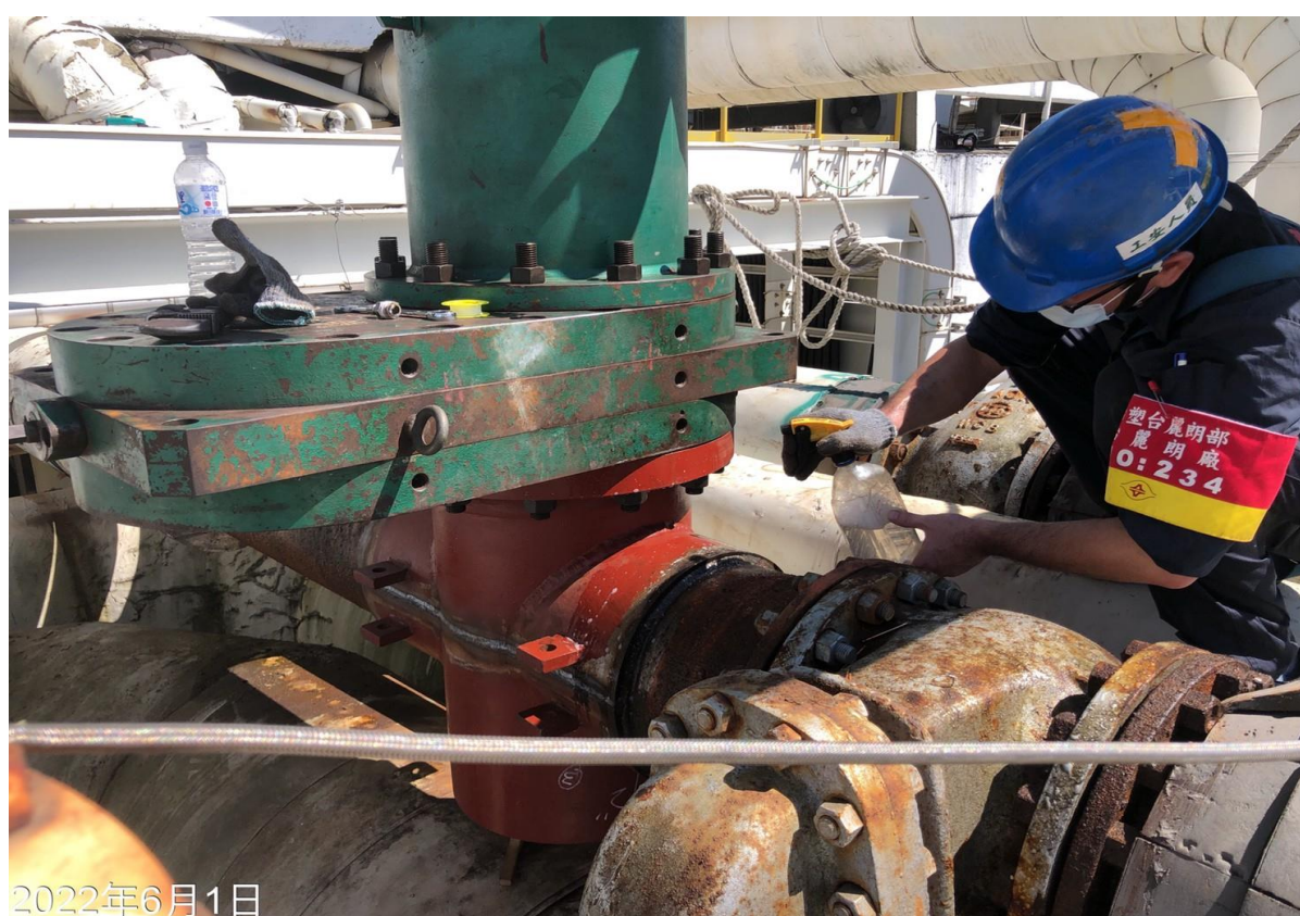
5. 人員安裝開孔機及夾板閥情形
