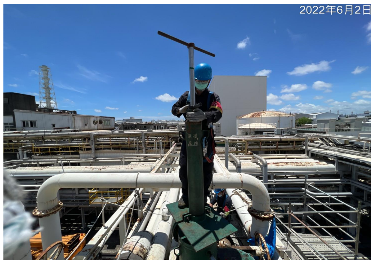
8. 安裝阻斷器進行阻斷作業
