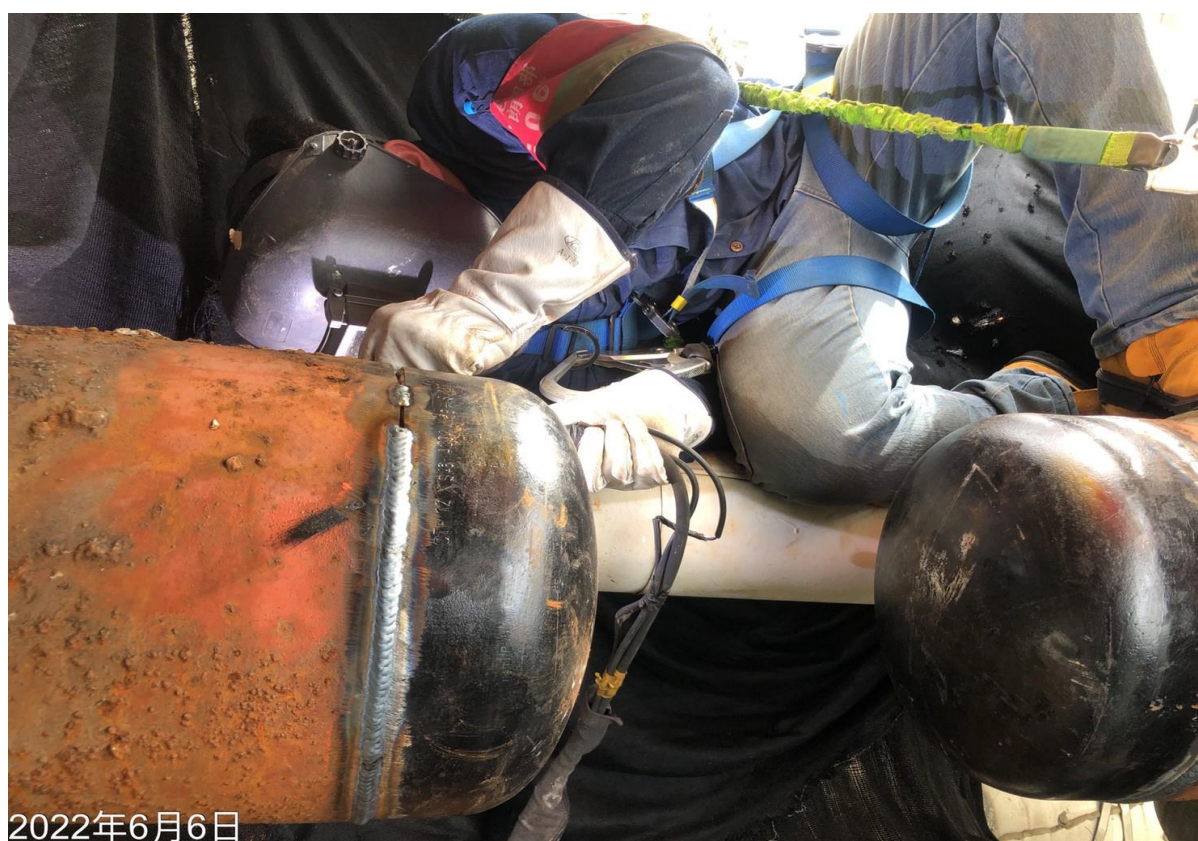
11. 管線切管後封焊情形
