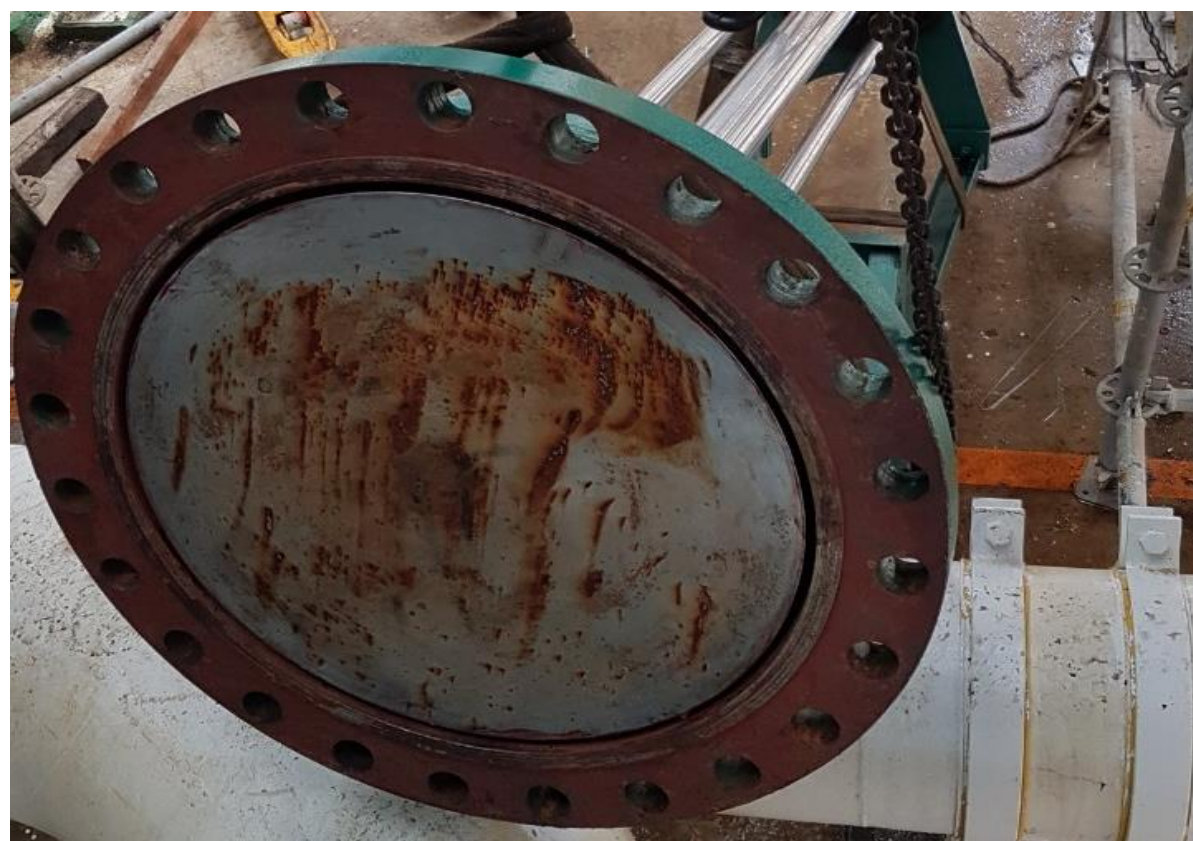
8. 安裝下堵器進行下堵作業
