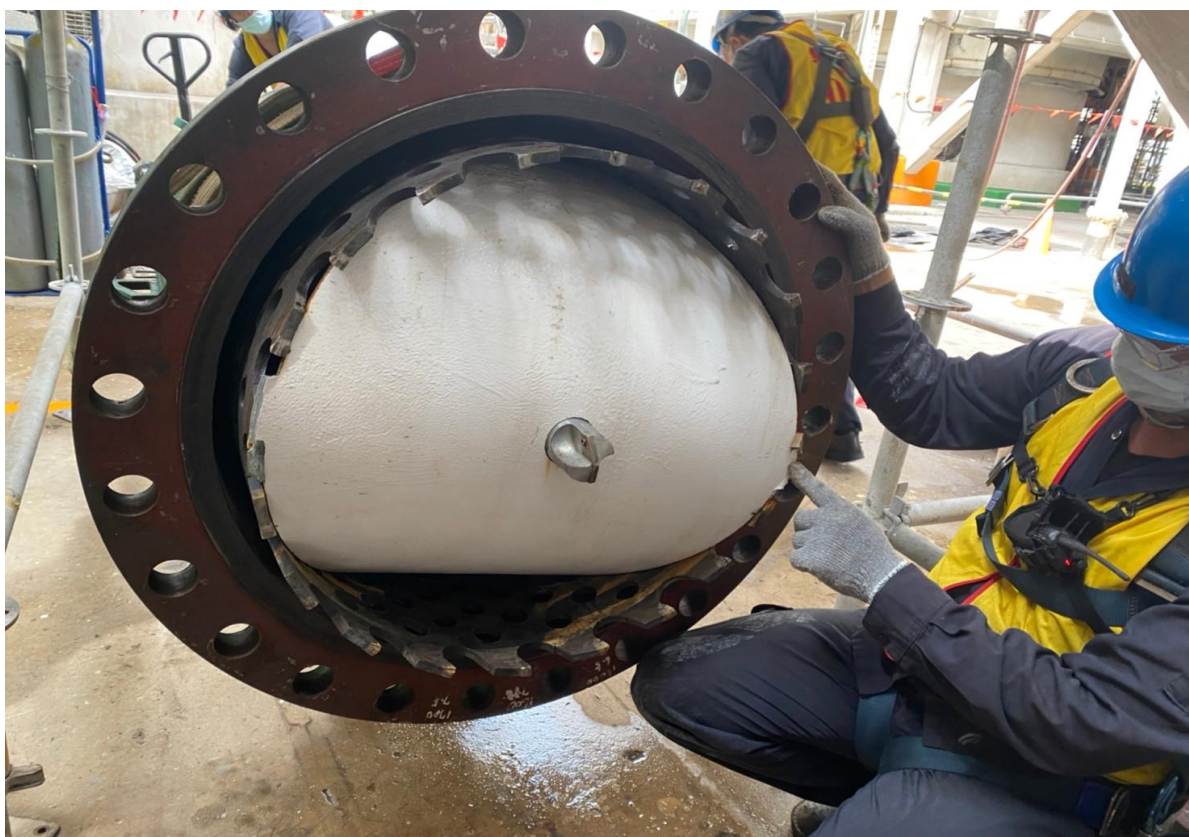
2. 斷管完成確認料塊取出
