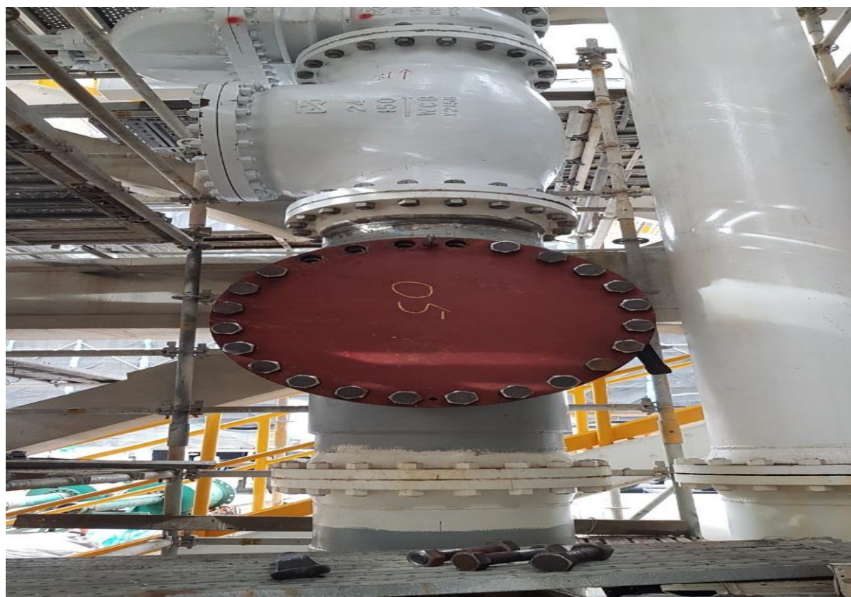
9. 施工完成安裝盲法蘭
