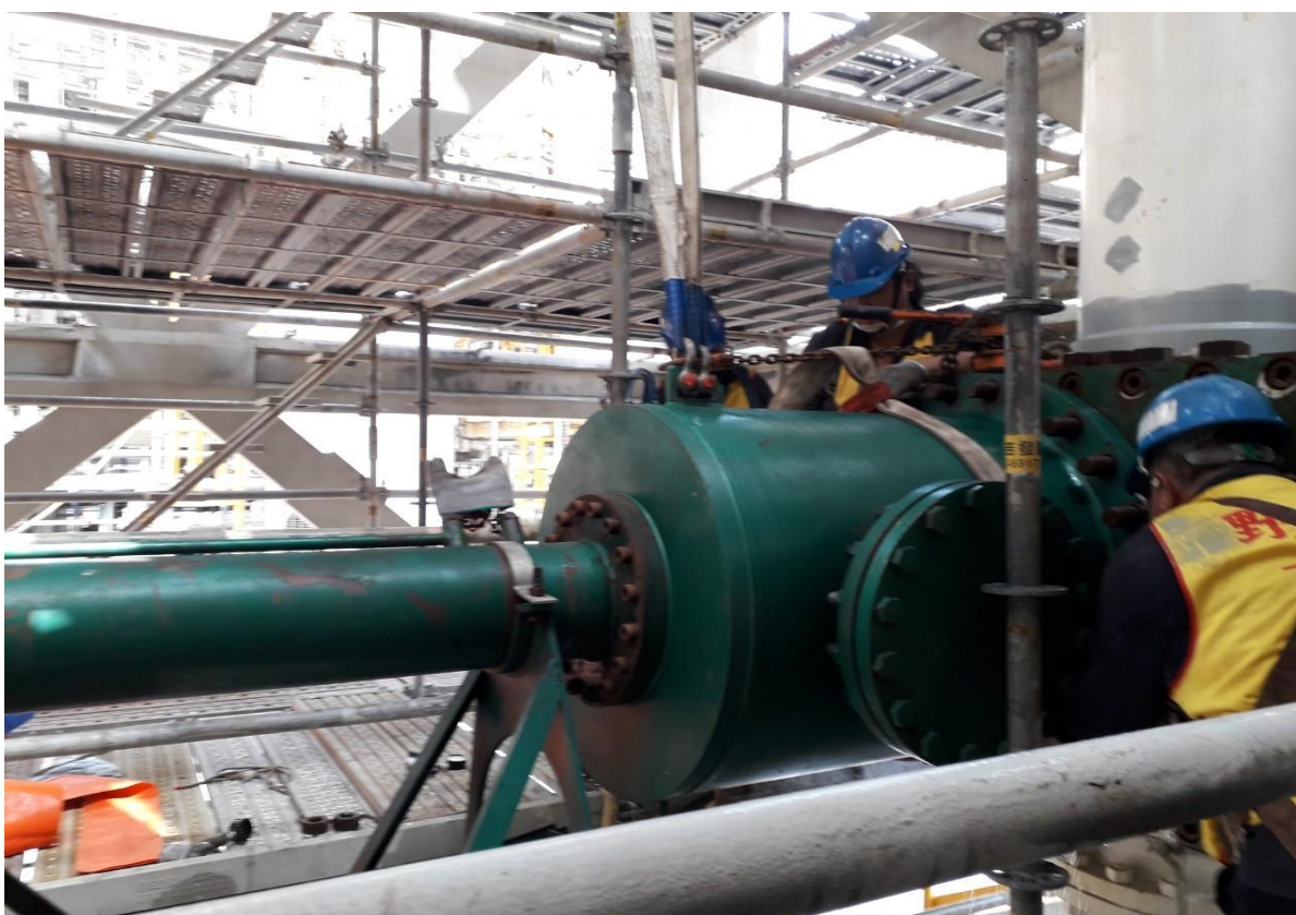
6. 人員安裝膨脹桶進行阻斷作業(下方)
