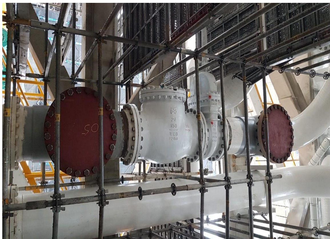
10. 24"雙阻斷施工完成
