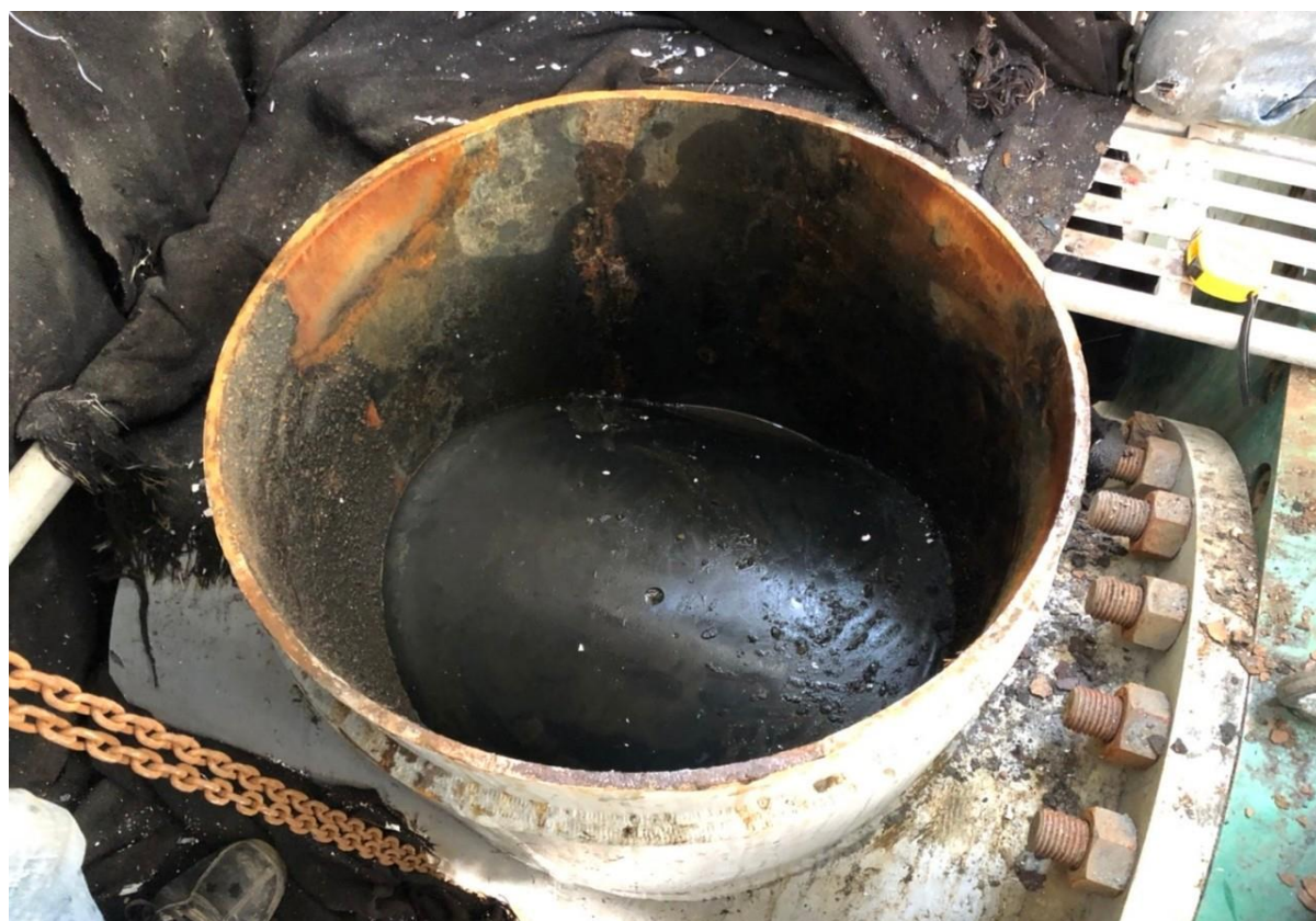
7. 阻斷後管線切管內部情形
