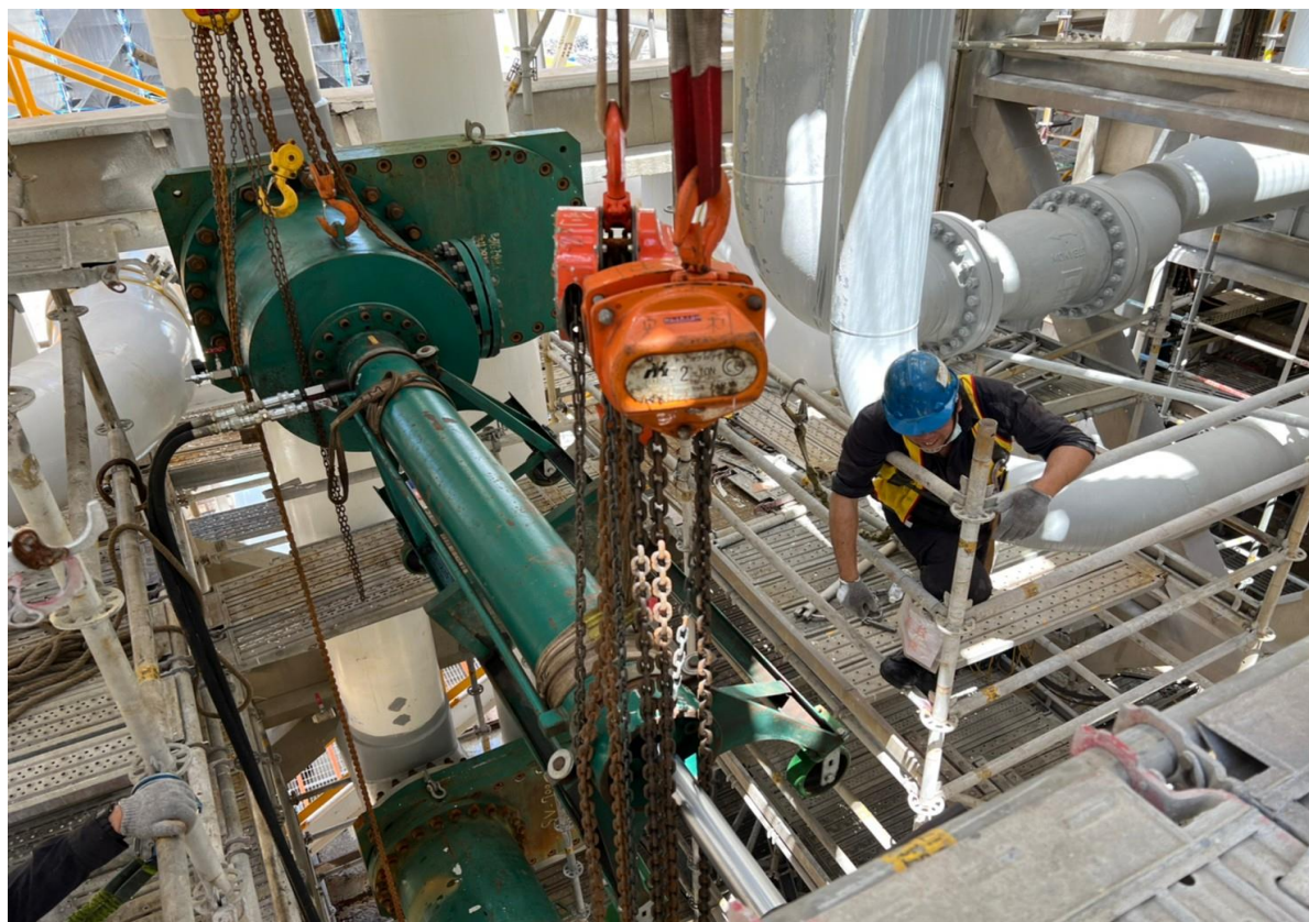
5. 人員安裝膨脹桶進行阻斷作業(上方)
