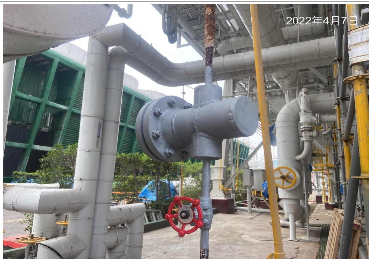
25. 施工完成安裝盲法蘭及油漆作業
