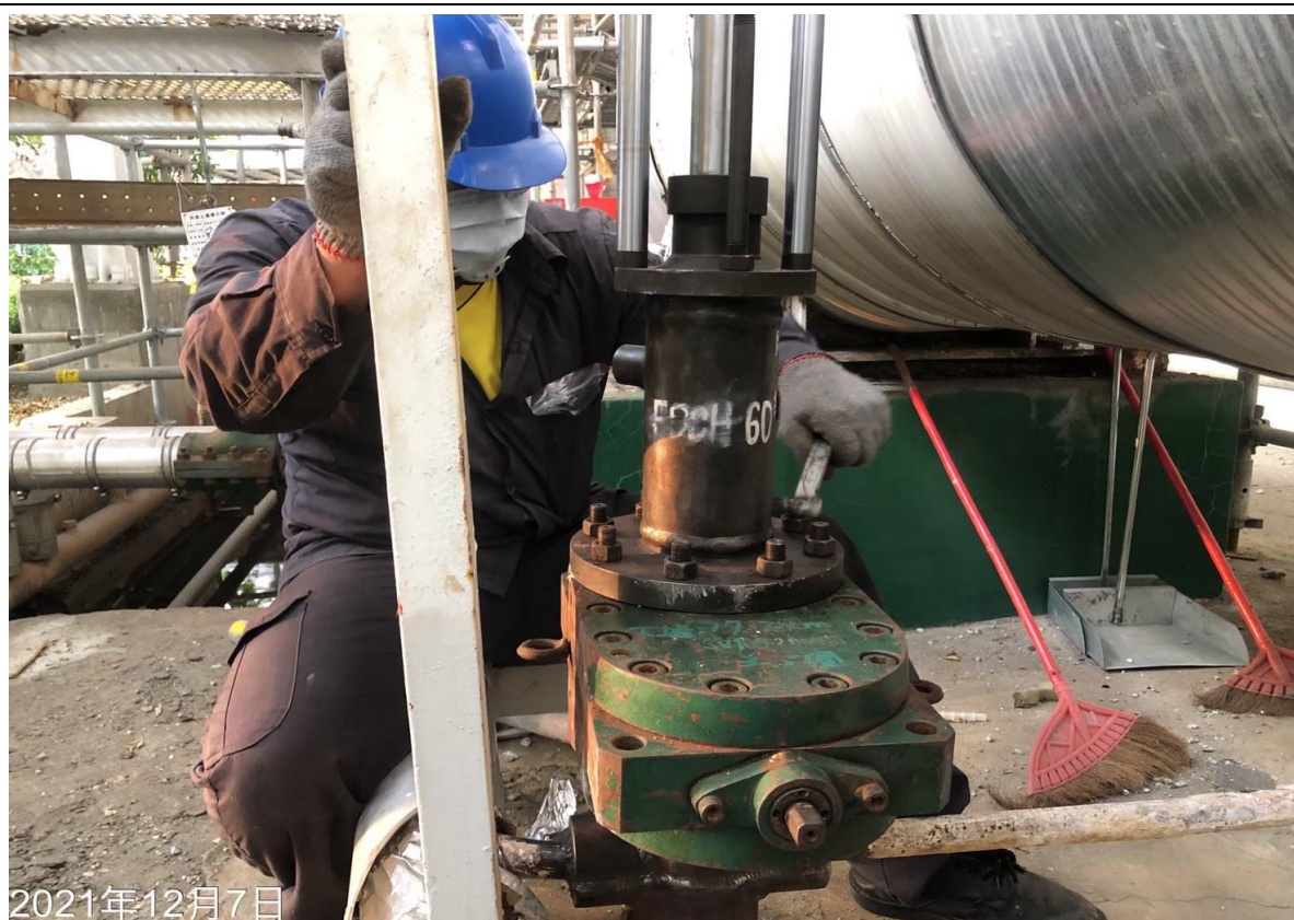
16. 安裝阻斷器進行阻斷作業
