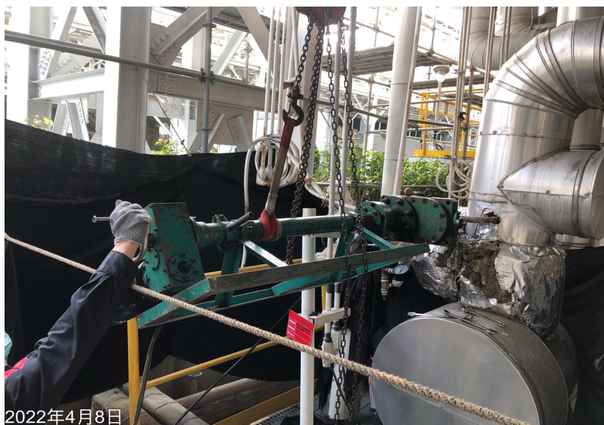
33. 人員安裝開孔機後進行斷管作業
