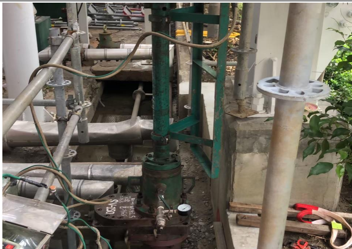
9. 安裝開孔機後進行開孔作業(4")
