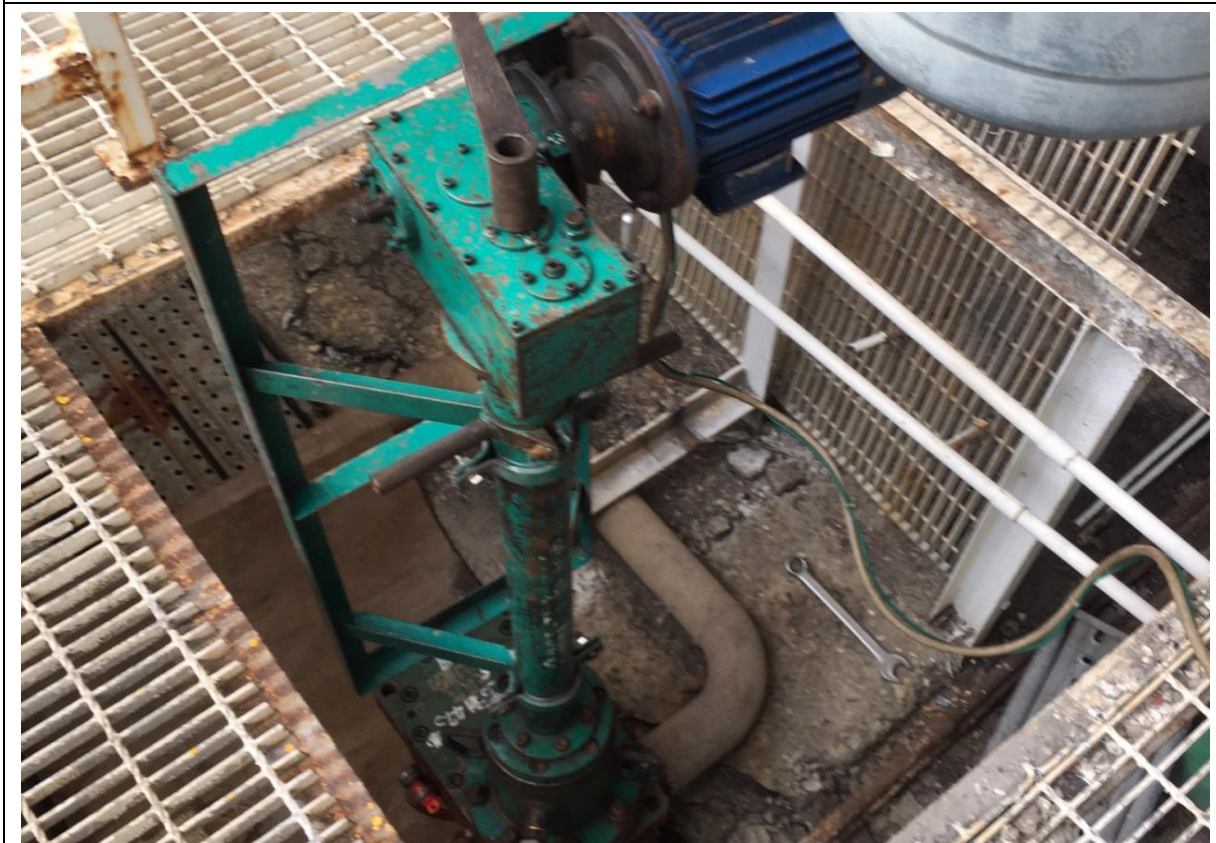
2. 開孔機安裝情形
