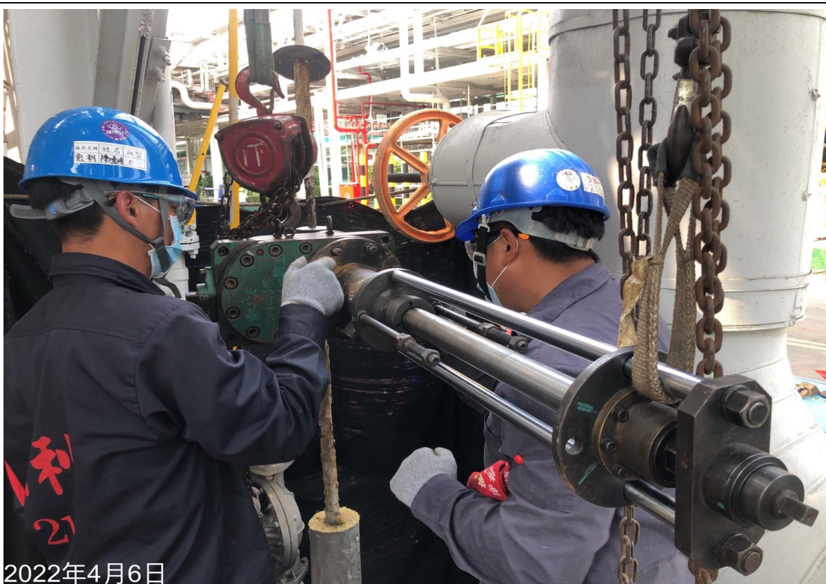
22. 安裝阻斷器進行阻斷
