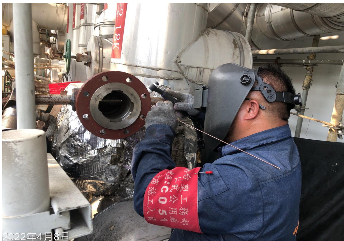
32. 安裝阻斷器進行阻斷
