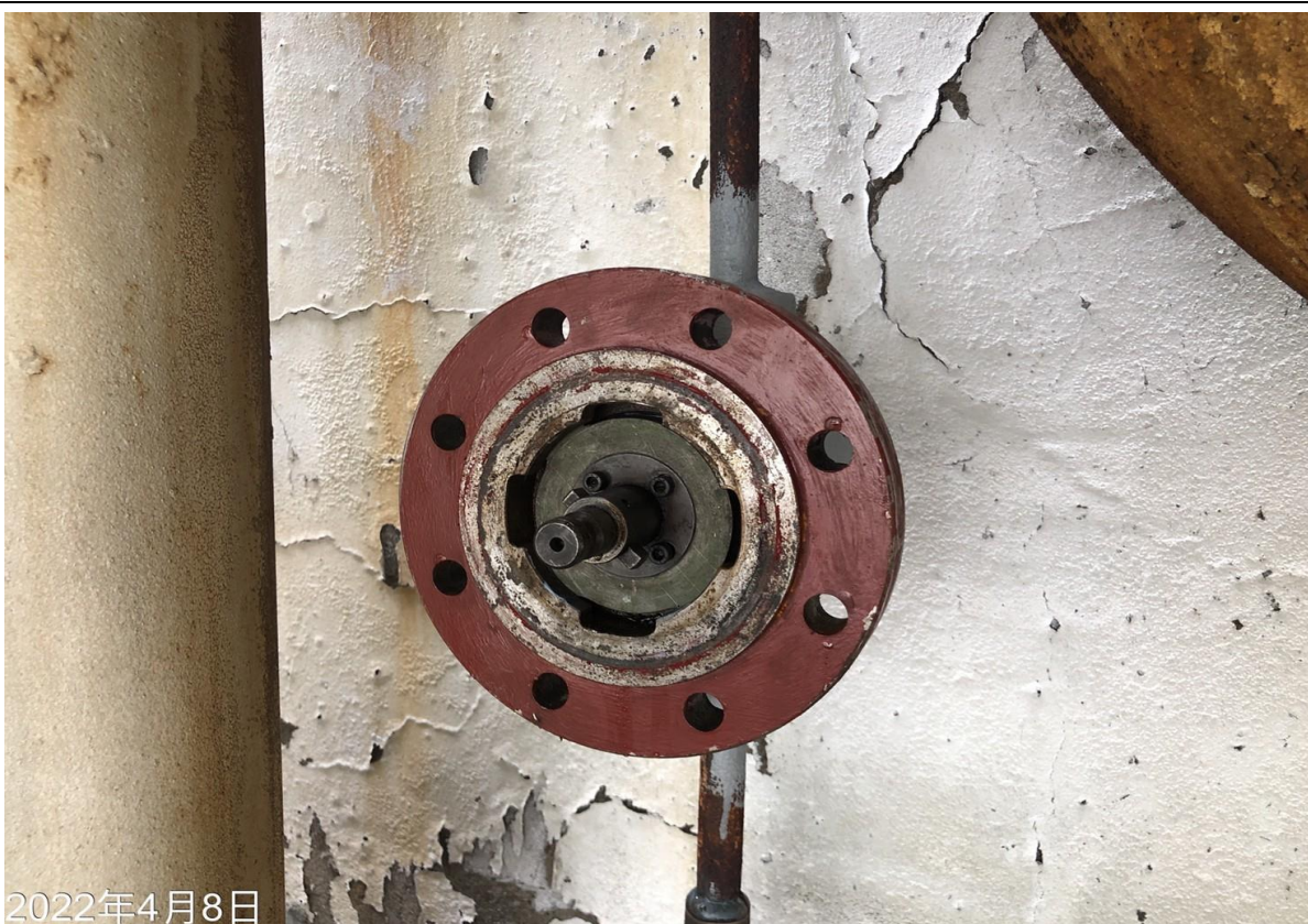
30. 人員進行下堵作業
