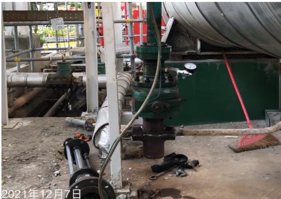
15. 安裝開孔機後進行開孔
