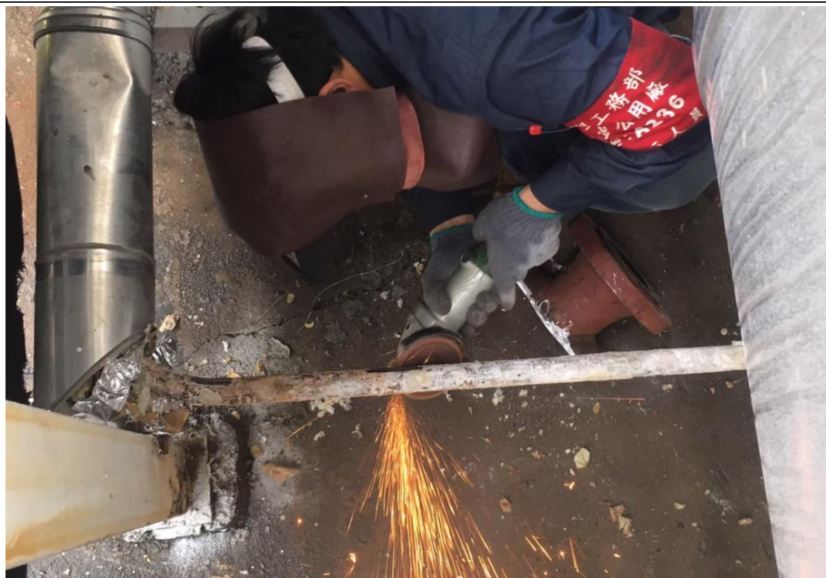
13. 管線研磨作業
