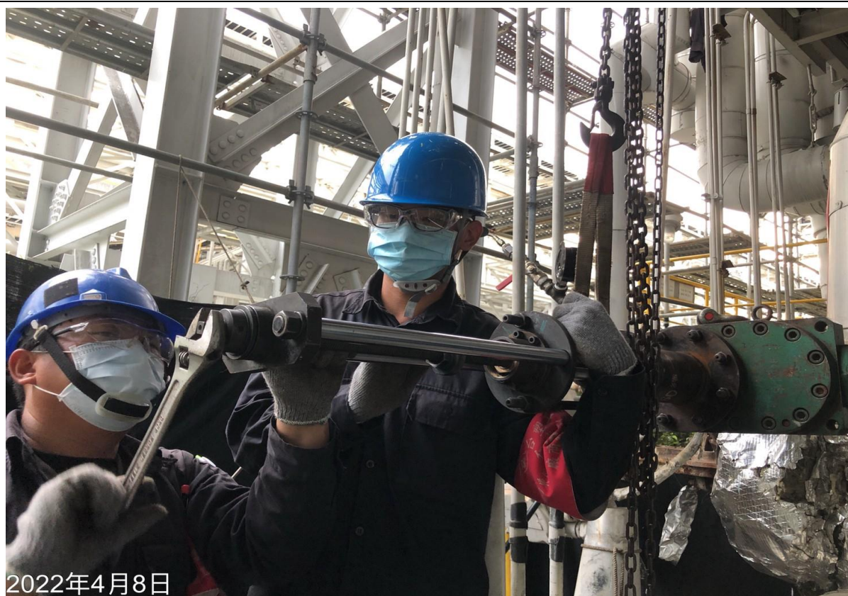
34. 安裝阻斷器進行阻斷作業
