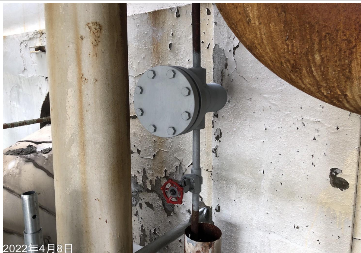
31. 施工完成安裝盲法蘭及油漆作業
