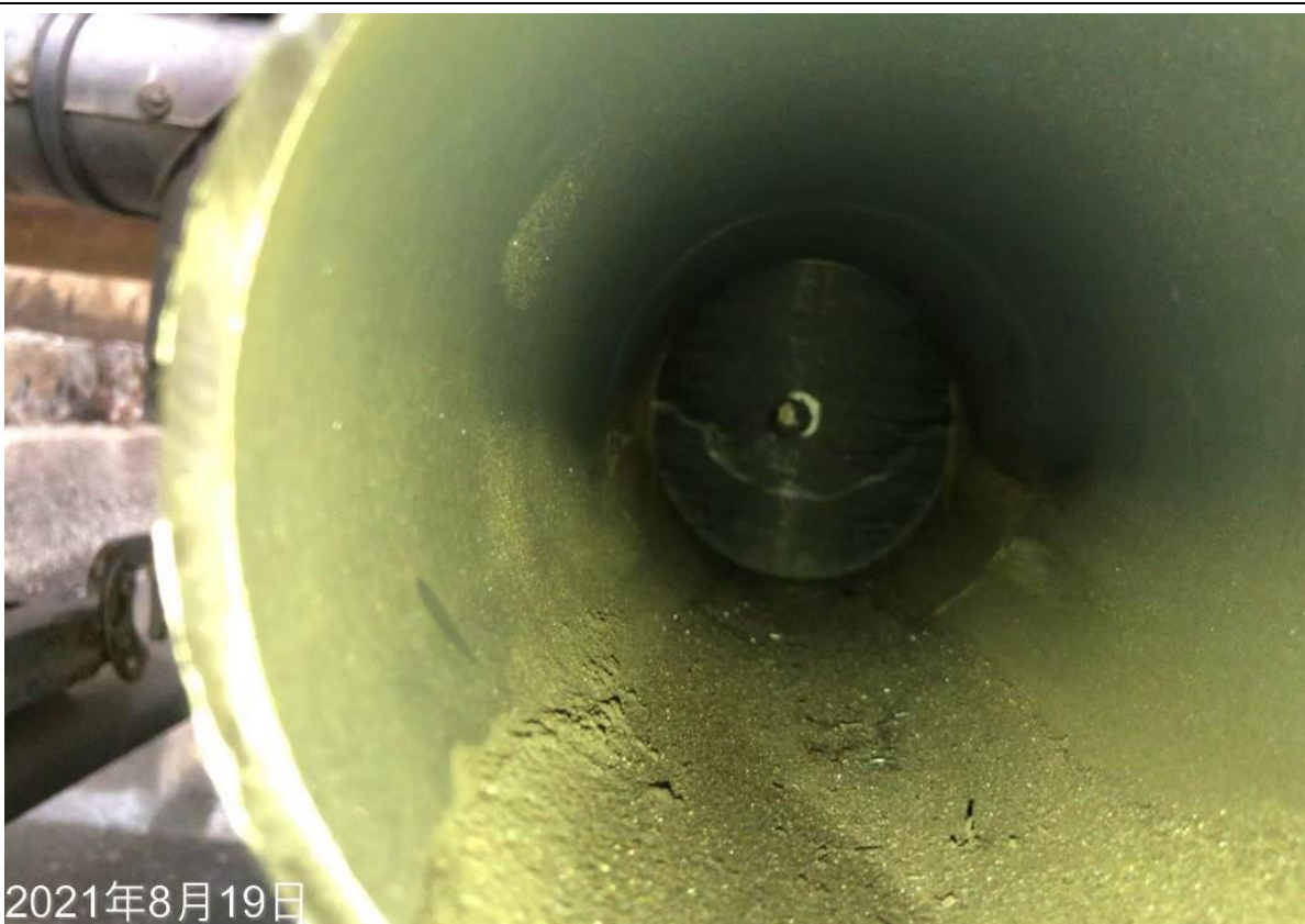
10. 阻斷後切管管內情形
