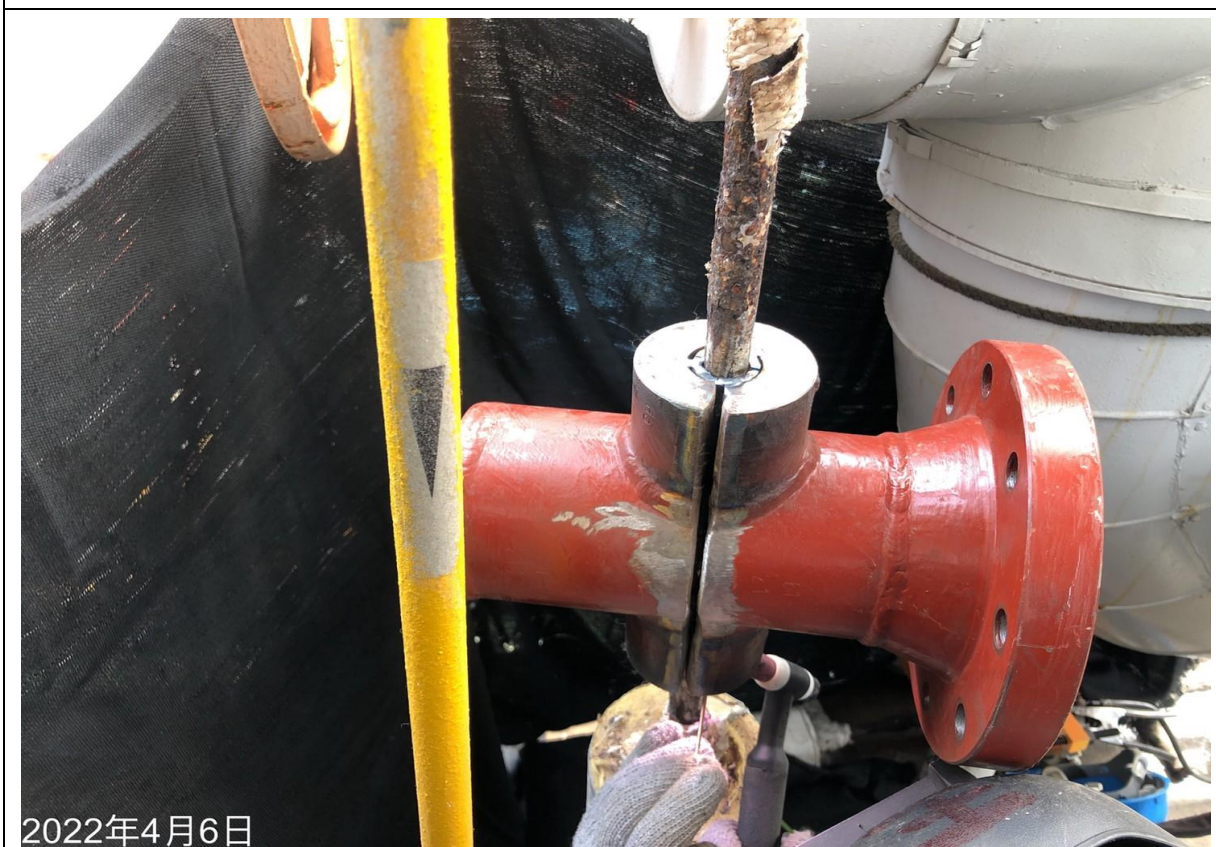
20. 施工完成安裝盲法蘭並油漆
