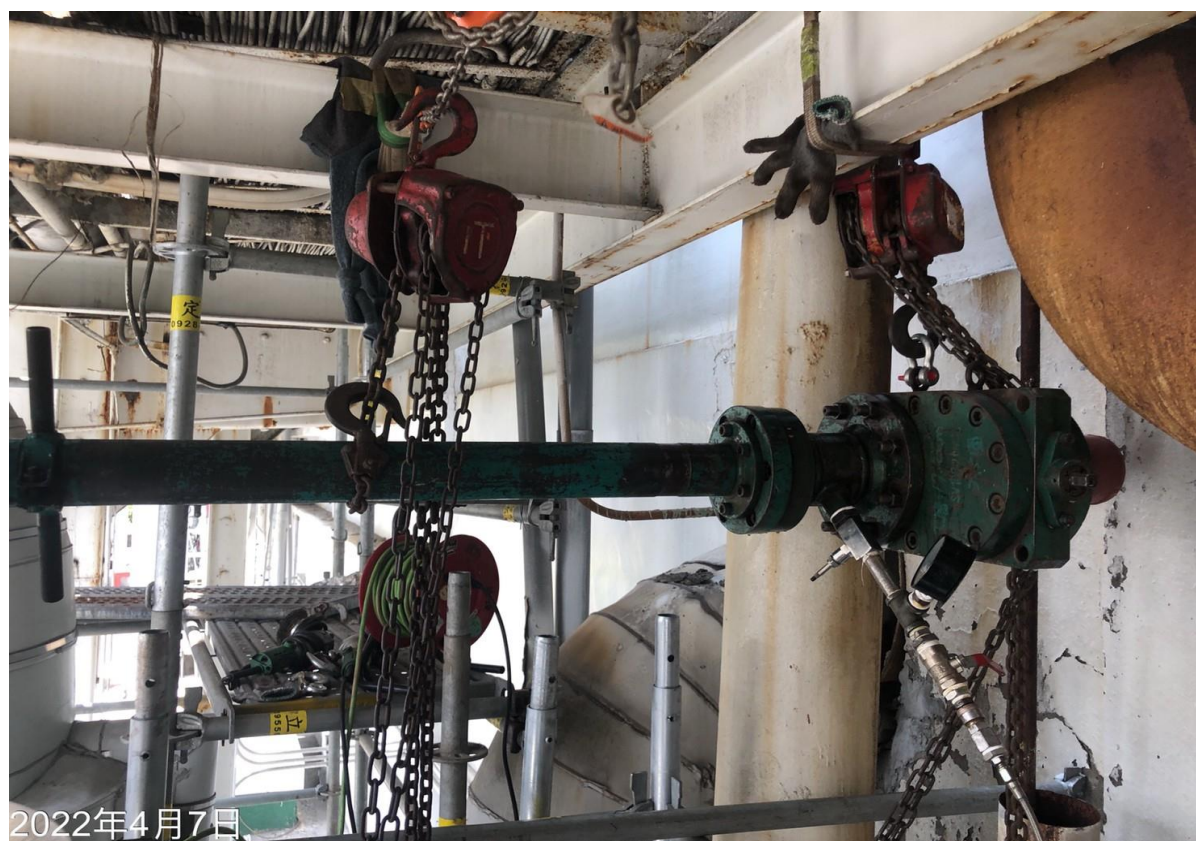
27. 安裝開孔機進行斷管作業
