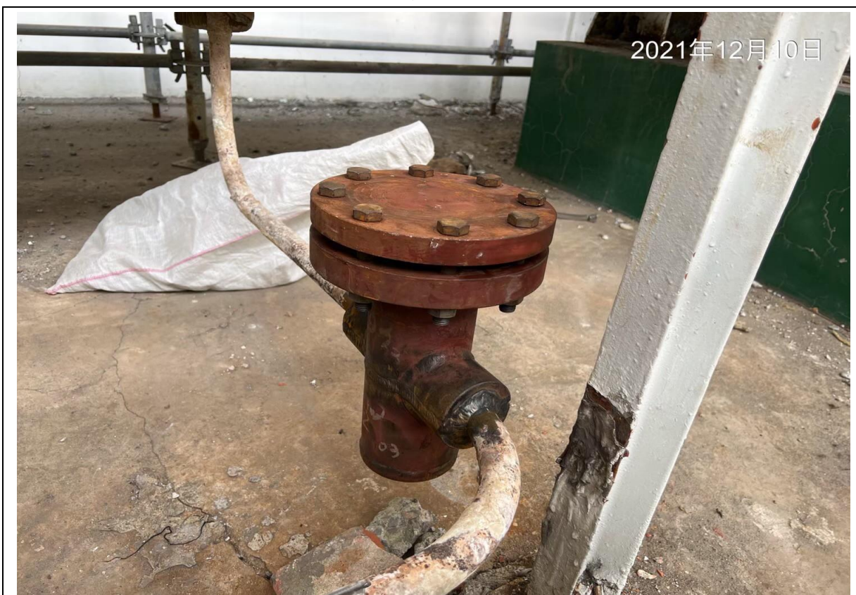
19. 施工完成安裝盲法蘭
