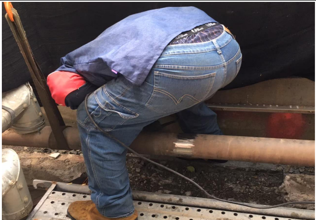
7. 4吋管研磨作業
