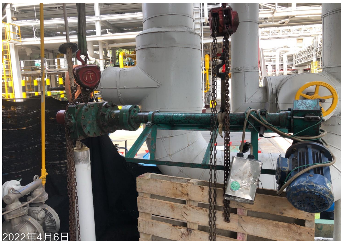
21. 安裝開孔機具進行斷管作業
