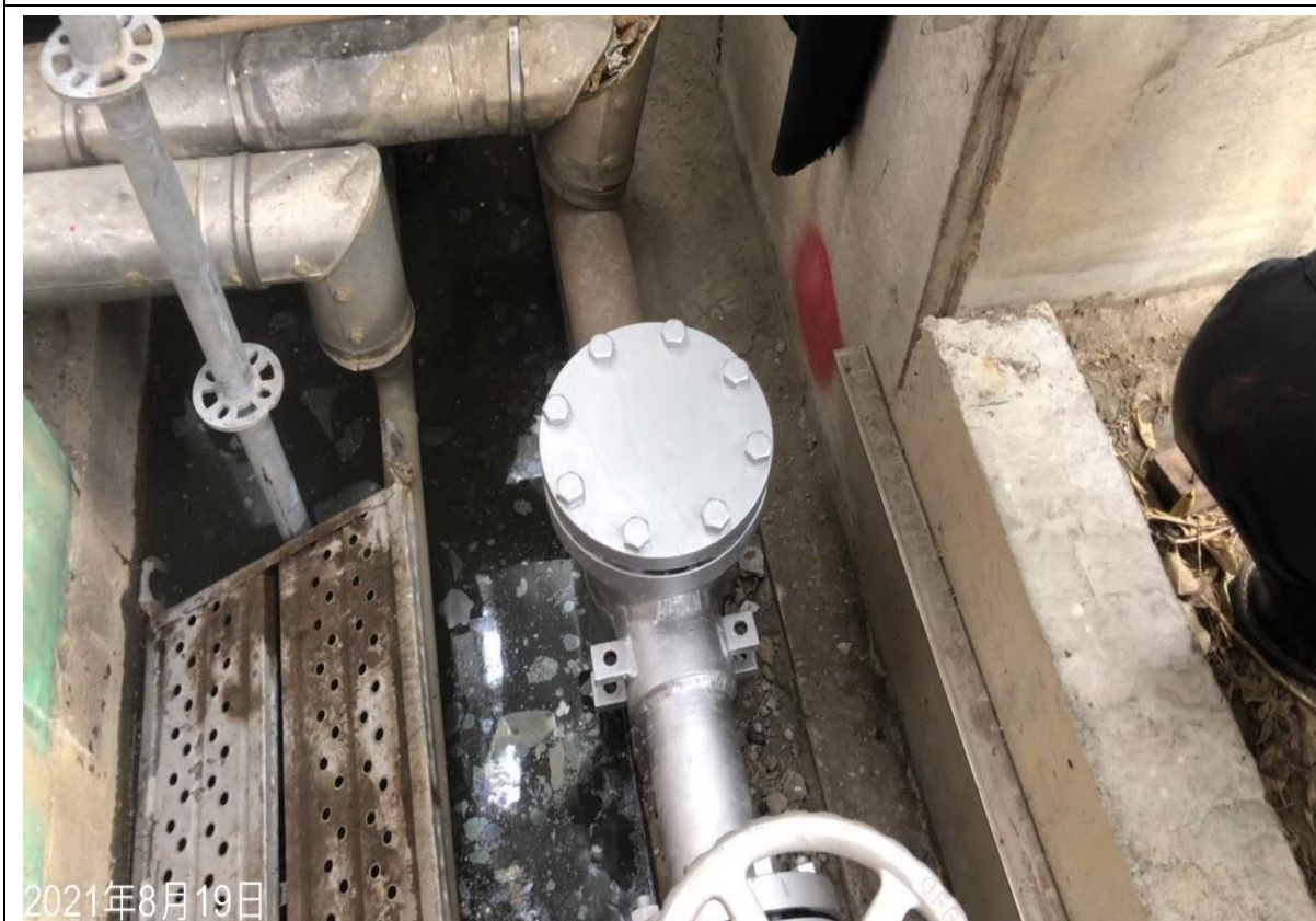
12. 下堵作業完成安裝盲法蘭
