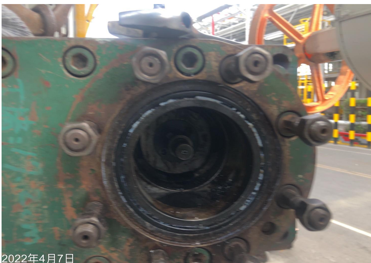
24. 人員進行下堵作業
