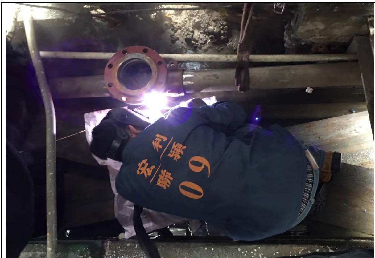
1. 管線焊接作業
