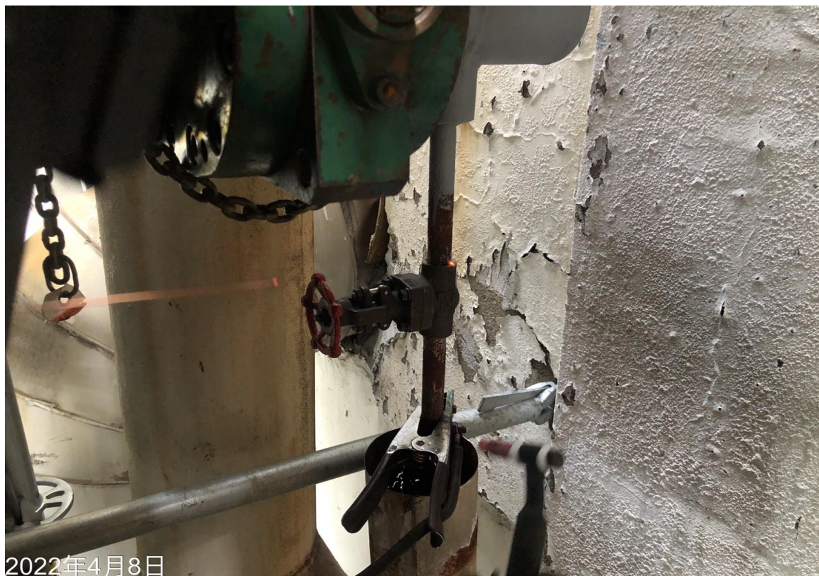
29. 阻斷後新增隔離閥
