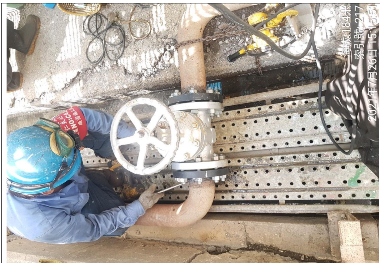
5. 阻斷後增設隔離閥情形
