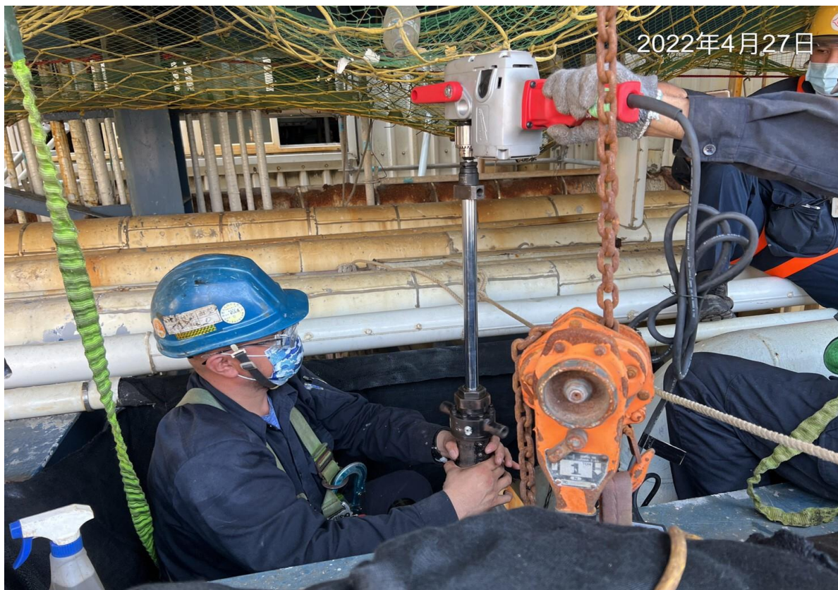
13. 人員執行開孔作業情形
