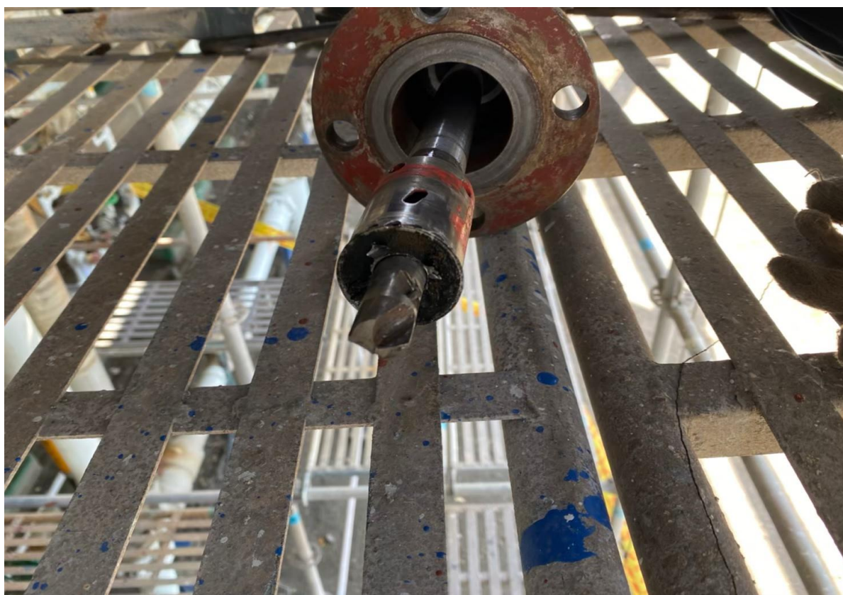
6. 阻斷完成後切管焊法蘭作業
