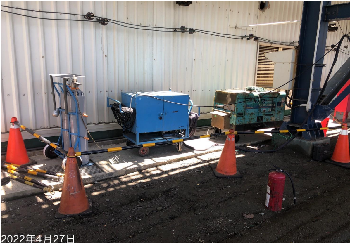
8. 發電機及氬焊機定位情形(MH5008)
