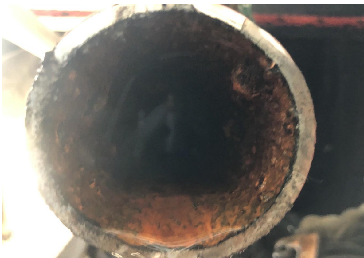
16. 管線切管後阻斷內部情形
