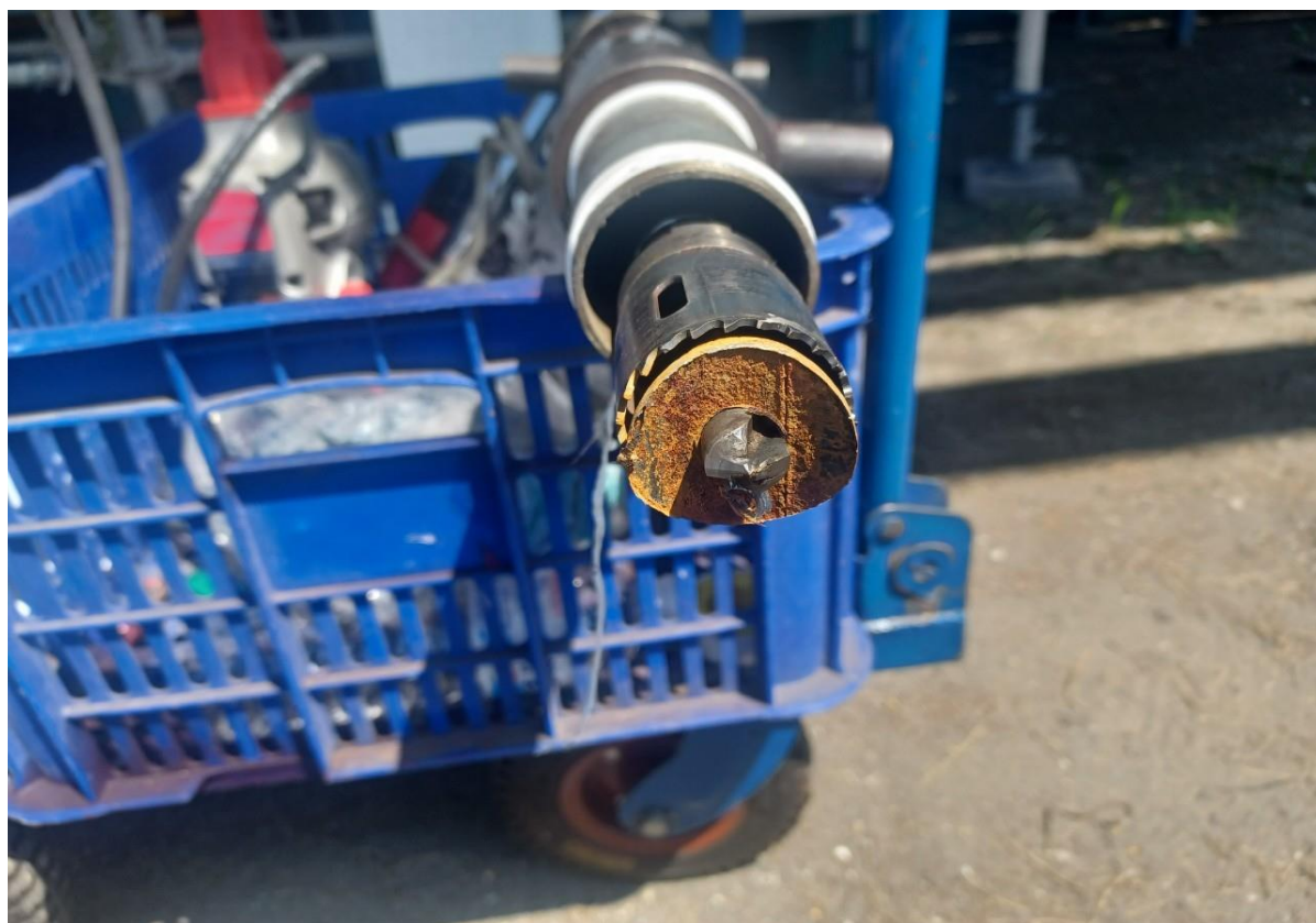
14. 開孔完成確認鐵片取出
