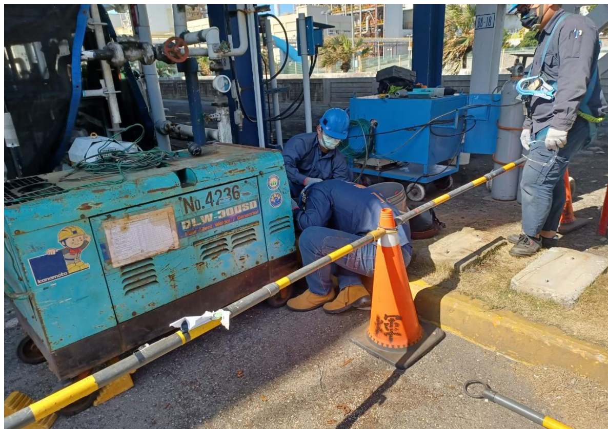
1. 發電機及氬焊機定位情形
