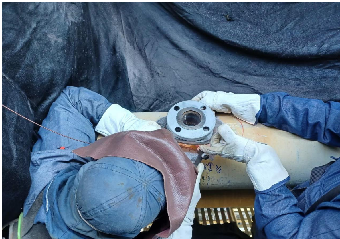
3. 短管法蘭焊接作業
