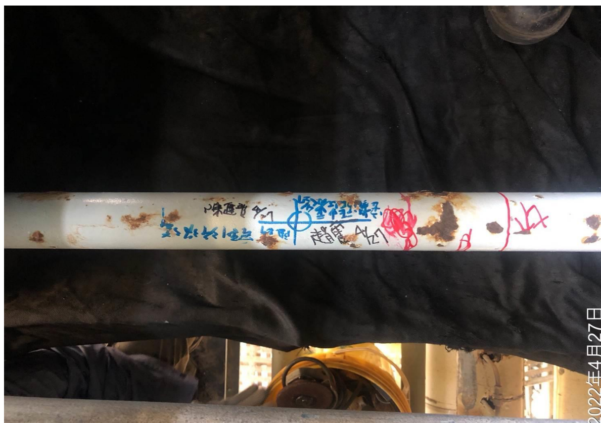
9. 施工管線四方會同
