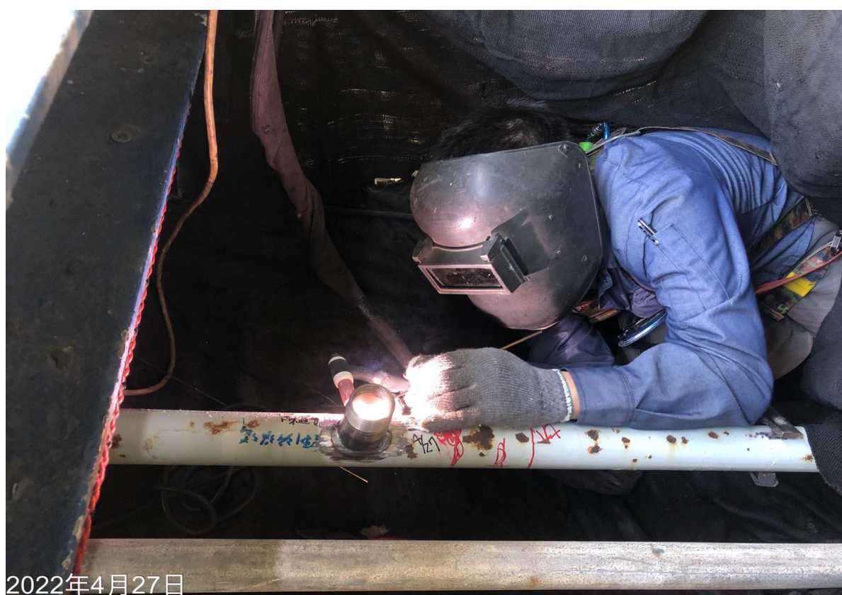
10. 模具焊接及防火毯鋪設情形
