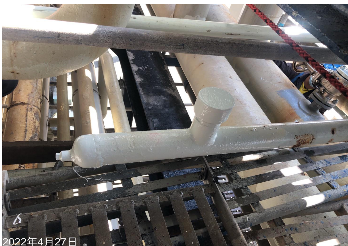
18. 線上插管及阻斷後管線封焊施工完成
