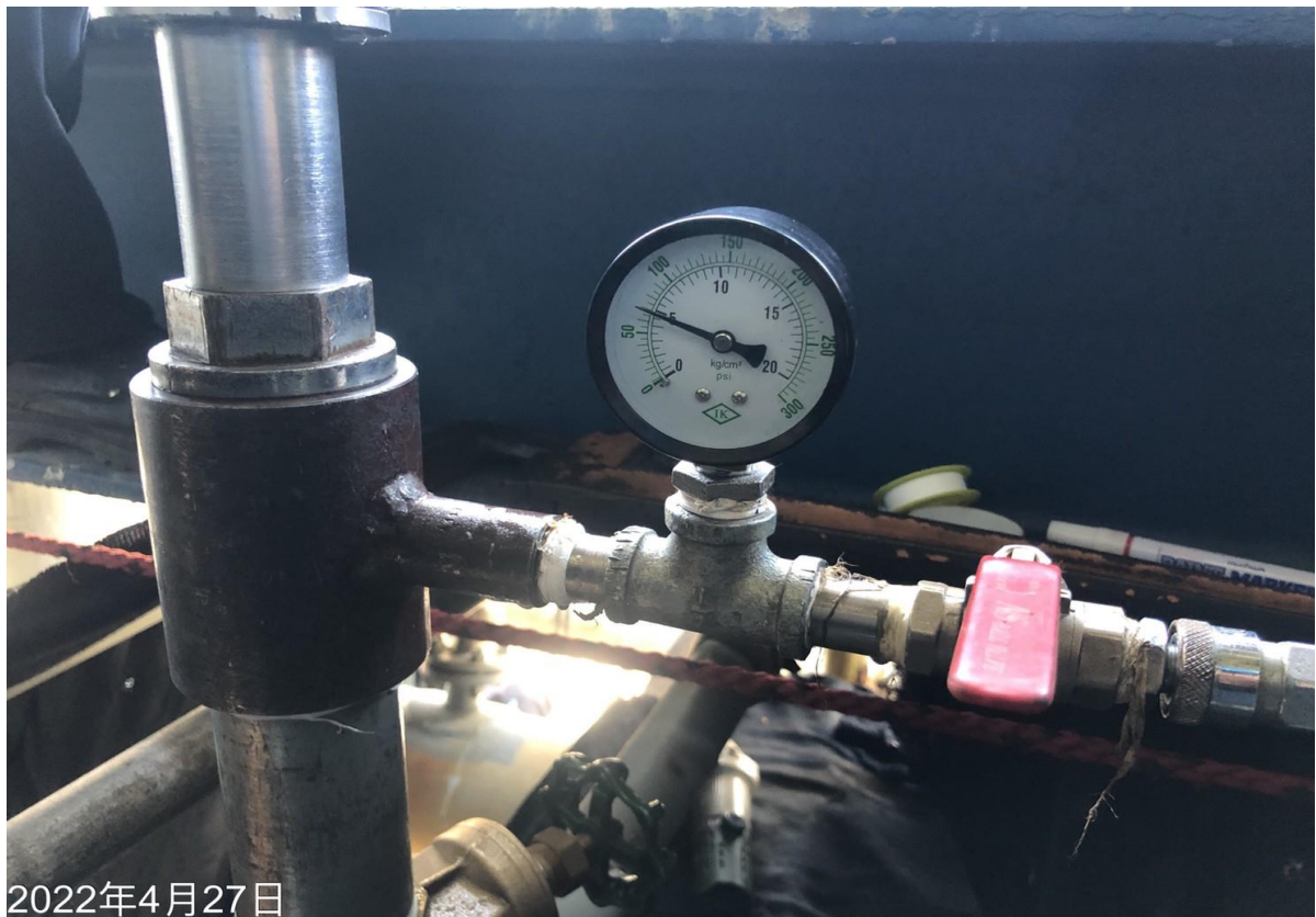
11. 閥件及開孔機安裝後進行試壓作業
