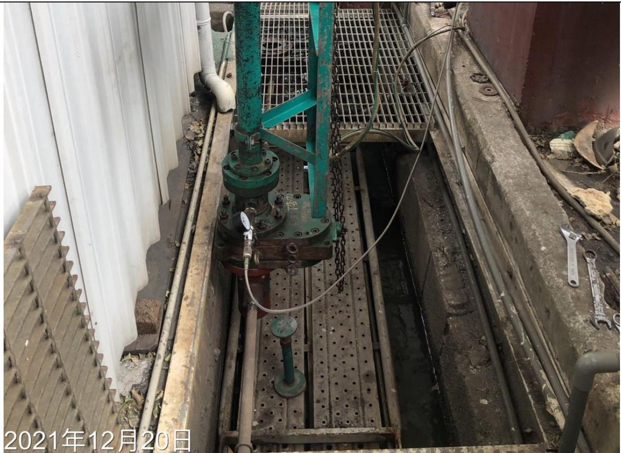
32. 安裝開孔機進行斷管作業
