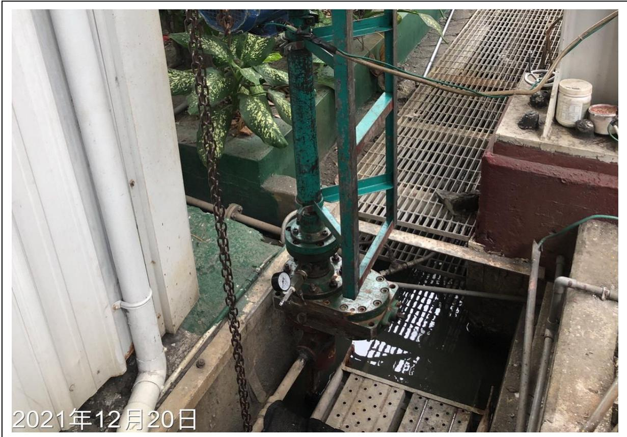
33. 安裝開孔機進行斷管作業
