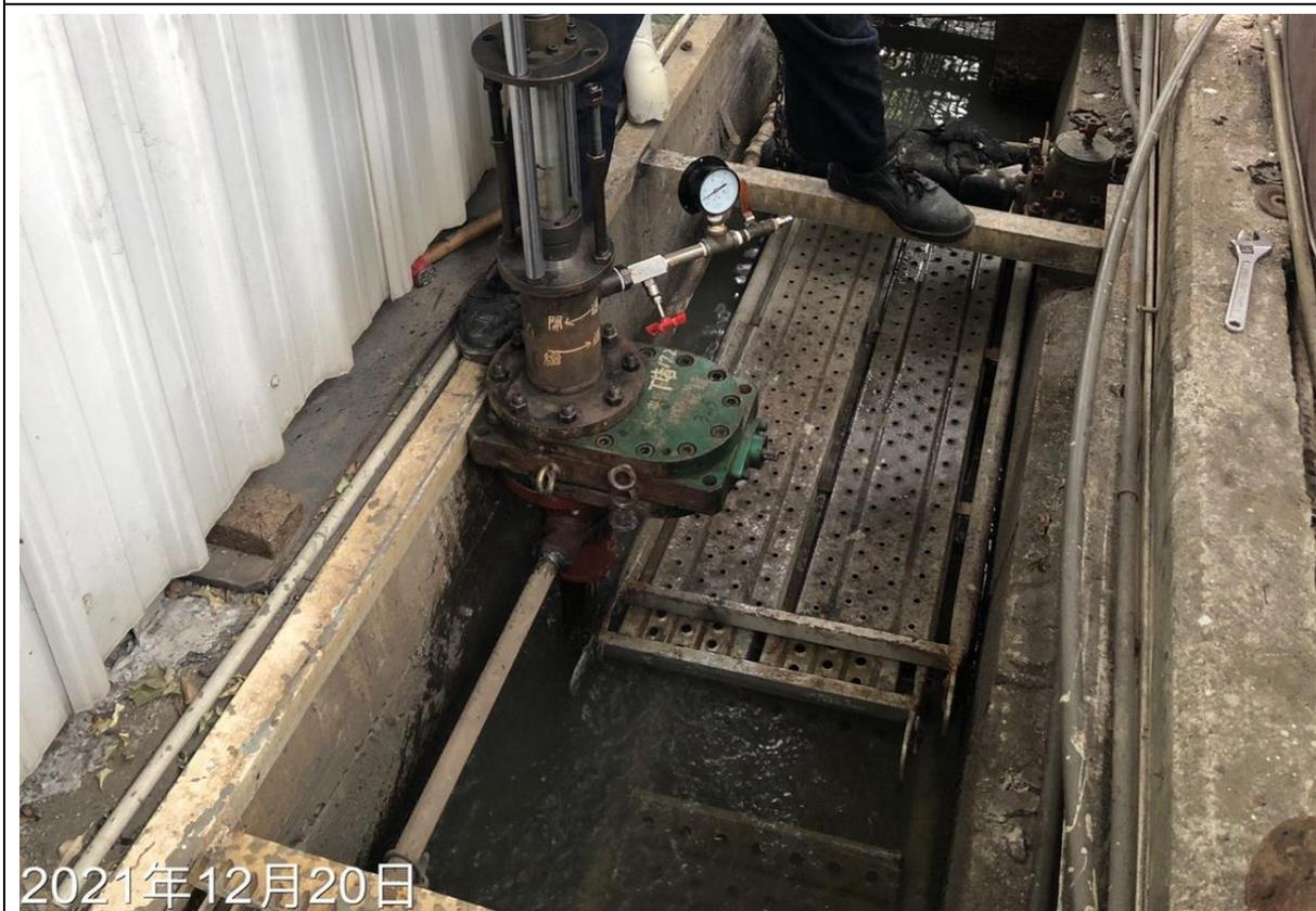
34. 安裝阻斷器進行阻斷作業
