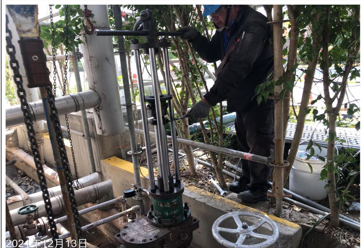
8. 安裝開孔機後進行開孔作業(1")
