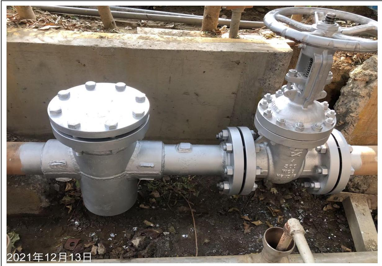
9. 施工完成後安裝盲法蘭及油漆作業
