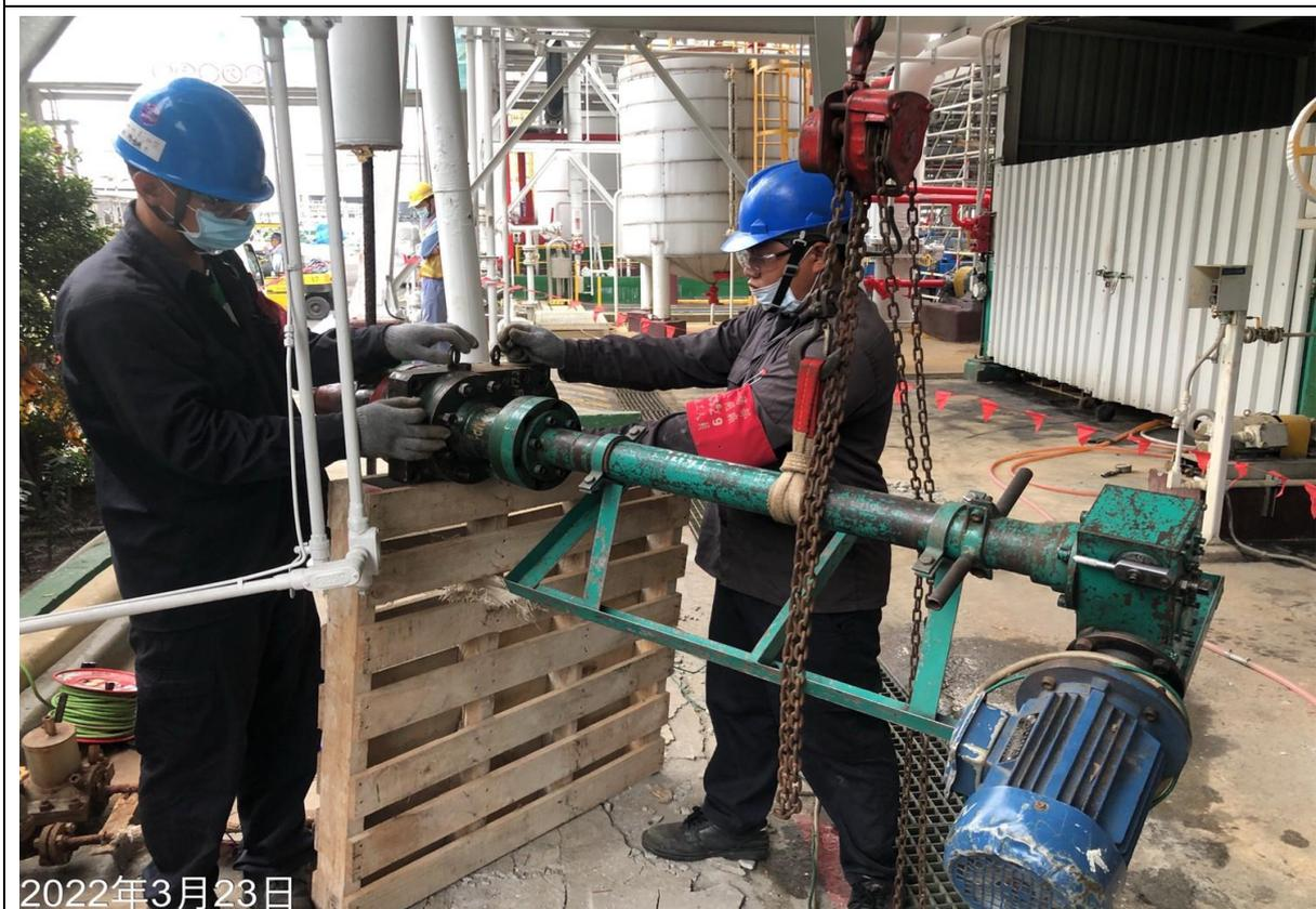
46. 安裝開孔機進行斷管作業
