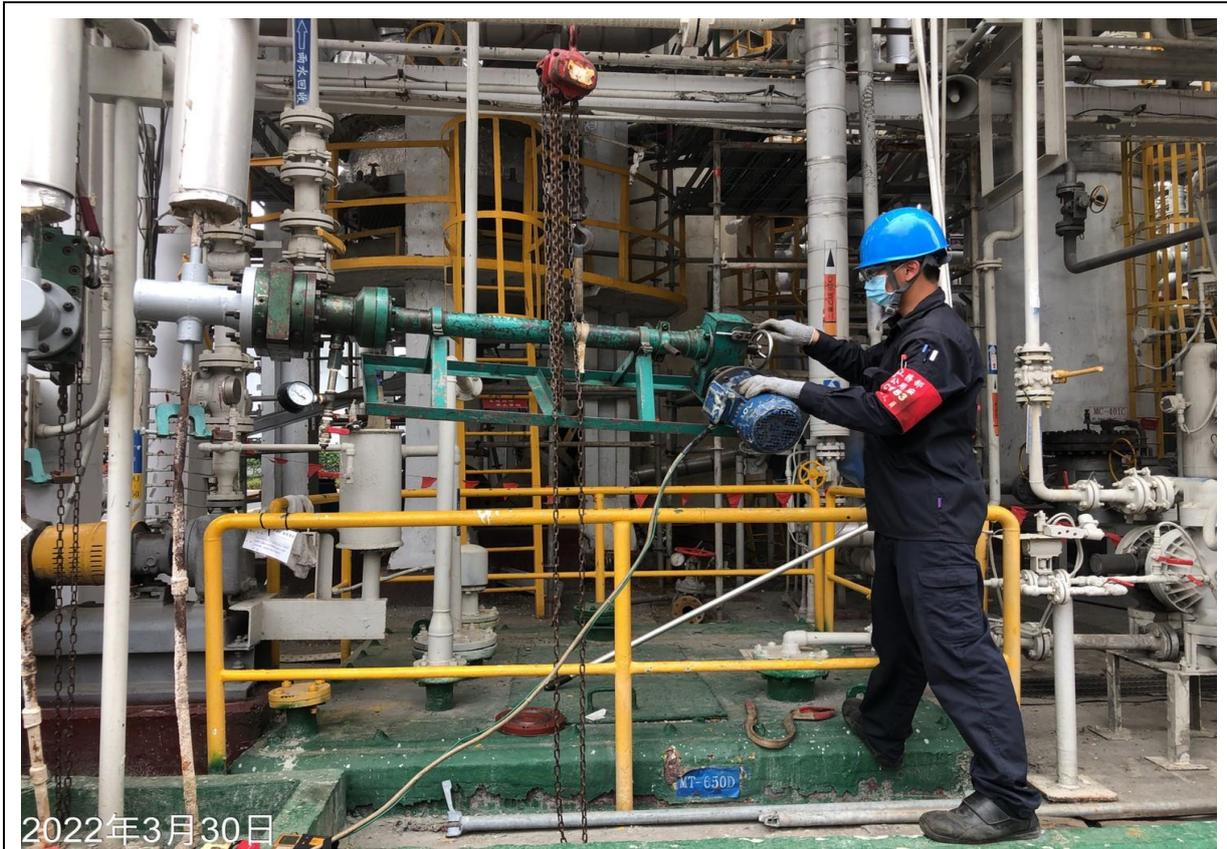
39. 安裝開孔機作業進行斷管作業
