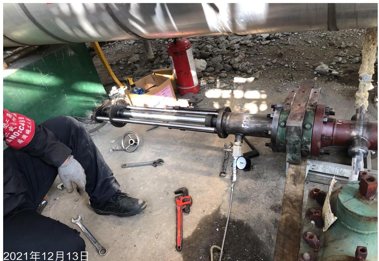
20. 安裝阻斷器進行阻斷作業
