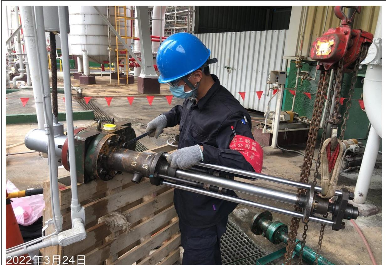
47. 安裝阻斷器進行阻斷作業
