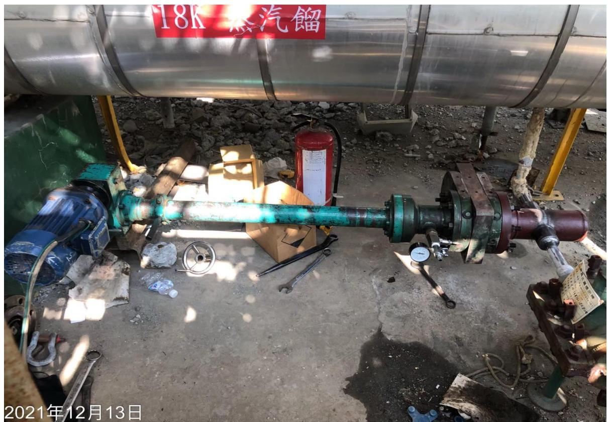
19. 安裝開孔機後進行斷管作業
