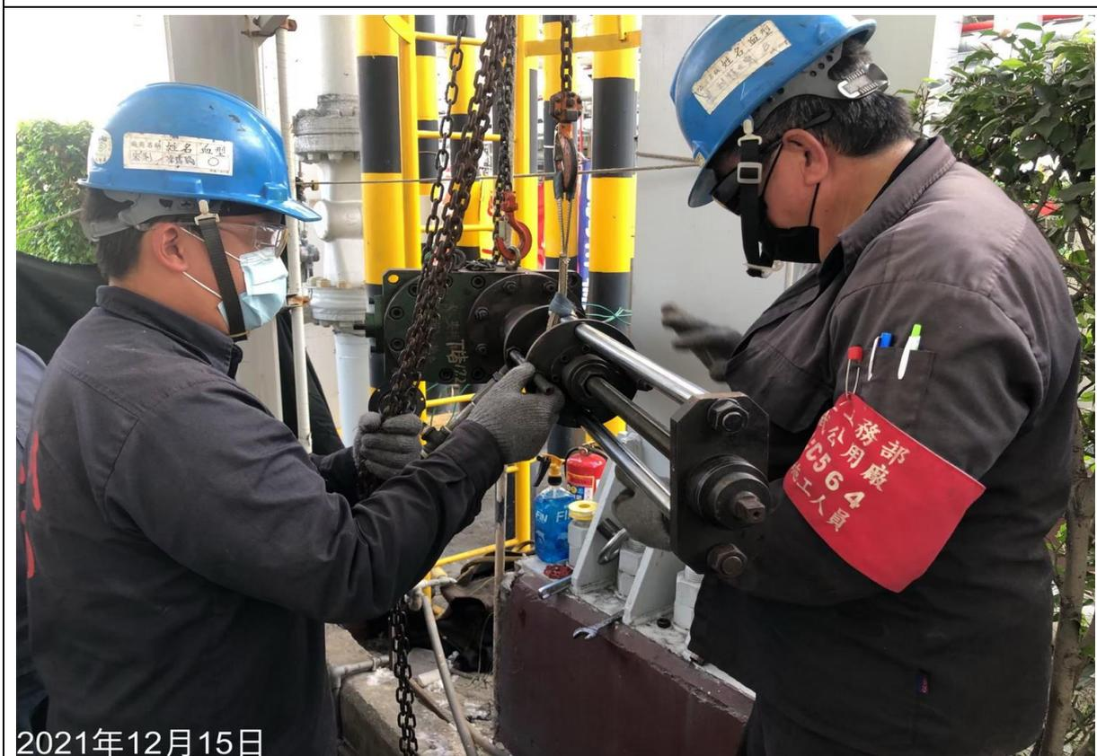
26. 安裝阻斷器進行阻斷作業
