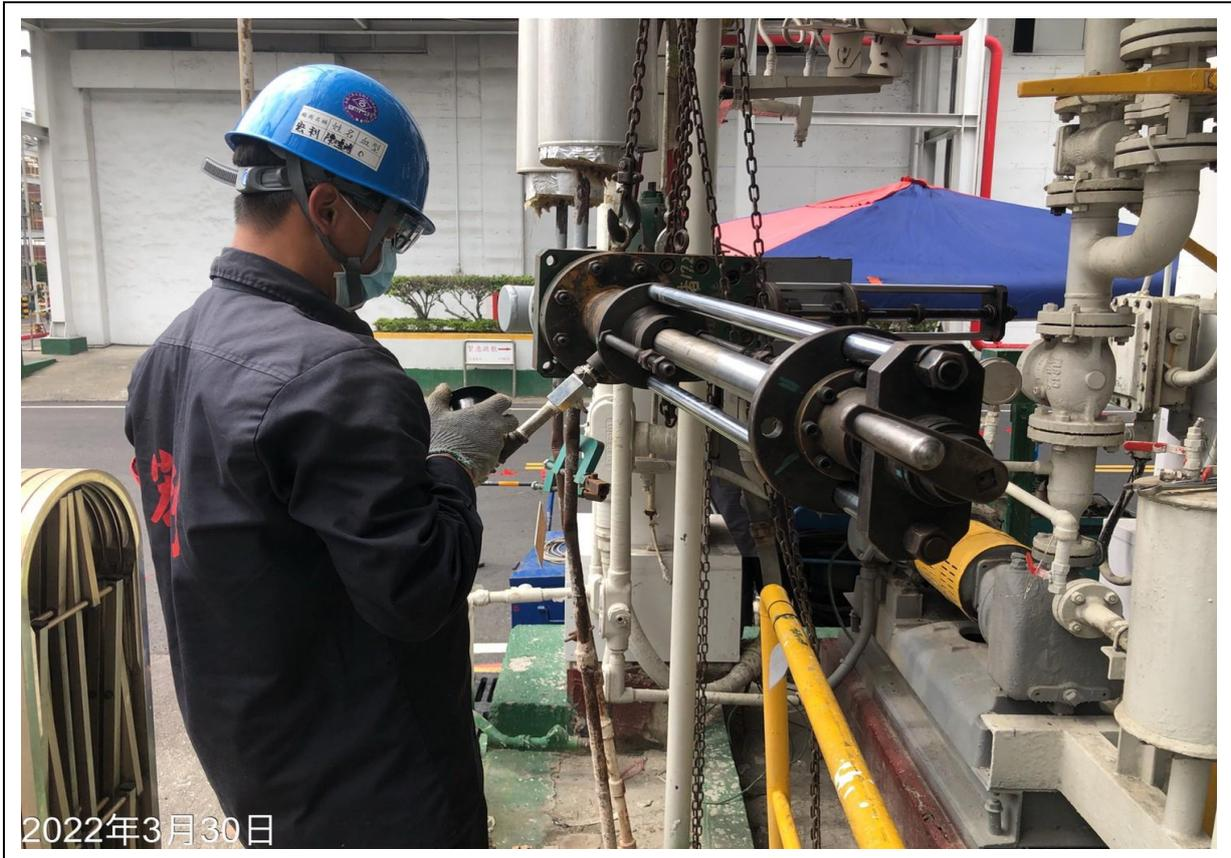
41. 安裝阻斷器進行阻斷作業
