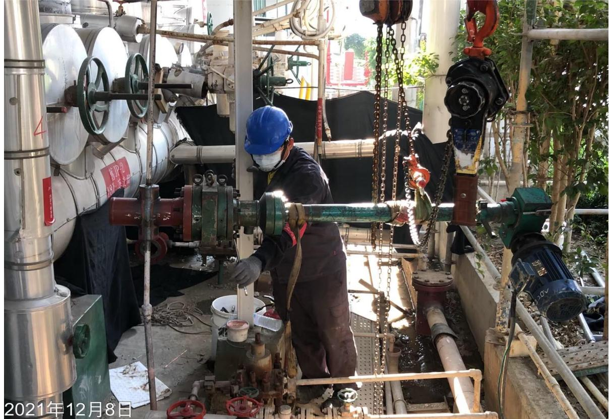
11. 安裝開孔機後進行斷管作業
