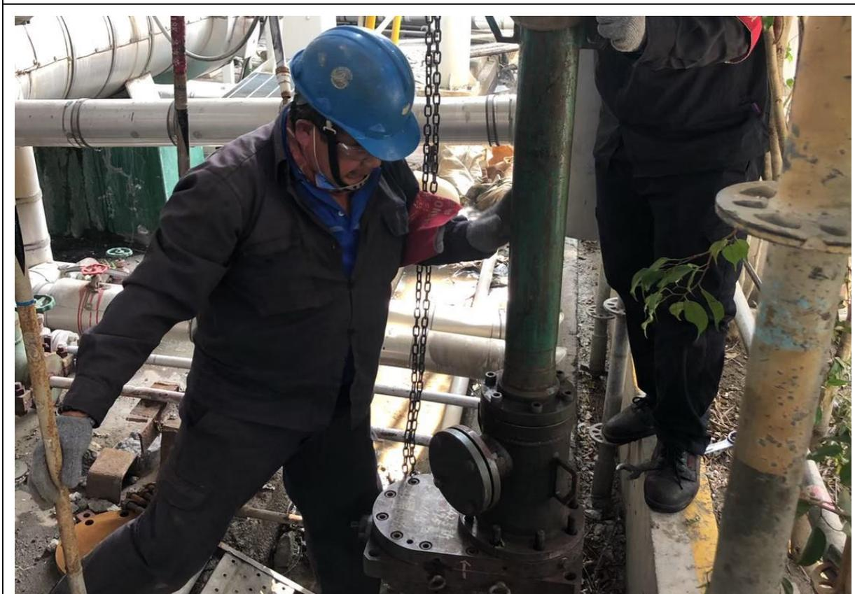
6. 安裝阻斷器後進行阻斷作業
