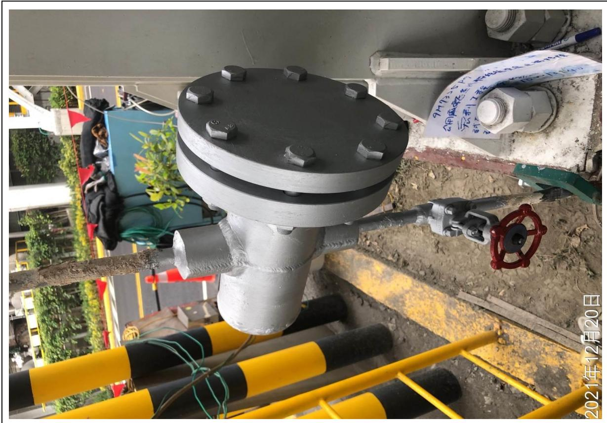
29. 施工完成安裝盲法蘭及油漆作業
