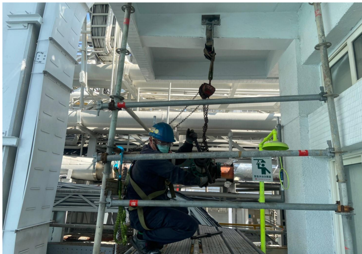
7. 安裝阻斷器後進行阻斷作業並排壓
