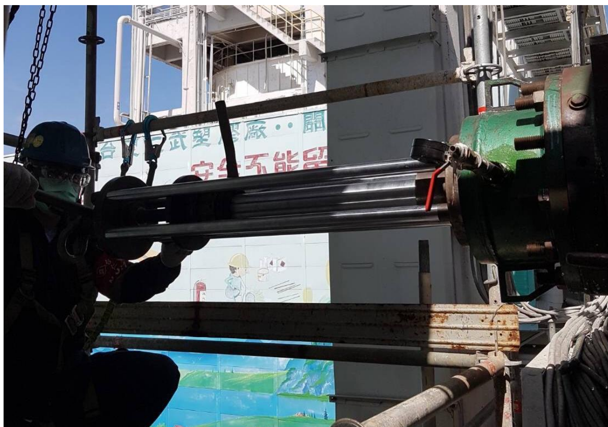
8. 安裝下堵器作業
