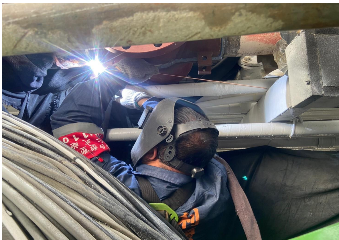
2. 四通模具焊接情形
