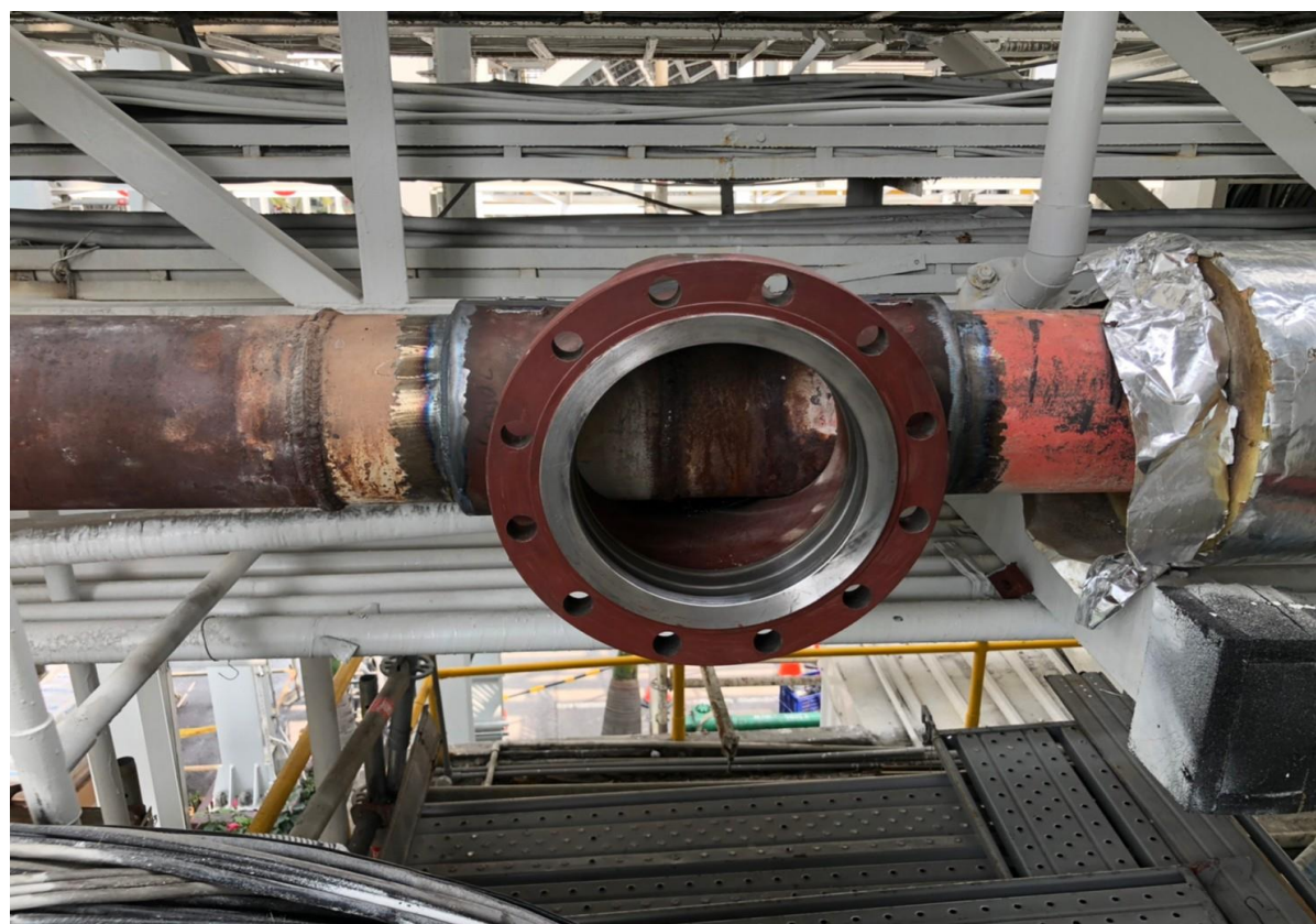
4. 模具焊接完成
