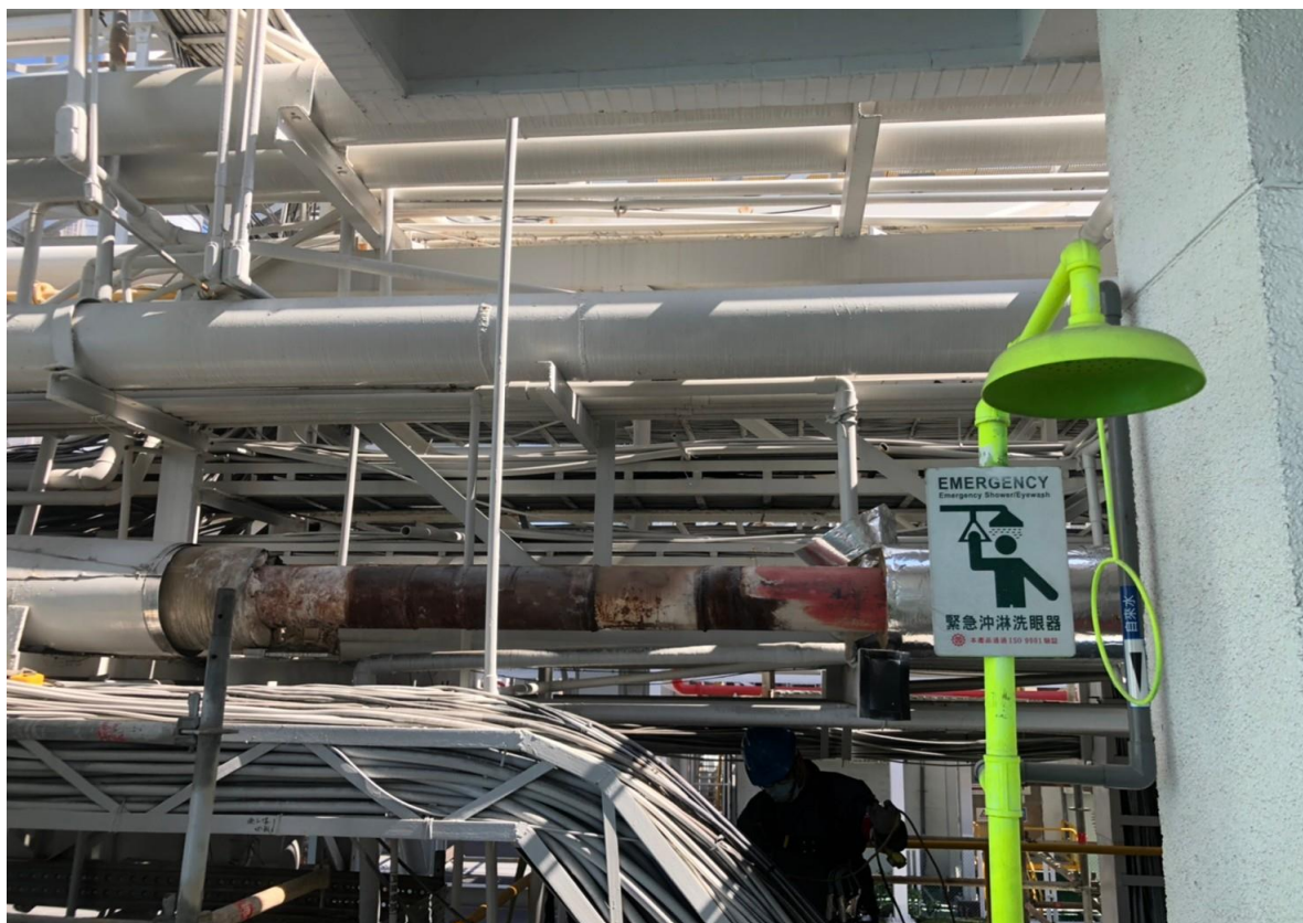
1. 施工處保溫移除及位置確認
