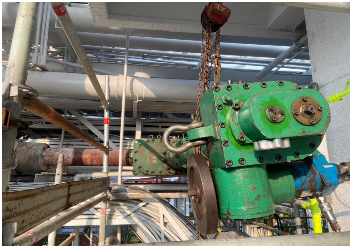
5. 開孔機具安裝並進行斷管作業
