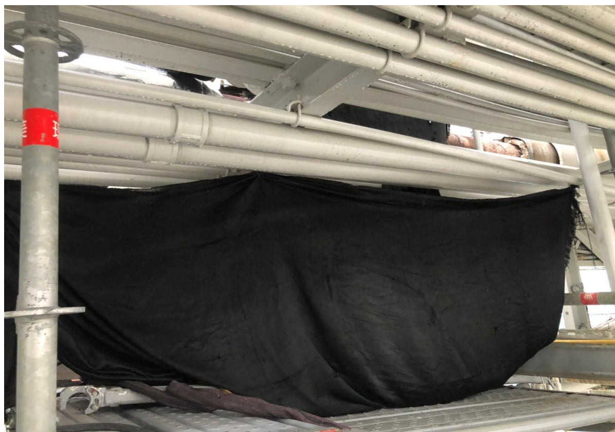
3. 焊接防火毯五面防護情形
