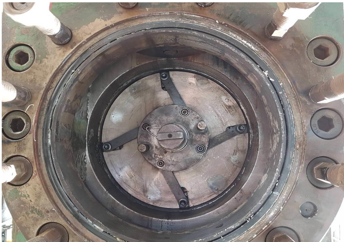
9. 內塞頭安裝完成
