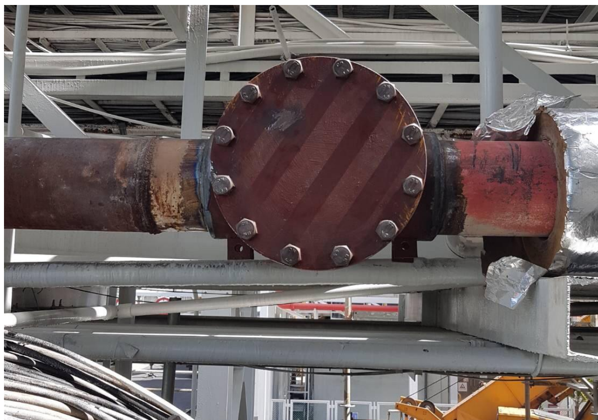
11. 安裝盲法蘭，線上阻斷施工完成
