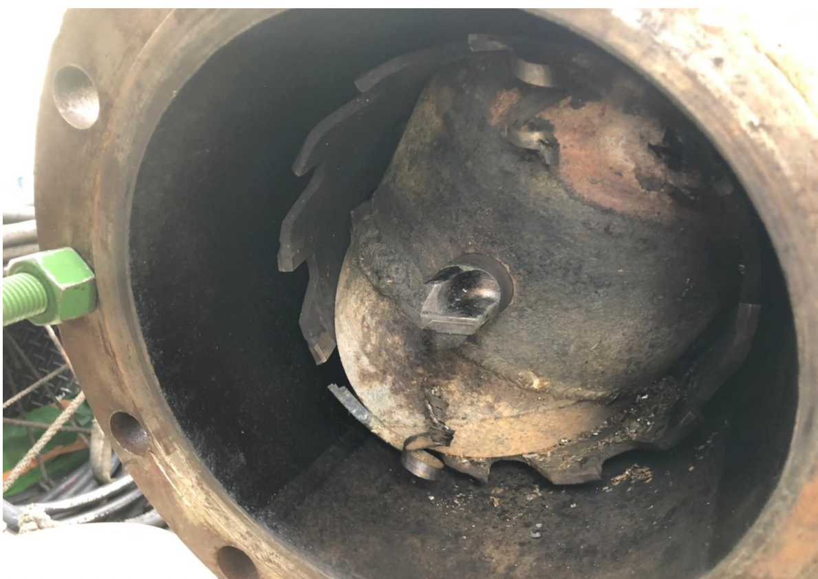
6. 斷管完成，確認料塊取出
