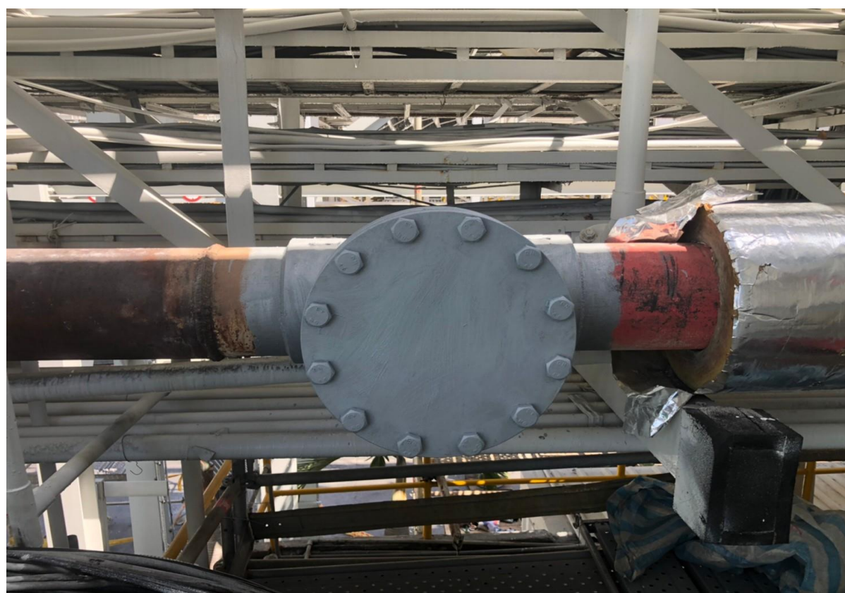
12. 施工完成油漆作業
