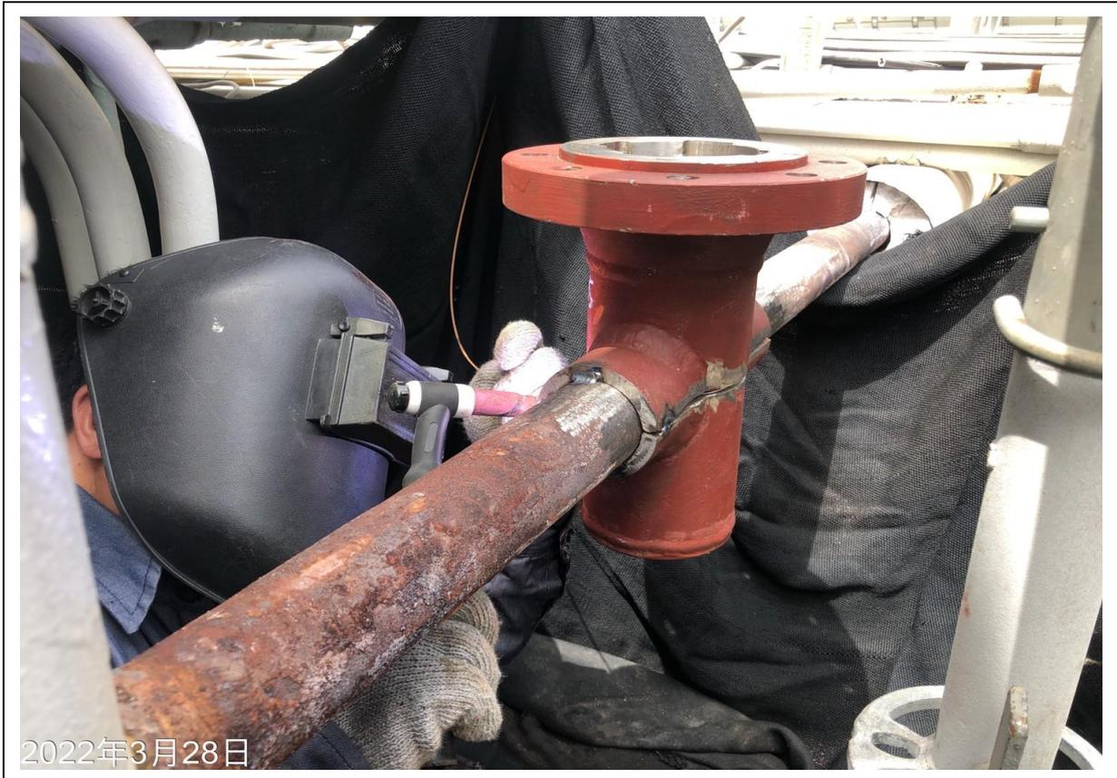
1. 管線研磨後進行模具焊接作業
