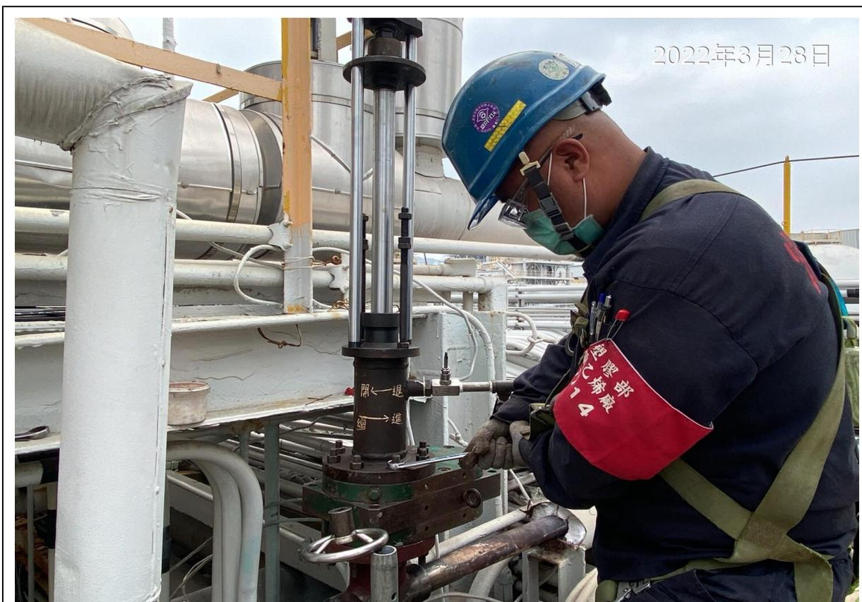
5. 安裝阻斷器進行阻斷作業
