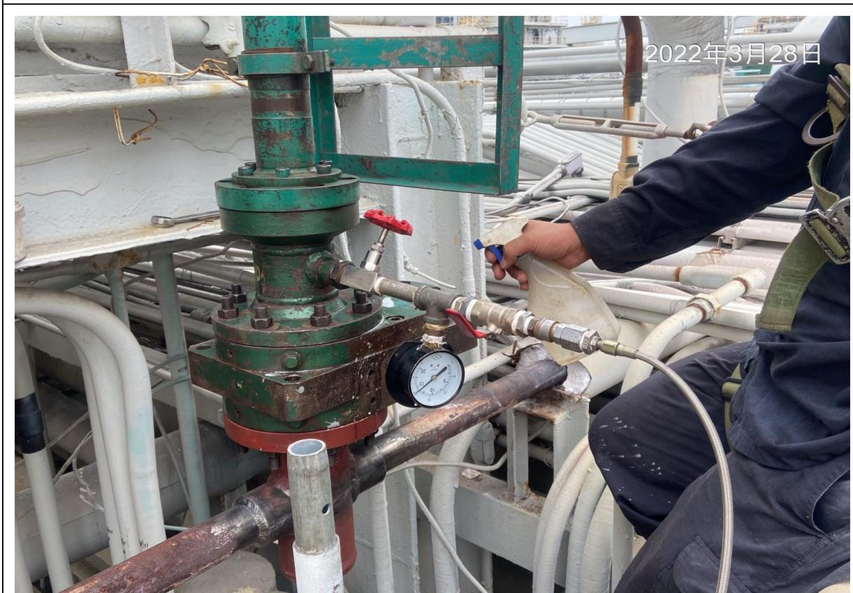
4. 試壓作業後進行斷管作業
