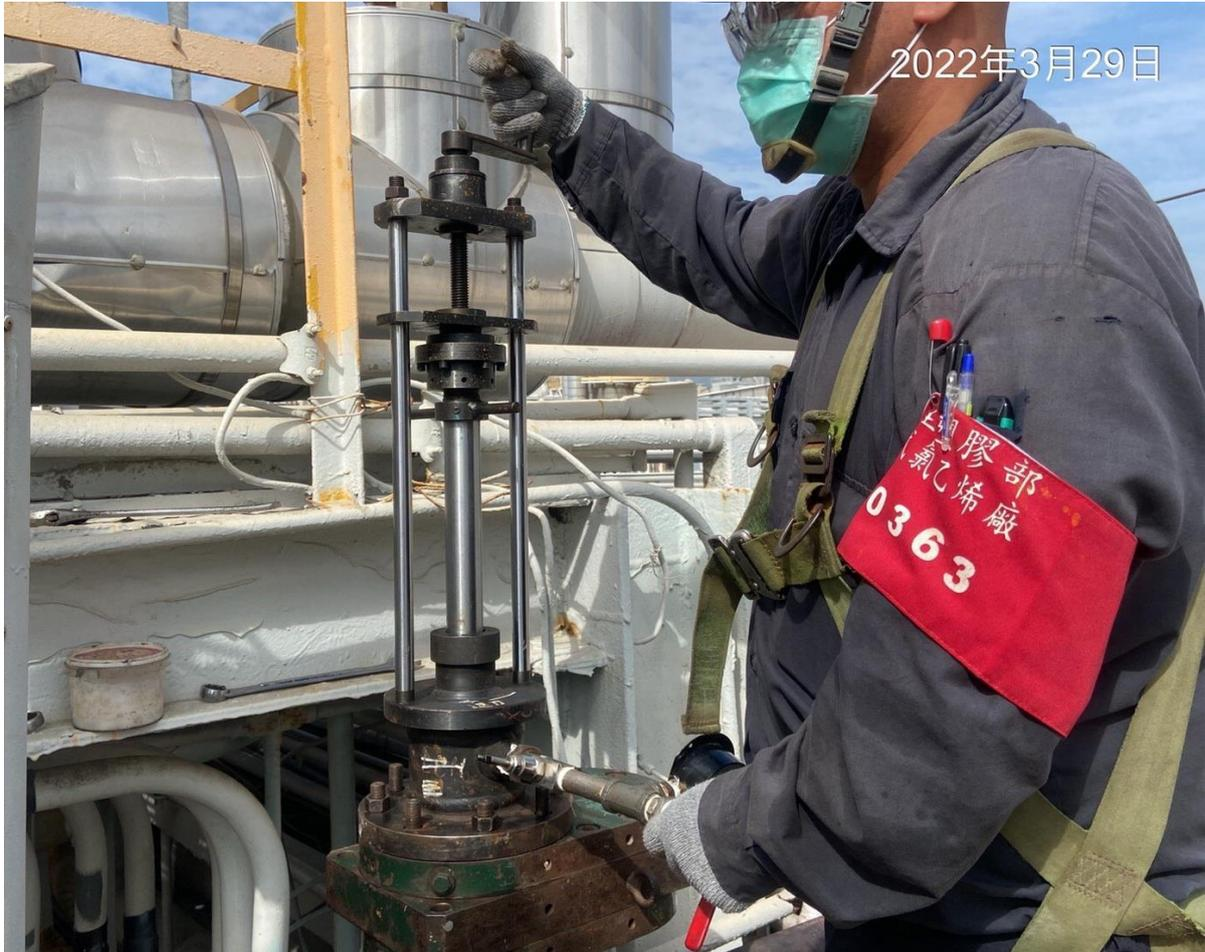
工程名稱：南部石化廠 2 吋中壓蒸氣阻斷增閥作業
