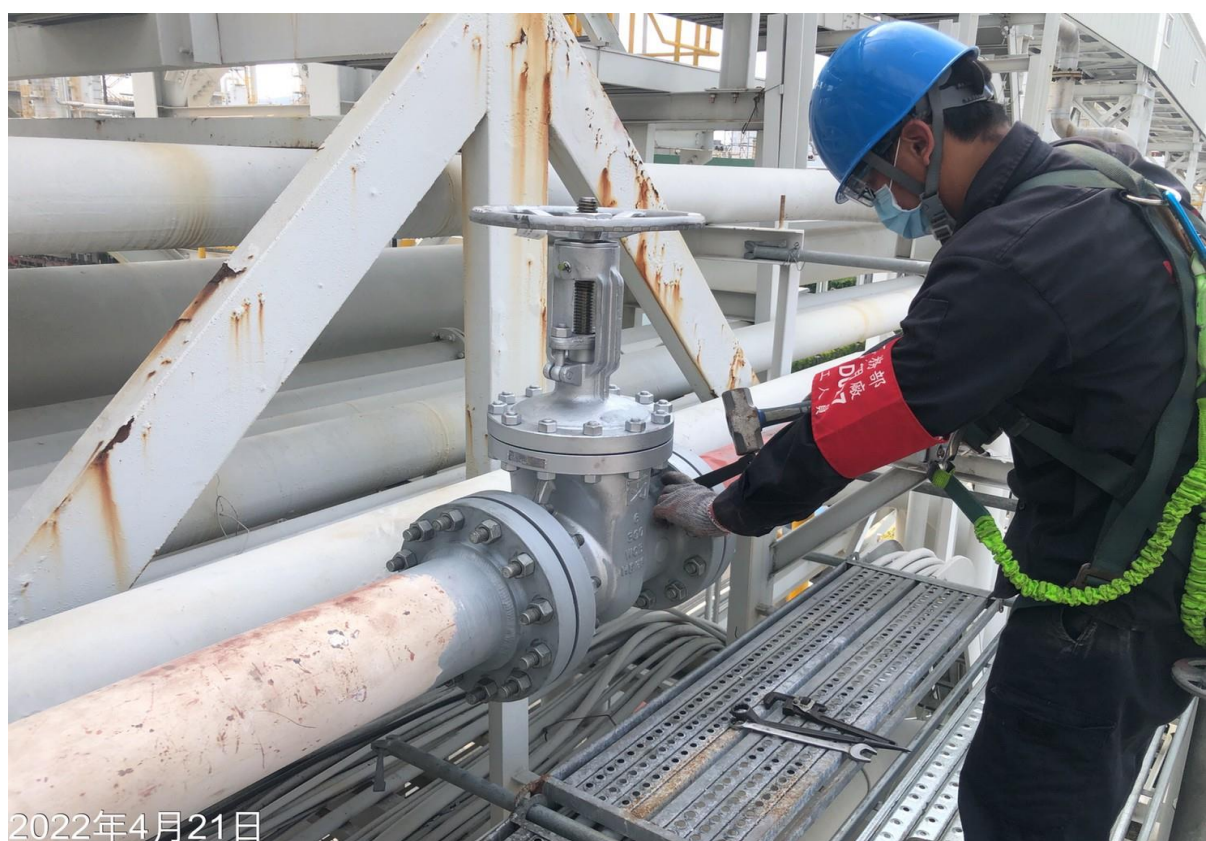
29. 阻斷後增設閥件完成(6")
