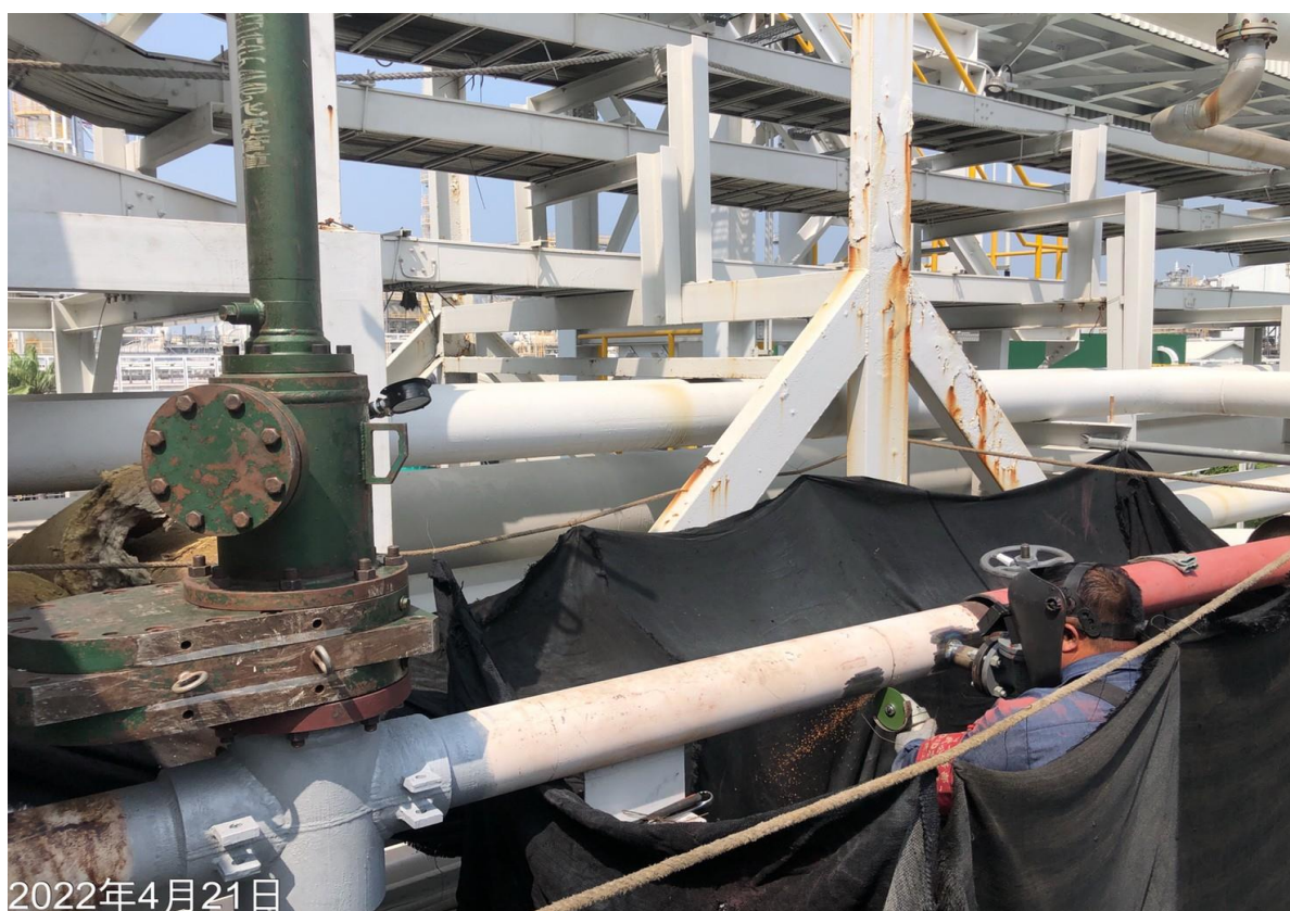
26. 管線阻斷後進行切管作業(6")
