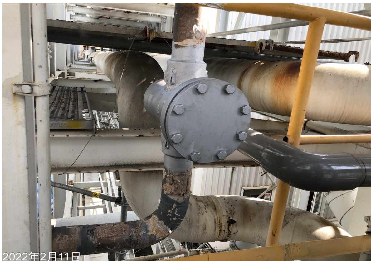
19. 施工完成安裝盲法蘭
