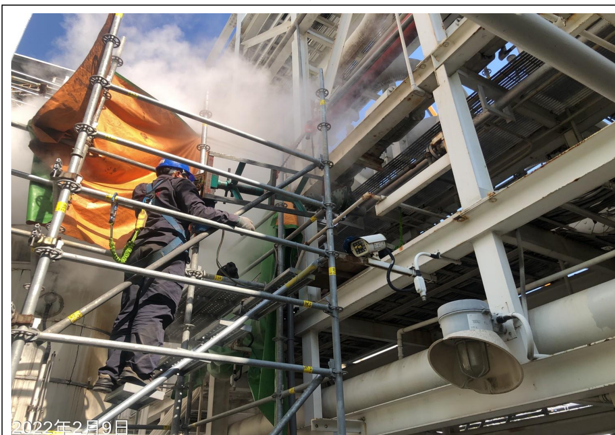
11.安裝夾板閥及開孔機進行斷管作業(1'')
