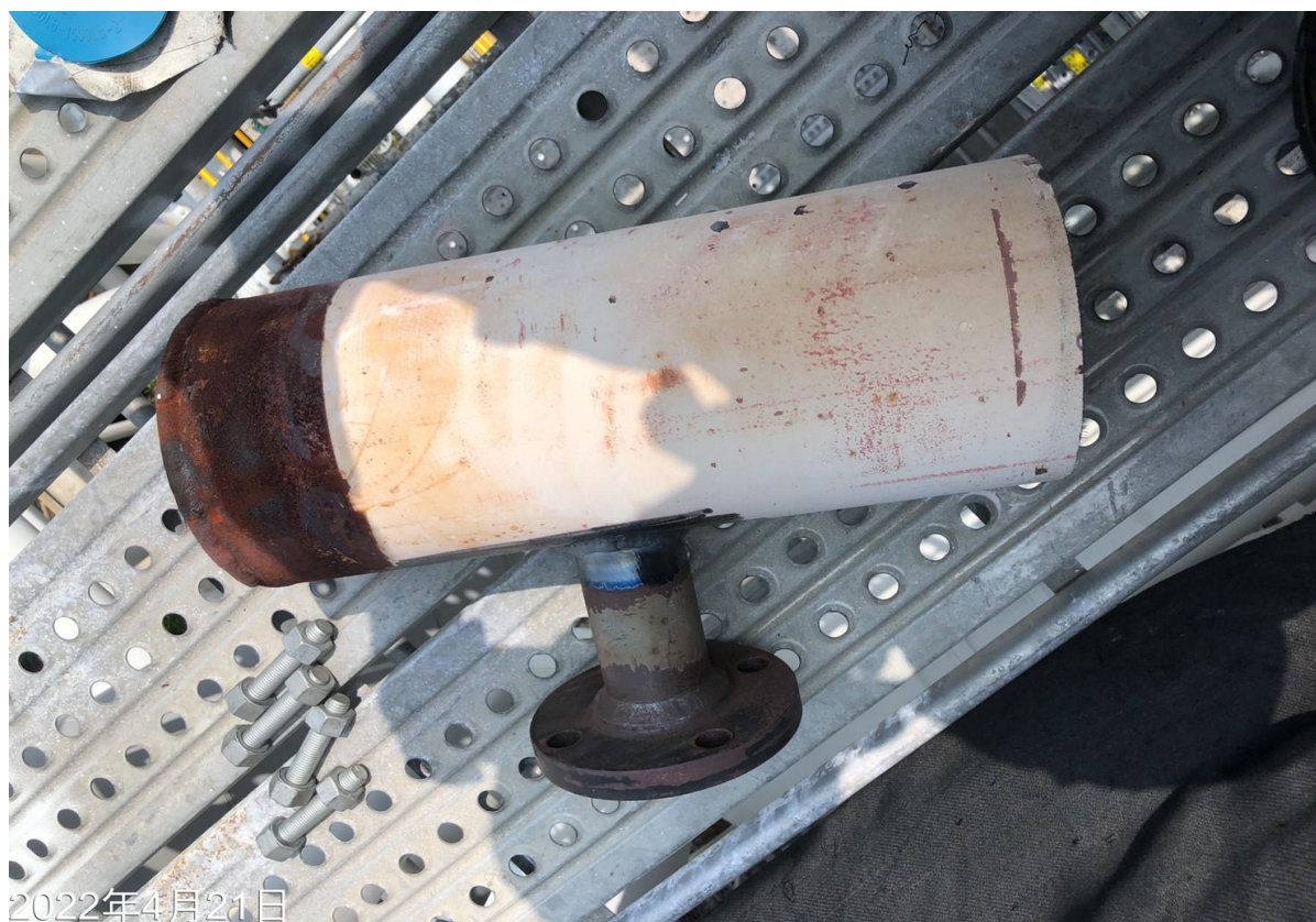
27. 管線切除作業
