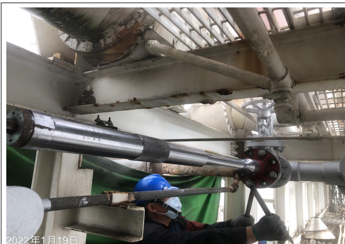
7. 安裝開孔機後進行開孔作業
