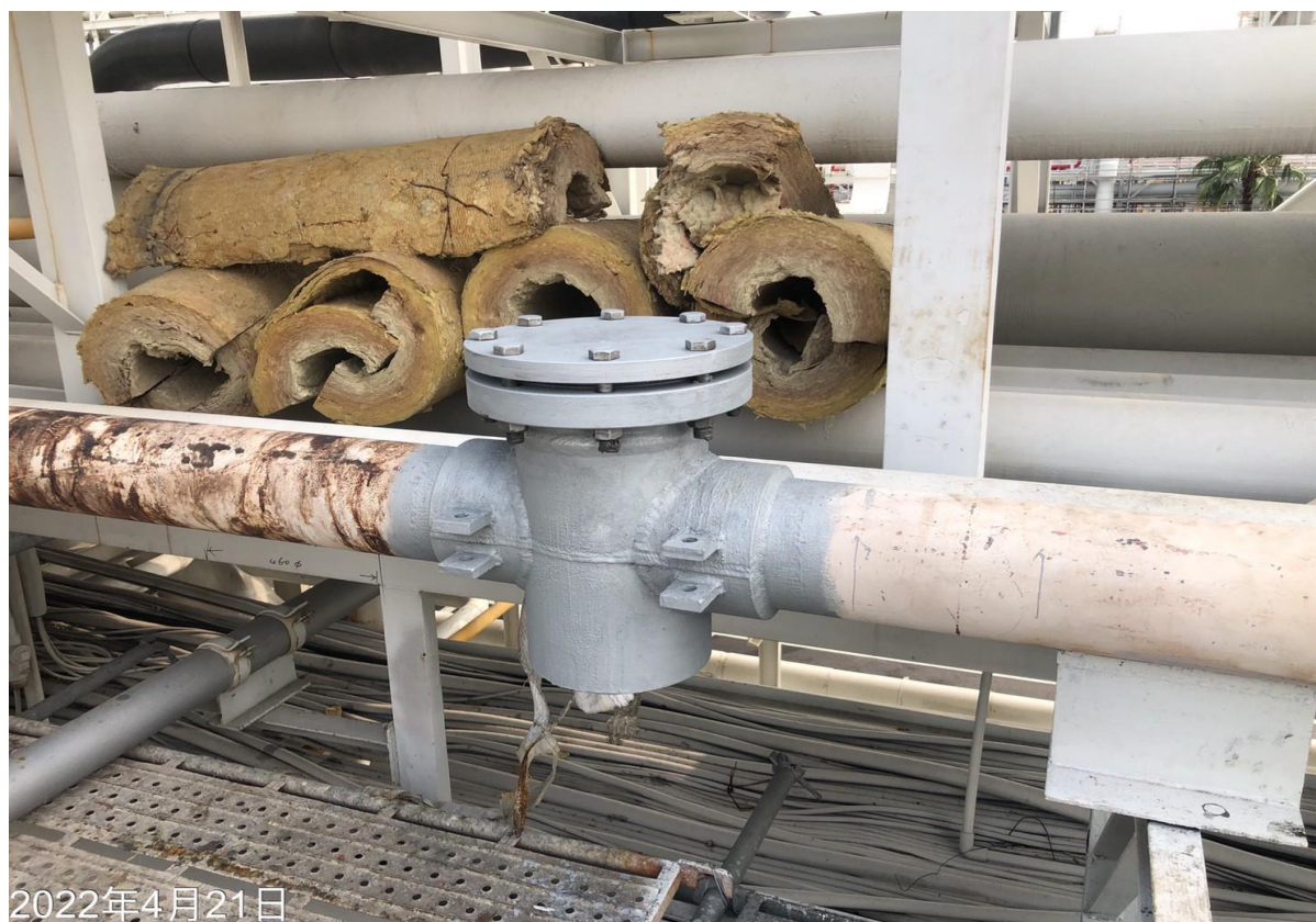
31. 施工完成安裝盲法蘭及油漆作業
