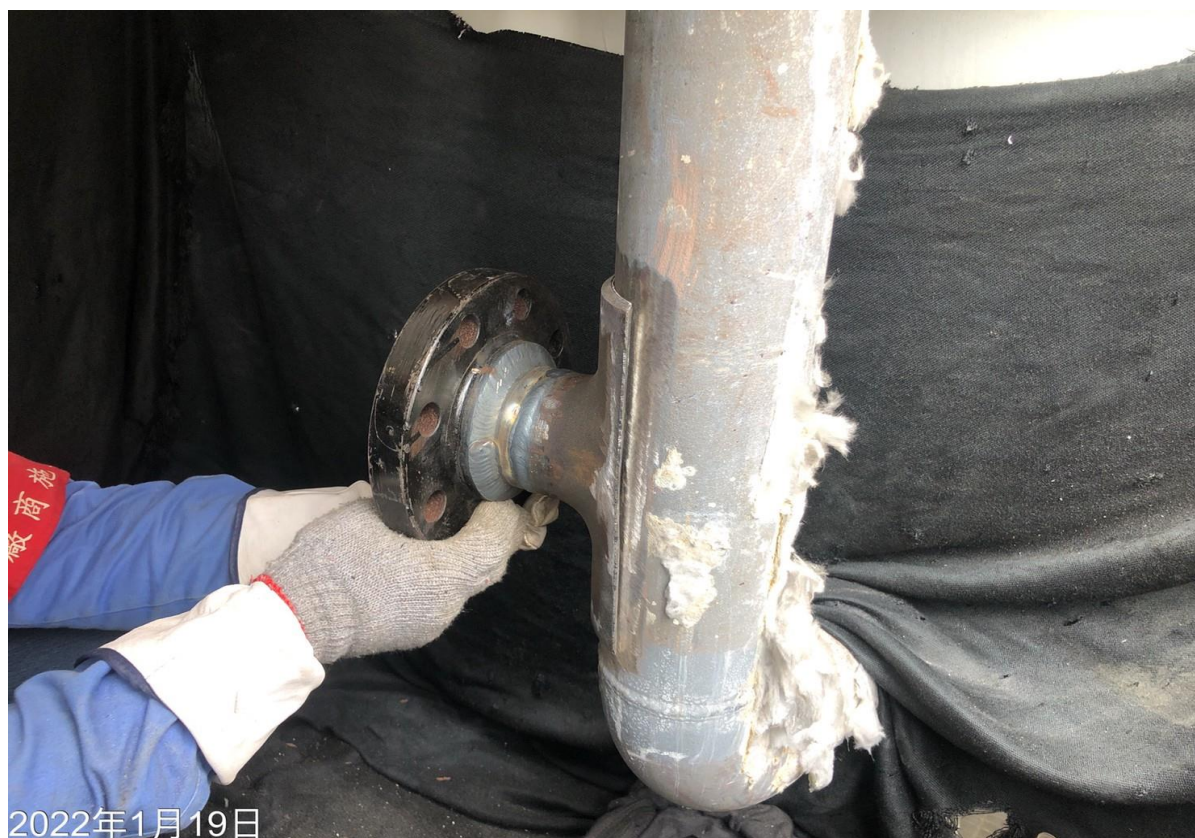
5. 3"插管焊接作業
