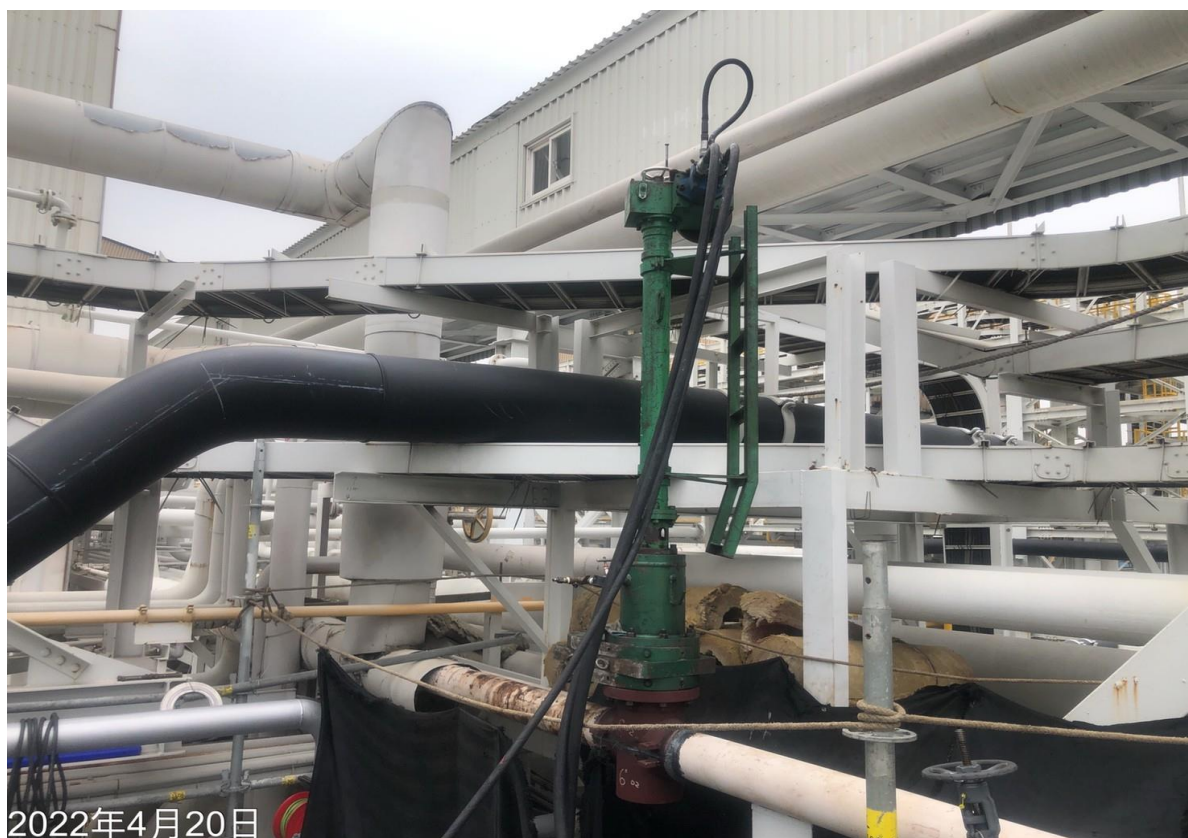
23.安裝夾板閥及開孔機進行斷管作業
