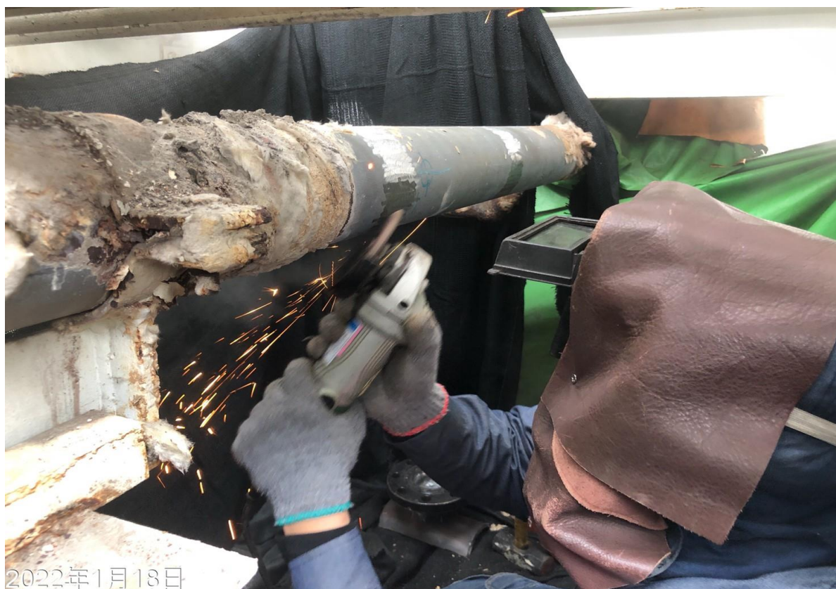
1. 管線研磨作業
