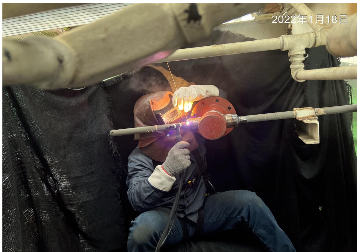
3. 1”模具焊接作業
