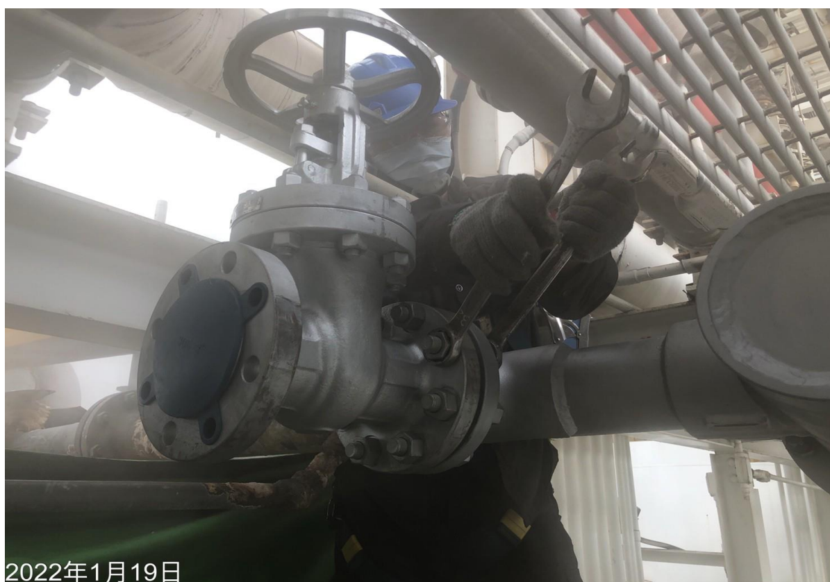
6. 插管閥件安裝
