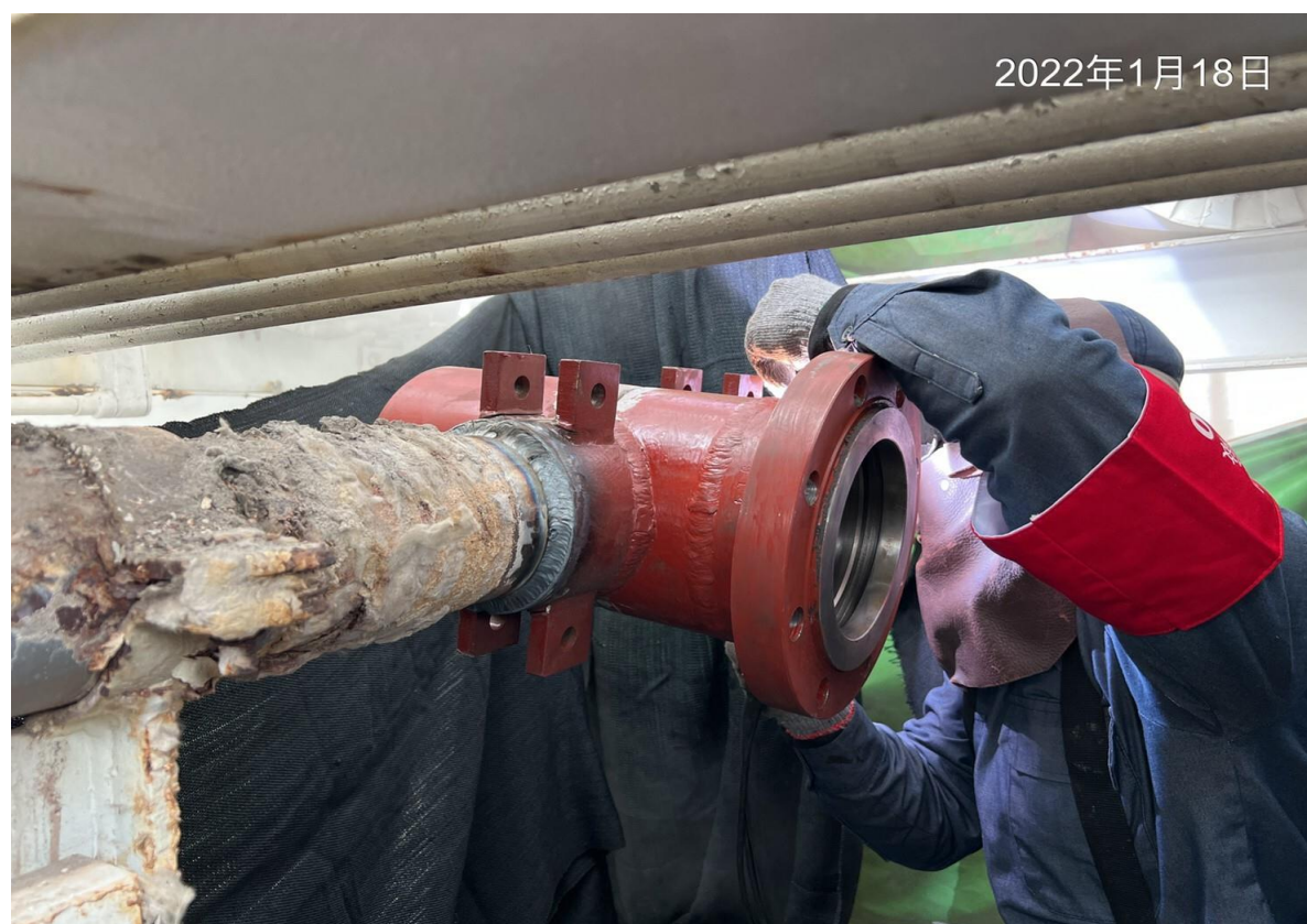
4. 4”模具焊接作業
