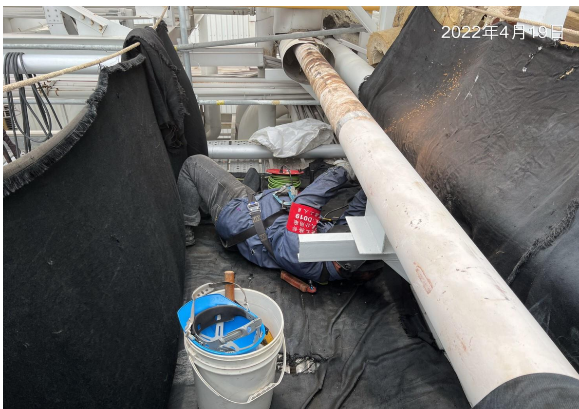
20. 管線研磨作業(6")
