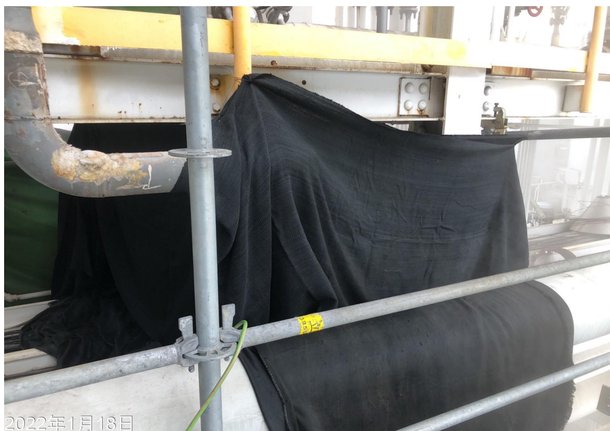
2. 焊接五面防護情形
