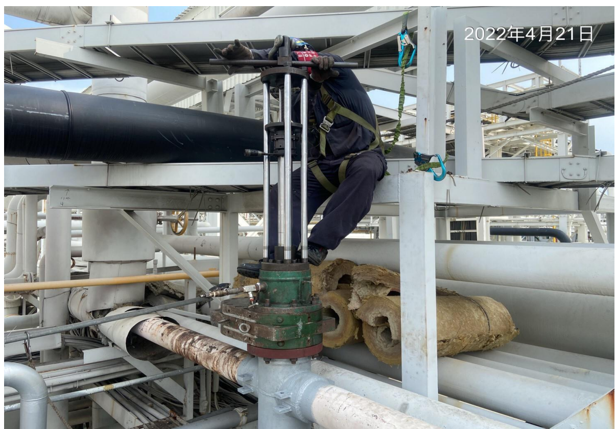
30. 人員進行下堵作業(6")
