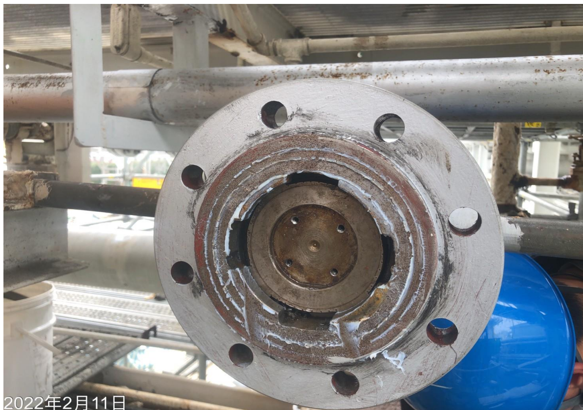
17.內塞頭安裝完成
