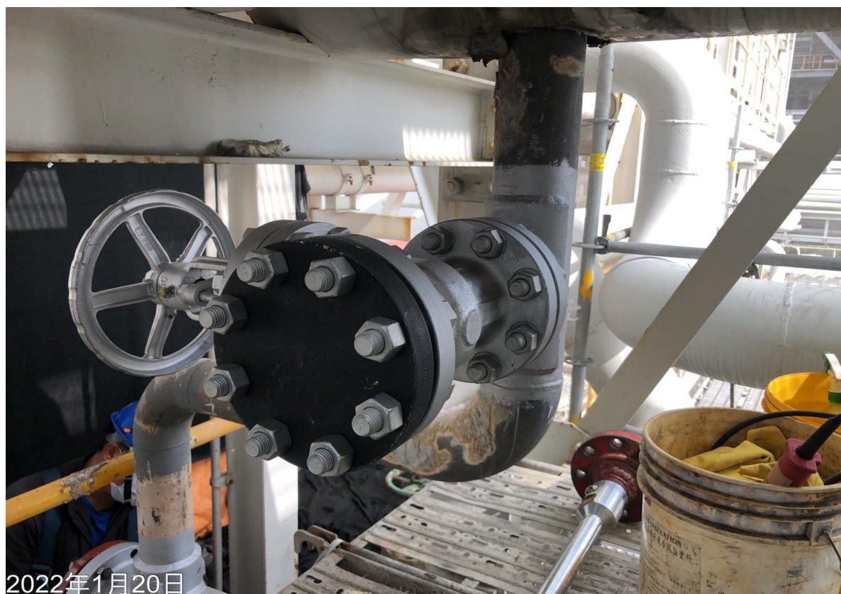
9. 開孔完成安裝盲法蘭
