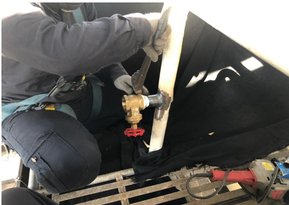
13. 模具焊接完成後安裝閥件(2")
