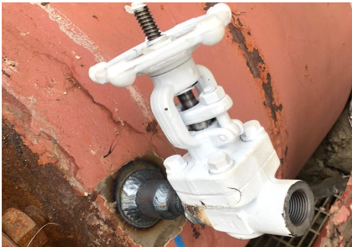
25. 短管焊接安裝閥件(3/4")
