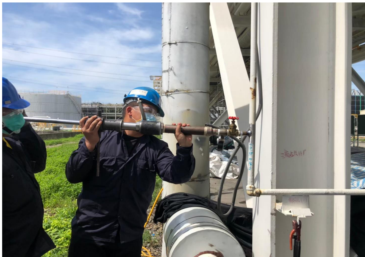
3. 人員安裝開孔機及閥件情形(1'')
