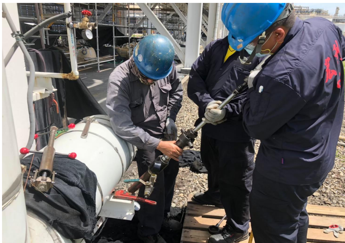
4. 人員安裝開孔機及閥件情形(1'')
