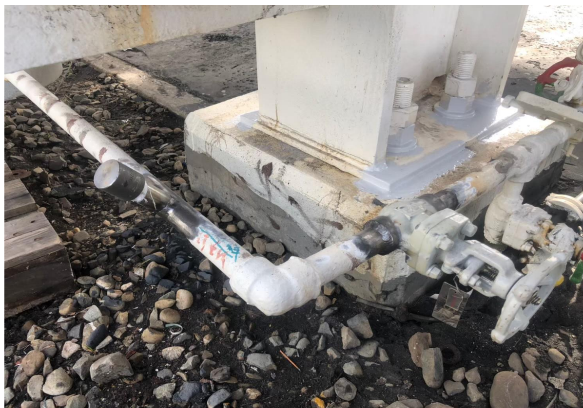
12. 阻斷新增隔離閥完成(1")
