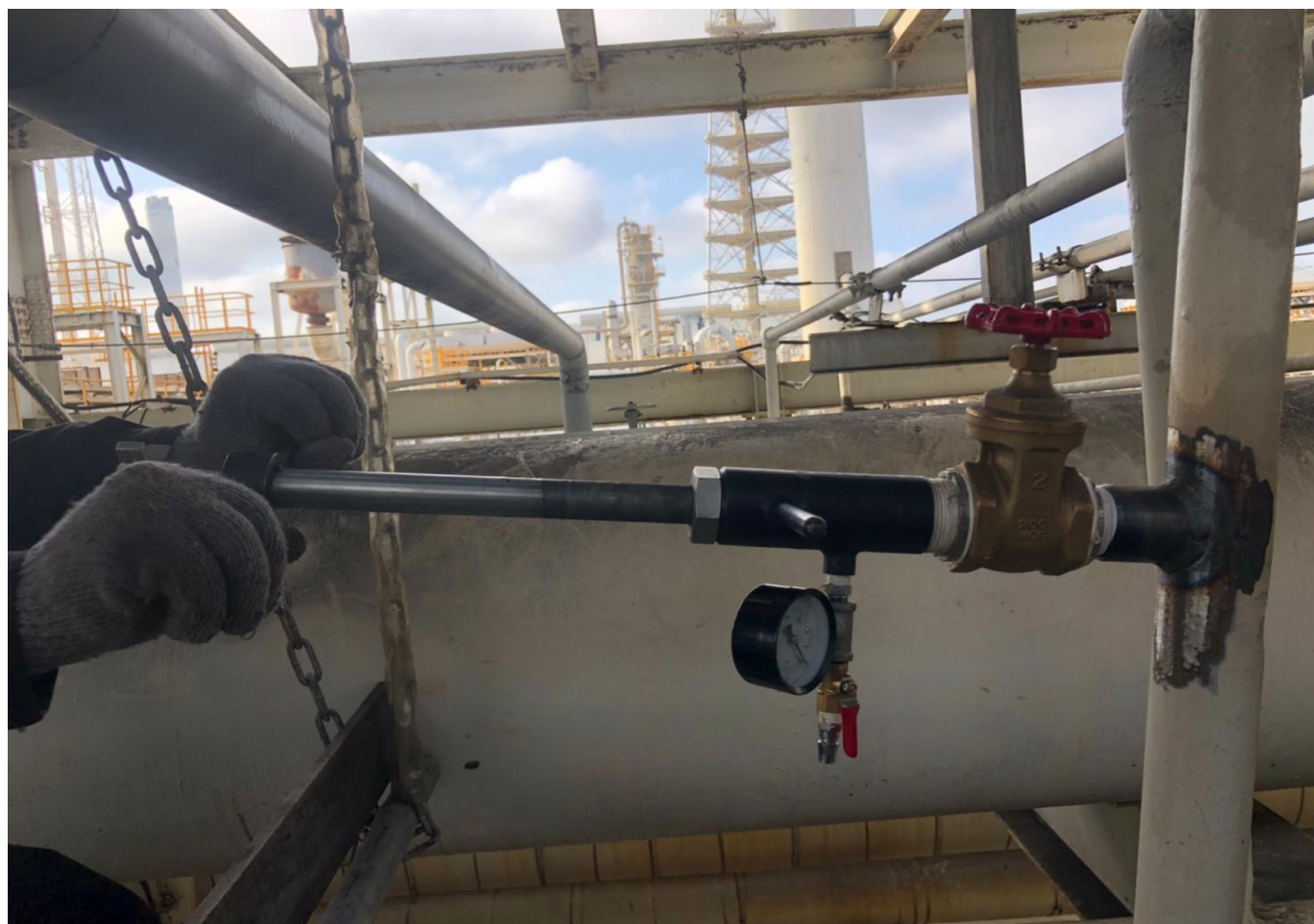
17. 人員進行下堵作業(2")
