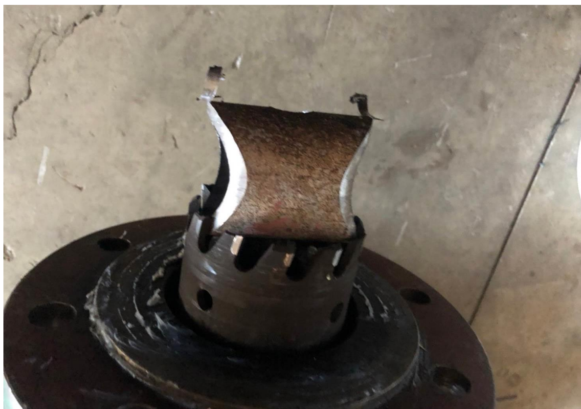
32. 斷管完成確認料塊取出
