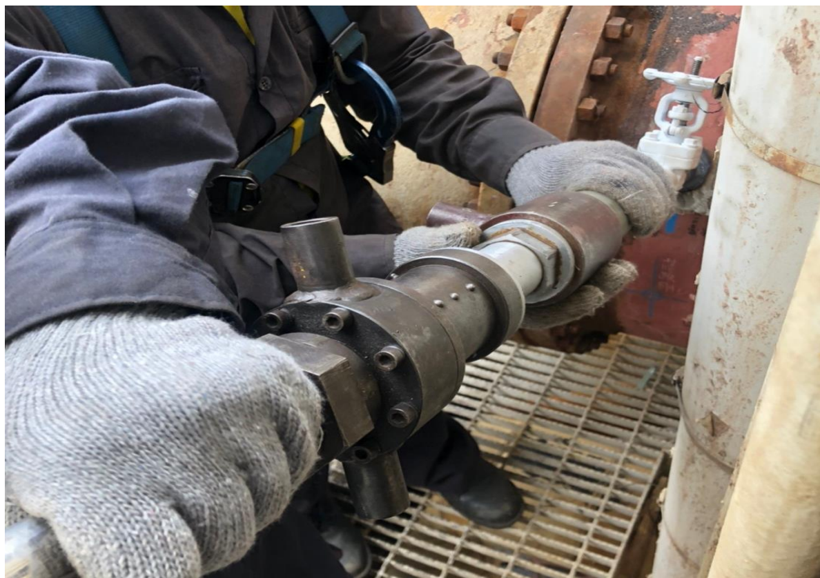
27. 人員進行開孔作業
