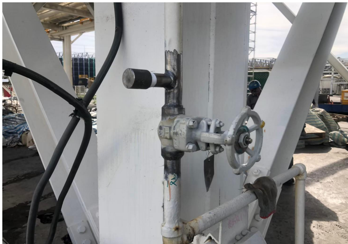
11. 阻斷新增隔離閥完成(1")
