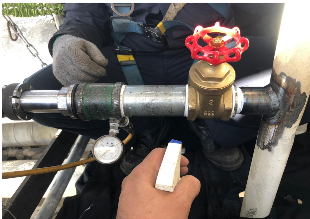
14. 人員進行開孔作業(2")
