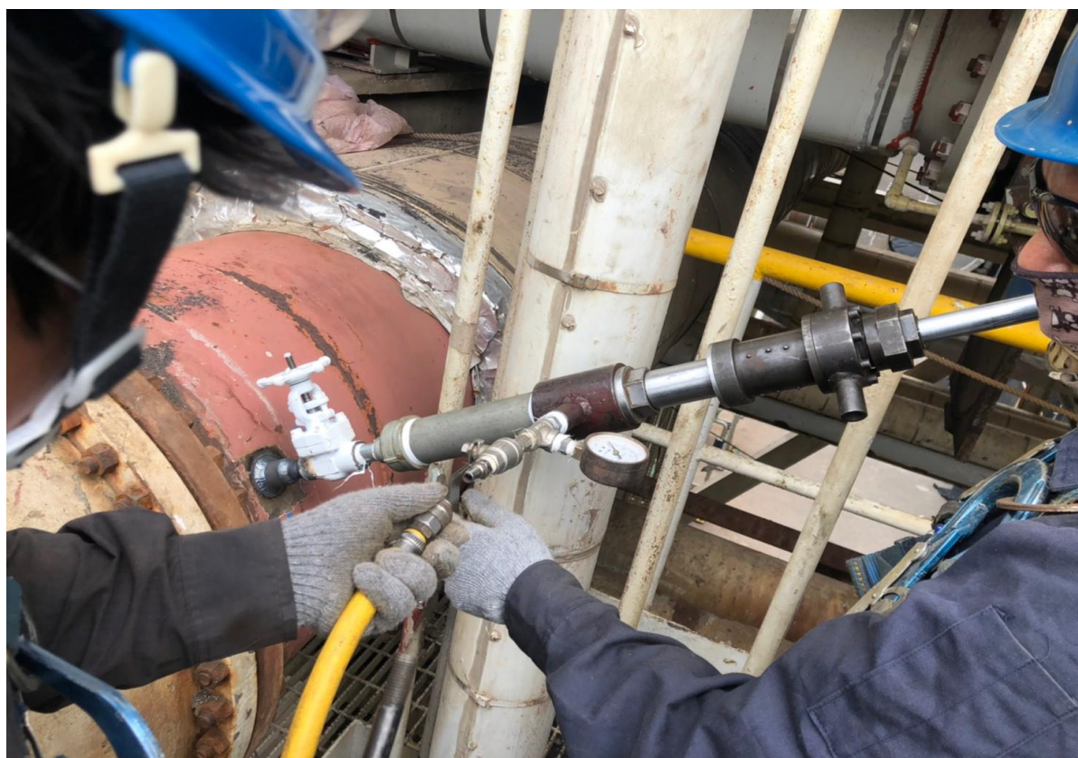
26. 持壓抓漏測試(3/4")
