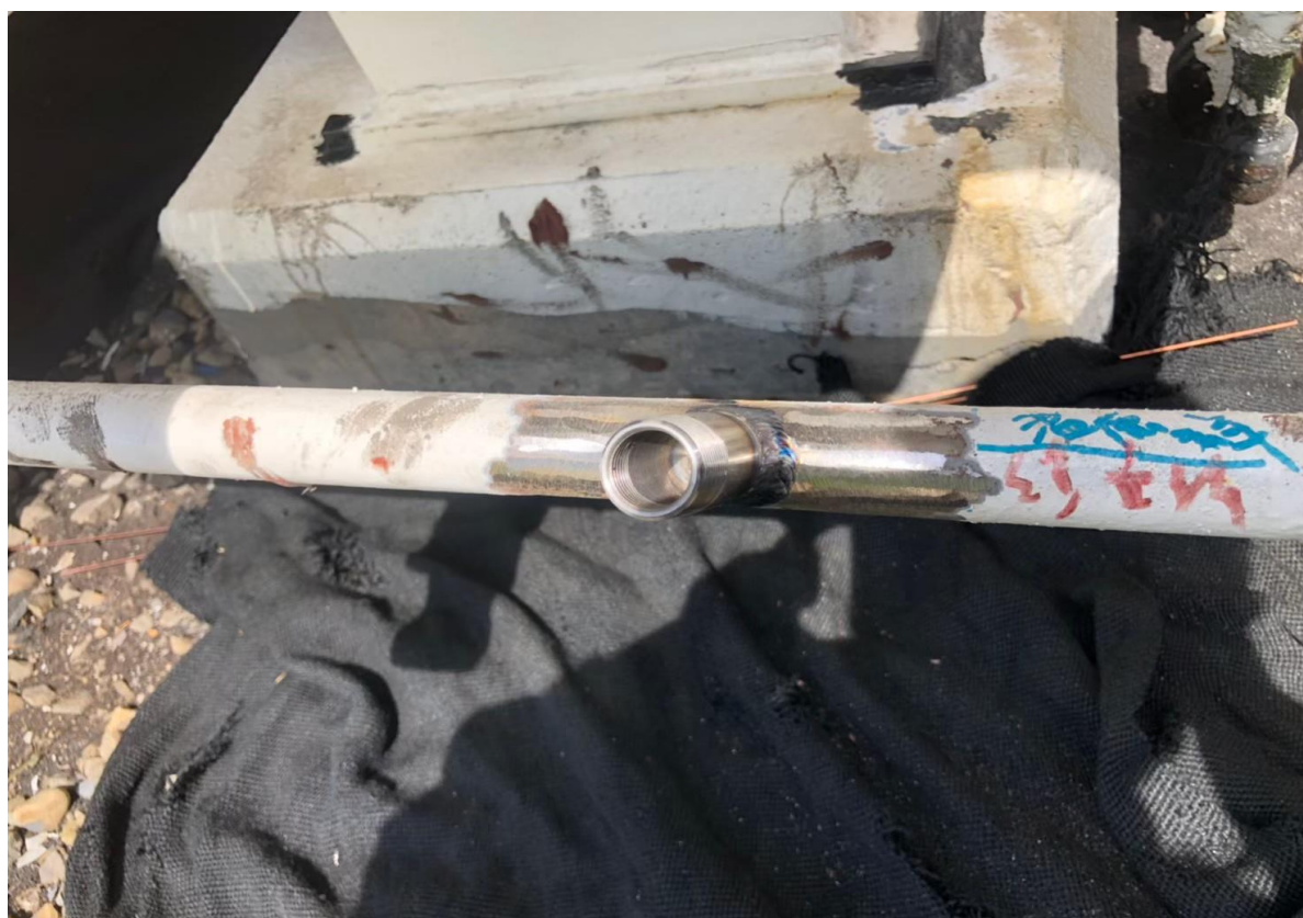
2. 模具焊接作業(1'')
