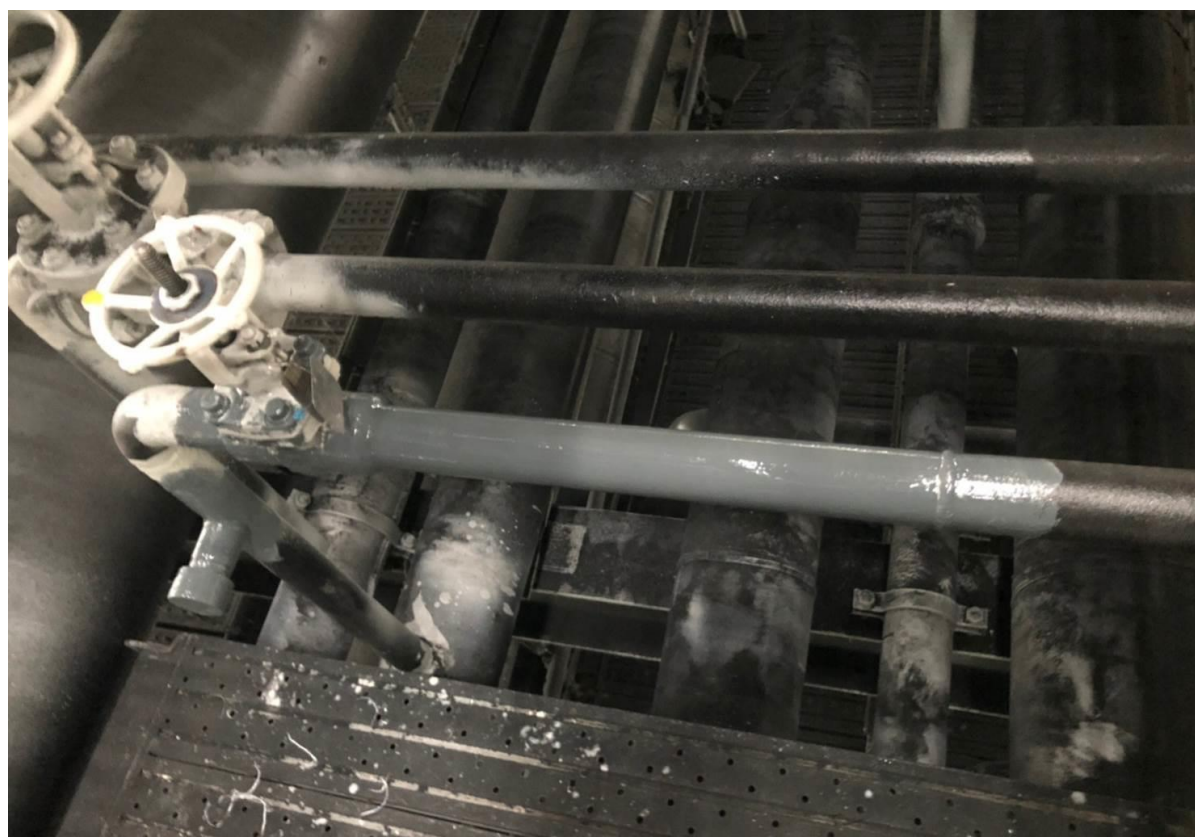
24. 阻斷新增隔離閥完成(2")
