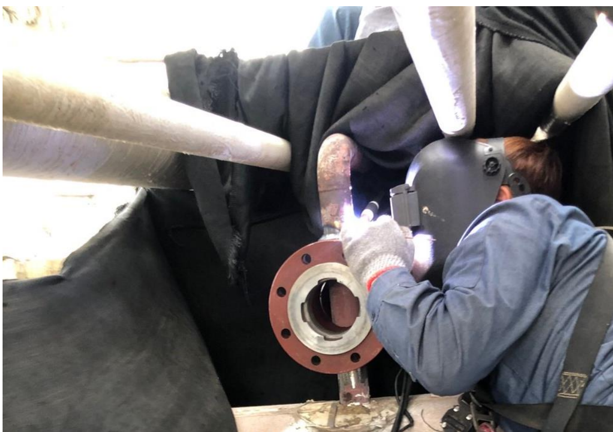
30. 模具焊接作業
