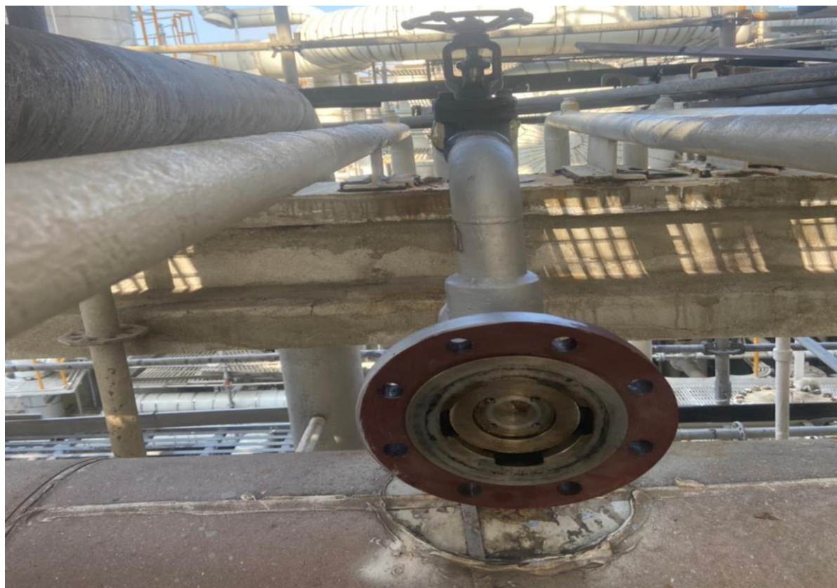
37. 阻斷新增隔離閥完成
