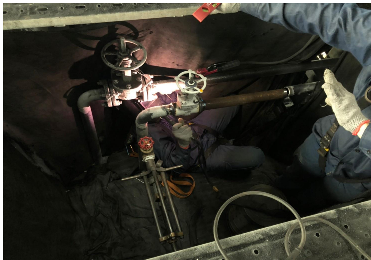
22. 阻斷新增隔離閥作業(2'')
