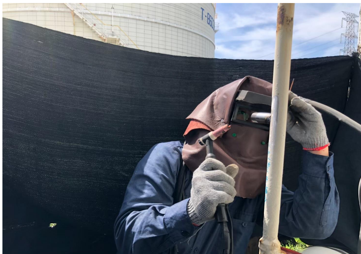
1. 模具焊接作業(1'')
