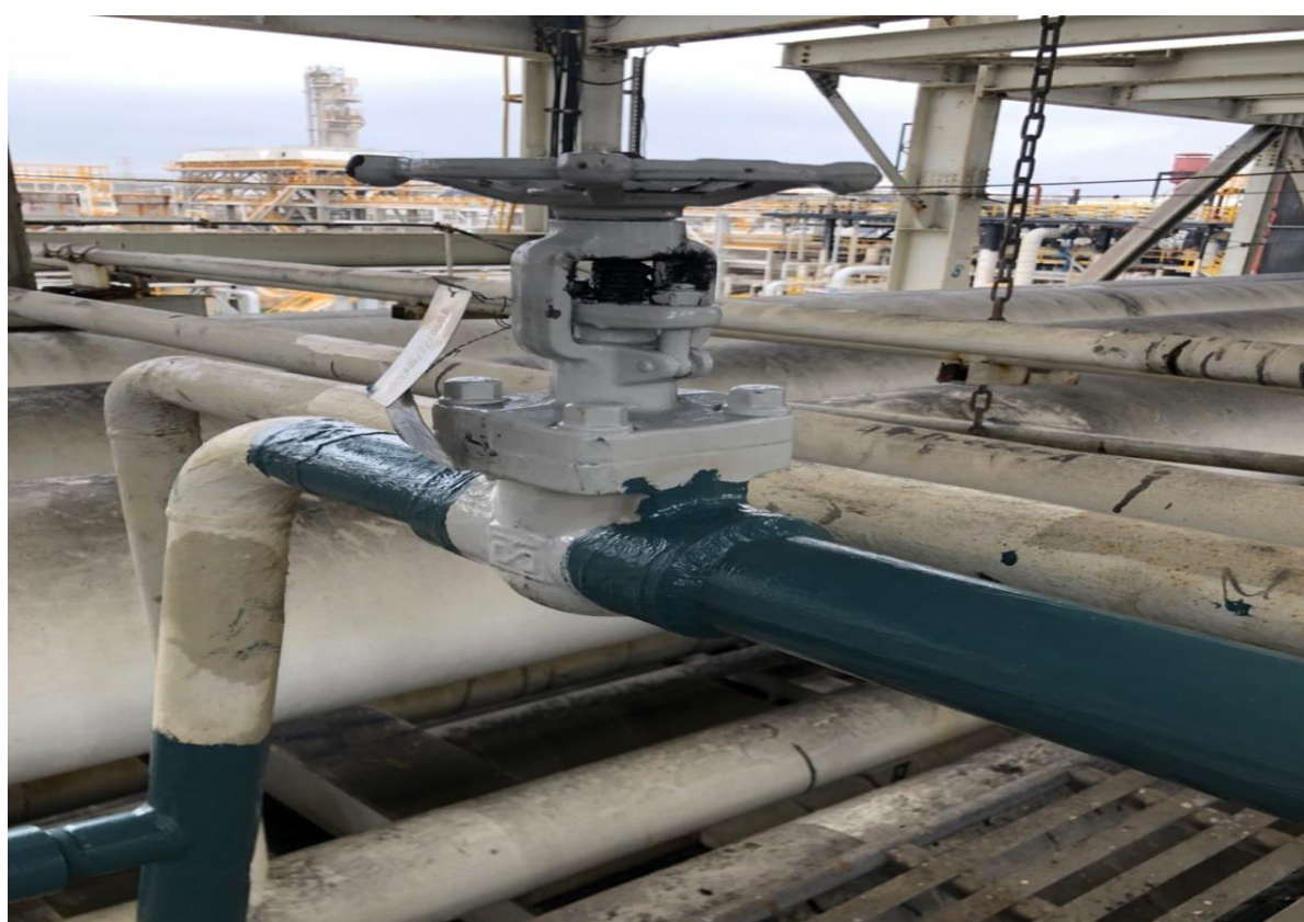
18. 阻斷新增隔離閥完成(2")
