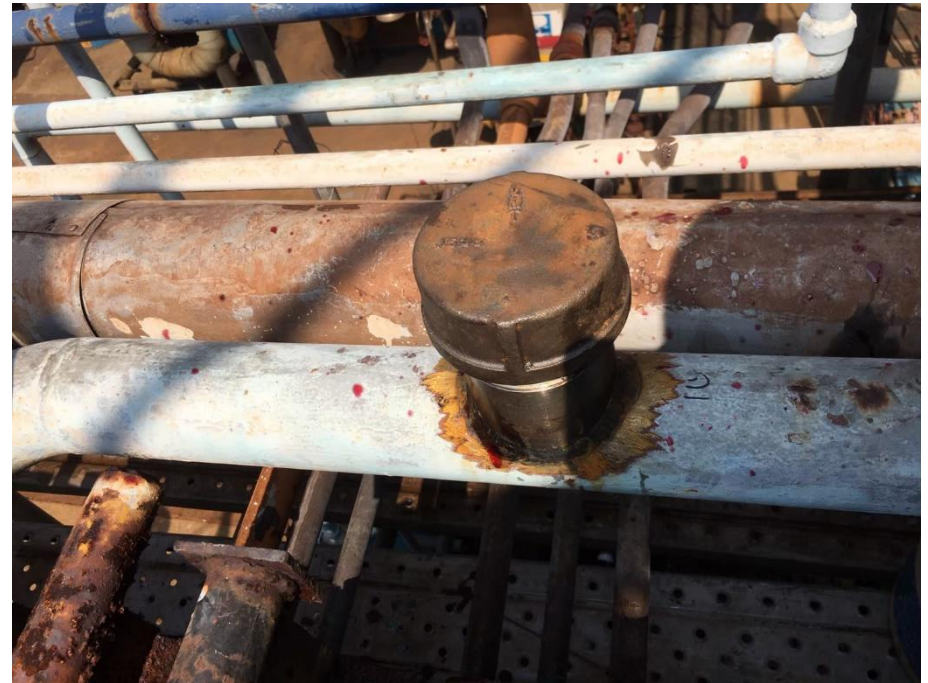
12. 施工完成，安裝盲蓋
