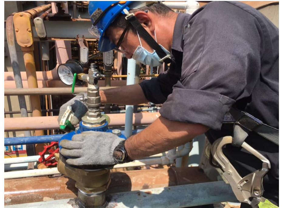
4. 人員安裝閥件及試壓抓漏作業
