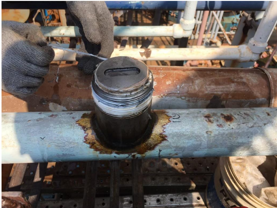
11. 下堵安裝完成
