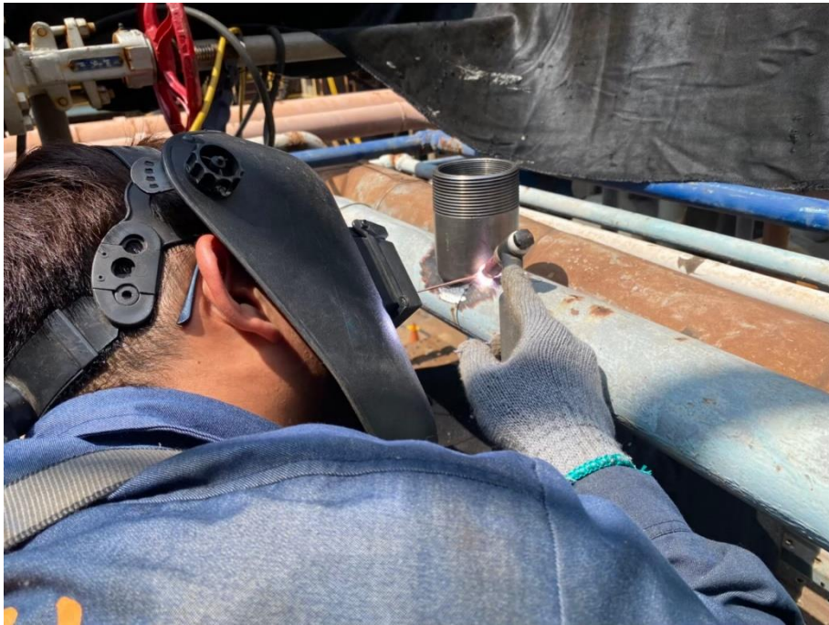
3. 管線研磨及模具組焊作業
