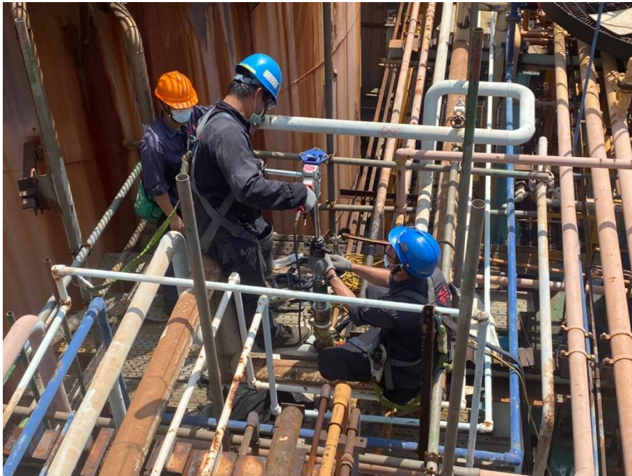
5. 人員執行開孔作業
