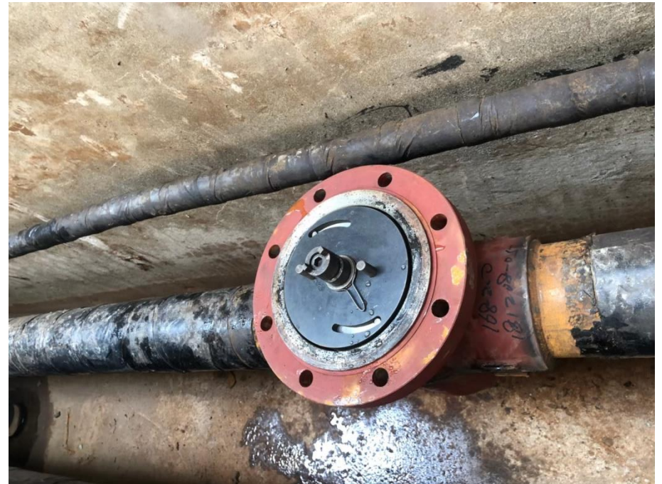
14. 內塞頭安裝完成
