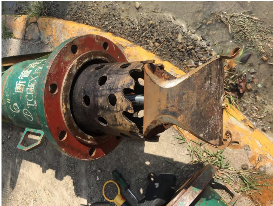
7. 斷管完成確認料塊取出
