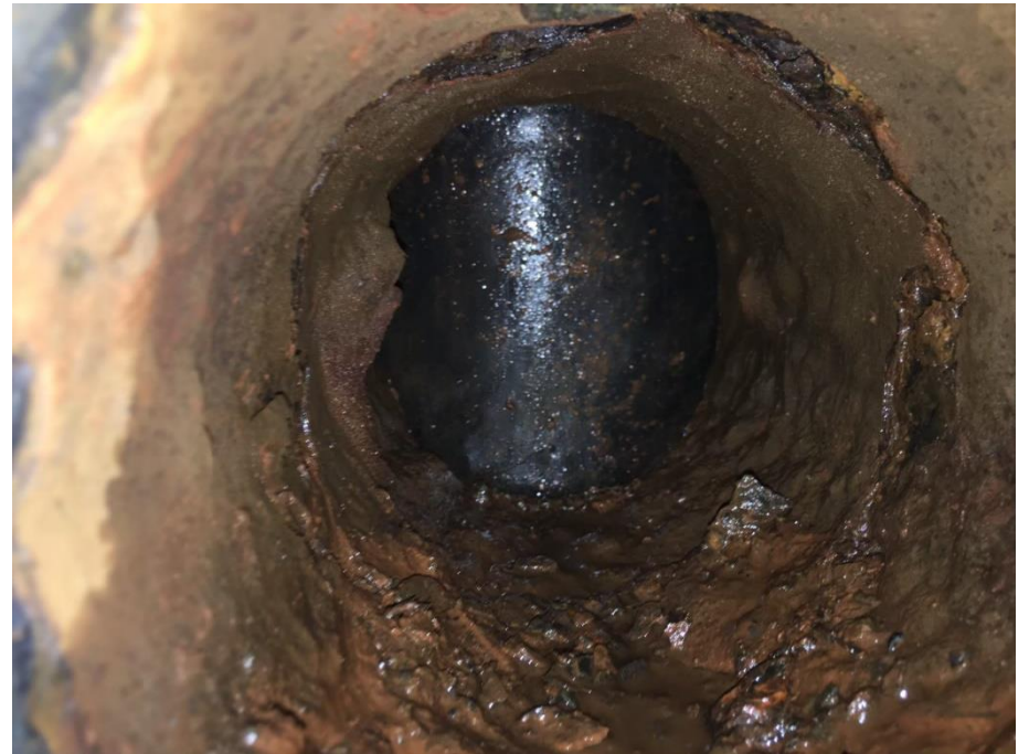
10. 阻斷完成切管後內部情形
