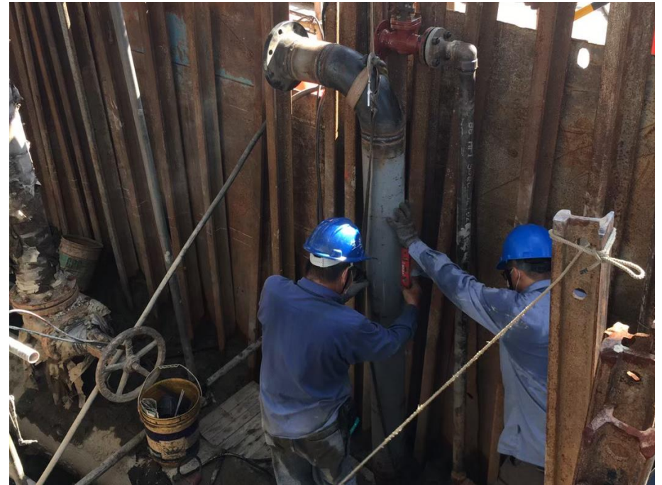
12. 阻斷後新增短管作業(2)
