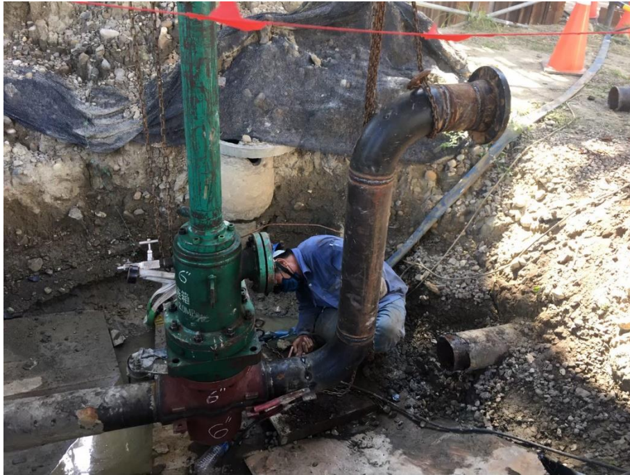
11. 阻斷後新增短管作業(1)
