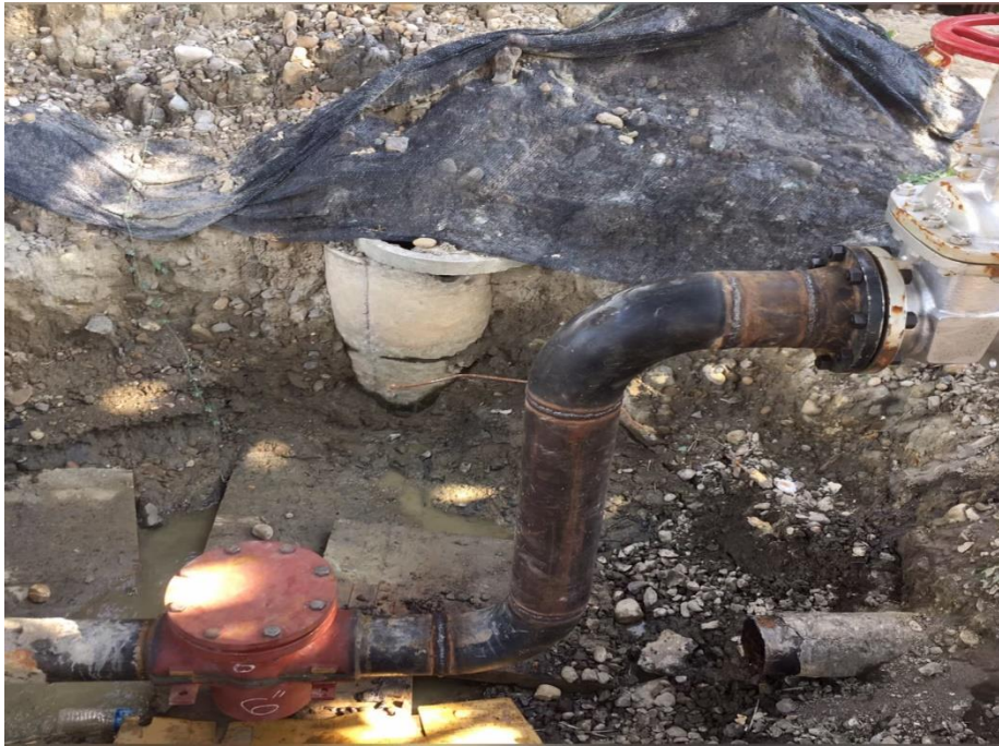
15. 施工完成，安裝盲蓋(1)
