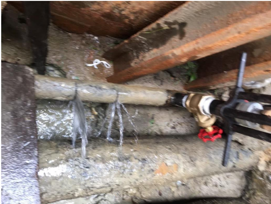
7. 人員進行切管確認阻斷情形
