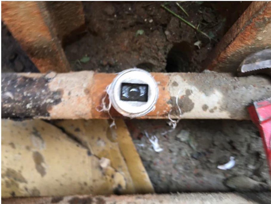
11. 下堵安裝完成
