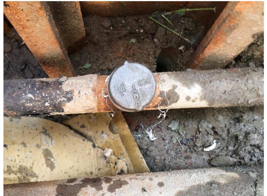
12. 施工完成，安裝盲蓋
