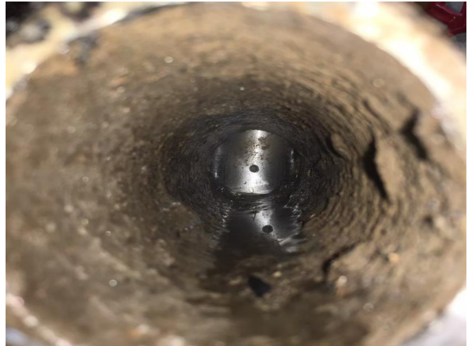
8. 管線切管後管內情形
