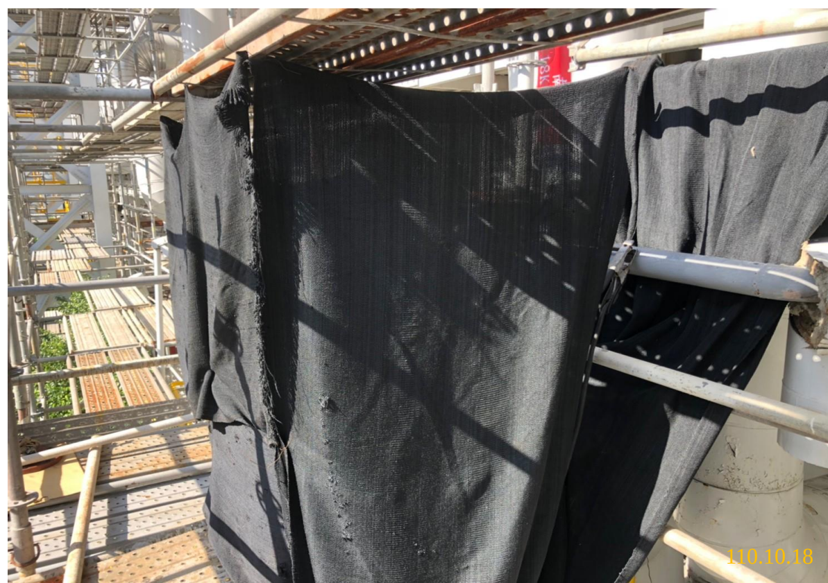
2. 人員焊接五面防護情形
