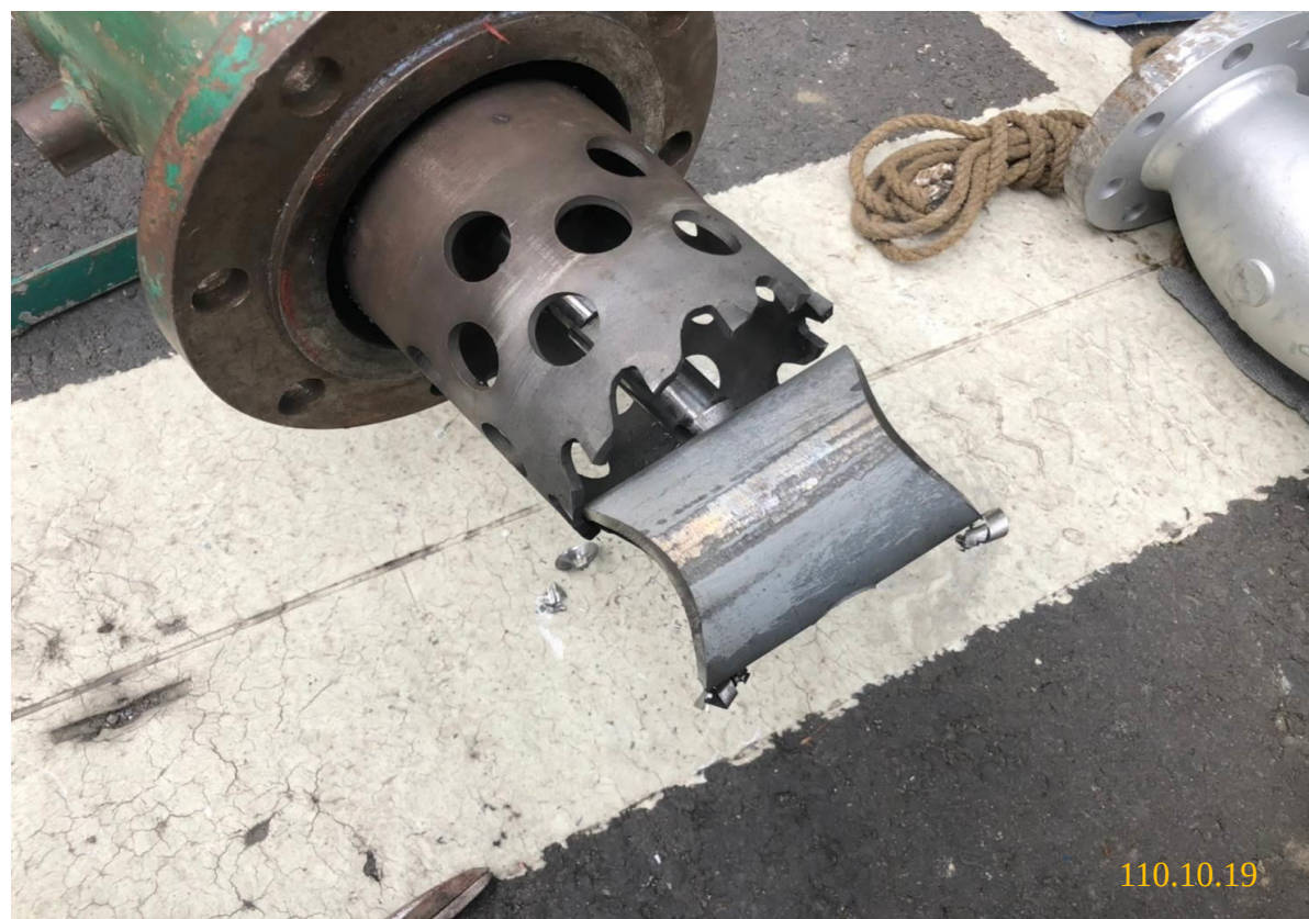
6. 斷管完成，確認鐵塊取出
