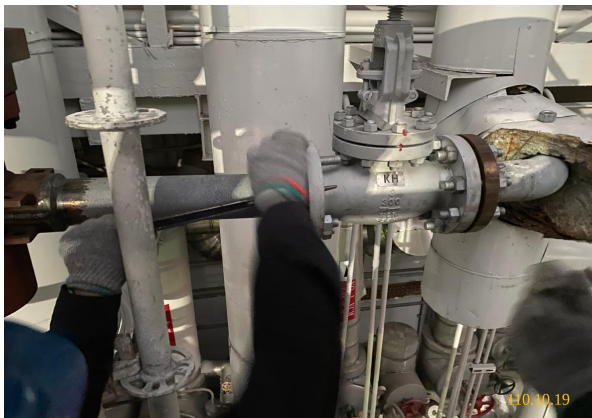
9. 閥件增設作業
