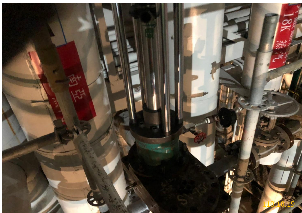
11. 人員進行下堵作業
