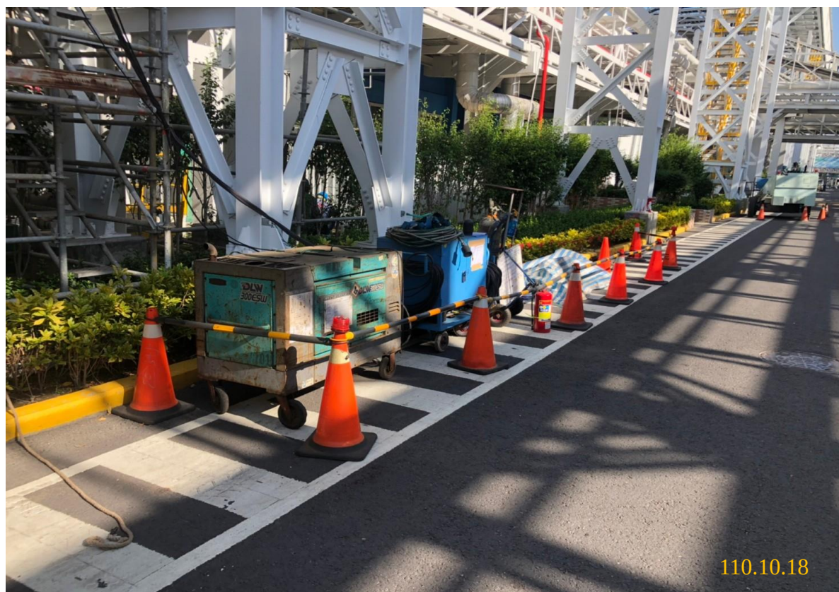
3. 施工機具定位情形
