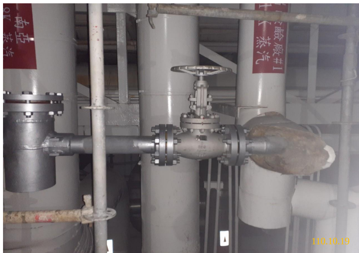
12. 蒸汽管線上阻斷作業施工完成
