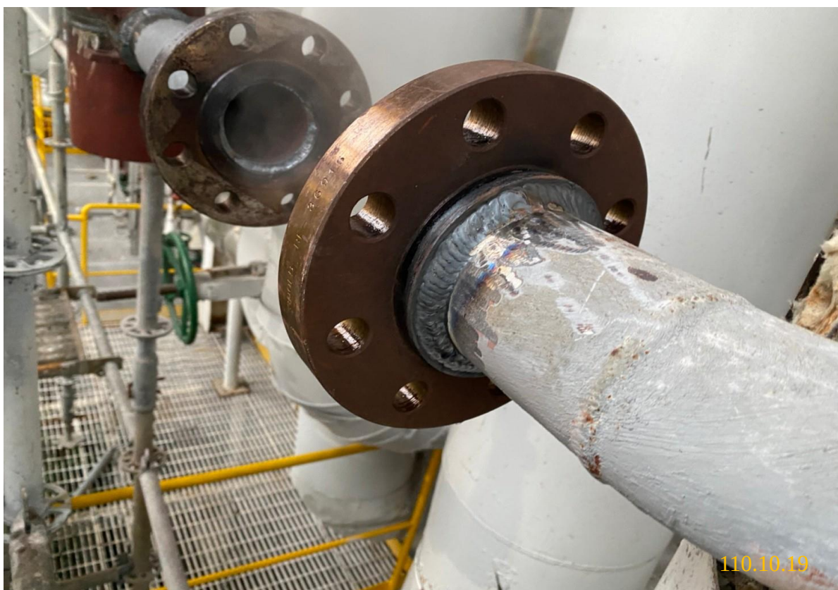
8. 阻斷後，人員進行切管焊接作業
