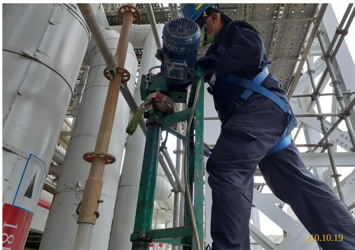
4. 人員安裝夾板閥及開孔機作業
