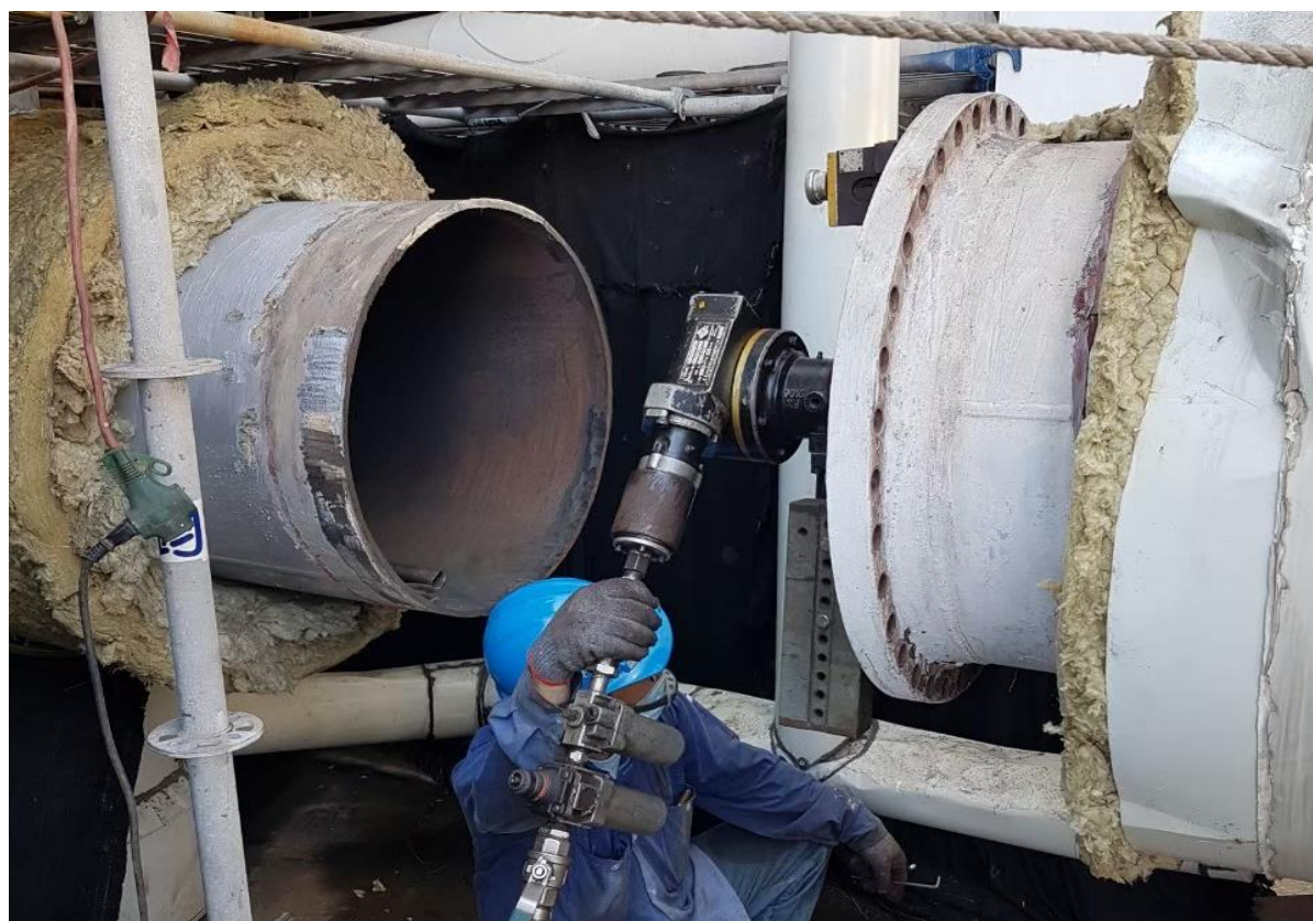
7. 管線切管及法蘭旋削情形
