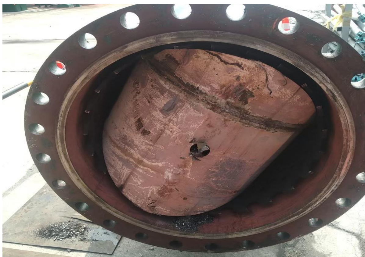
4. 斷管完成，確認鐵塊取出
