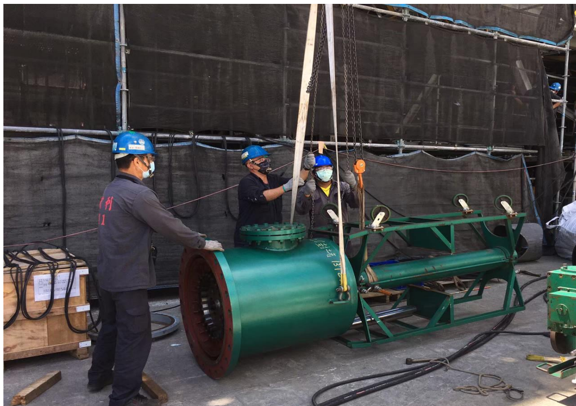
5. 安裝阻斷器進行阻斷作業
