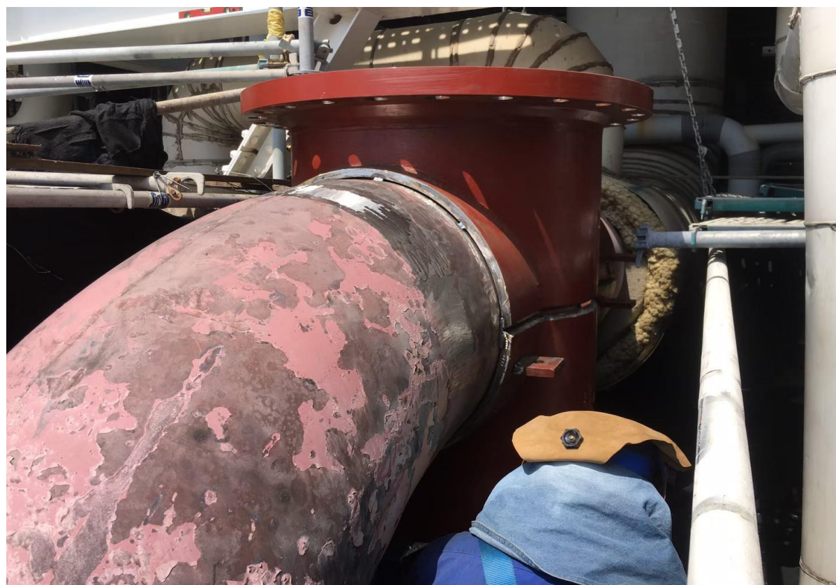
2. 四通模具焊接情形
