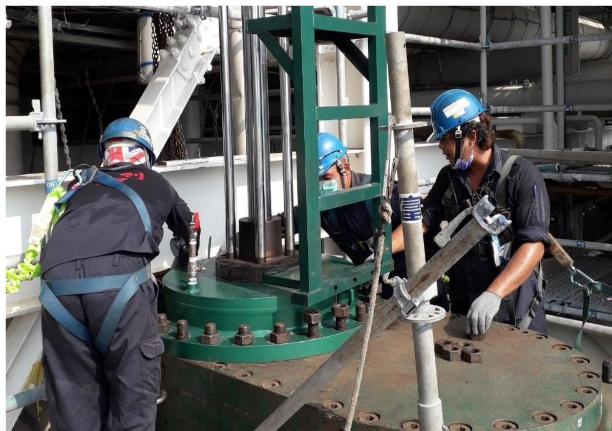
8. 人員進行下堵作業
