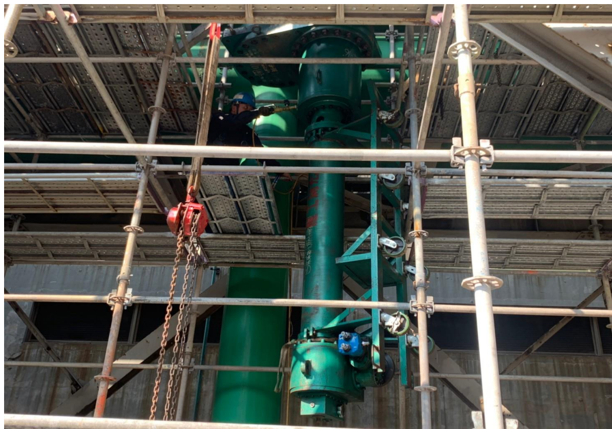
3. 安裝開孔機後執行斷管作業
