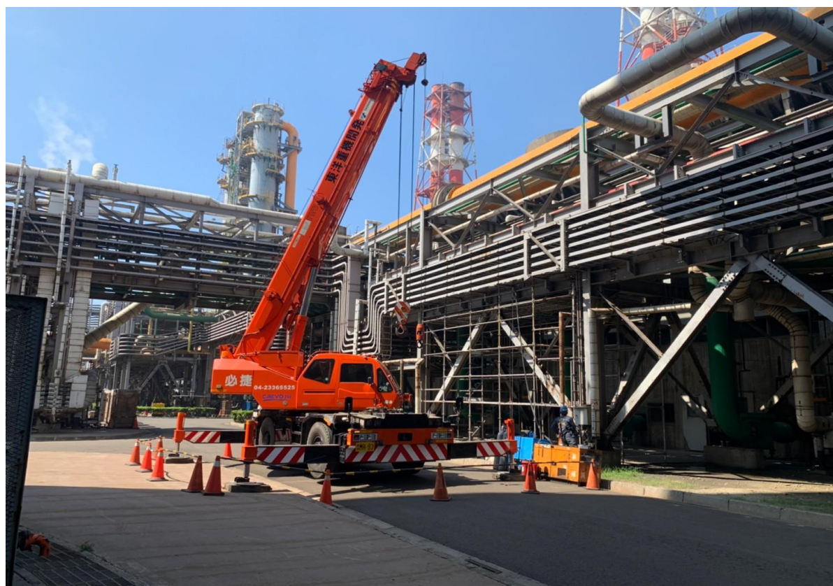
1. 施工機具定位
