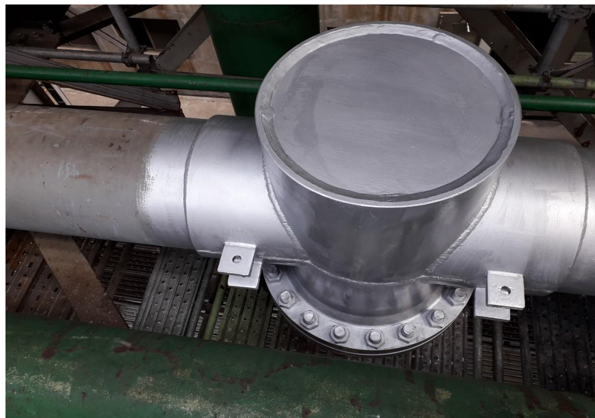
10. 管線阻斷閥件增設完成
