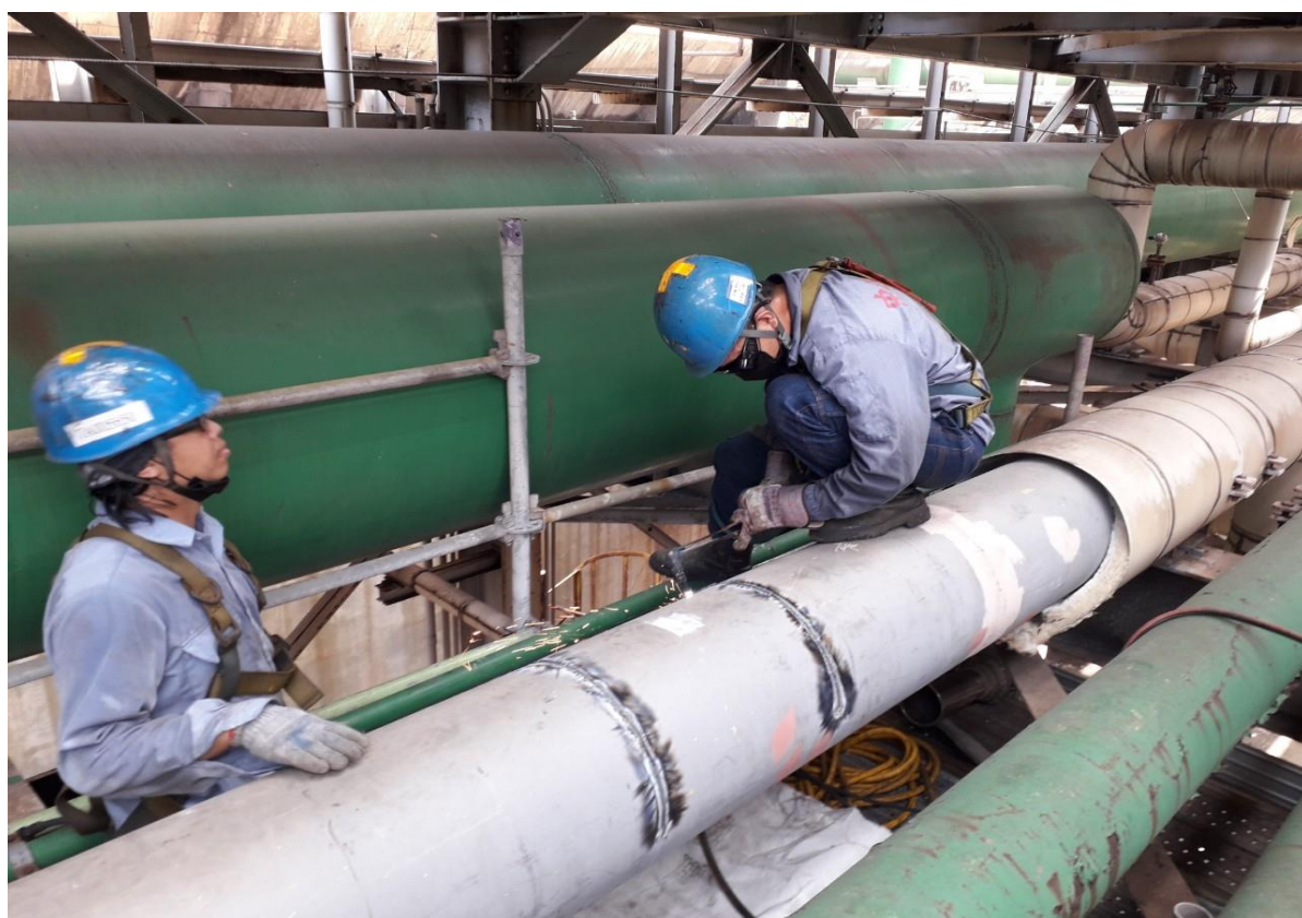
6. 阻斷完成後進行切管作業
