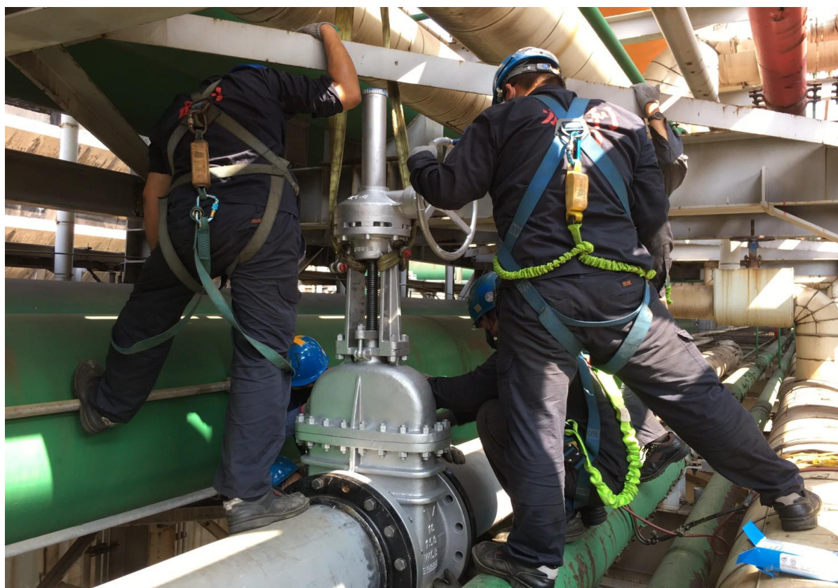
8. 閘閥增設完成
