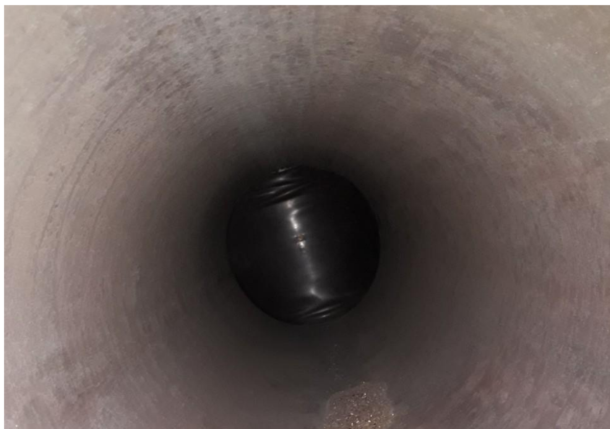
7. 切管完成確認管內阻斷情形
