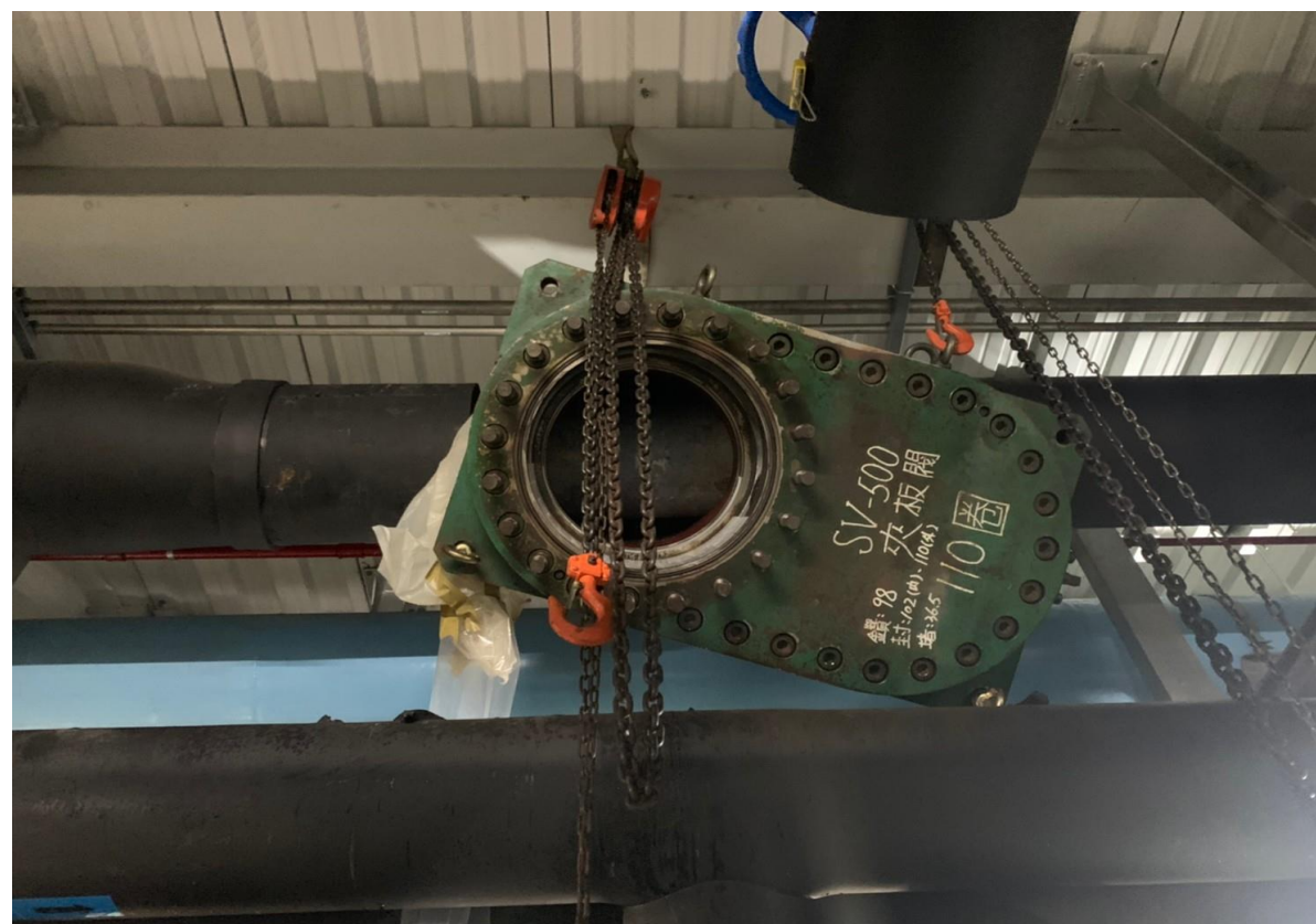
8. 管線夾板閥吊裝作業
