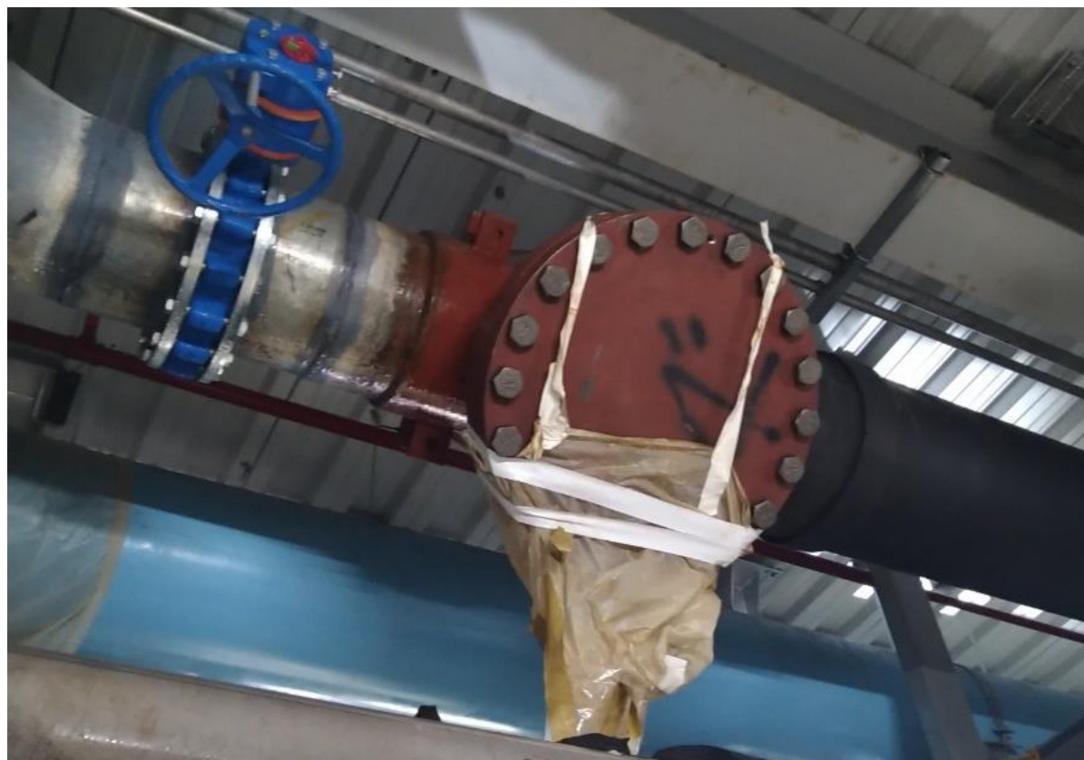
19. 活水開孔及阻斷加閥施工完成
