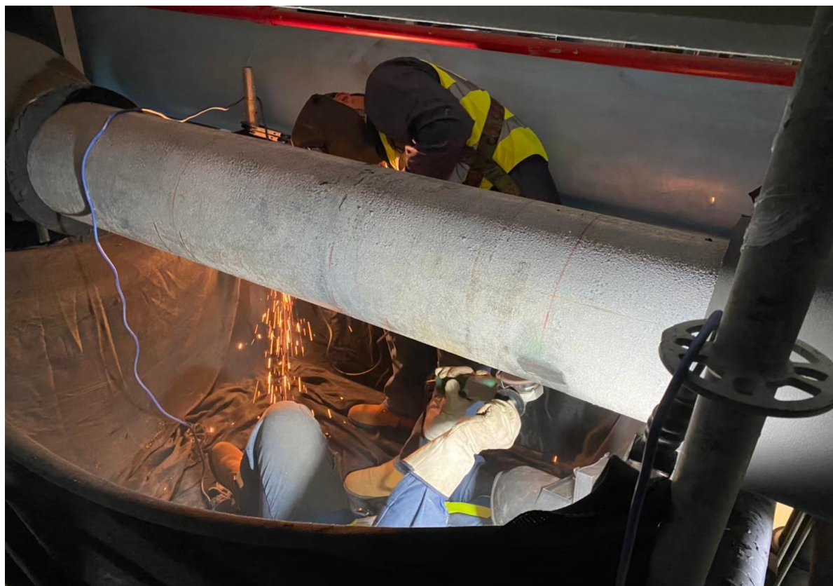
1. 管線研磨作業
