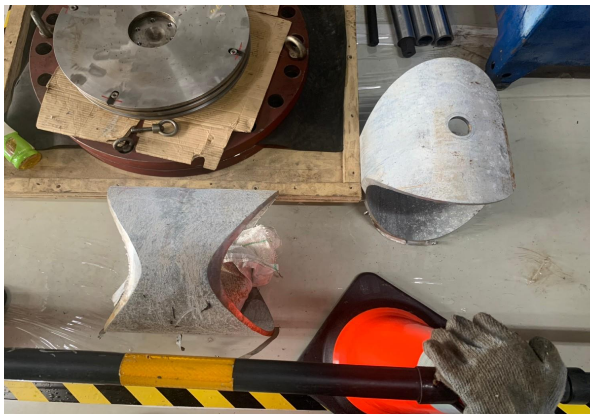
13. 管線斷管後料塊取出
