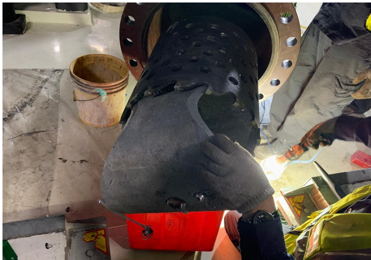
7. 管線斷管作業完成，確認料塊取出
