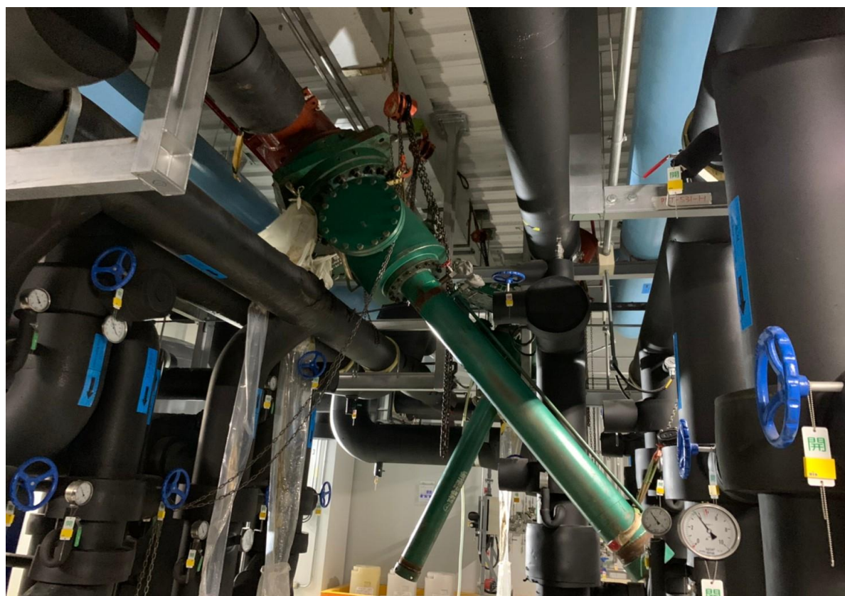
16. 阻斷器安裝作業
