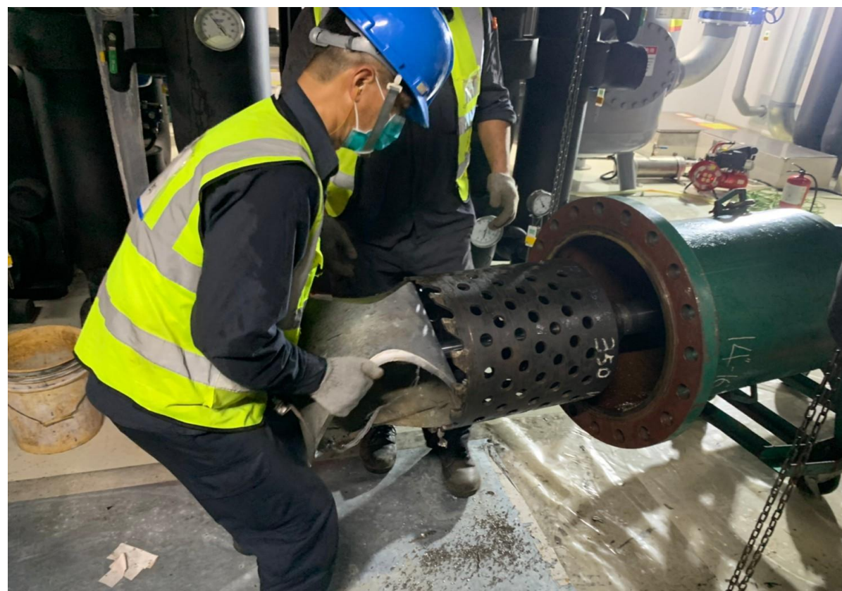
12. 管線斷管作業完成，確認料塊取出
