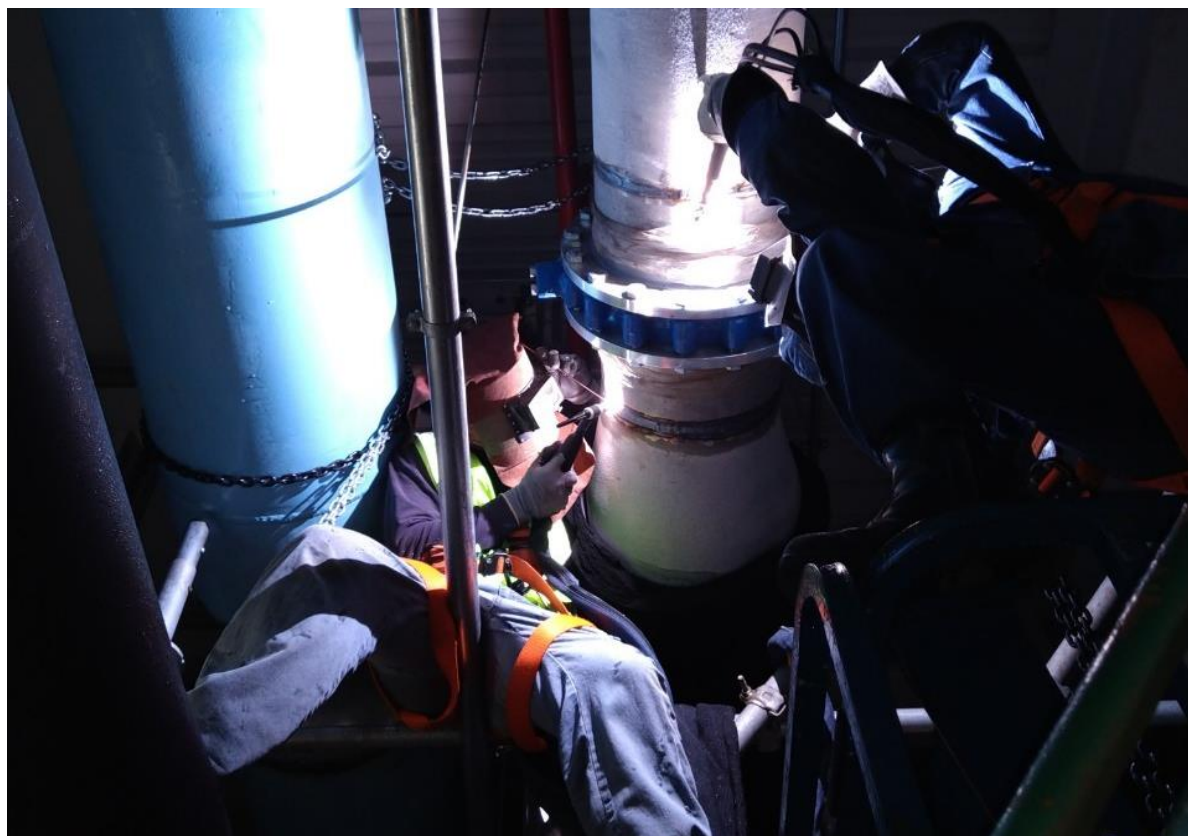
17. 阻斷後管線增設蝶閥
