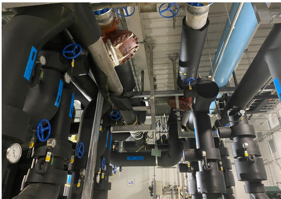
22. TCP 1F 冰水系統活水開孔及阻斷加閥完成
