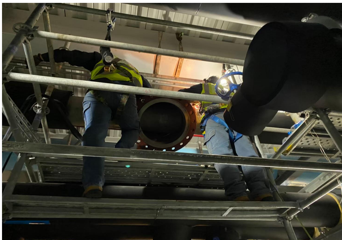
2. 施工管線進行模具組焊
