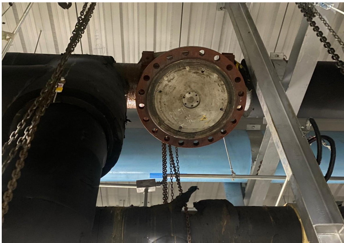
21. 內塞頭安裝完成
