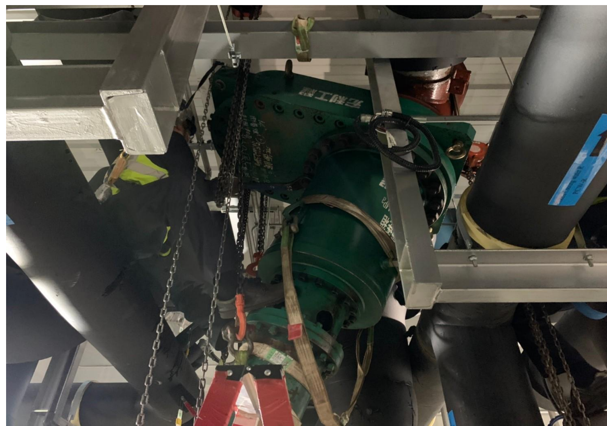
4. 開孔機安裝作業
