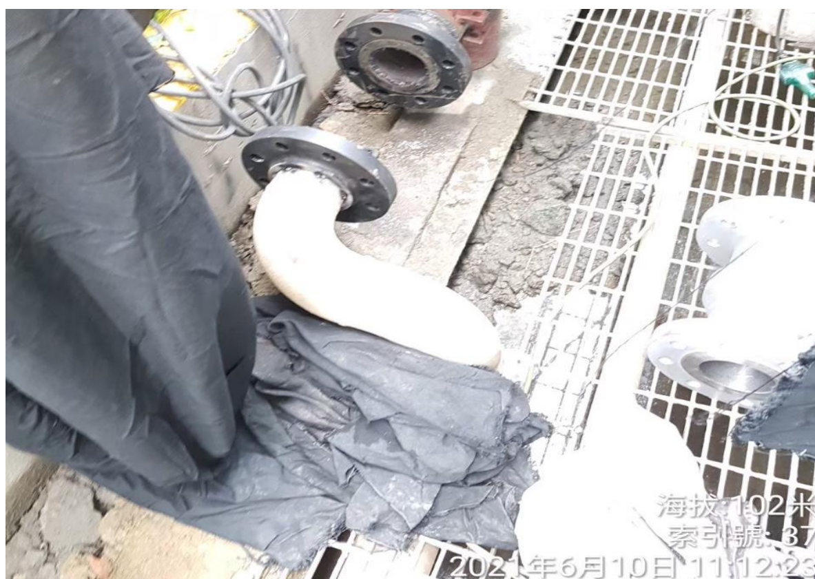
8. 法蘭焊接完成
