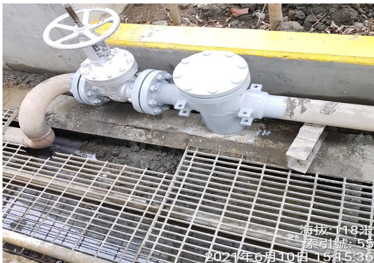
10. 管線阻斷新增閥完成
