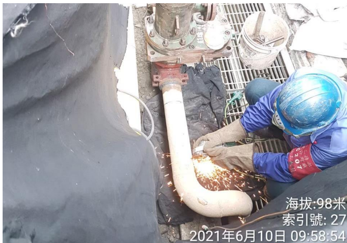
6. 阻斷完成後進行切管作業
