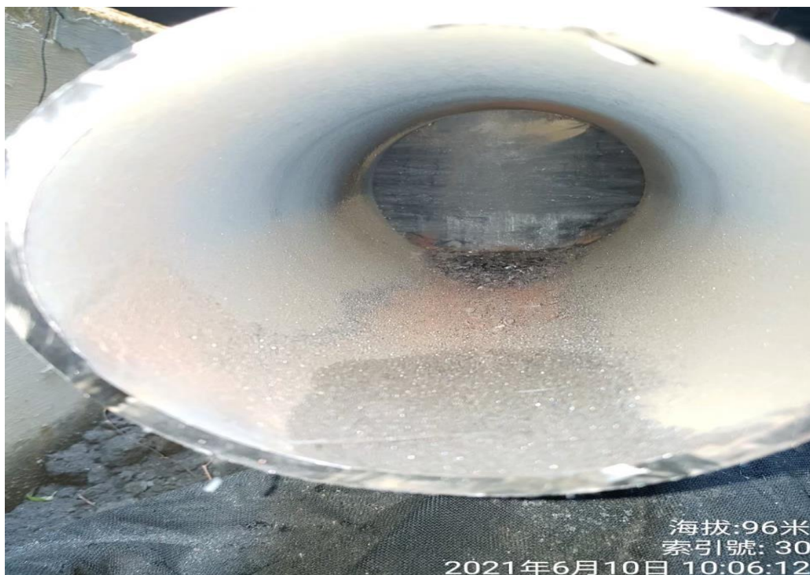
7. 切管完成確認管內阻斷情形
