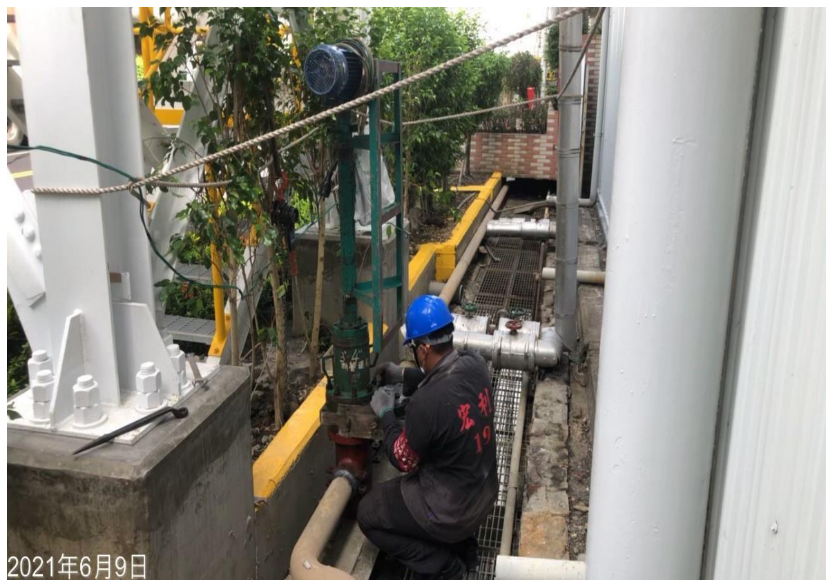
3. 安裝開孔機後執行斷管作業
