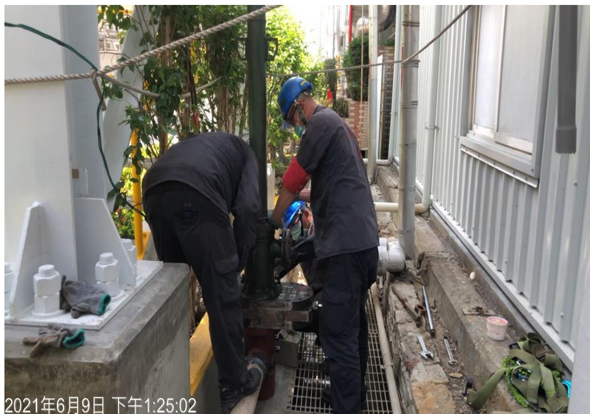
5. 安裝阻斷器後進行阻斷作業
