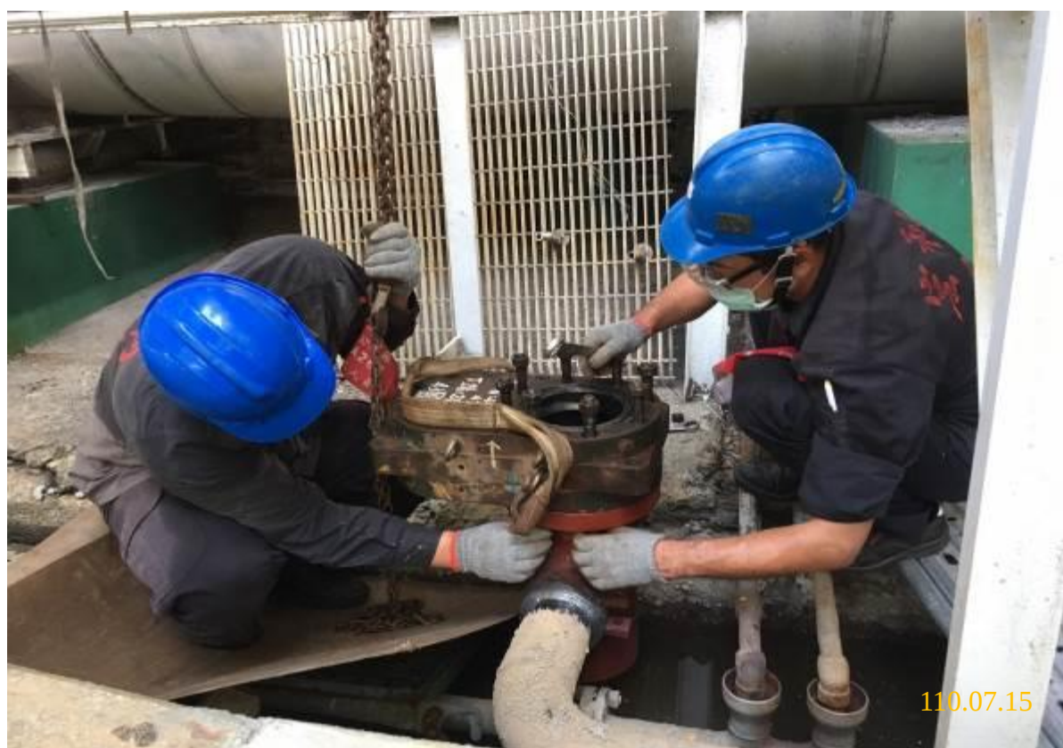
32. 夾板閥安裝作業
