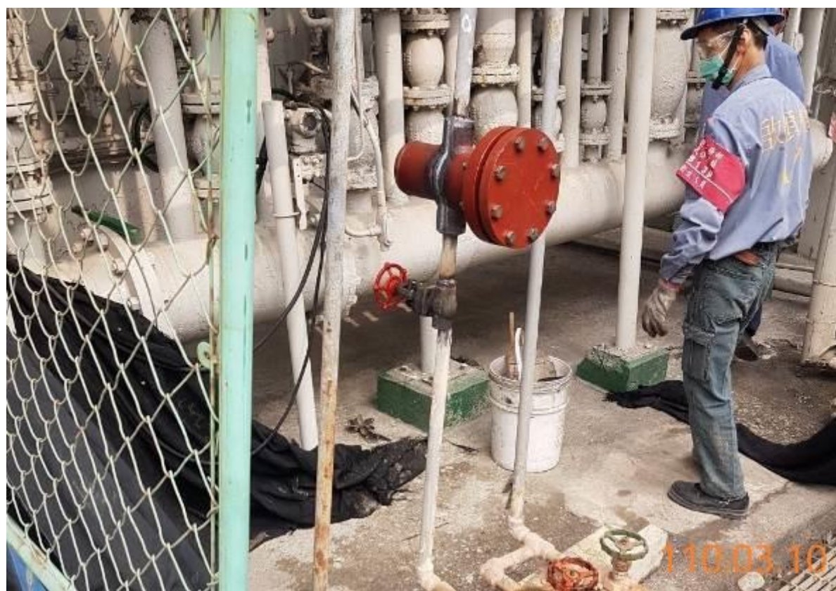
8. 線上阻斷作業完成
