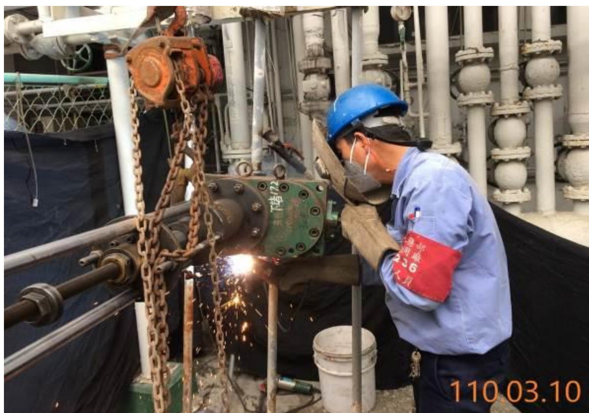
6. 管線焊接作業
