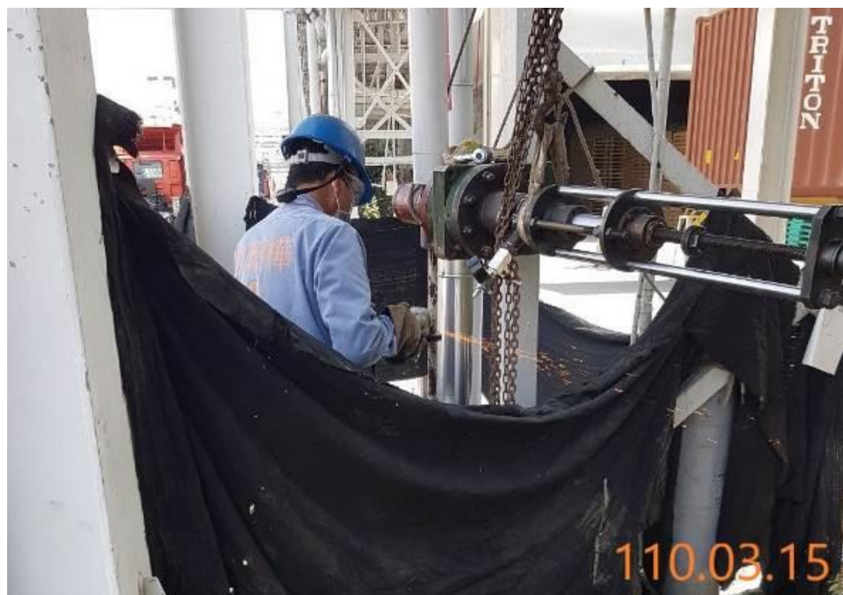
16. 阻斷完成後進行切管作業
