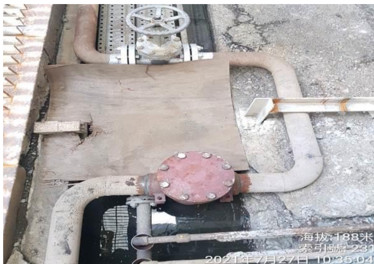
43. 不斷水施工完成
