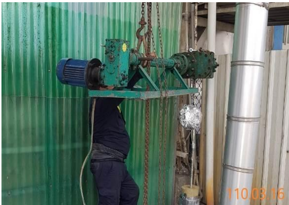
18. 模具焊接完成後進行斷管作業
