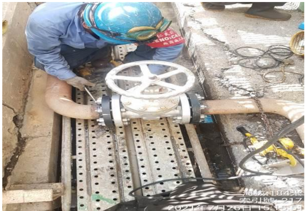
41. 阻斷完成後交由駐廠焊工進行增閥作業
