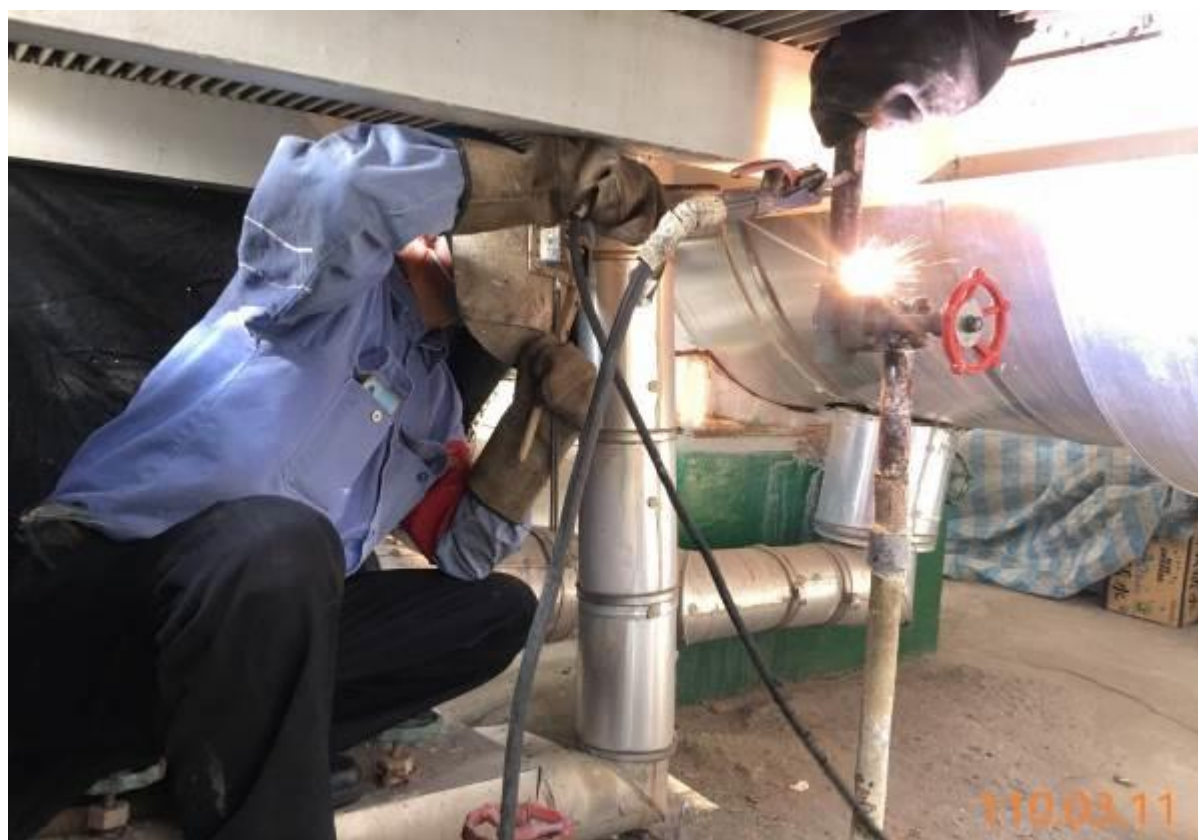
13. 阻斷完成後交由駐廠焊工進行切管增設閥作業
