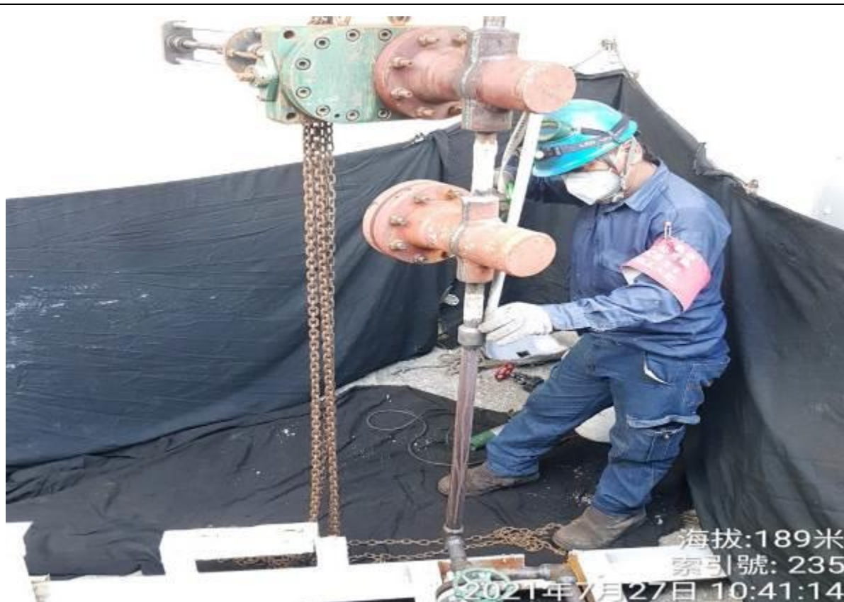
44. 阻斷後交由配管廠商切管
