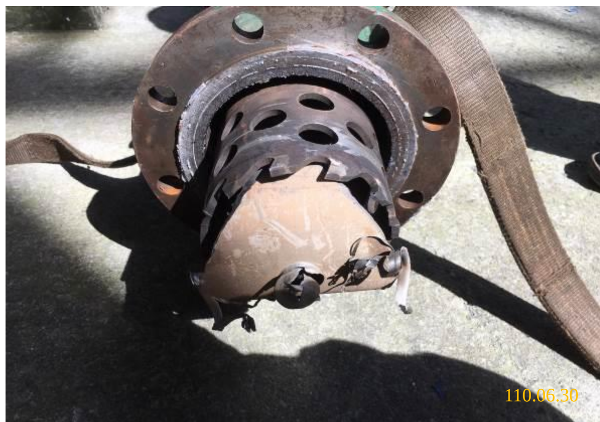
24. 不斷水施工完成
