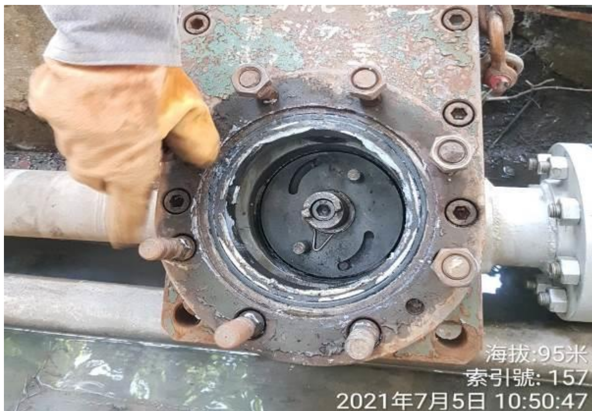
29. 下堵作業完成
