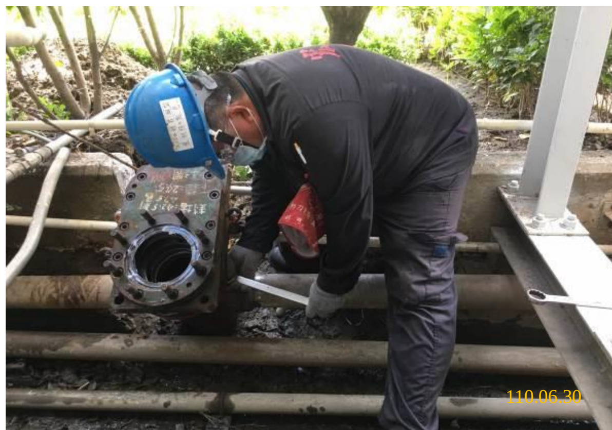
22. 不斷水施工完成
