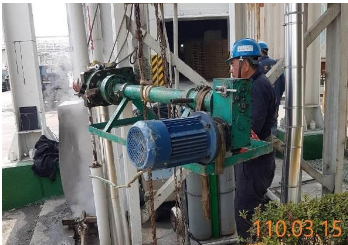
15. 模具組焊完成後進行斷管作業
