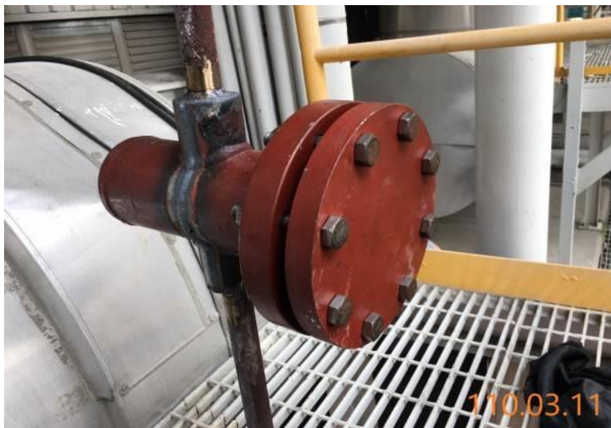
14. 不斷水阻斷完成
