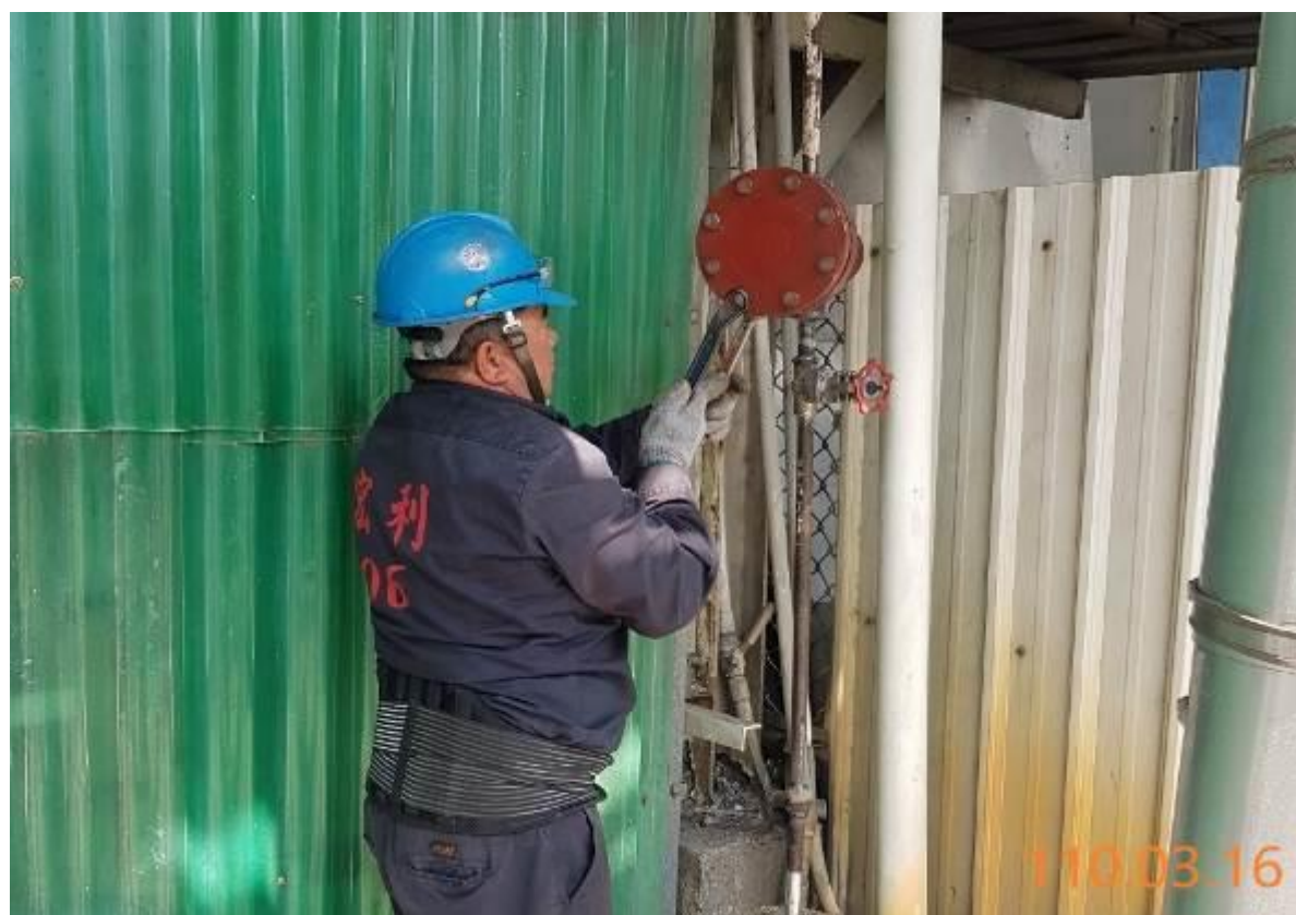
20. 不斷水施工完成
