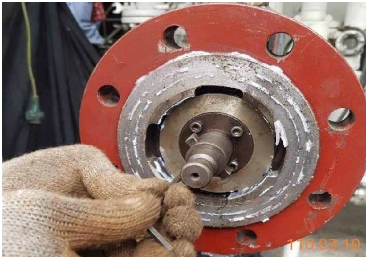
7. 人員進行下堵作業
