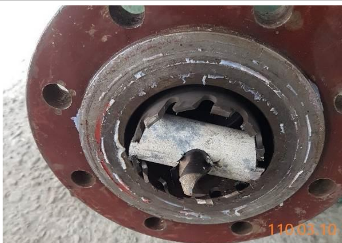
3. 斷管完成，確認料塊取出
