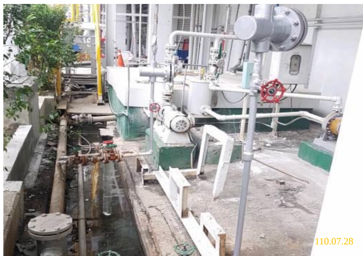
50. 阻斷後交由配管廠商切管
