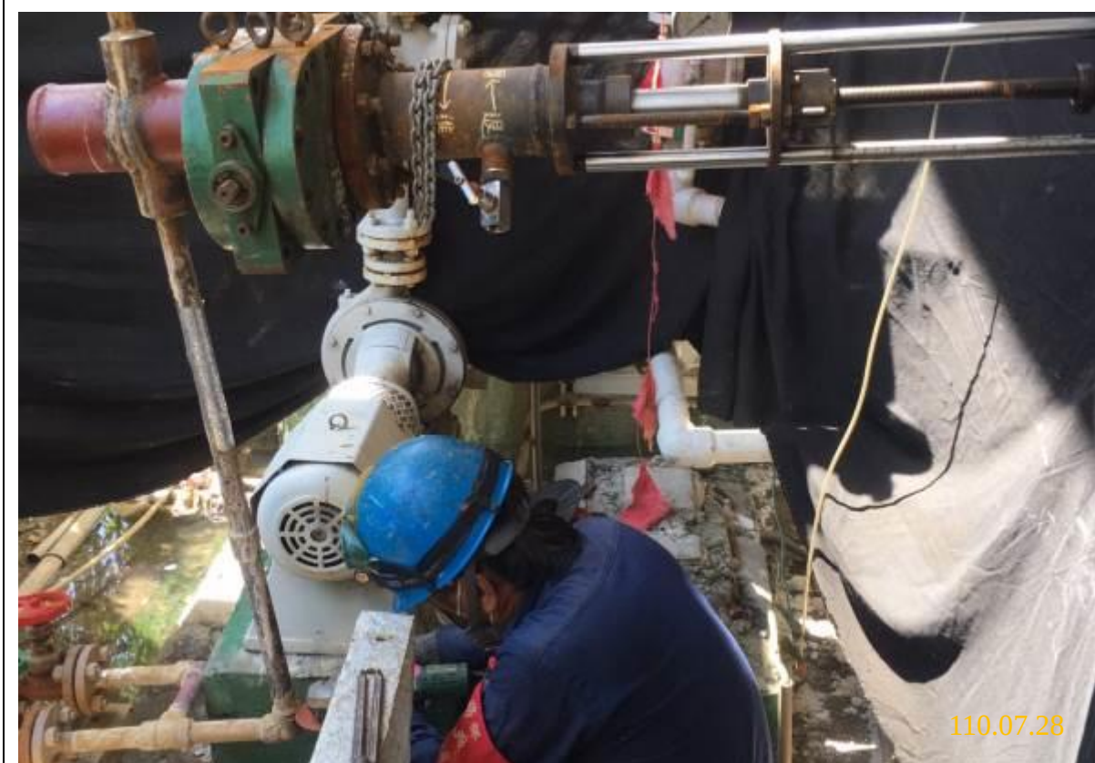
46. 管線切管作業
