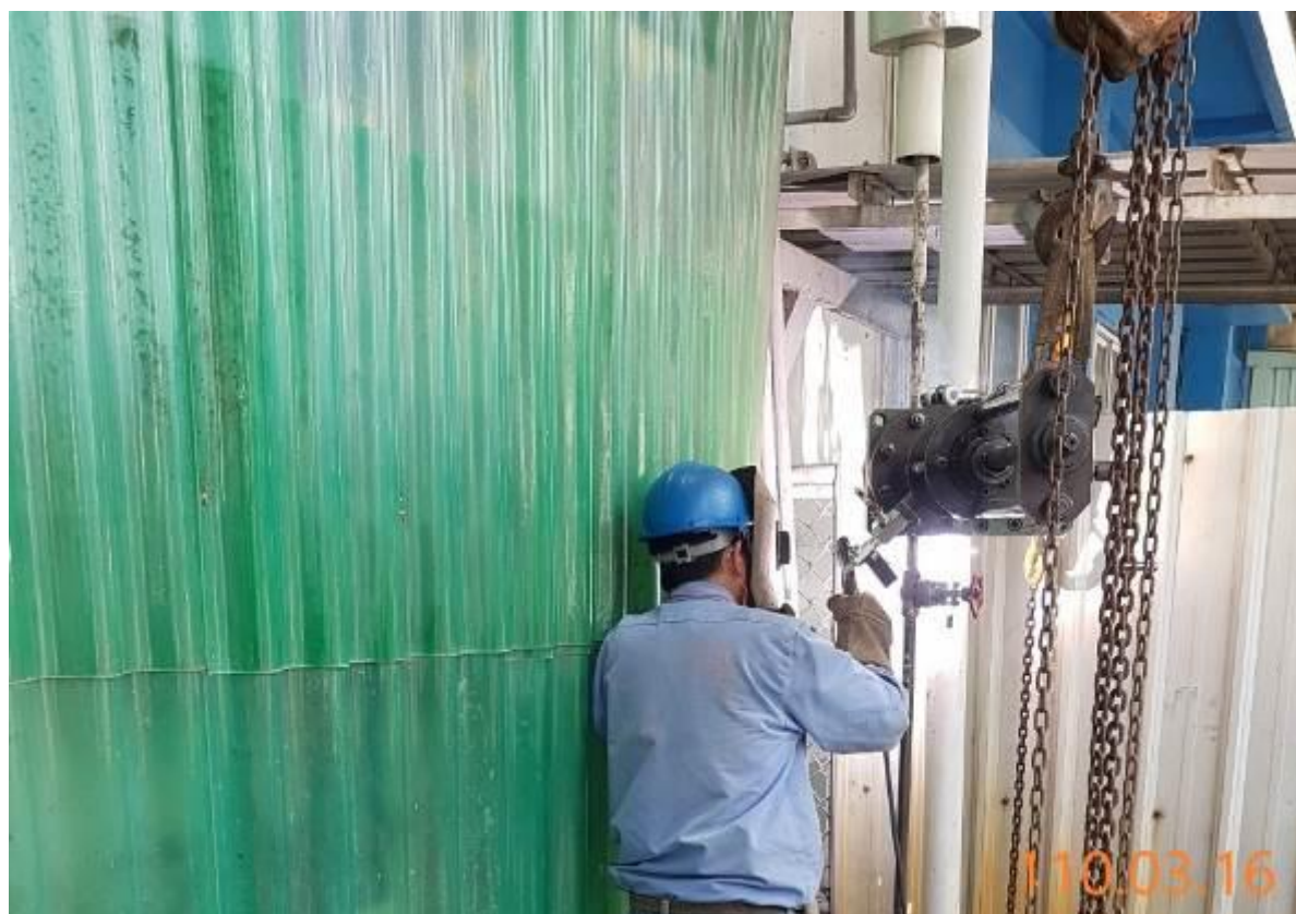
19. 阻斷完成後交由駐廠焊工進行增閥作業
