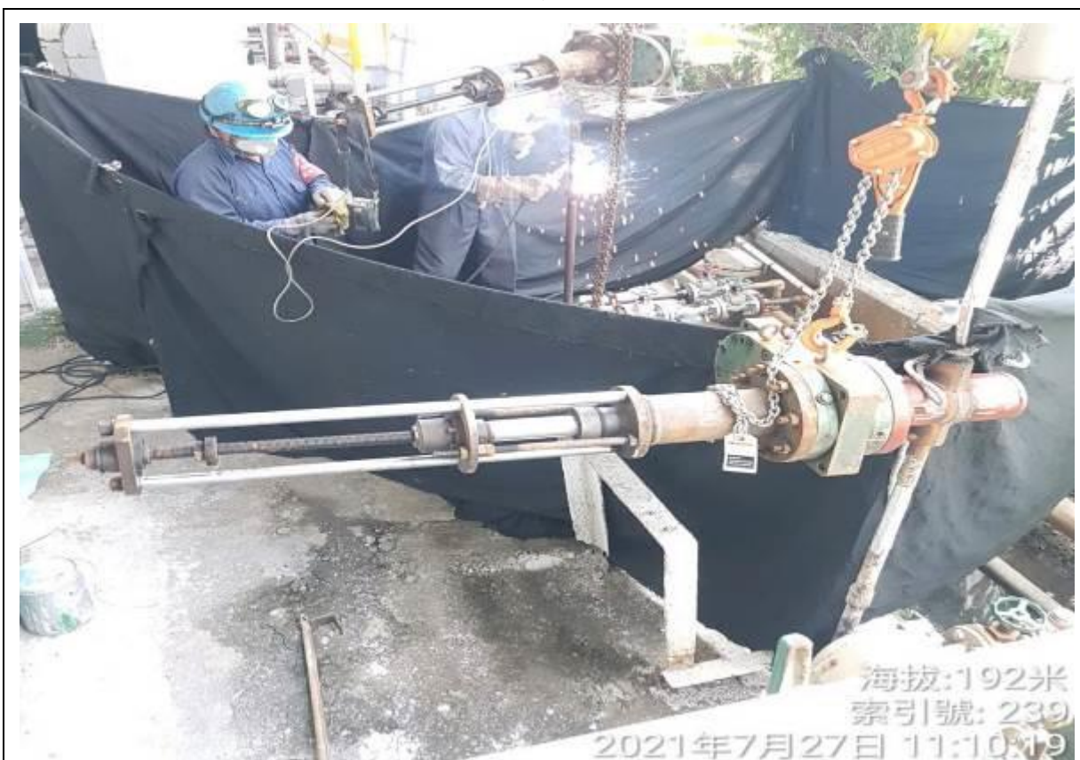
45. 管線增閥作業
