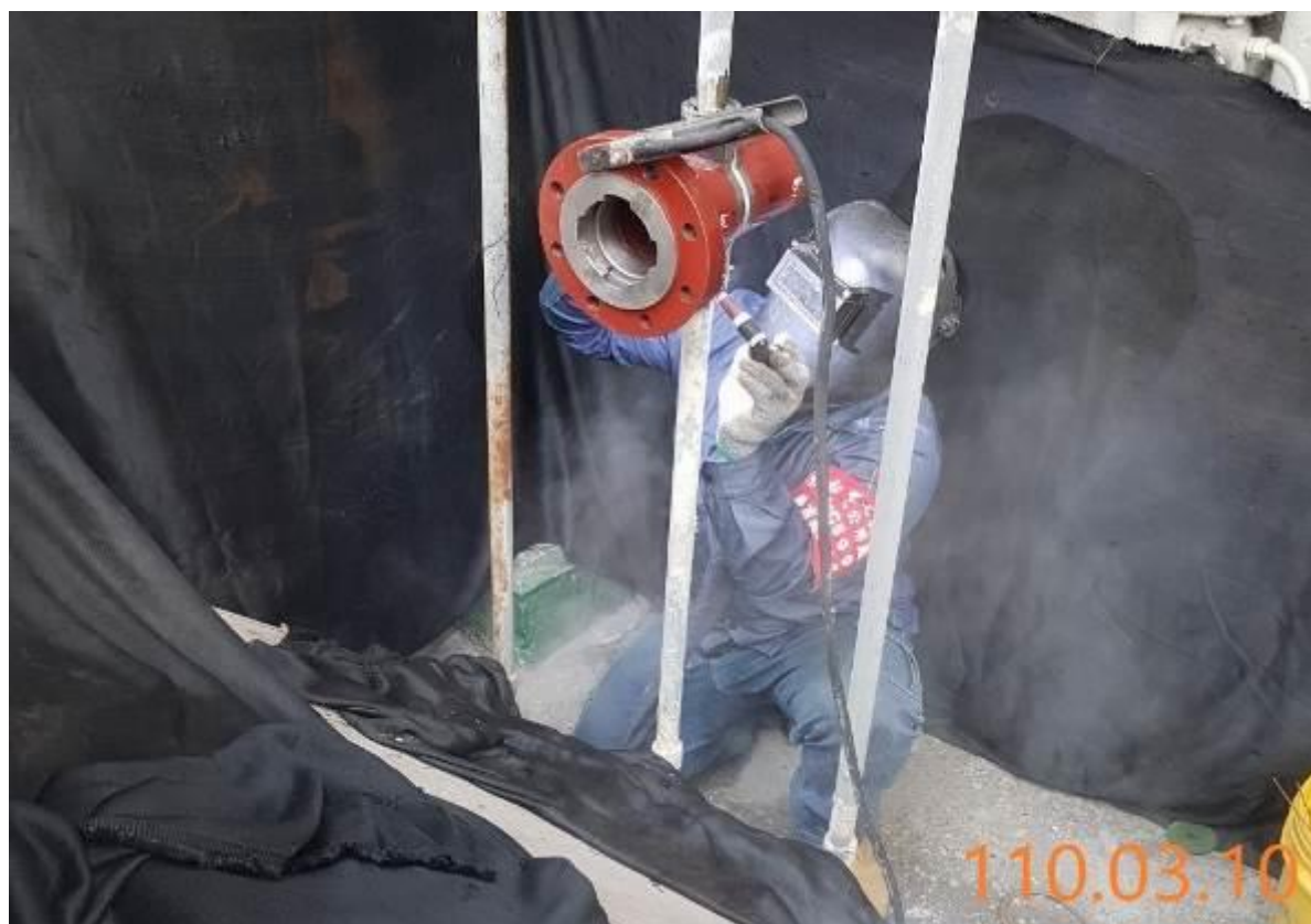
1. 模具焊接作業
