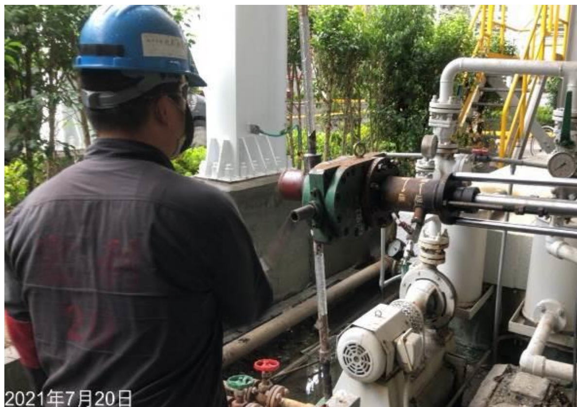
37. 管線進行阻斷作業
