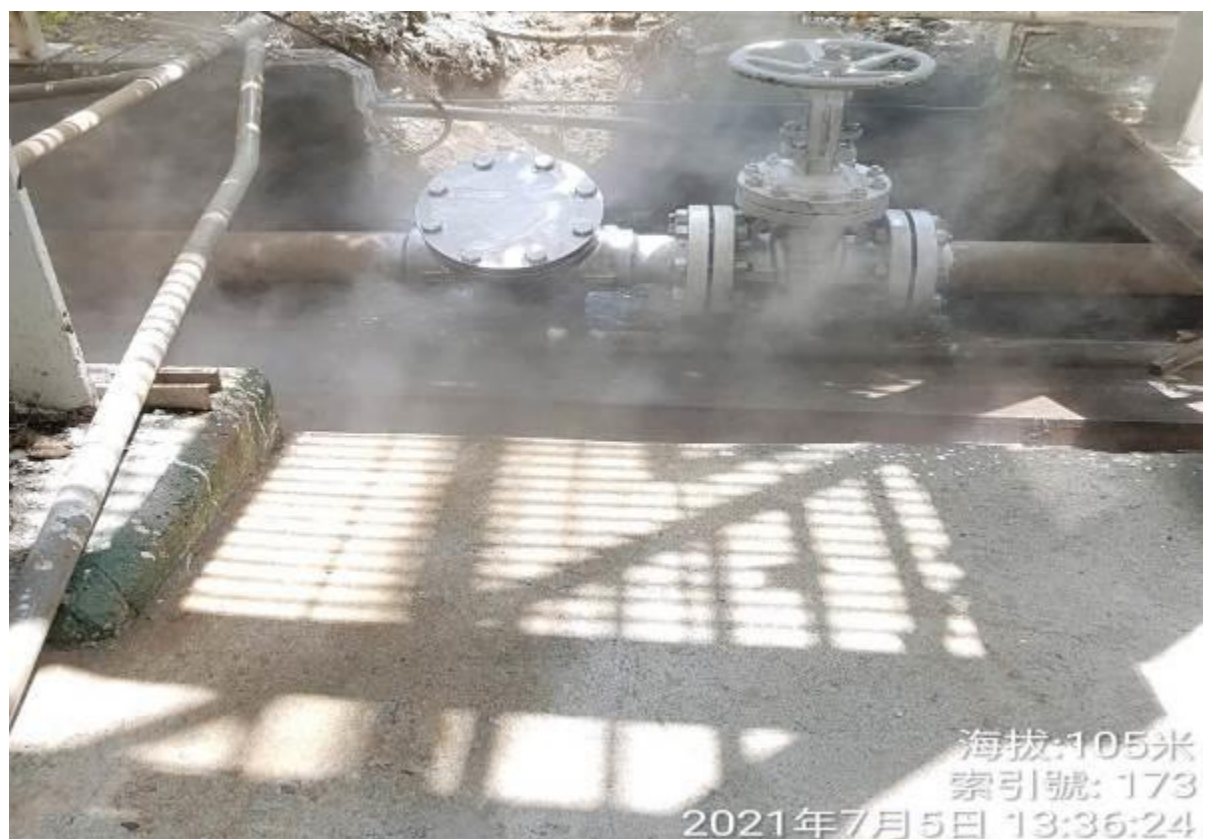
30. 不斷水施工完成
