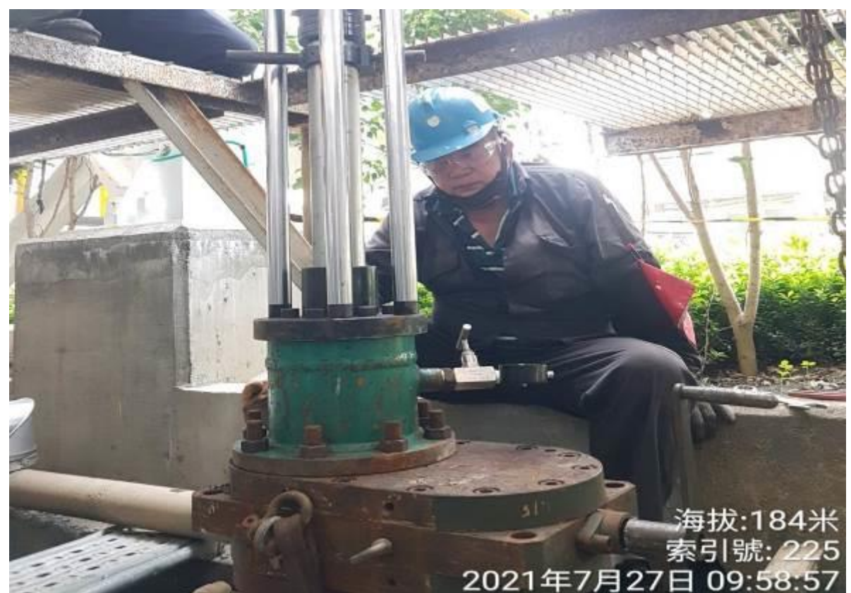
42. 人員進行下堵作業
