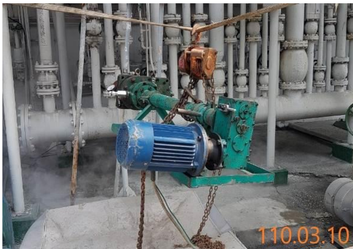
2. 夾板閥及開孔機安裝完成後進行斷管作業
