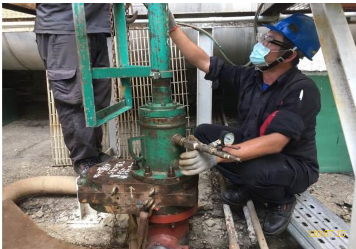
33. 安裝開孔機後進行開孔作業
