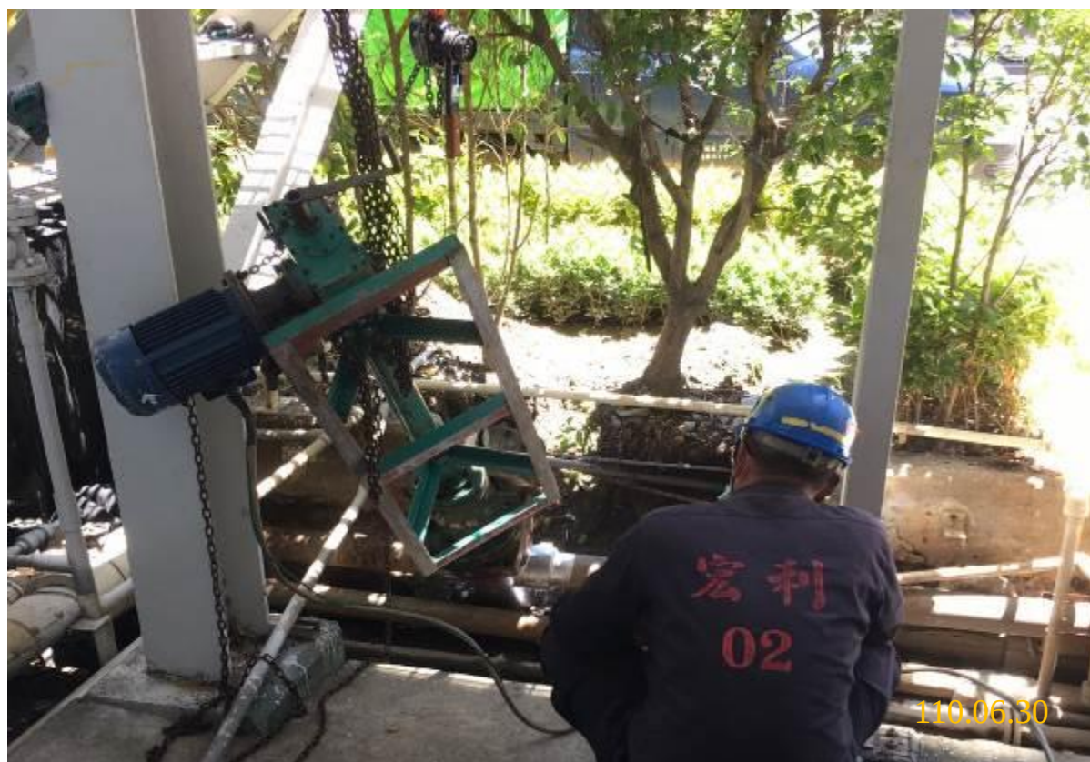
23. 阻斷完成後交由駐廠焊工進行增閥作業
