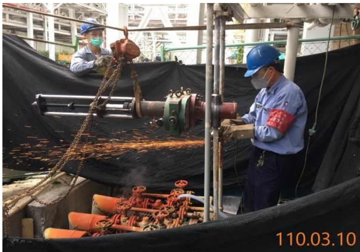
5. 阻斷完成後交由駐廠焊工進行切管作業
