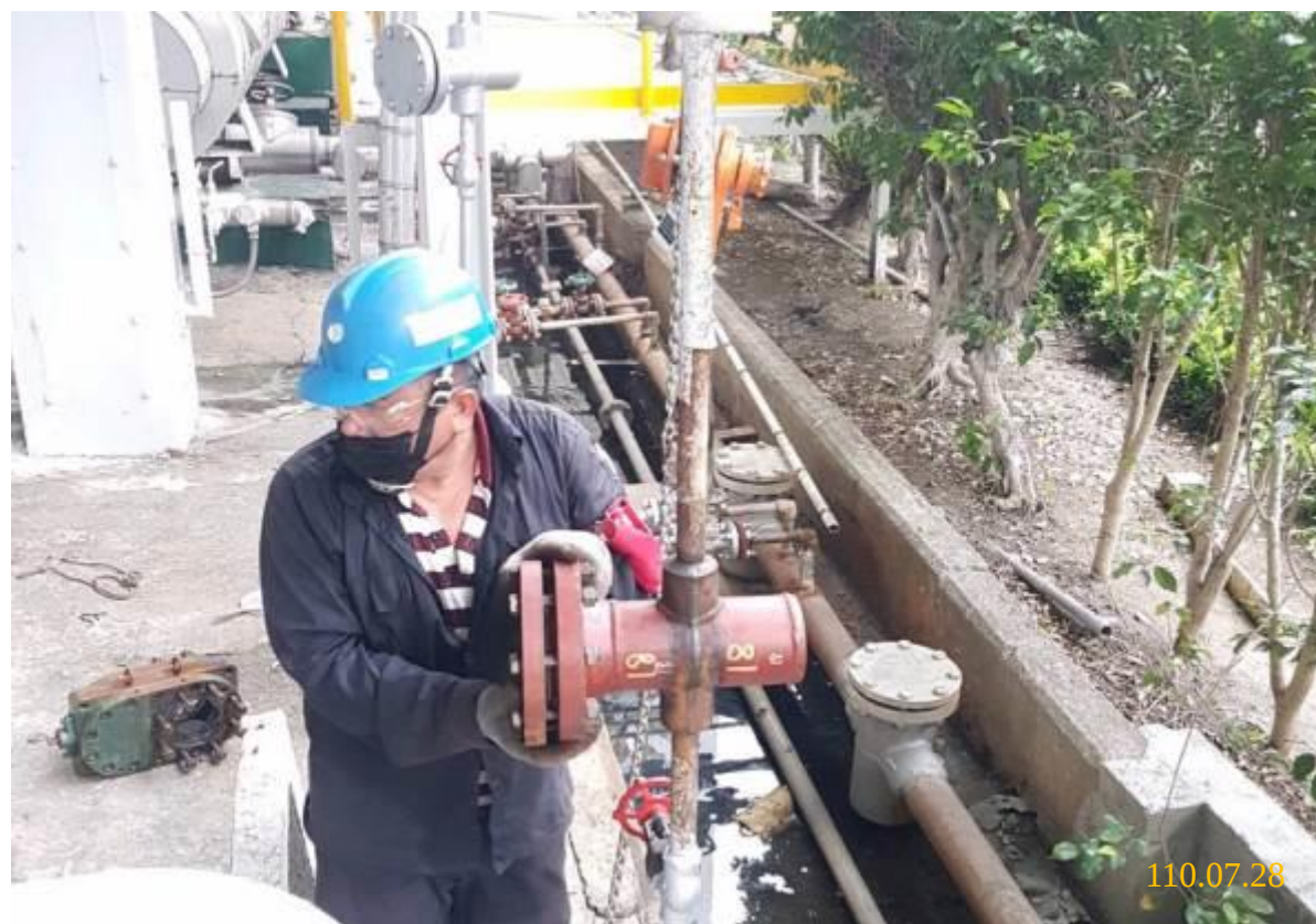
49. 不斷水施工完成
