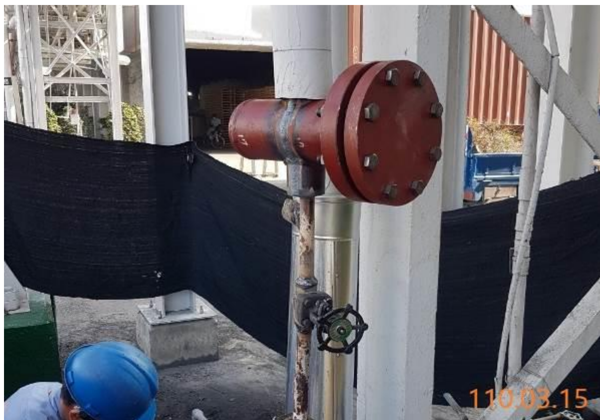
17. 不斷水作業完成
