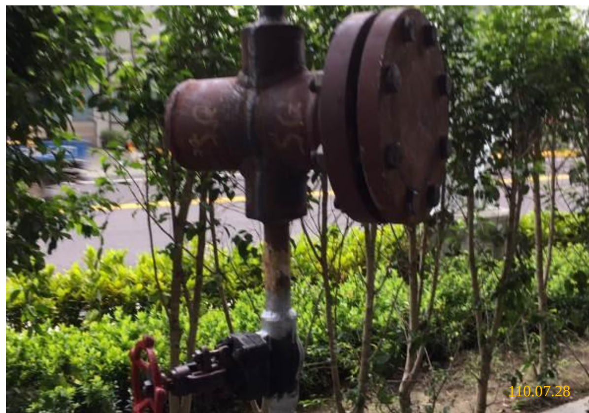
48. 不斷水施工完成
