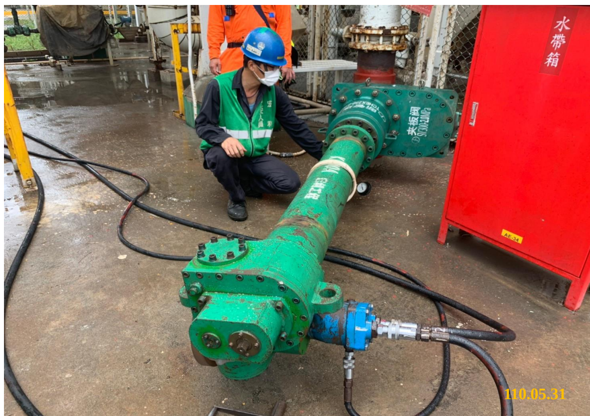
5. 安裝夾板閥及開孔機後進行斷管作業
