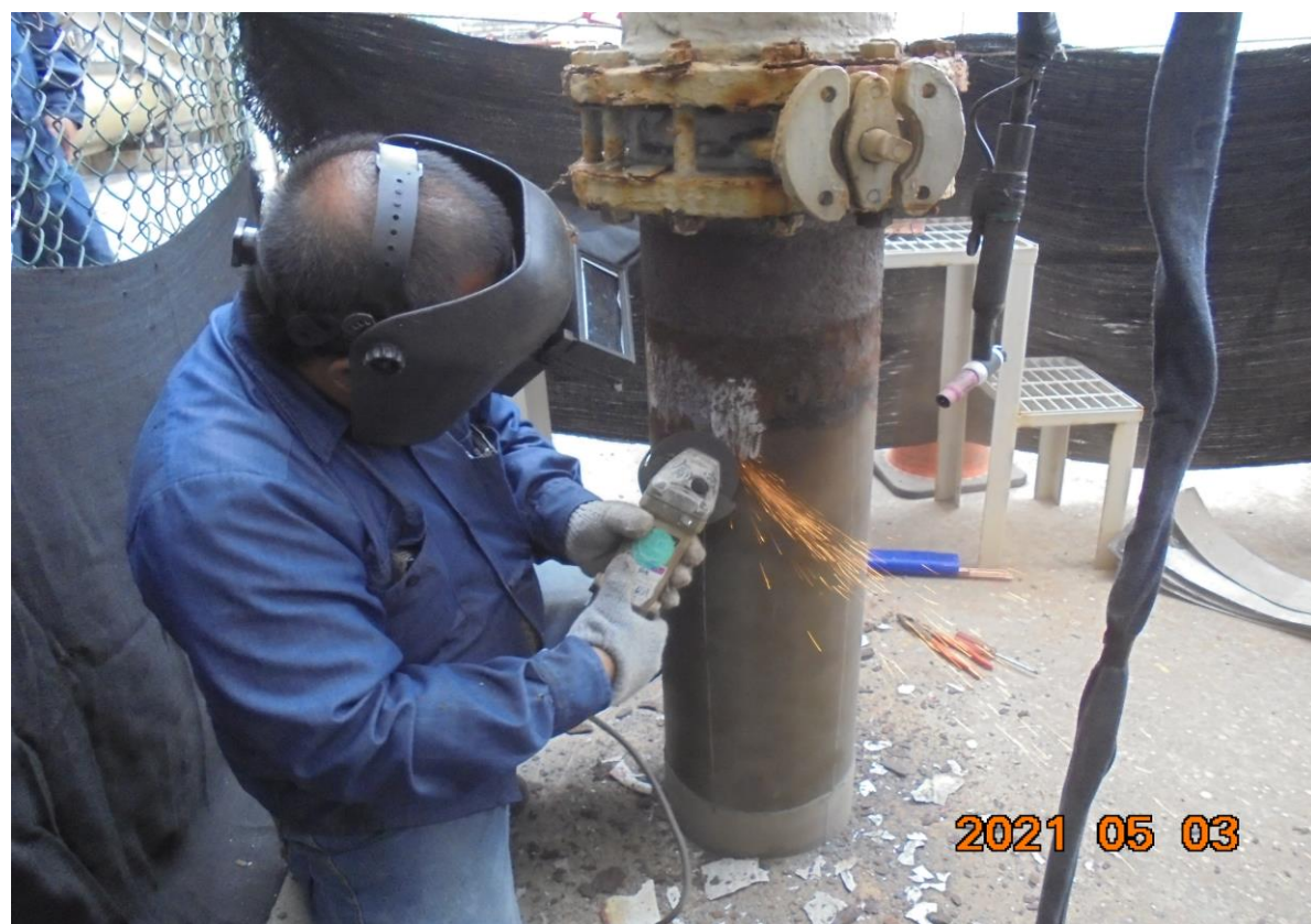
2. 管線研磨作業
