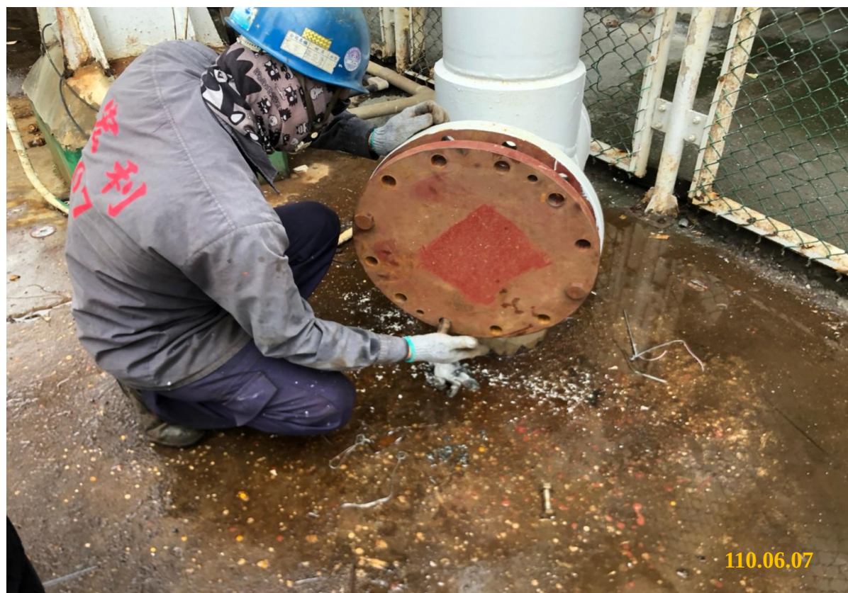
10. 線上封堵完成，安裝盲法蘭
