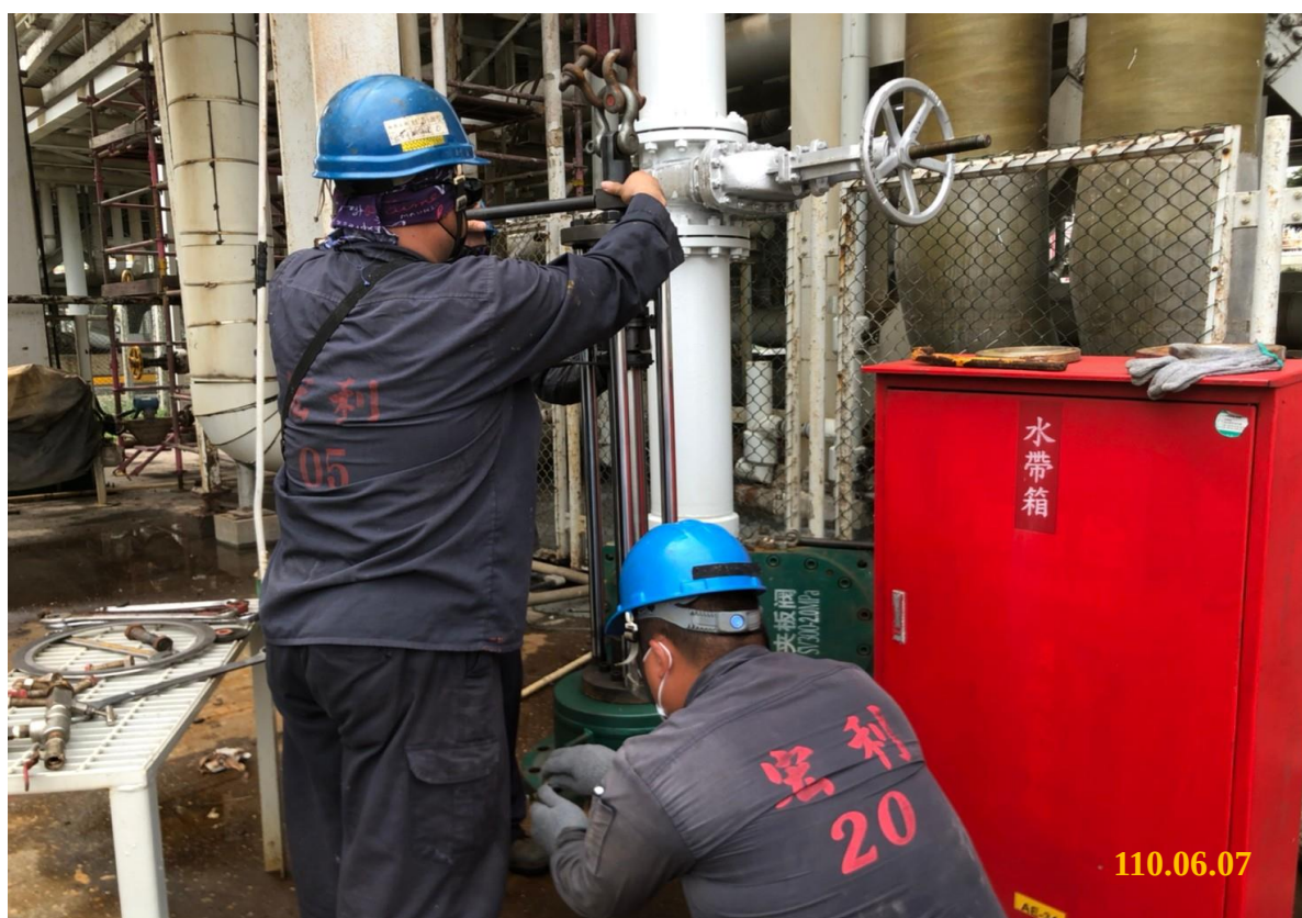
8. 管線更換完成後進行下堵作業
