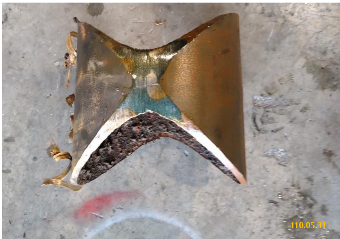
6. 斷管完成，確認料塊取出
