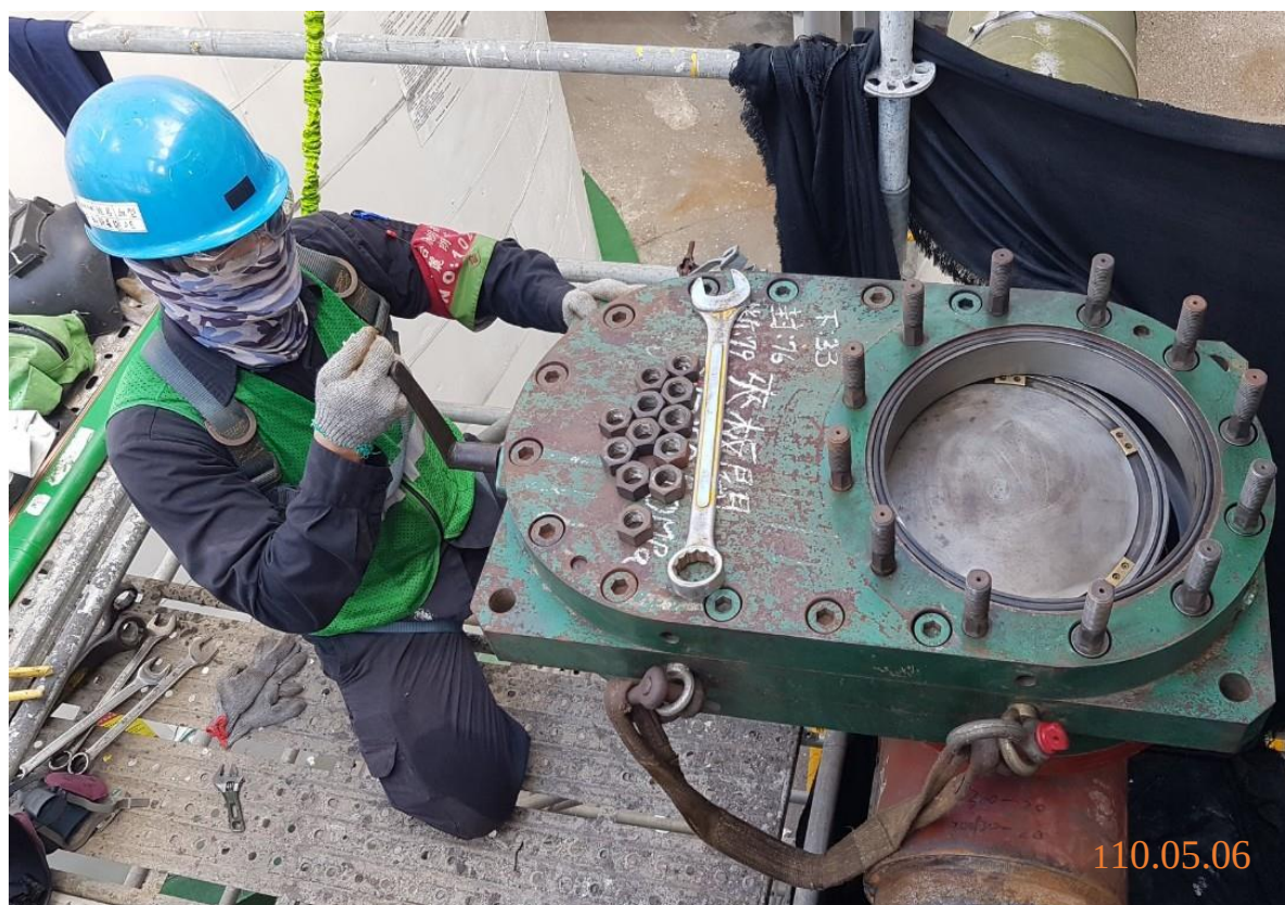
4. 夾板閥安裝作業
