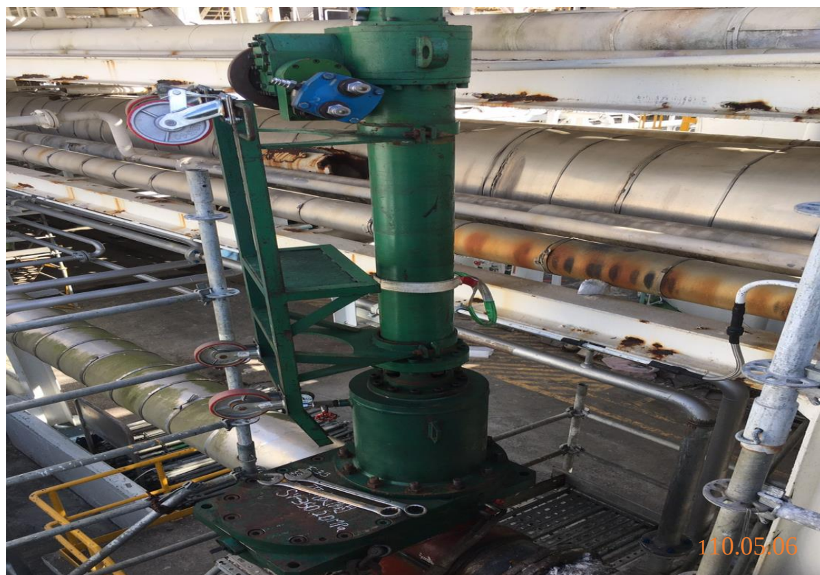
5. 開孔機安裝後進行斷管作業
