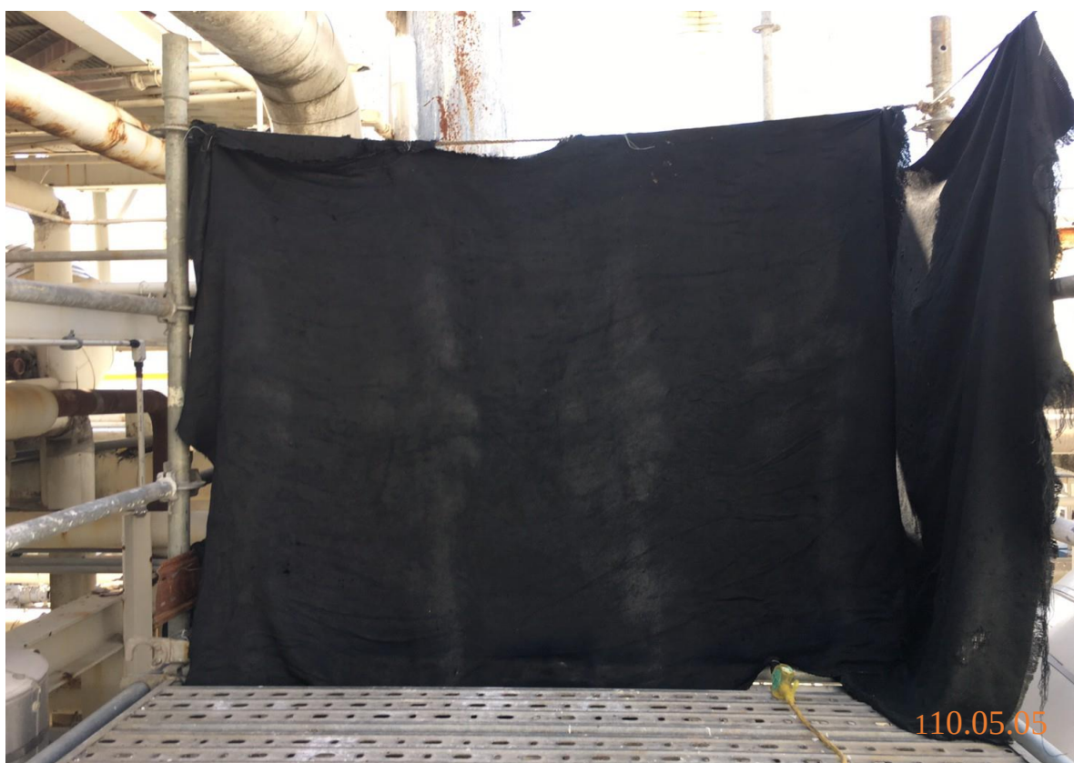
2. 防火毯鋪設情形
