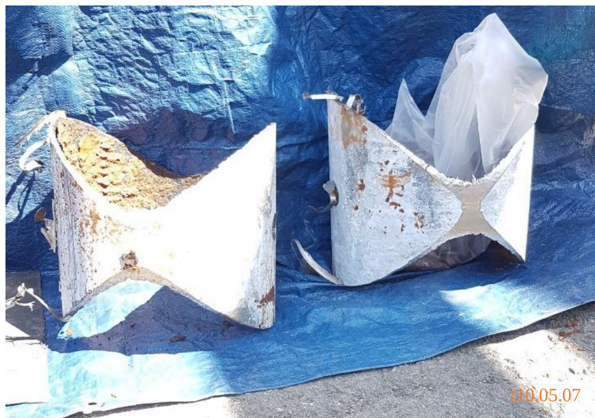
8. 斷管完成確認料塊取出
