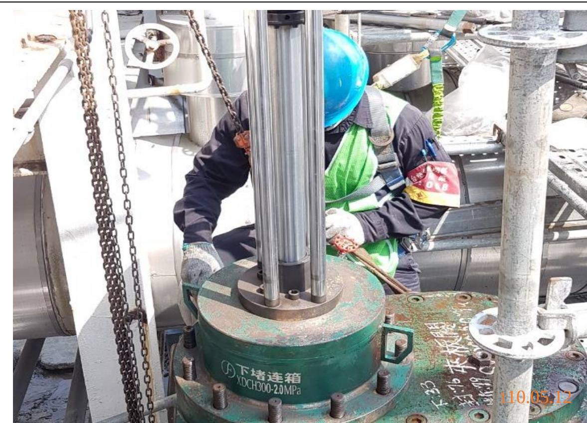
12. 人員進行下堵作業
