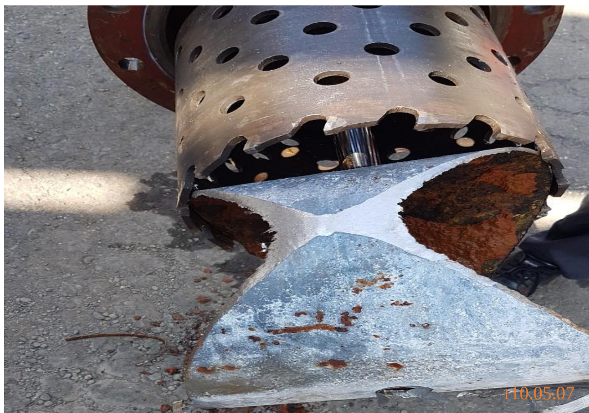
6. 斷管完成確認料塊取出
