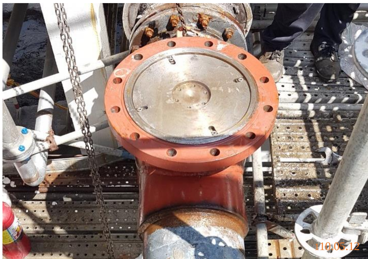
13. 下堵作業完成
