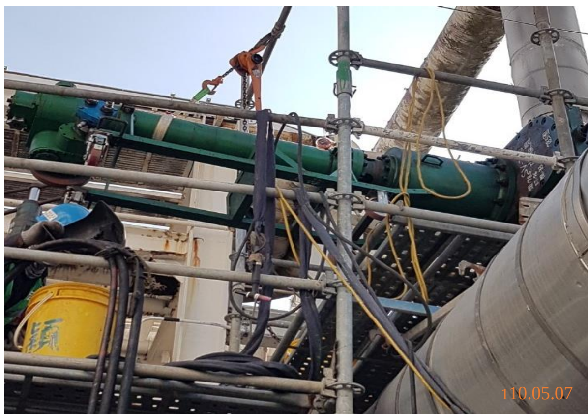
7. 人員安裝開孔機進行斷管作業
