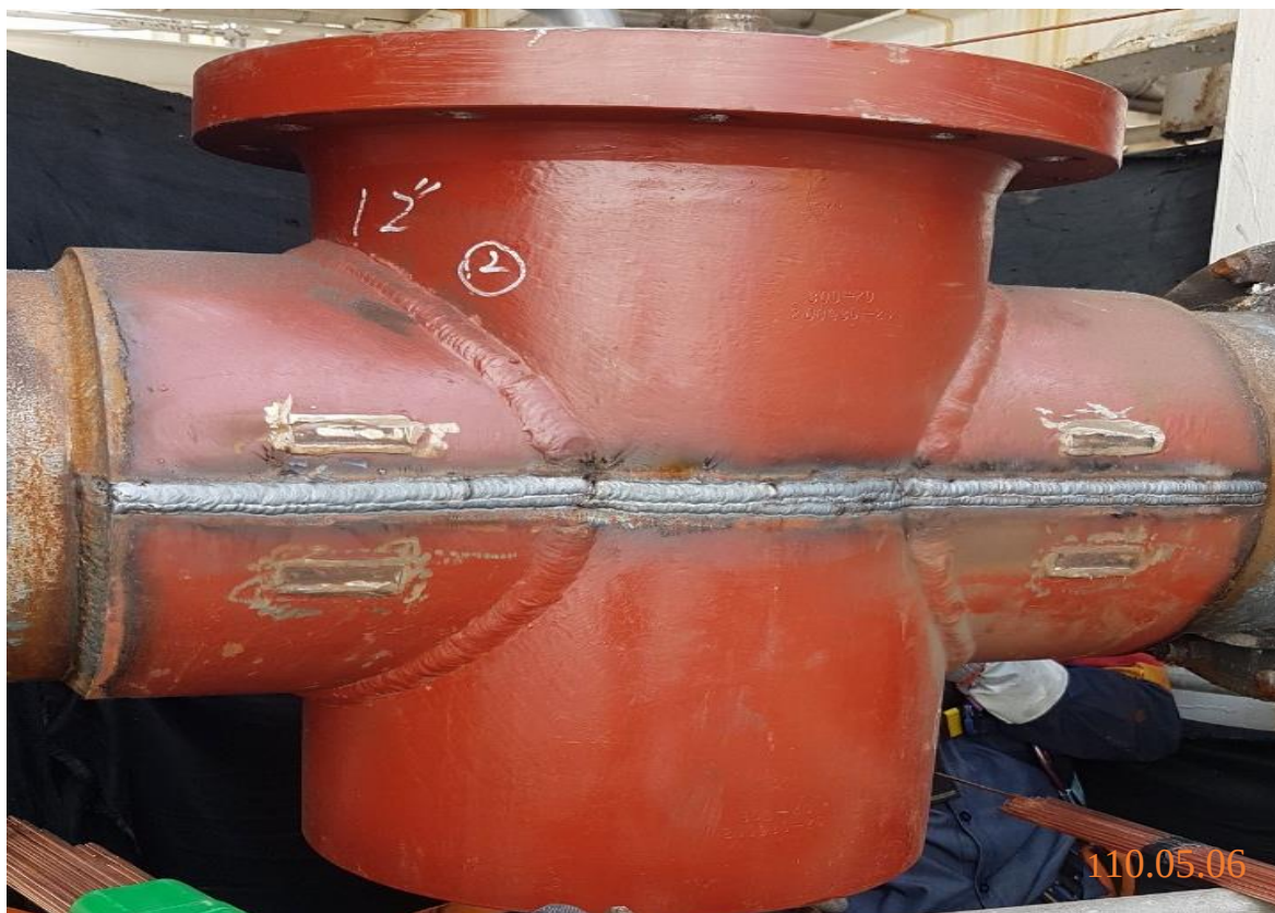
3. 模具焊接完成
