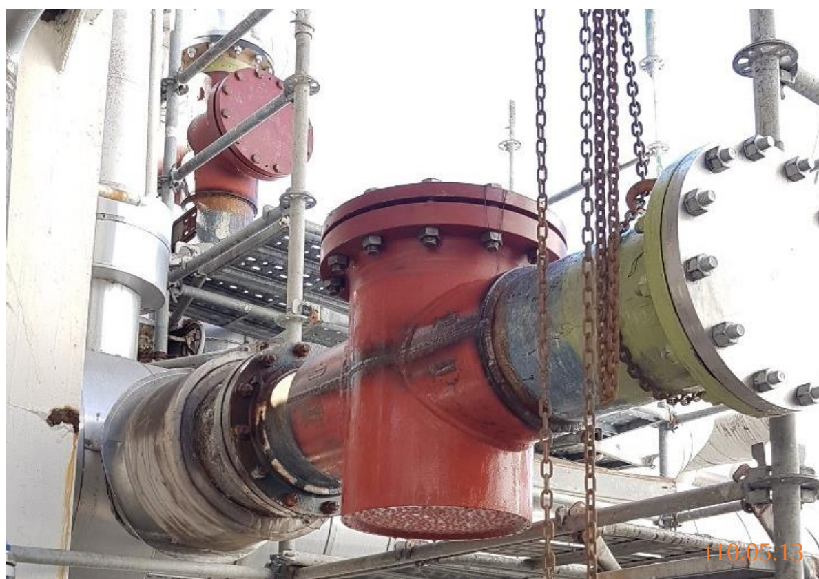
14. 不斷水阻斷完成
