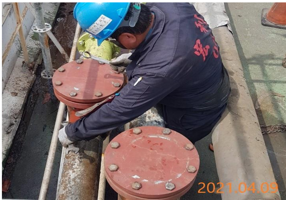
9. 施工完成安裝盲法蘭
