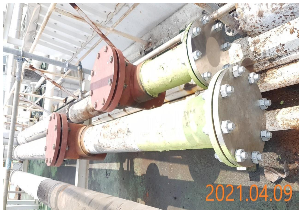
10. 冷凍水管路線上阻斷完成
