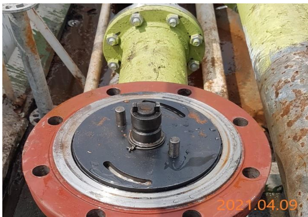
8. 下堵作業完成
