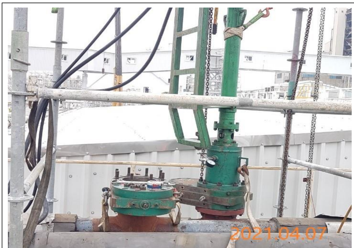
3. 安裝夾板閥及開孔機並執行斷管作業
