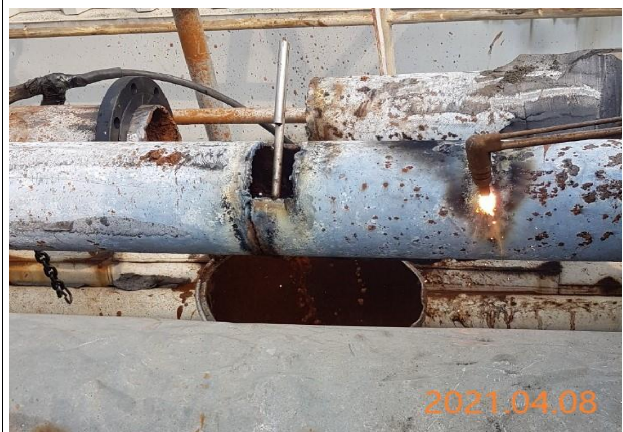
6. 管線切管作業
