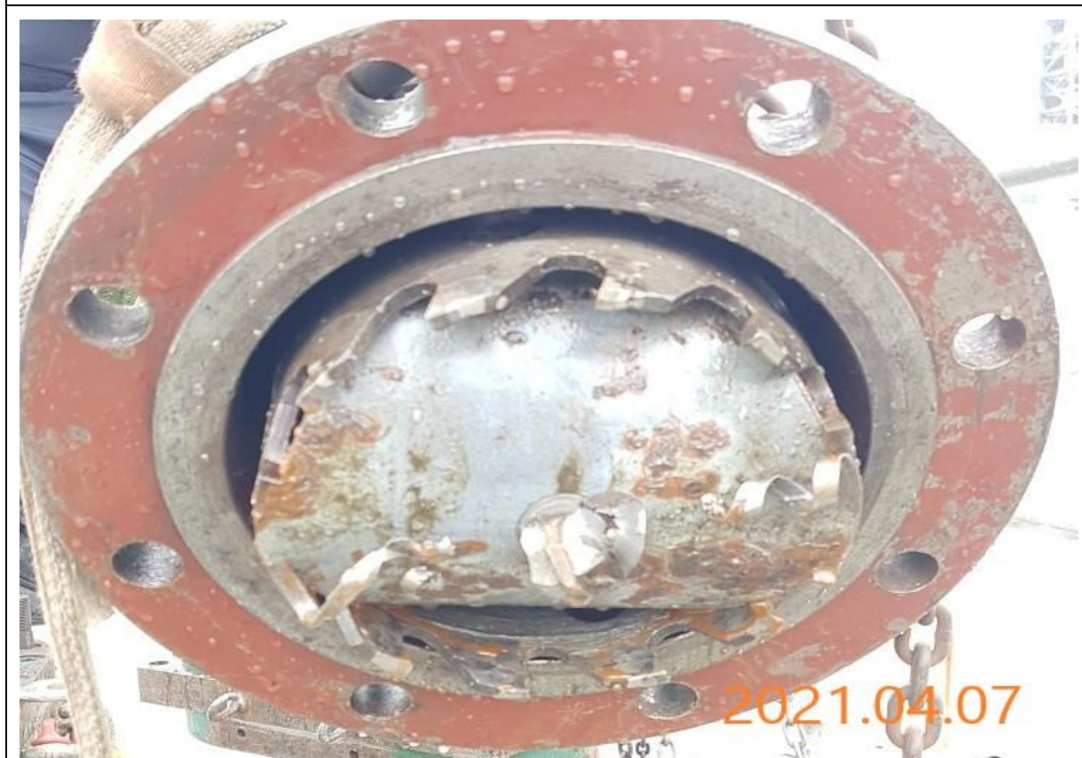
4. 斷管完成確認料塊取出
