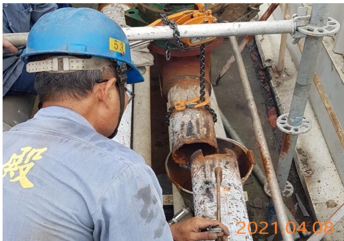
7. 切管完成將管線移除
