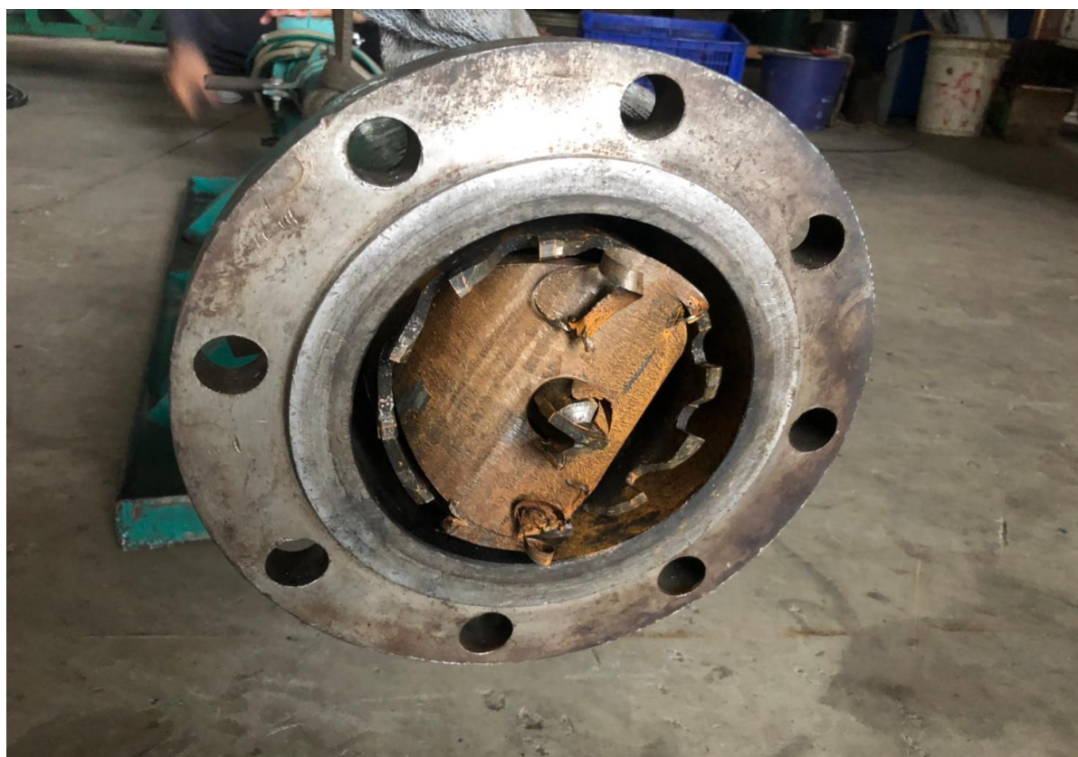
4. 斷管完成，確認料塊取出
