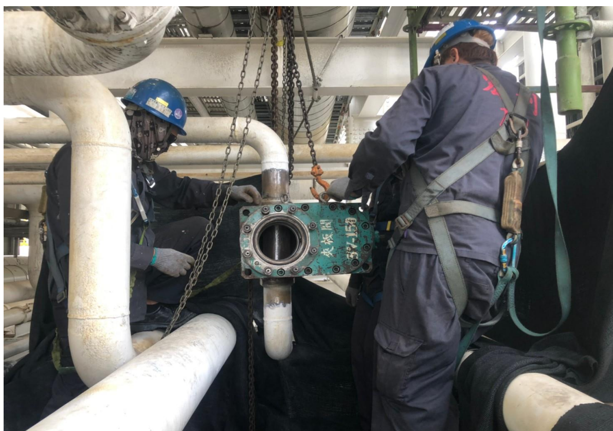
2. 夾板閥安裝作業
