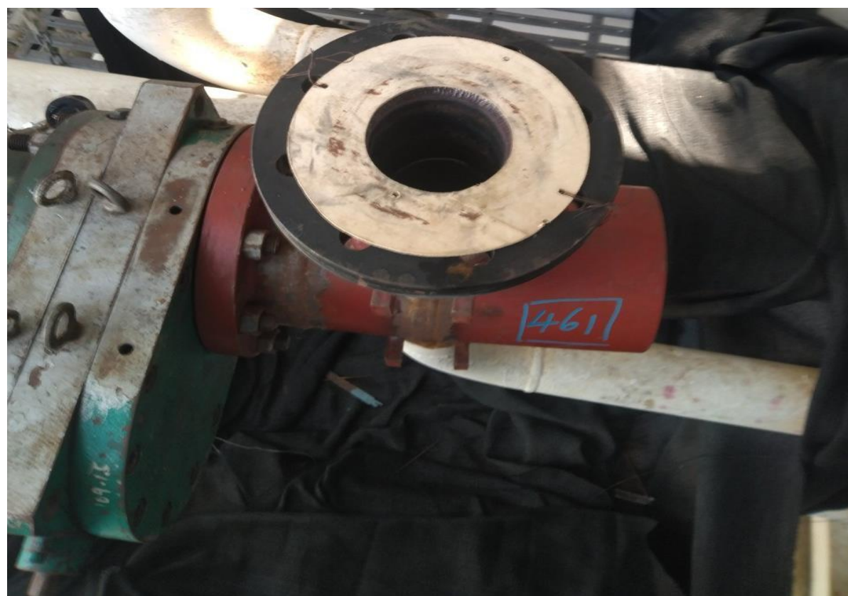
6. 阻斷後進行切管焊法蘭作業
