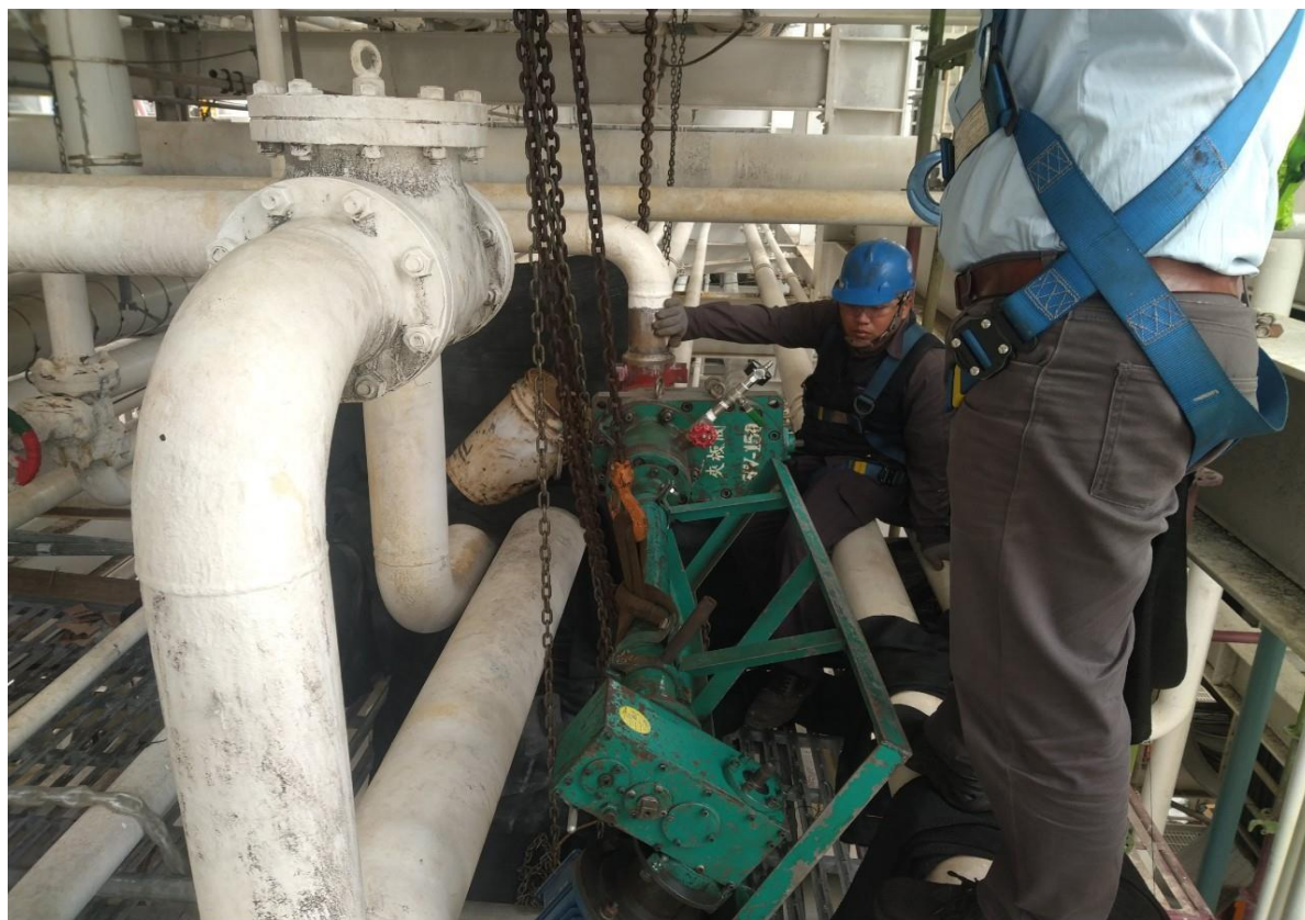
3. 開孔機安裝後進行斷管作業
