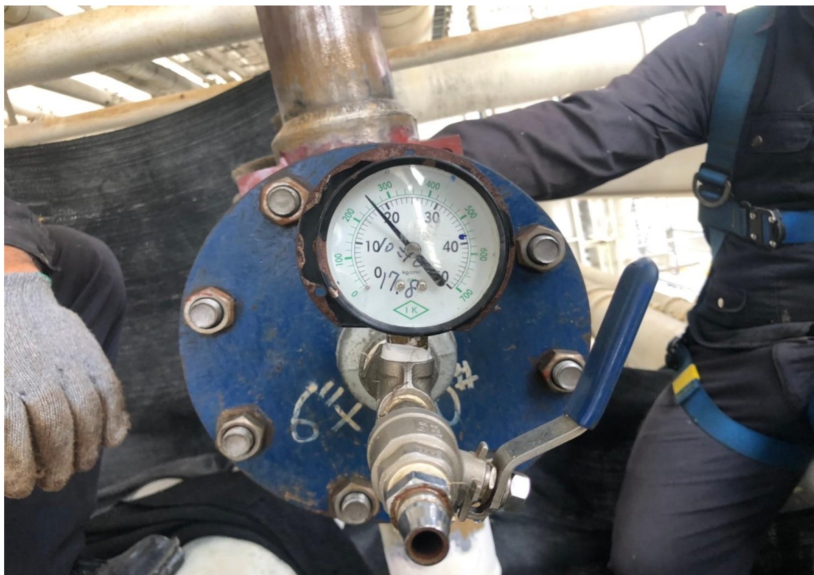
1. 模具焊接後試壓作業
