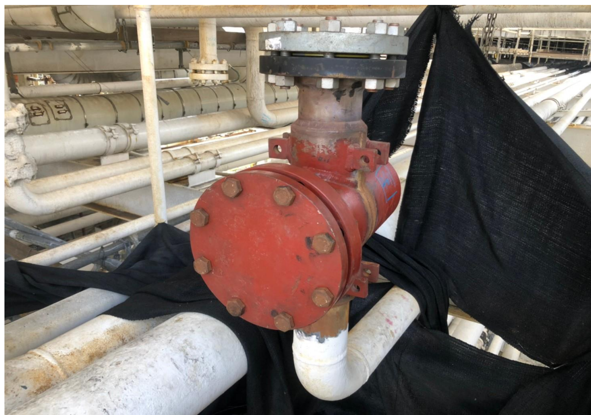
8. 線上阻斷作業完成
