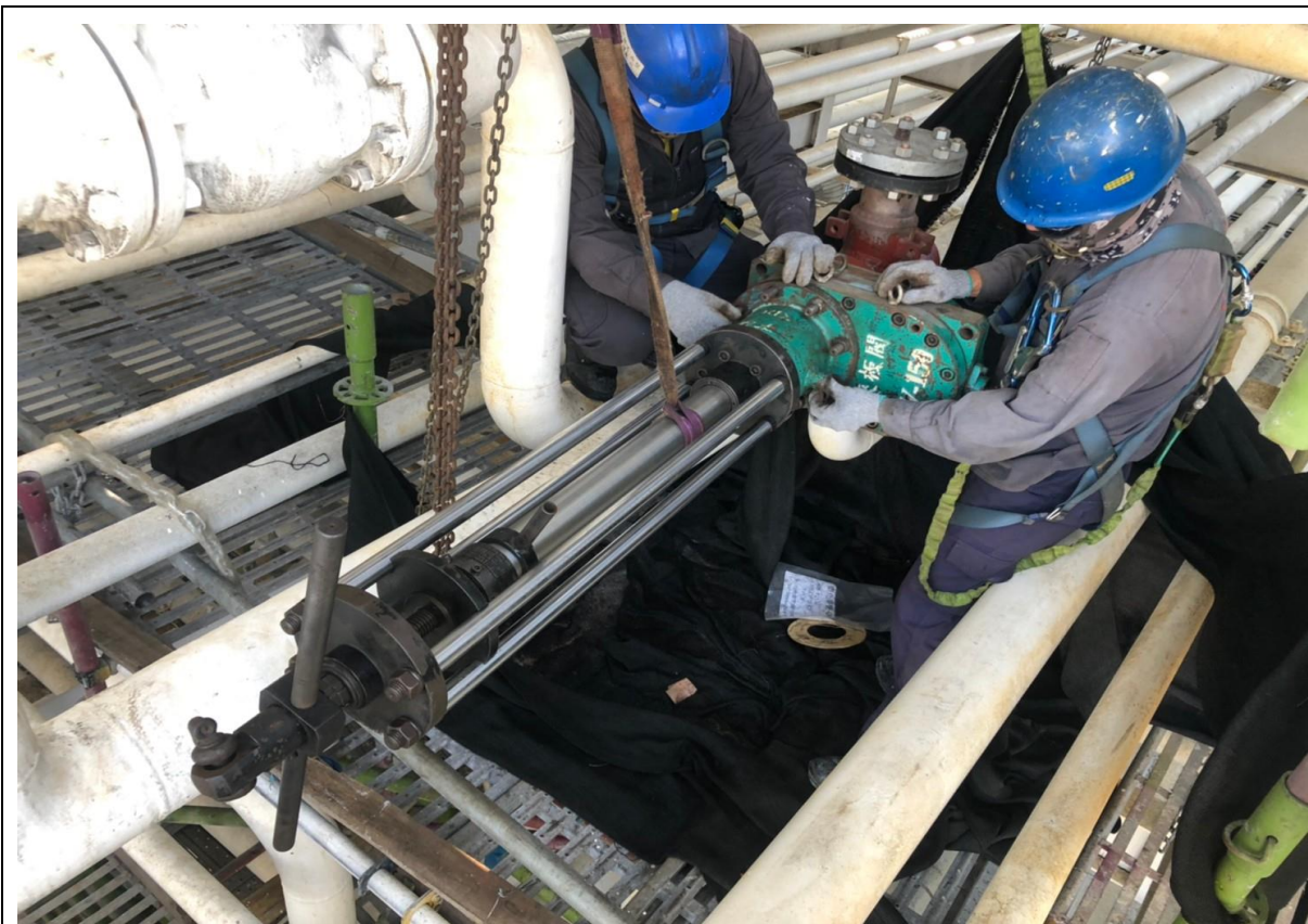
7. 盲法蘭盲封後進行下堵作業
