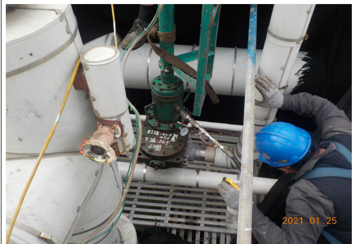
2. 夾板閥及開孔機安裝作業
