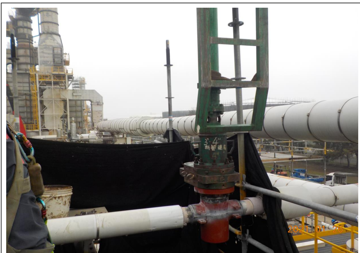
3. 開孔機安裝後進行斷管作業
