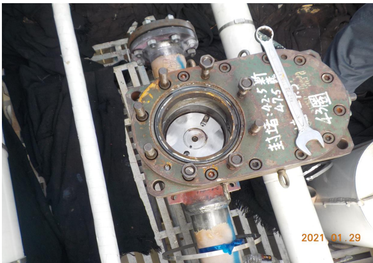
6. 阻斷後進行切管焊法蘭作業
