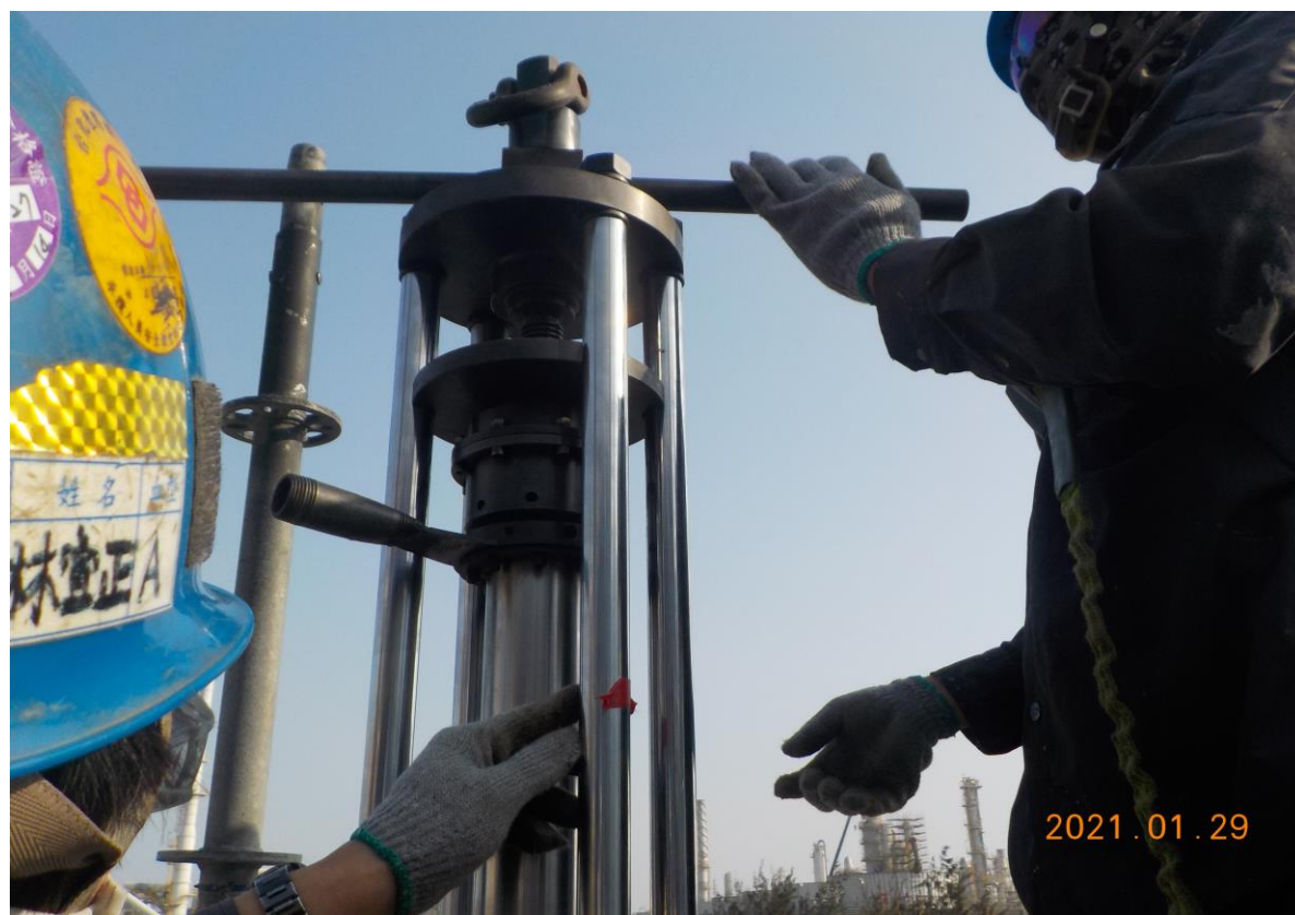
7. 人員進行下堵作業
