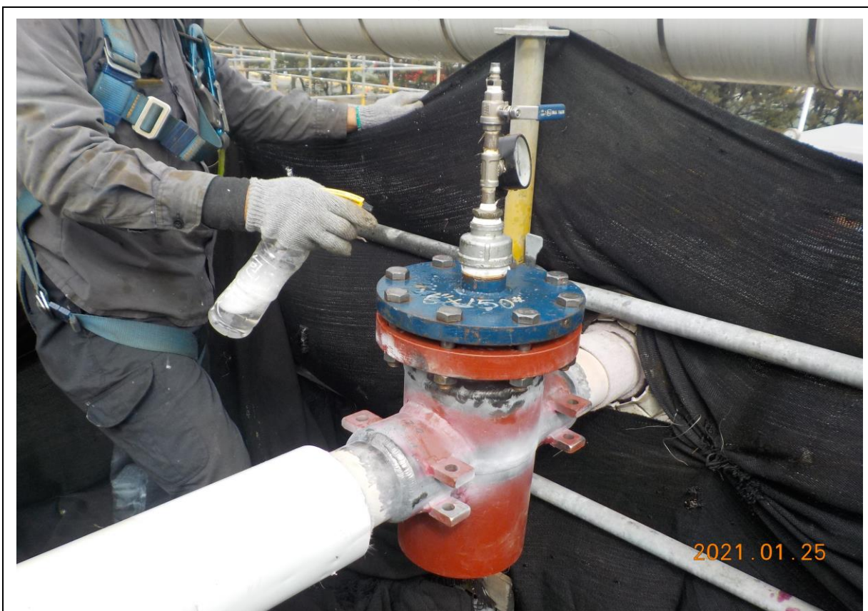
1. 模具焊接後試壓作業
