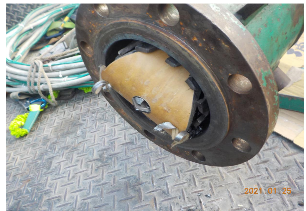
4. 斷管完成，確認料塊取出
