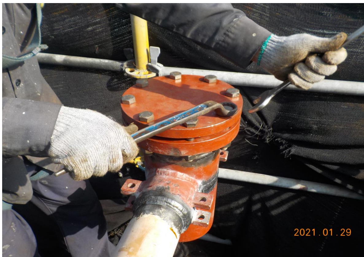
8. 線上阻斷作業完成
