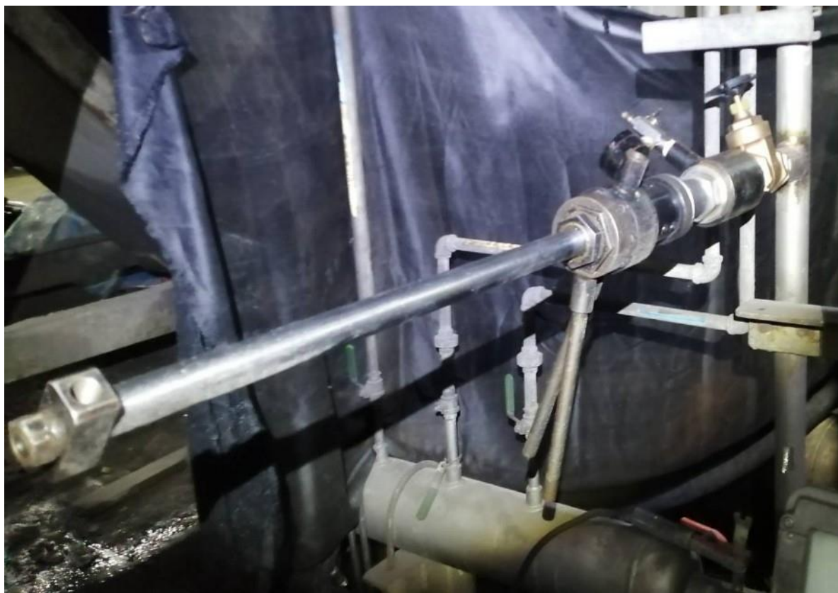
3. 開孔機安裝作業
