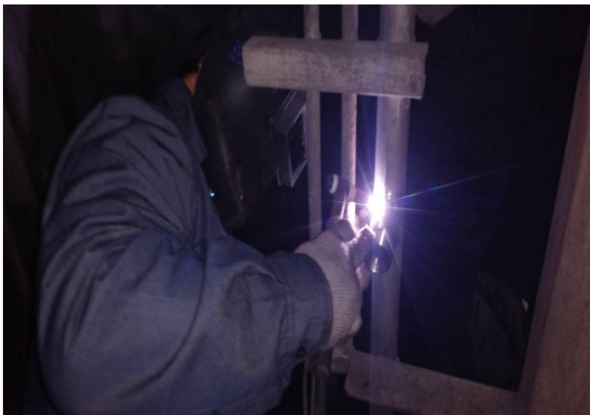
2. 開孔機安裝作業
