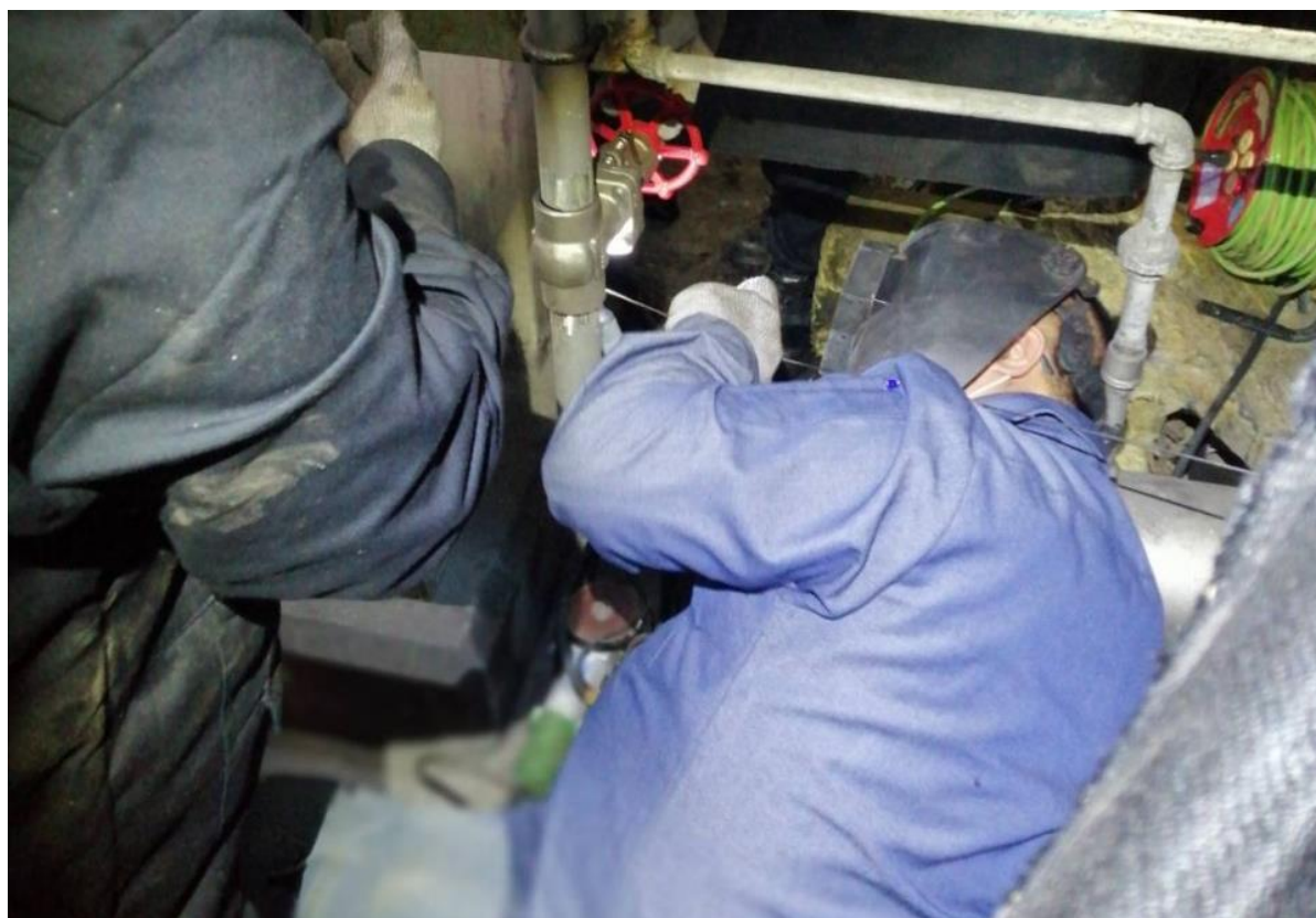
6. 管線切管後增加閥件
