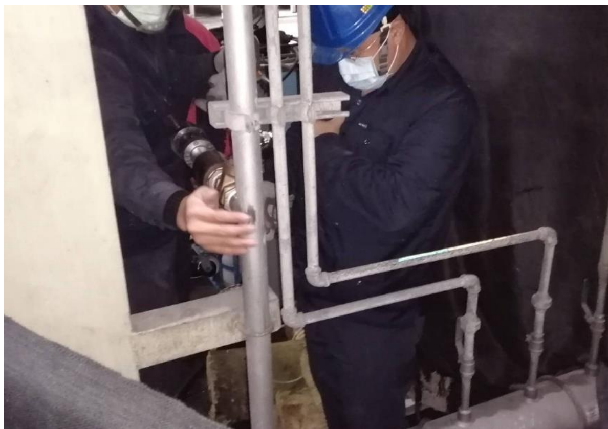
4. 人員進行開孔作業
