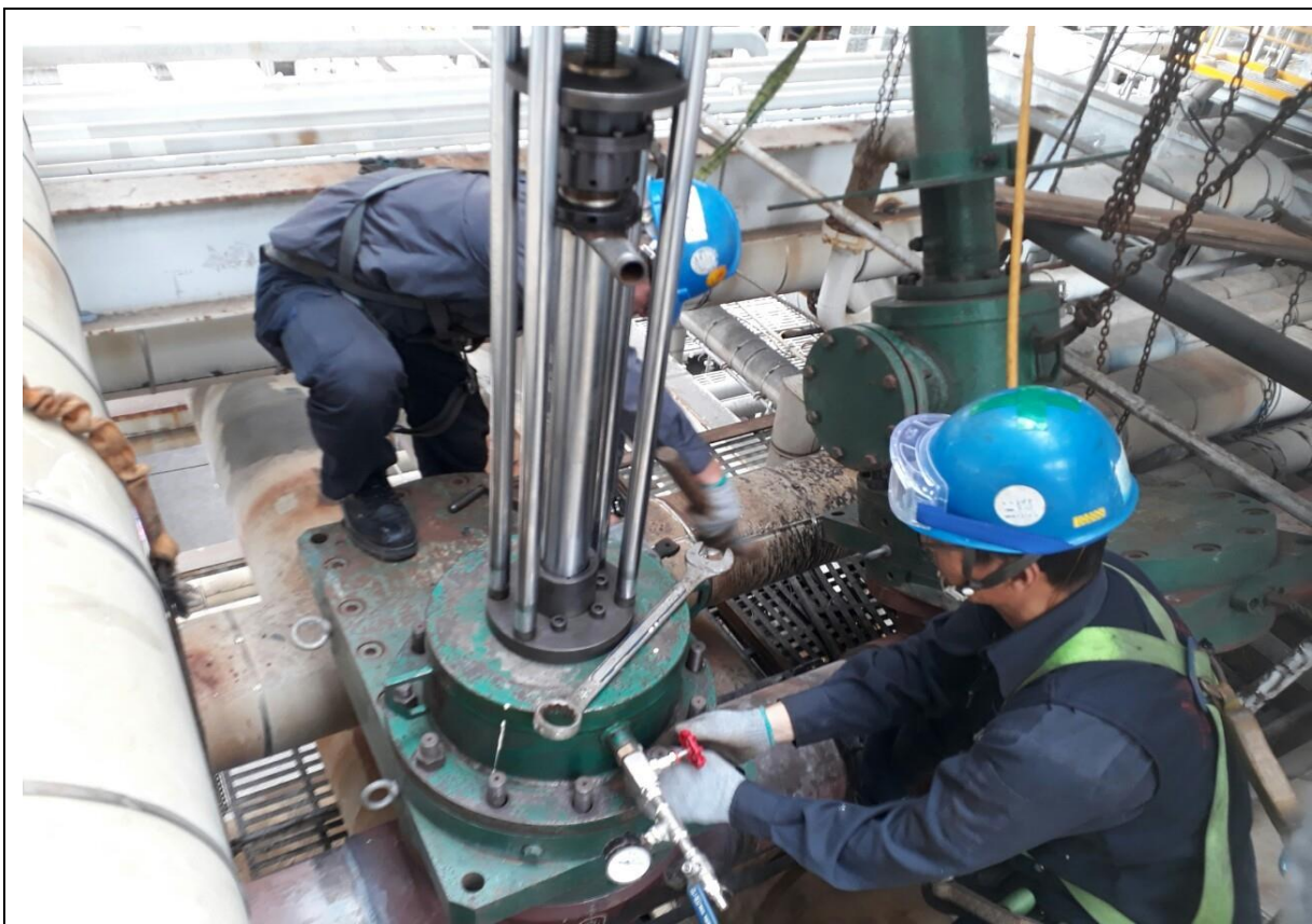
7.人員進行下堵作業
