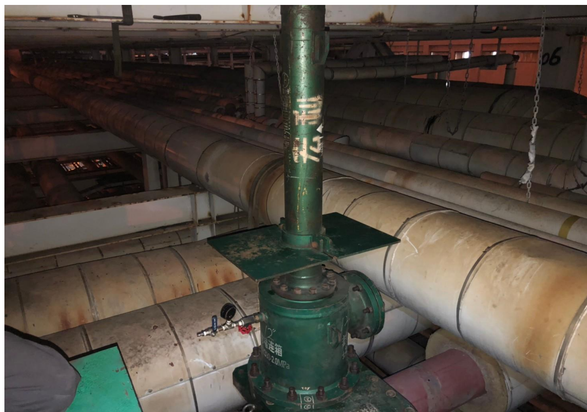
6. 雙阻斷完成後交由製程進行更換閥件
