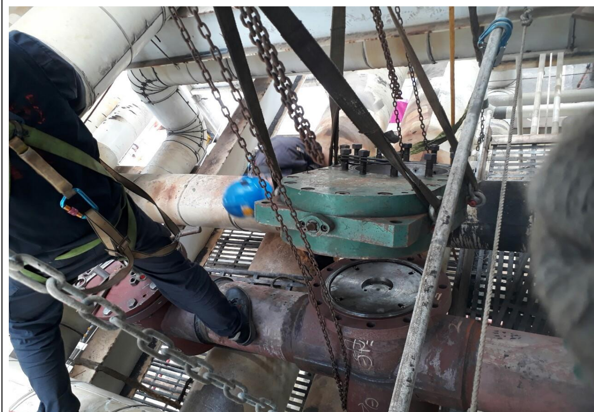
8. 下堵作業完成後將夾板閥移除
