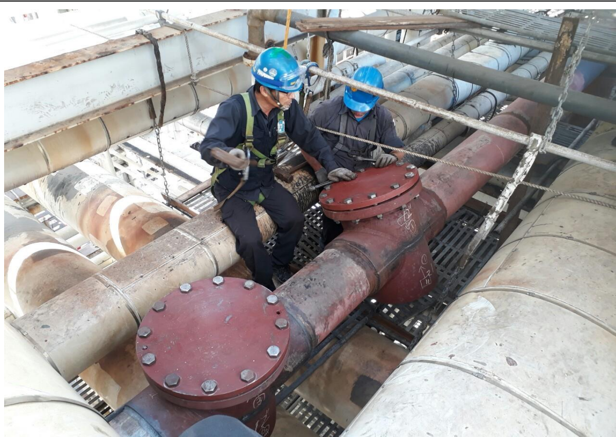
10. DCU 低壓蒸汽線上阻斷施工完成
