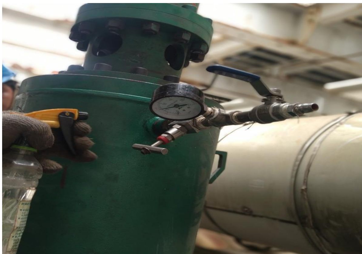
3. 焊接完成後安裝夾板閥及開孔機具並試壓
