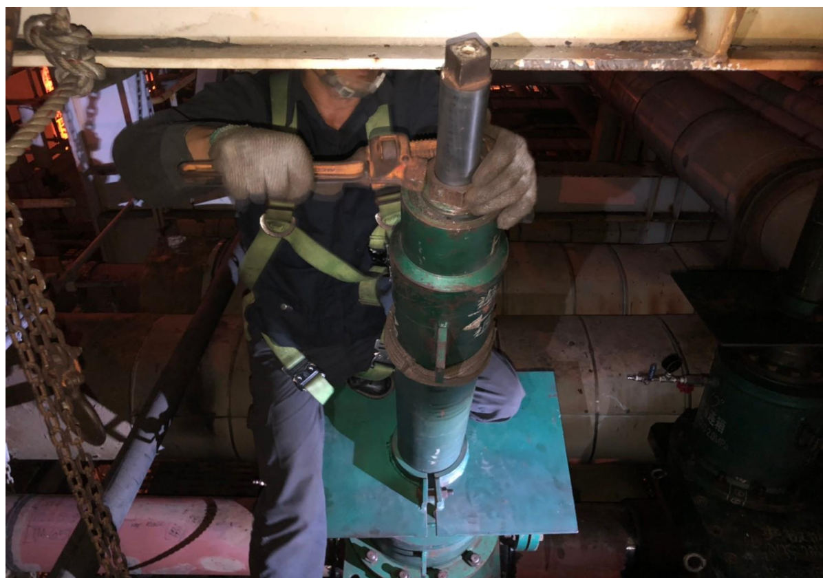
5. 斷管完成進行阻斷作業
