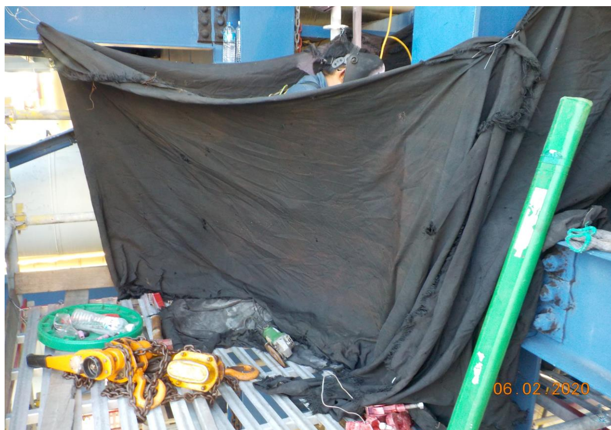
2. 現場防火毯鋪設
