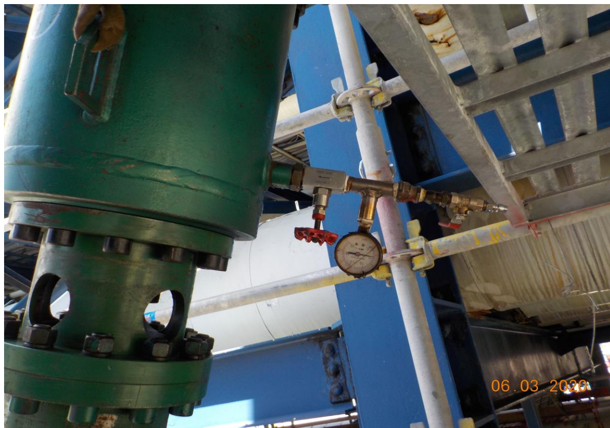
3. 焊接完成後安裝夾板閥及開孔機具
