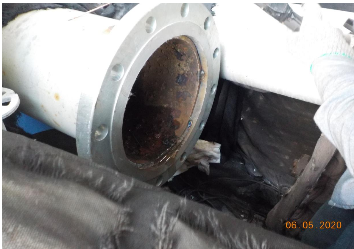
9. 管線新增法蘭面作業
