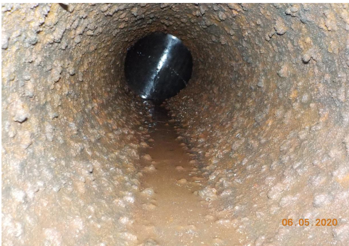
8. 切管後管內情形
