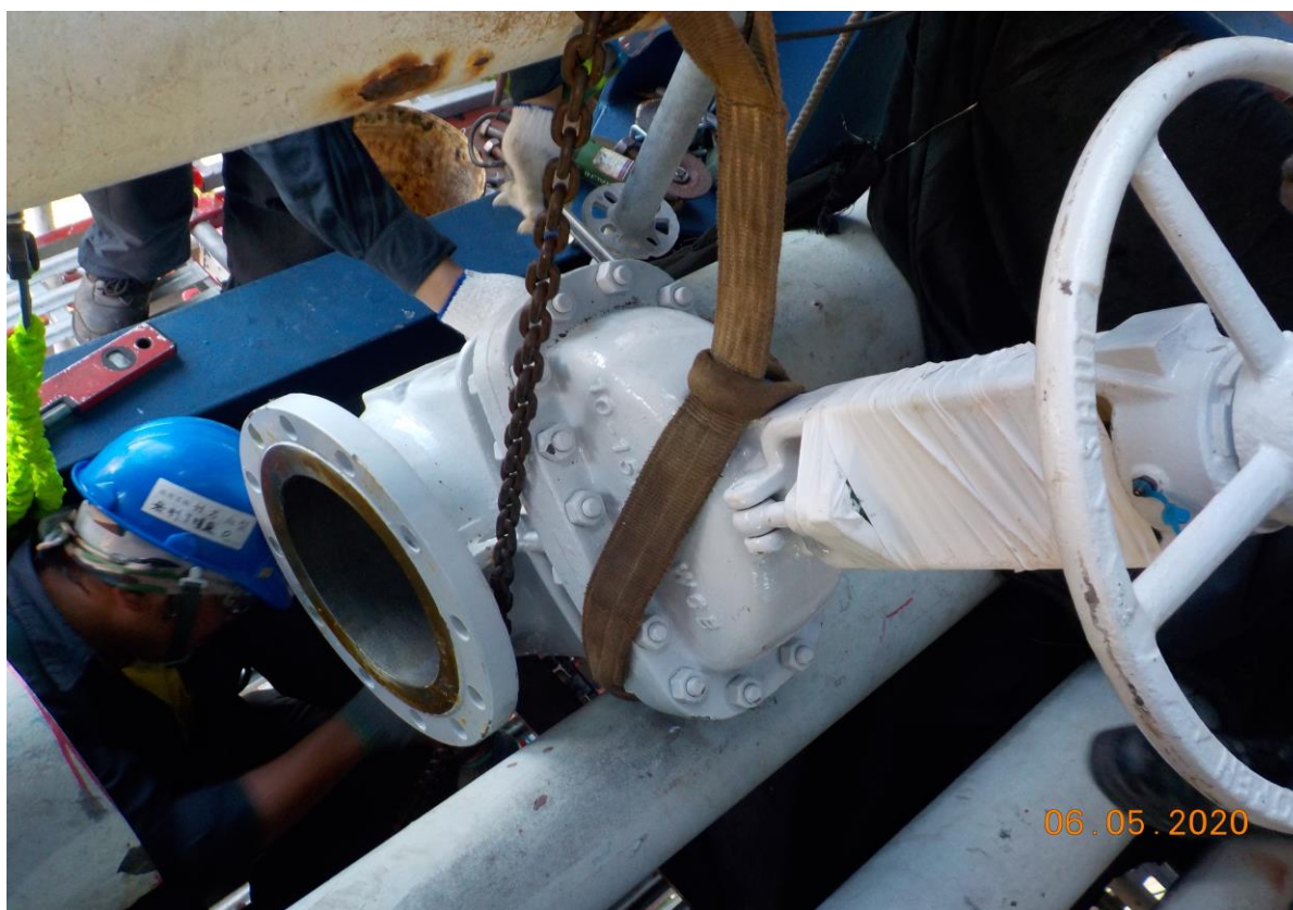
10. 管線新增閥件安裝作業
