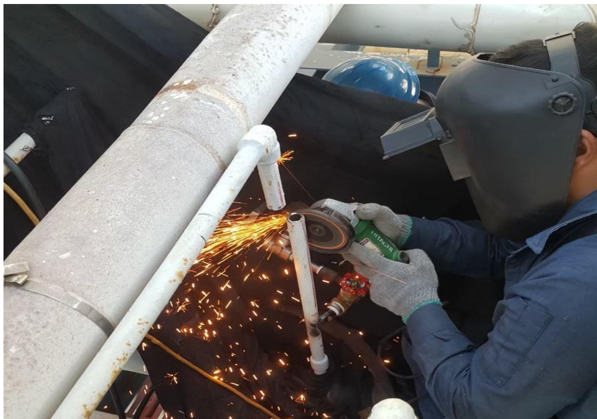
17. 阻斷完成後切管作業
