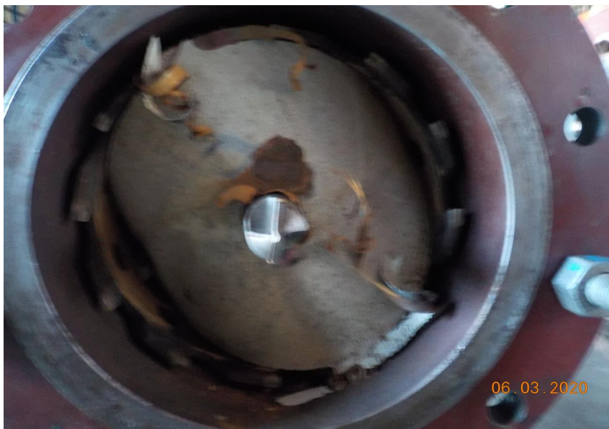
5. 斷管完成確認料塊取出
