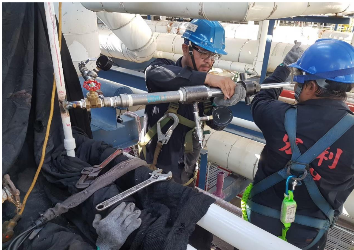
15. 人員進行開孔作業
