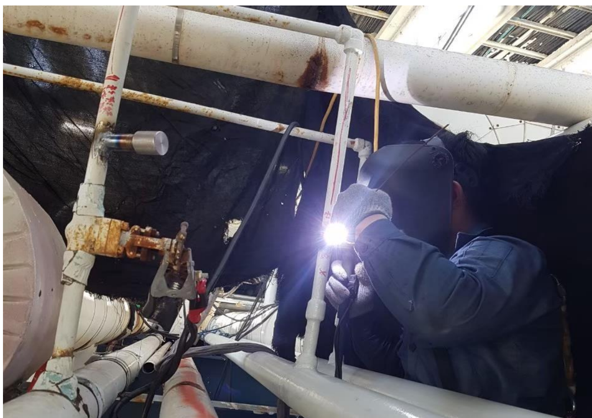
14. 6 分模具焊接作業
