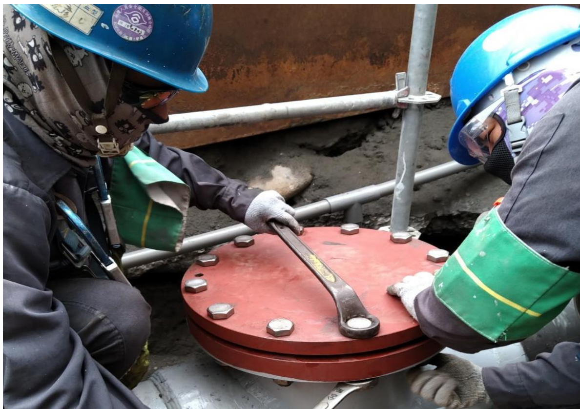
19. 施工完成，人員安裝盲法蘭
