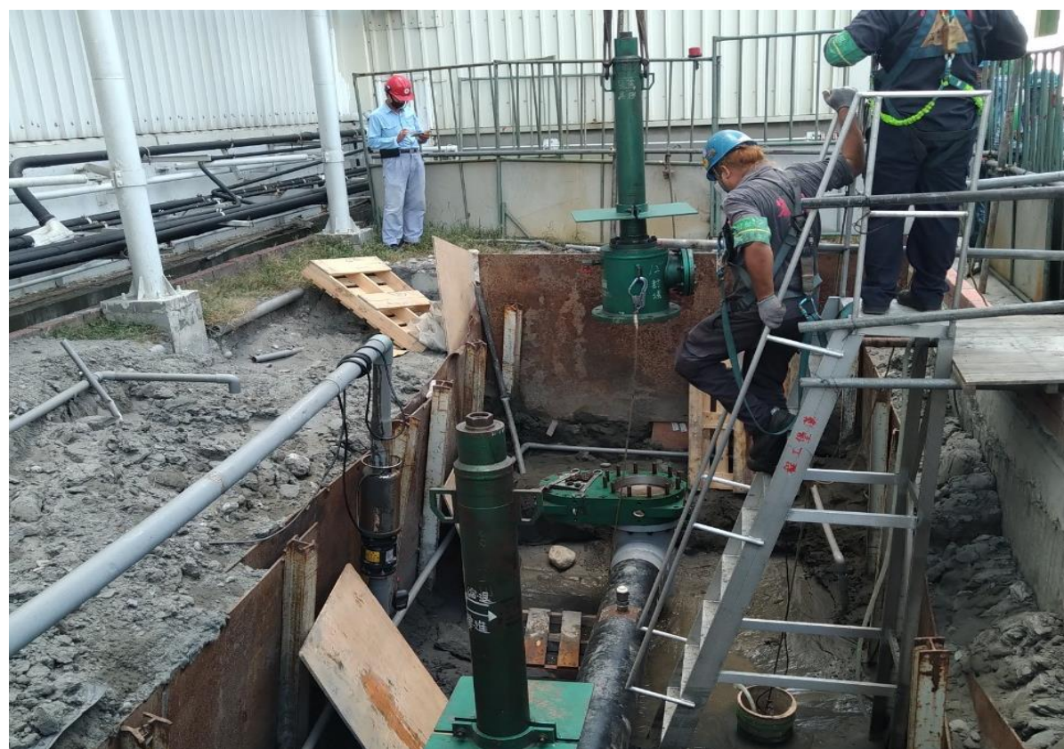
6. 斷管完成進行阻斷機具安裝
