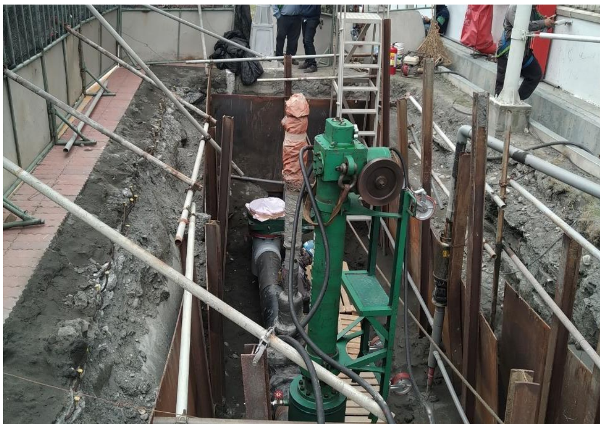
14. 開孔機試壓完成後進行開孔作業
