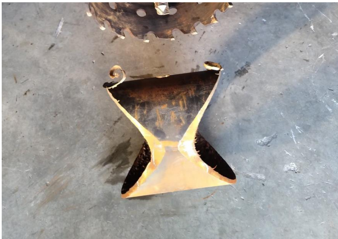
15. 斷管完成確認料塊取出
