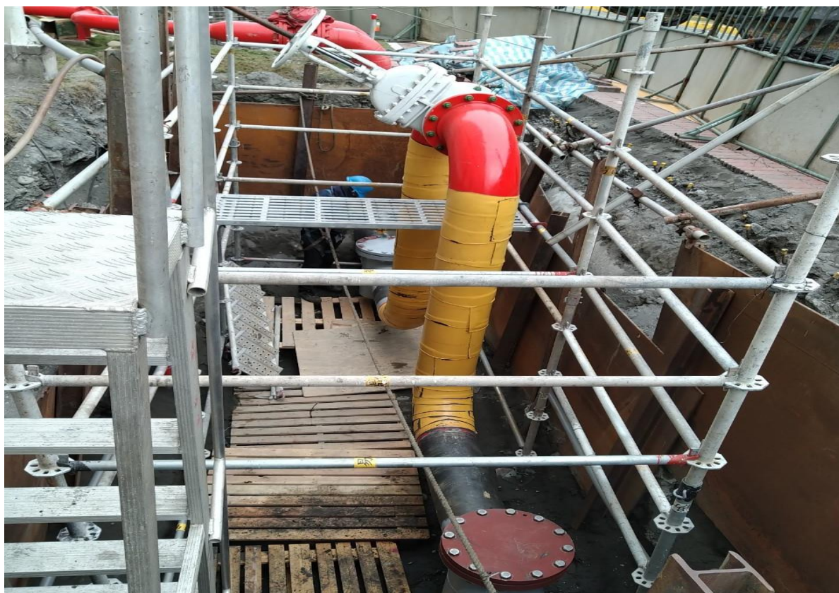
20. 倉儲消防管 PIV 遮斷閥地上化第二組完成
