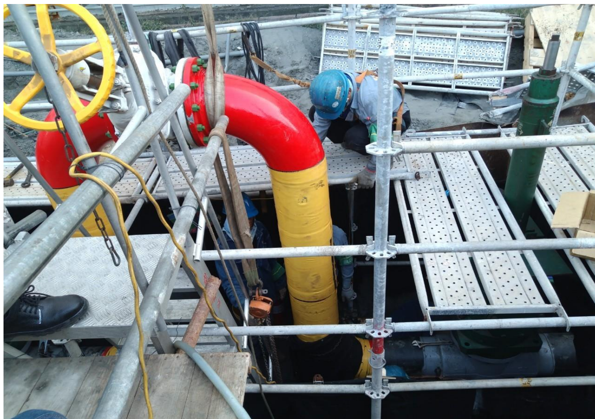
9. 管線配管及新增閥件作業
