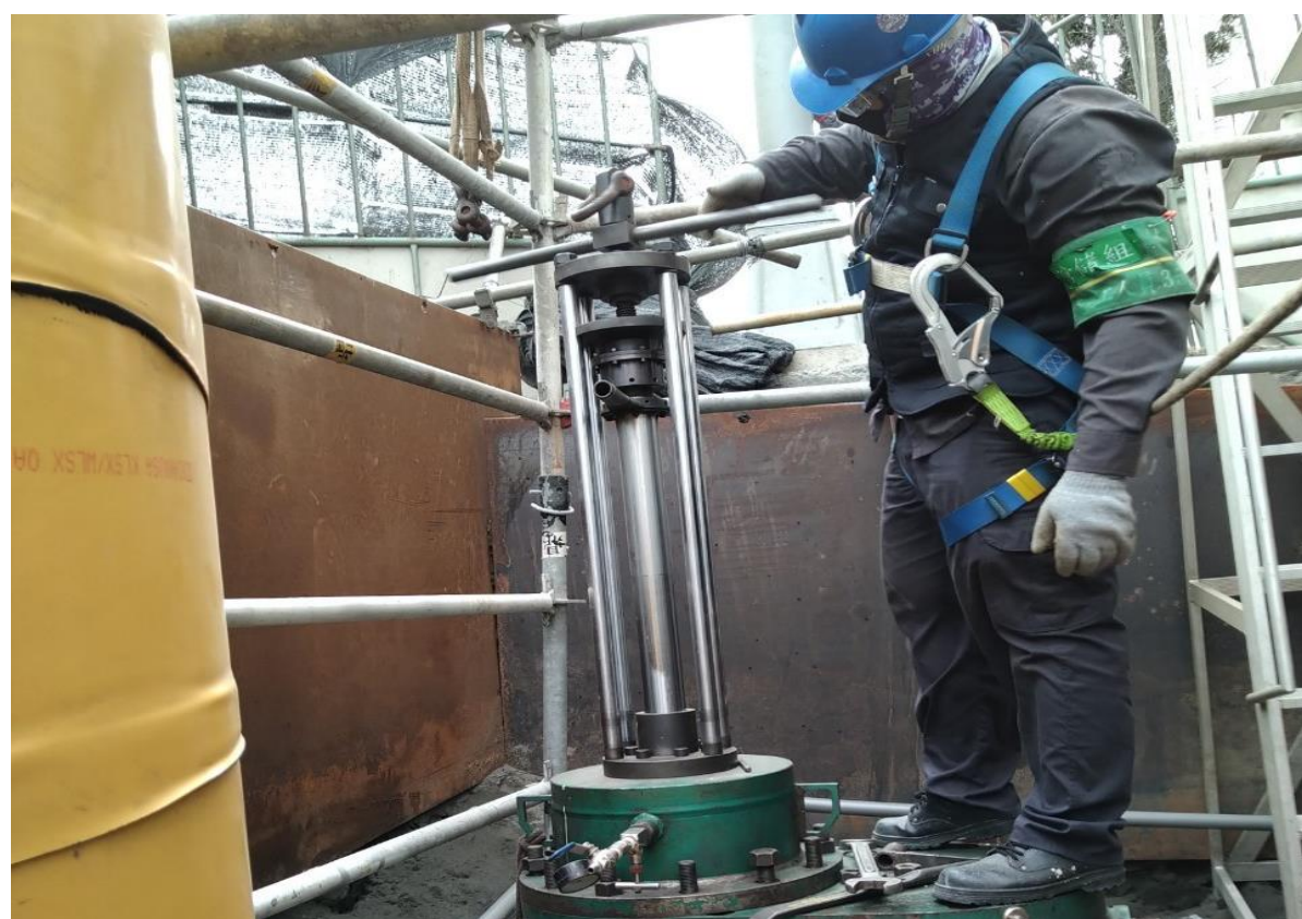
18. 人員進行下堵作業
