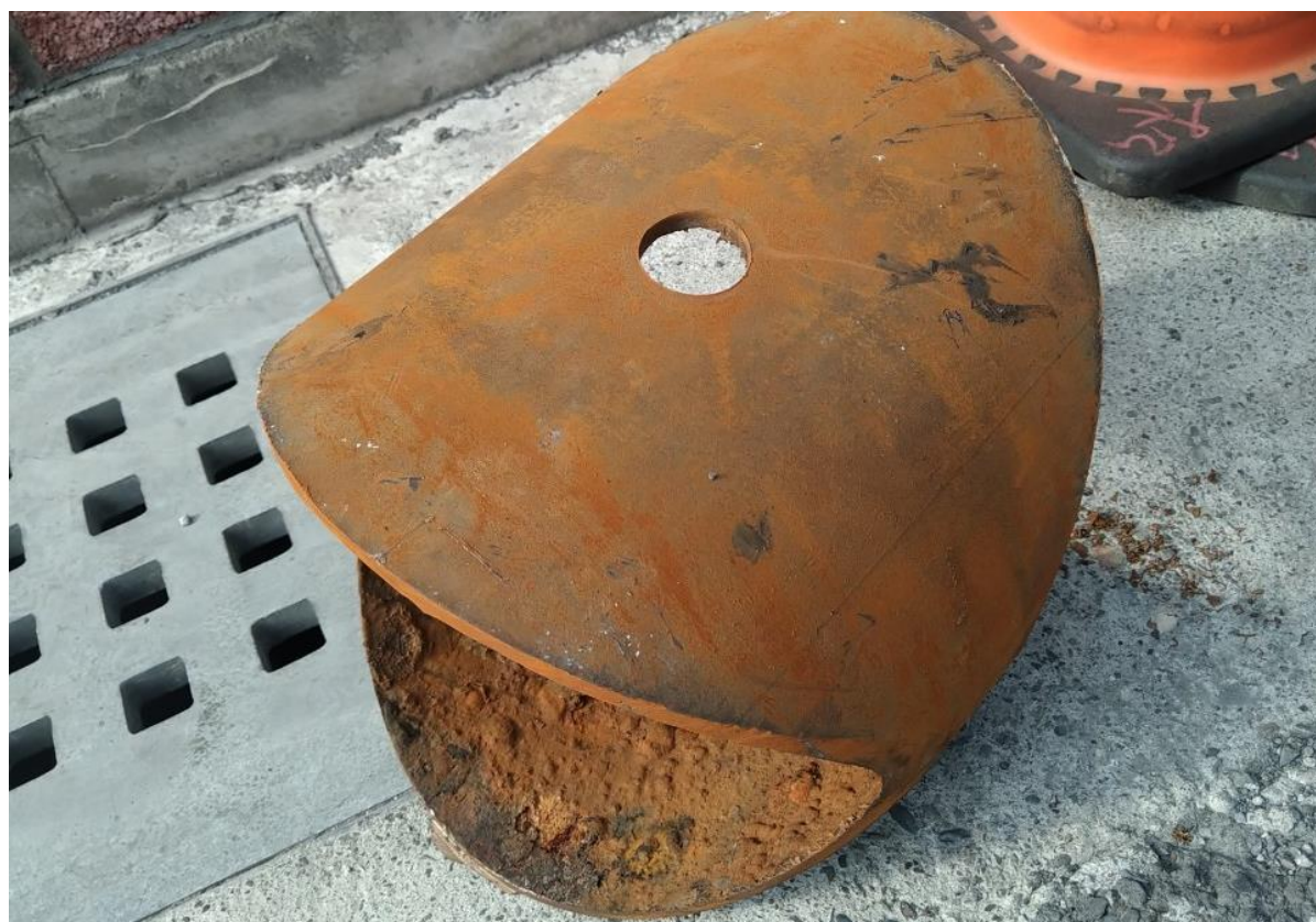
5. 斷管完成確認料塊取出(2)
