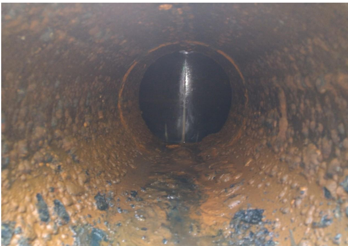
8. 切管後管內情形
