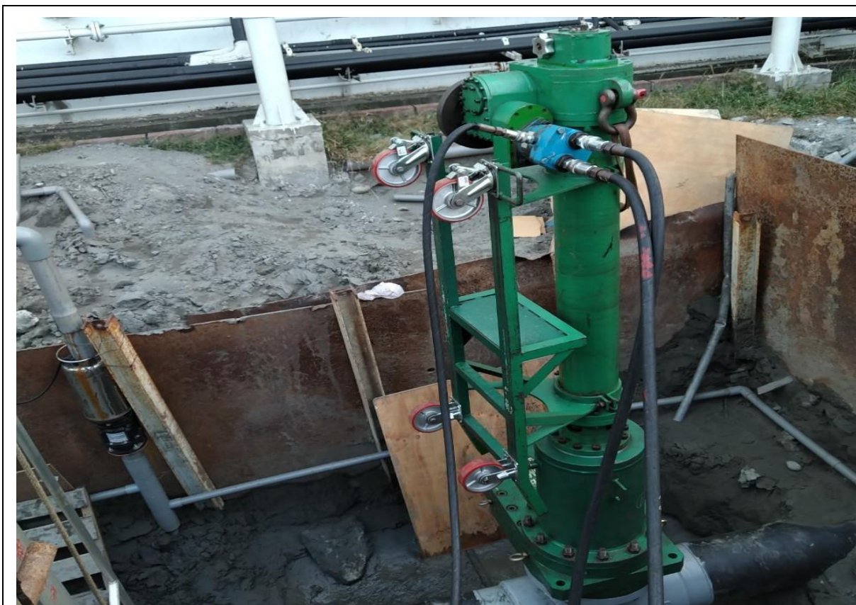
1. 夾板閥及開孔機安裝作業
