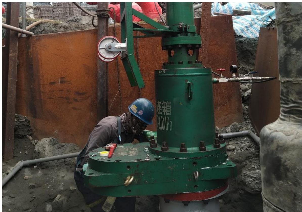
13. 開孔機安裝後進行試壓作業
