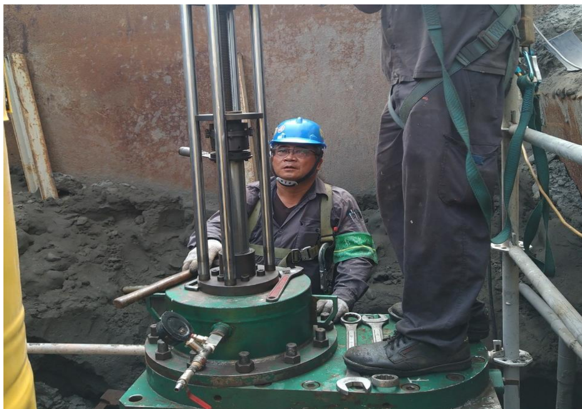
10. 人員進行下堵作業
