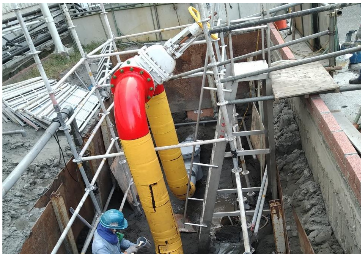
12. 倉儲消防管 PIV 遮斷閥地上化第一組完成
