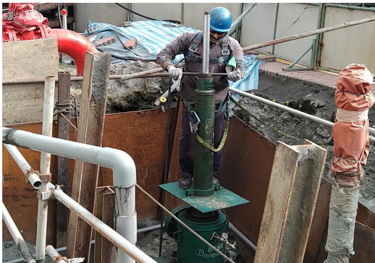
16. 斷管完成後進行阻斷作業
