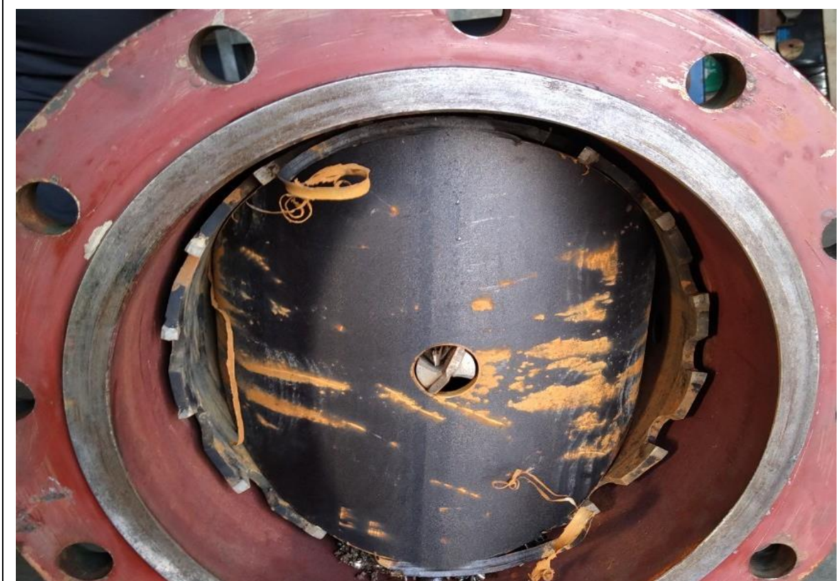
4. 斷管完成確認料塊取出(1)
