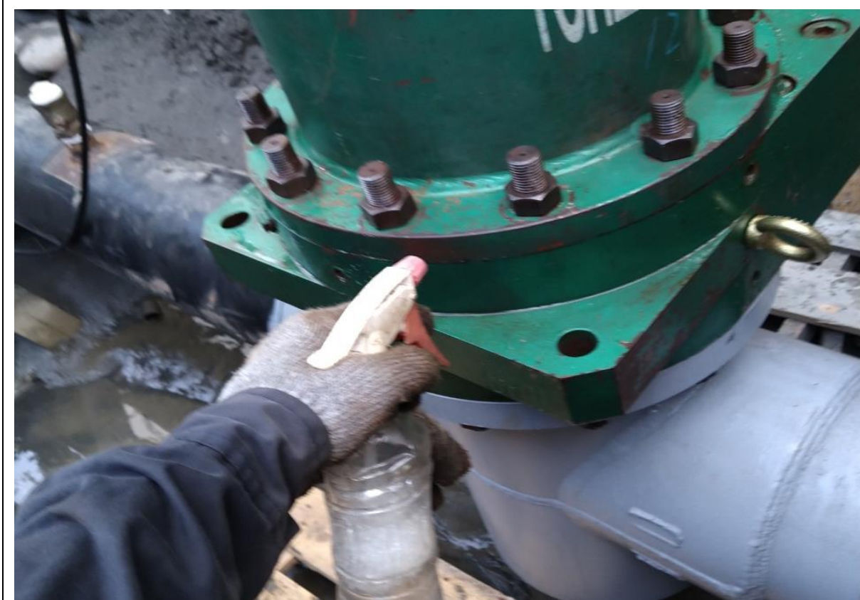
2. 開孔機安裝完成後試壓抓漏情形
