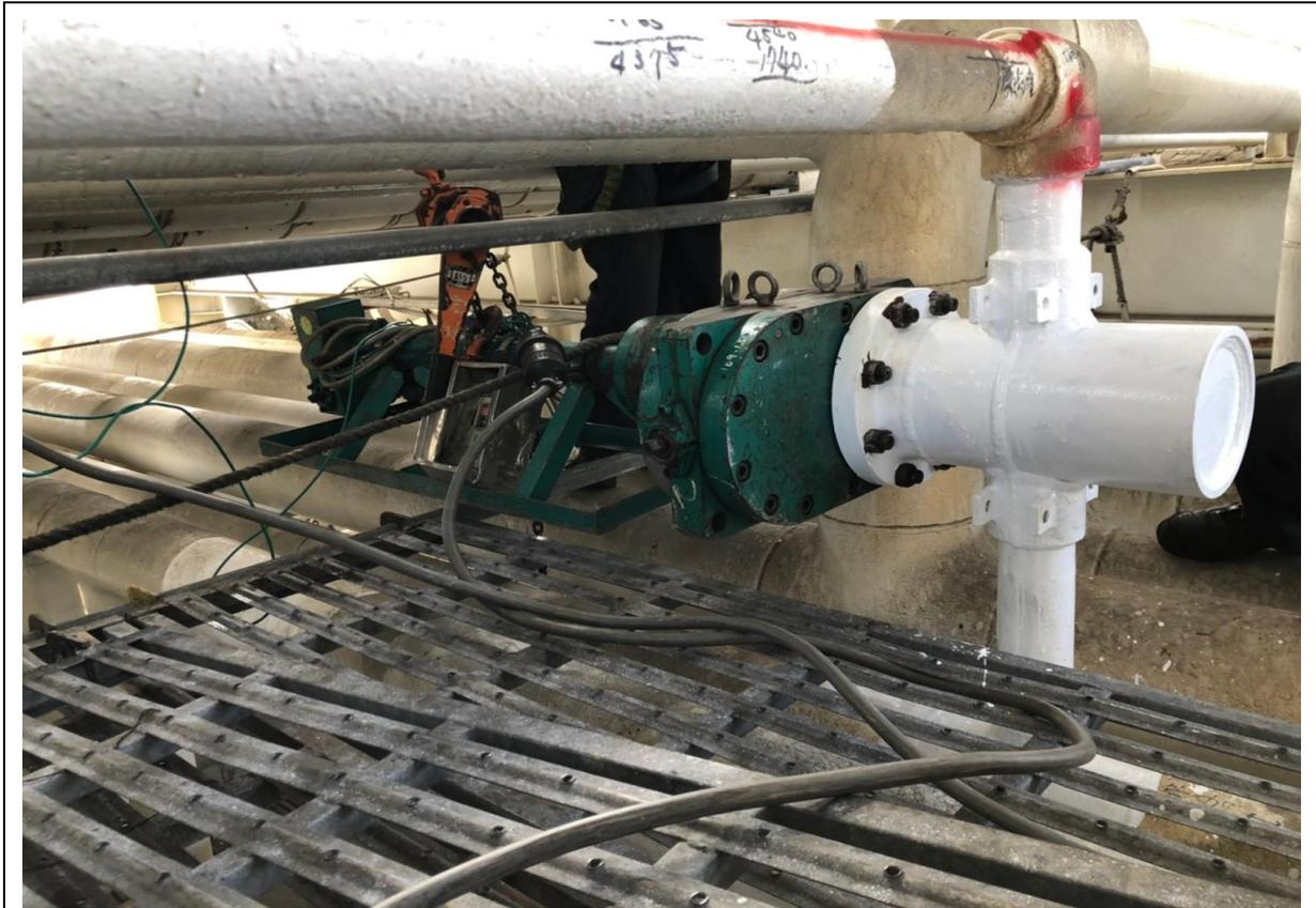
1. 開孔機具安裝及試壓作業(3")
