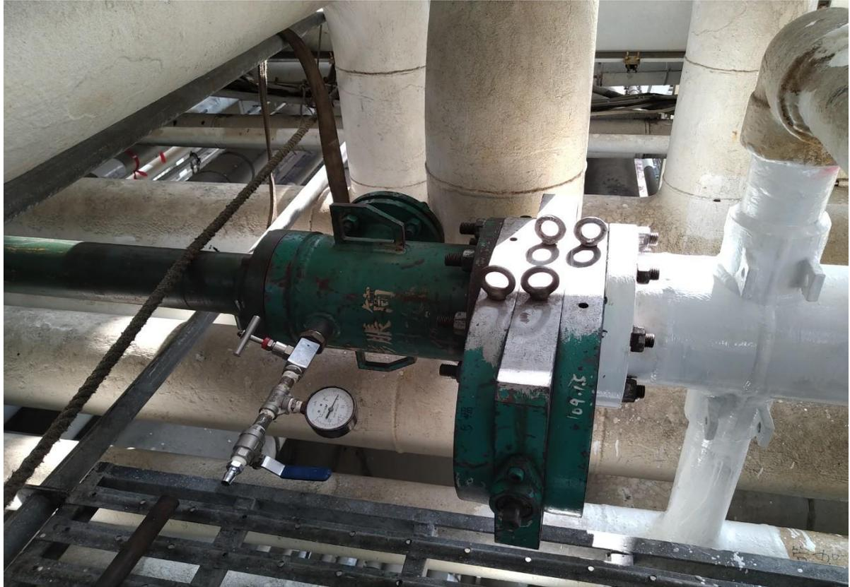
5. 確認阻斷排壓後交由配管商切管封焊
