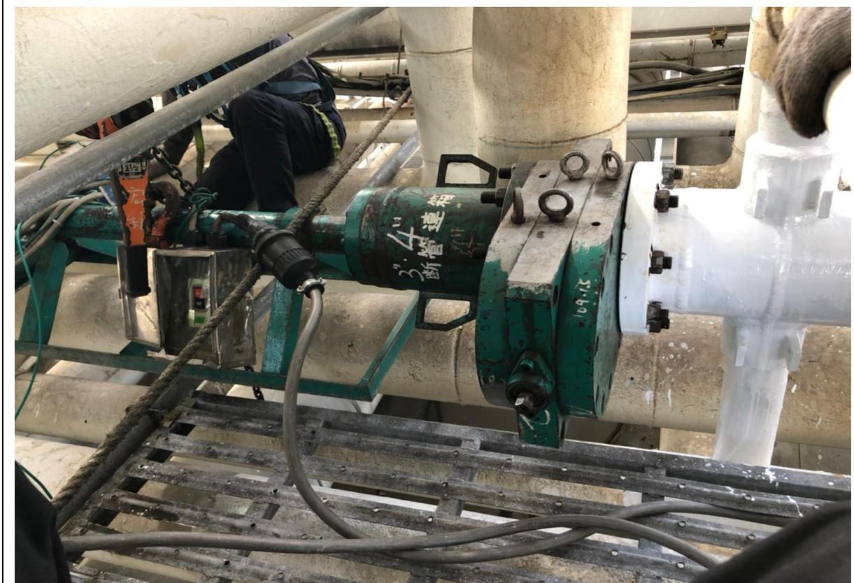
2. 人員操作開孔機進行斷管作業
