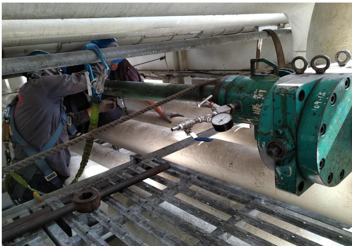
4. 人員操作阻斷機進行阻斷作業
