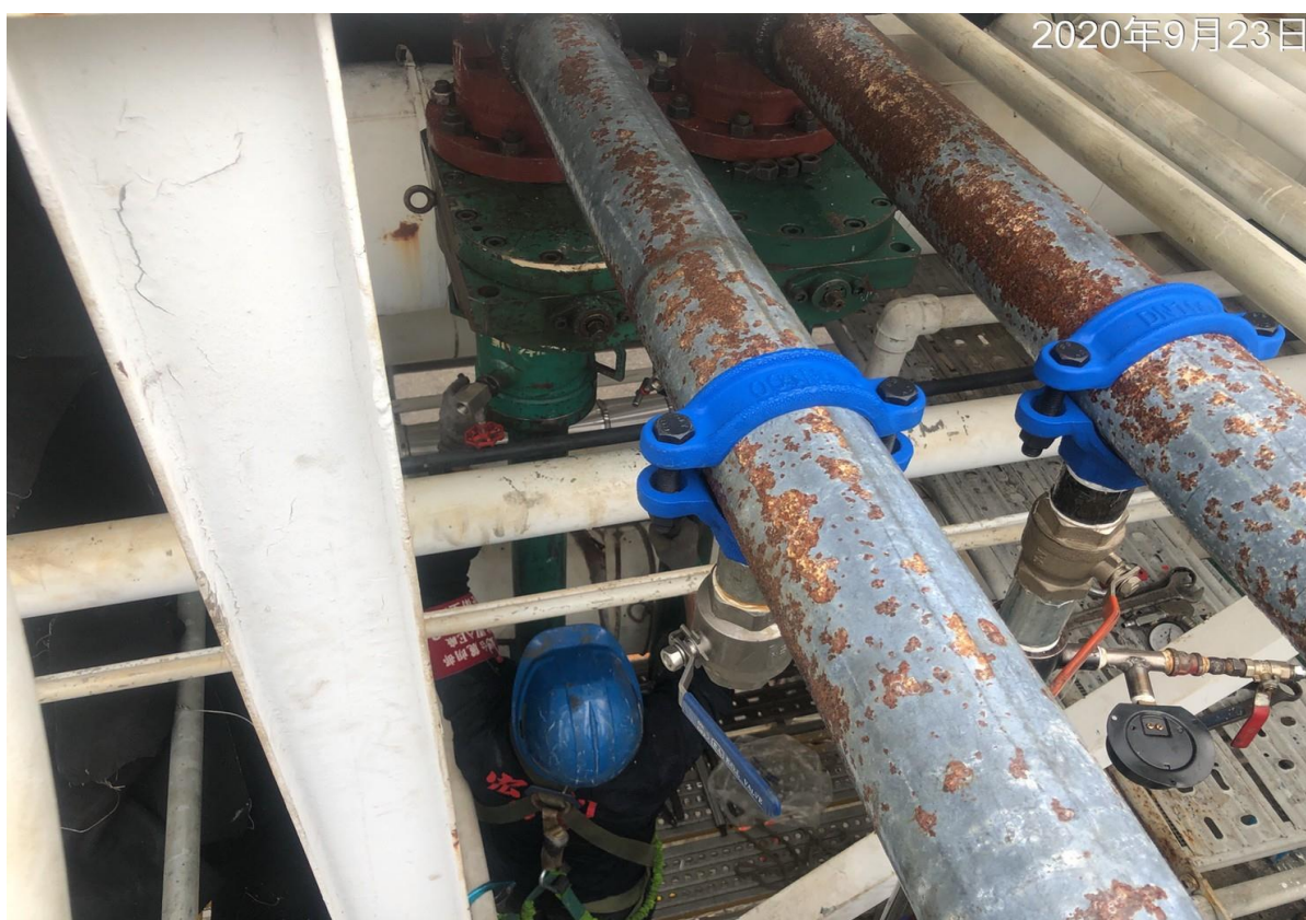
6. 後端開孔確認阻斷是否完成
