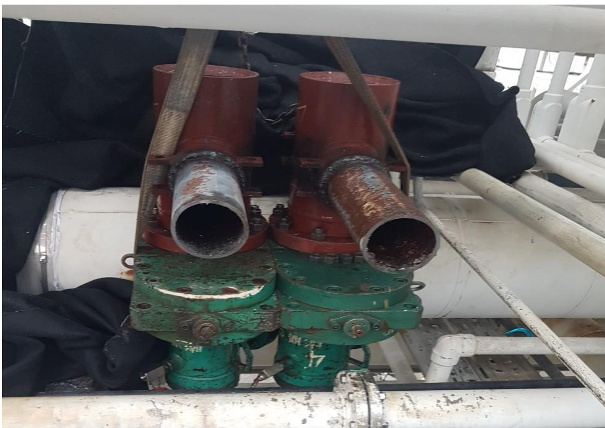
8. 阻斷完成進行切管作業
