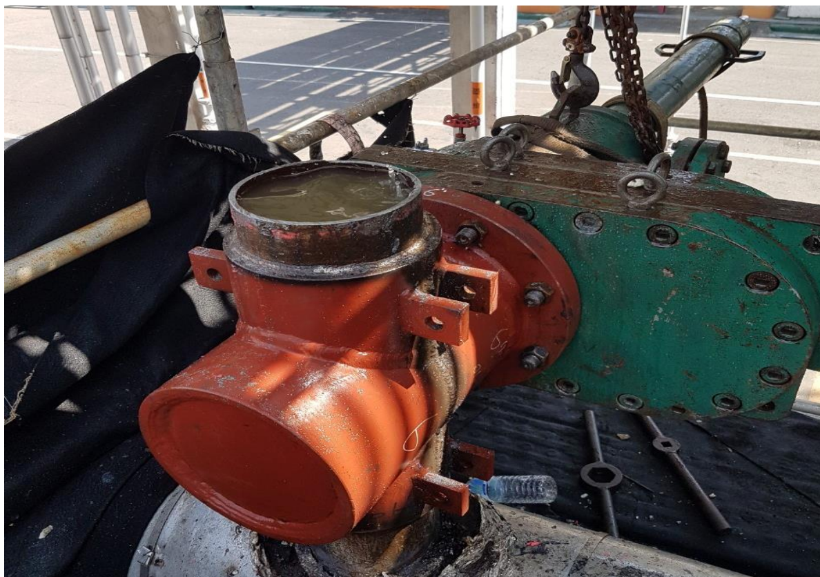
15. 阻斷後進行切管作業
