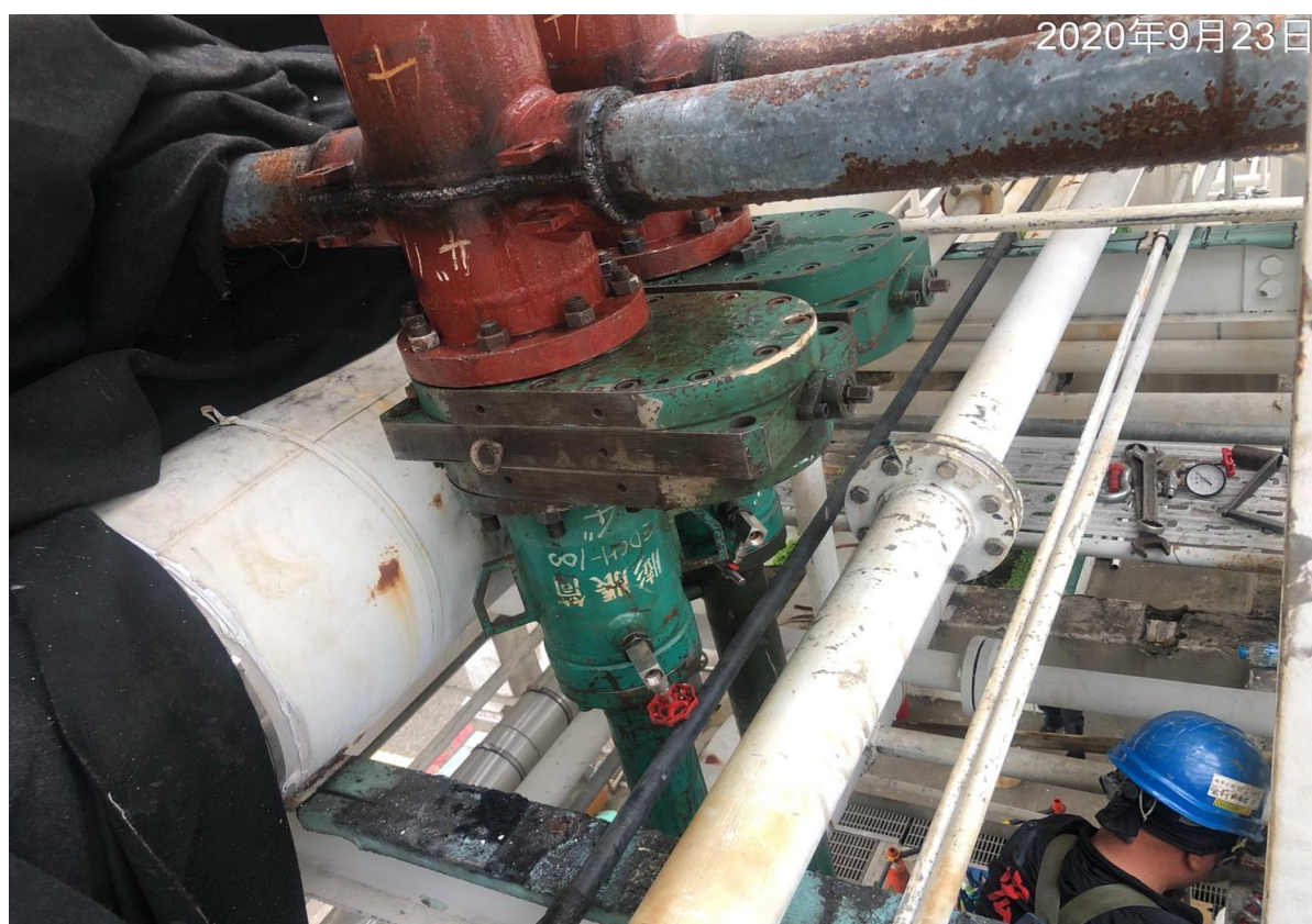
5. 開孔完成進行阻斷作業
