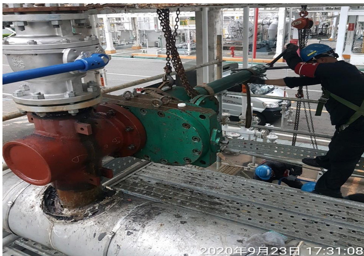
16. 閥件增設作業完成
