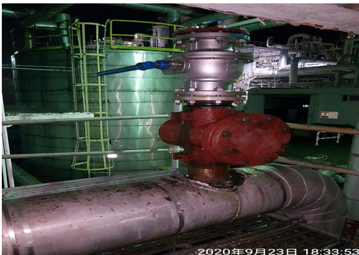
18. 6"線上阻斷工程施工完成
