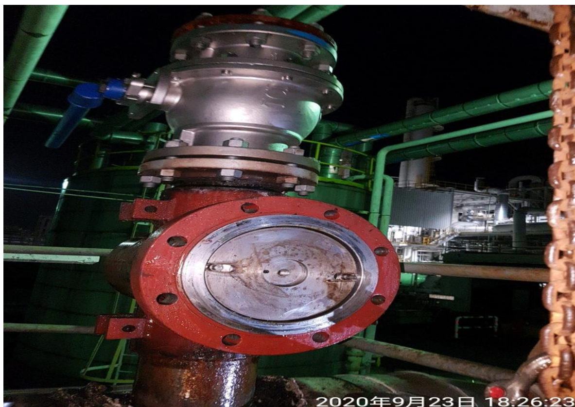
17. 下塞堵作業完成
