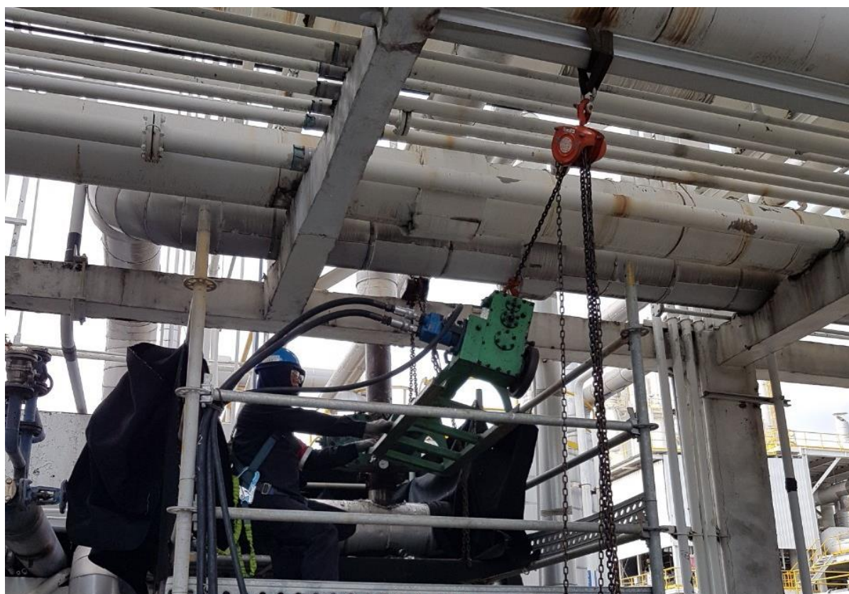
13. 安裝開孔機後進行斷管作業
