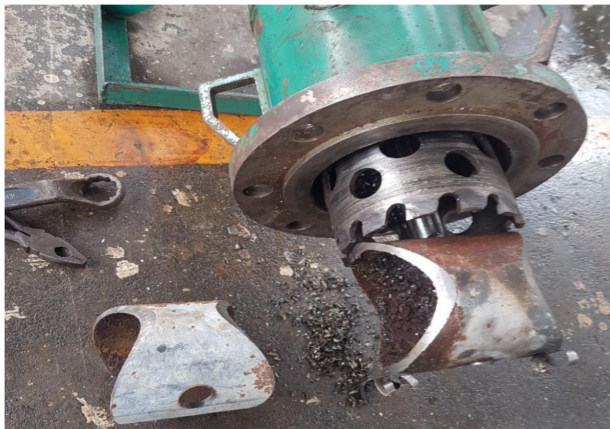
4. 斷管完成確認料塊取出
