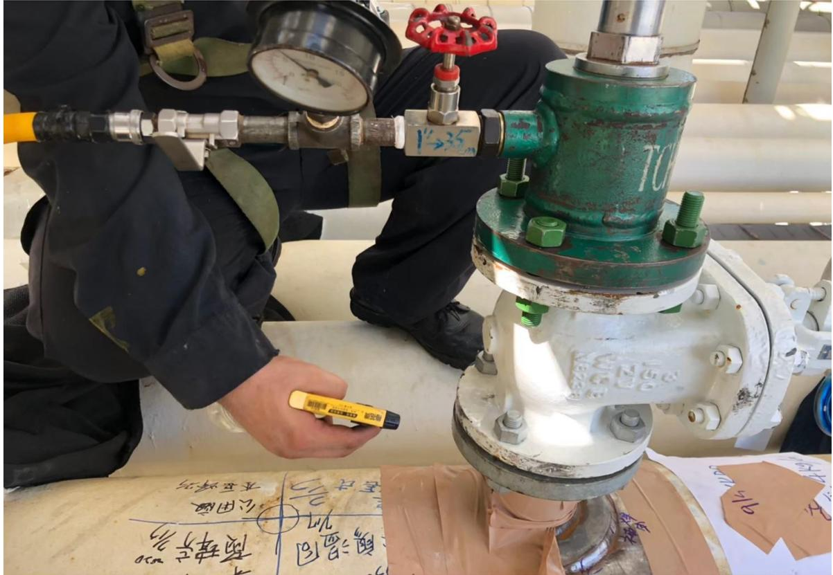
5. 開孔機具安裝及試壓作業(3'')
