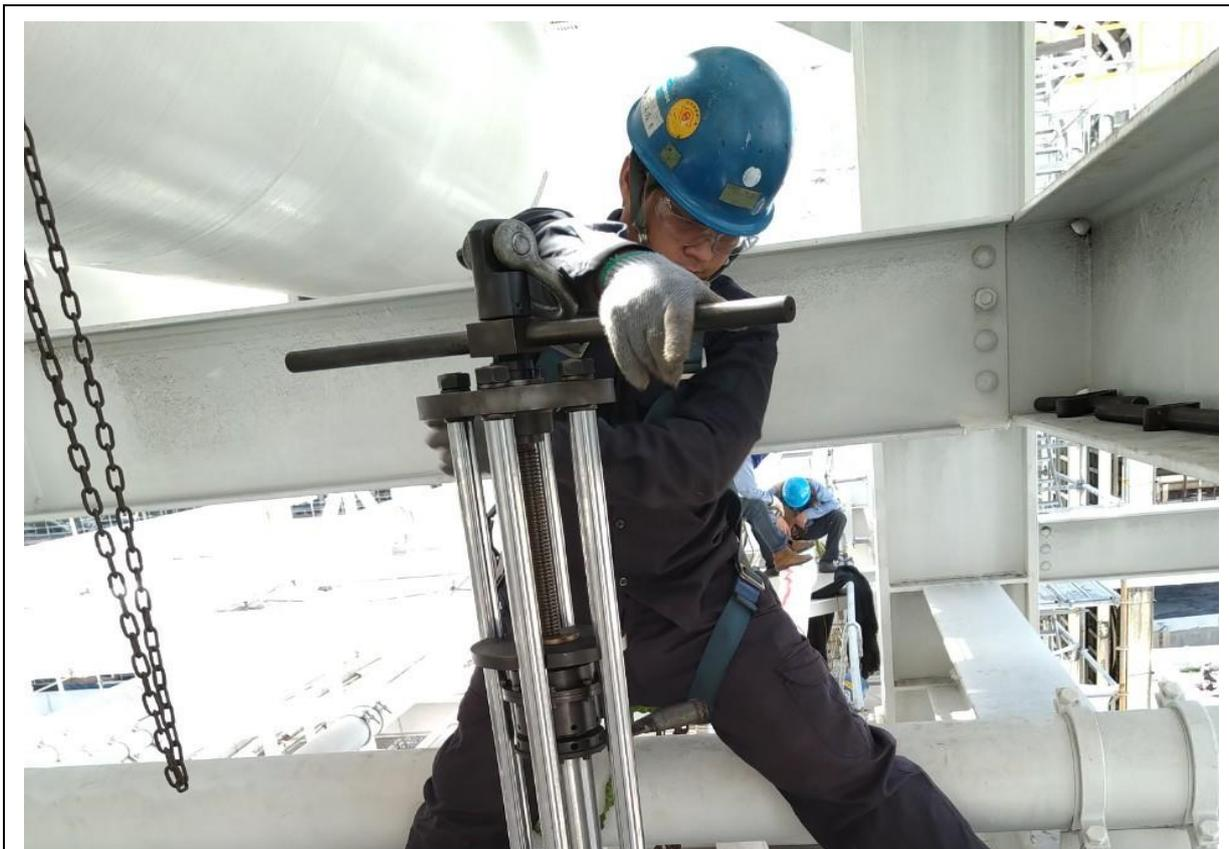
13. 管線換閥後，移除阻斷器進行下堵作業
