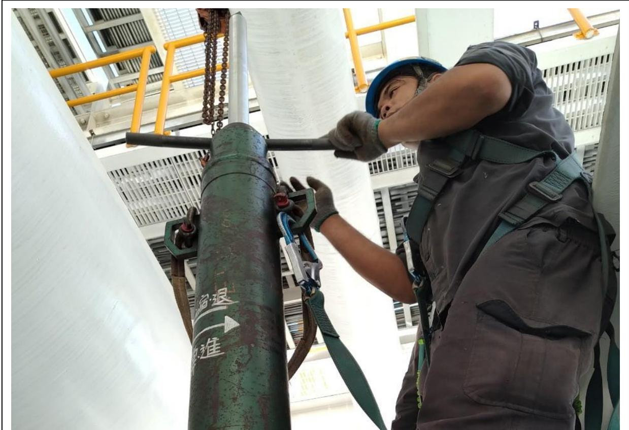
11. 人員操作阻斷機進行阻斷作業
