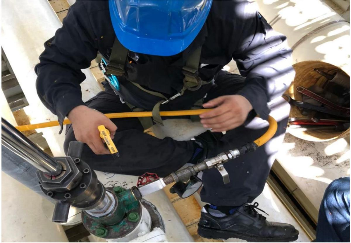
3. 開孔機具安裝及試壓作業(2'')
