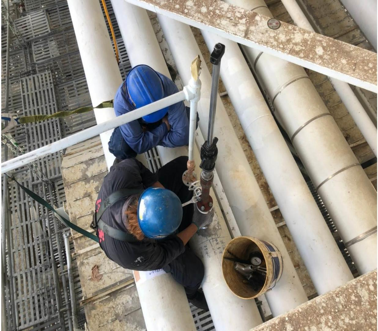
工程名稱：中部石化廠 8 吋廢水管線阻斷作業及活水開孔作業
