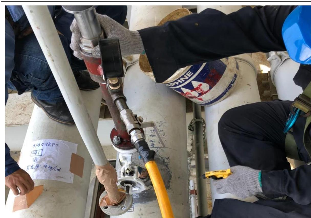
1. 開孔機具安裝及試壓作業(1'')
