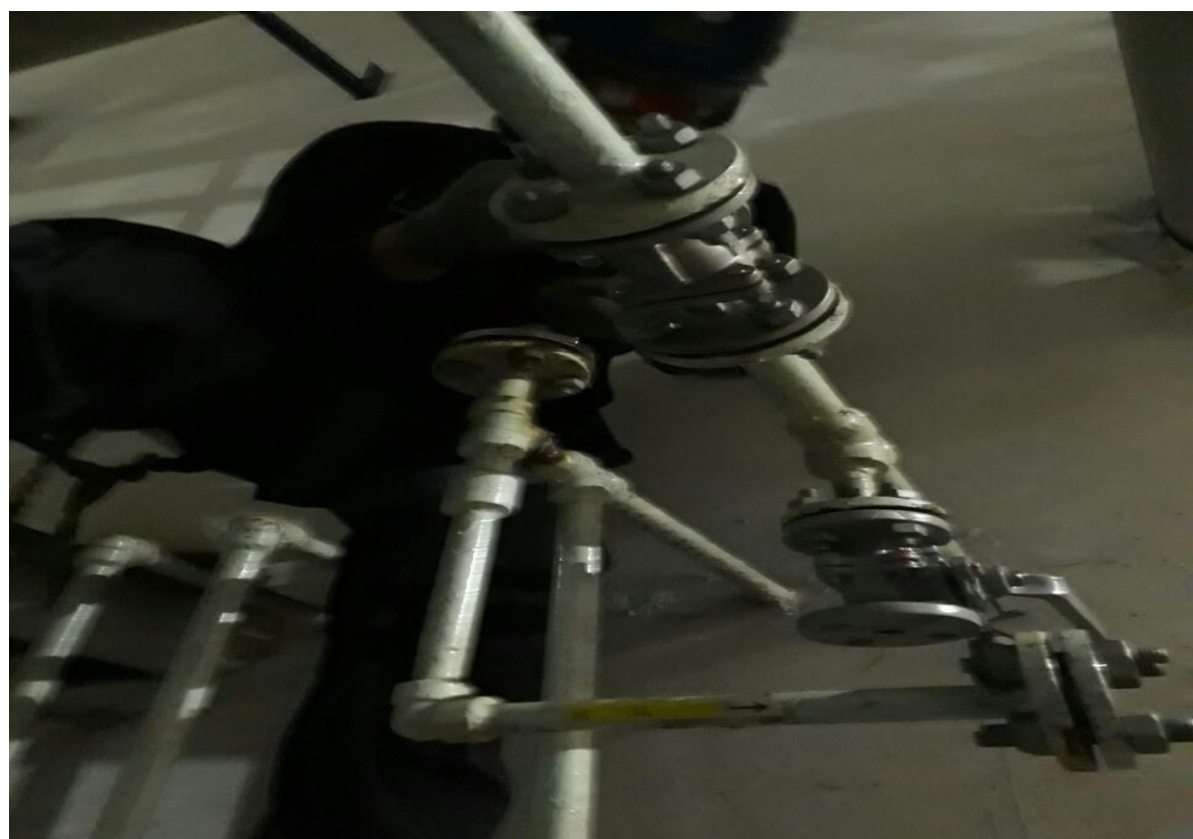
10. 閥件移除更換作業完成
