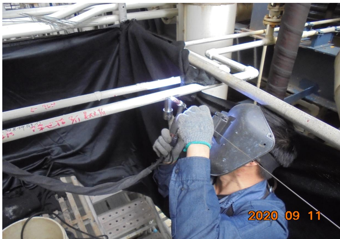
1. 阻斷位置焊接情形
