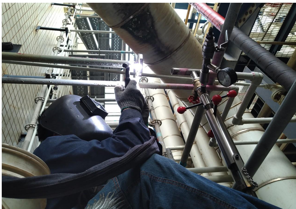
6. 阻斷完成後切管焊法蘭作業
