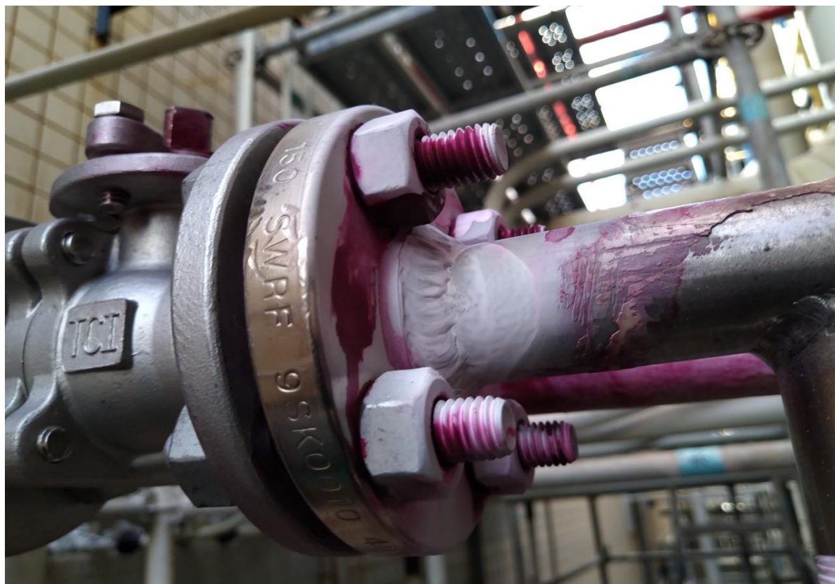
7. 新增閥件完成
