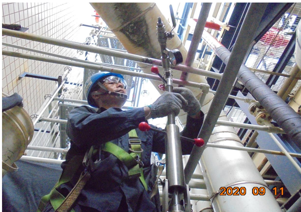
5. 開孔完成進行阻斷作業
