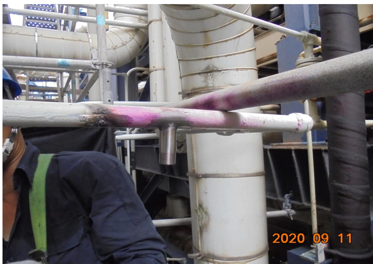
2. 阻斷焊接完成並進行液慎檢查
