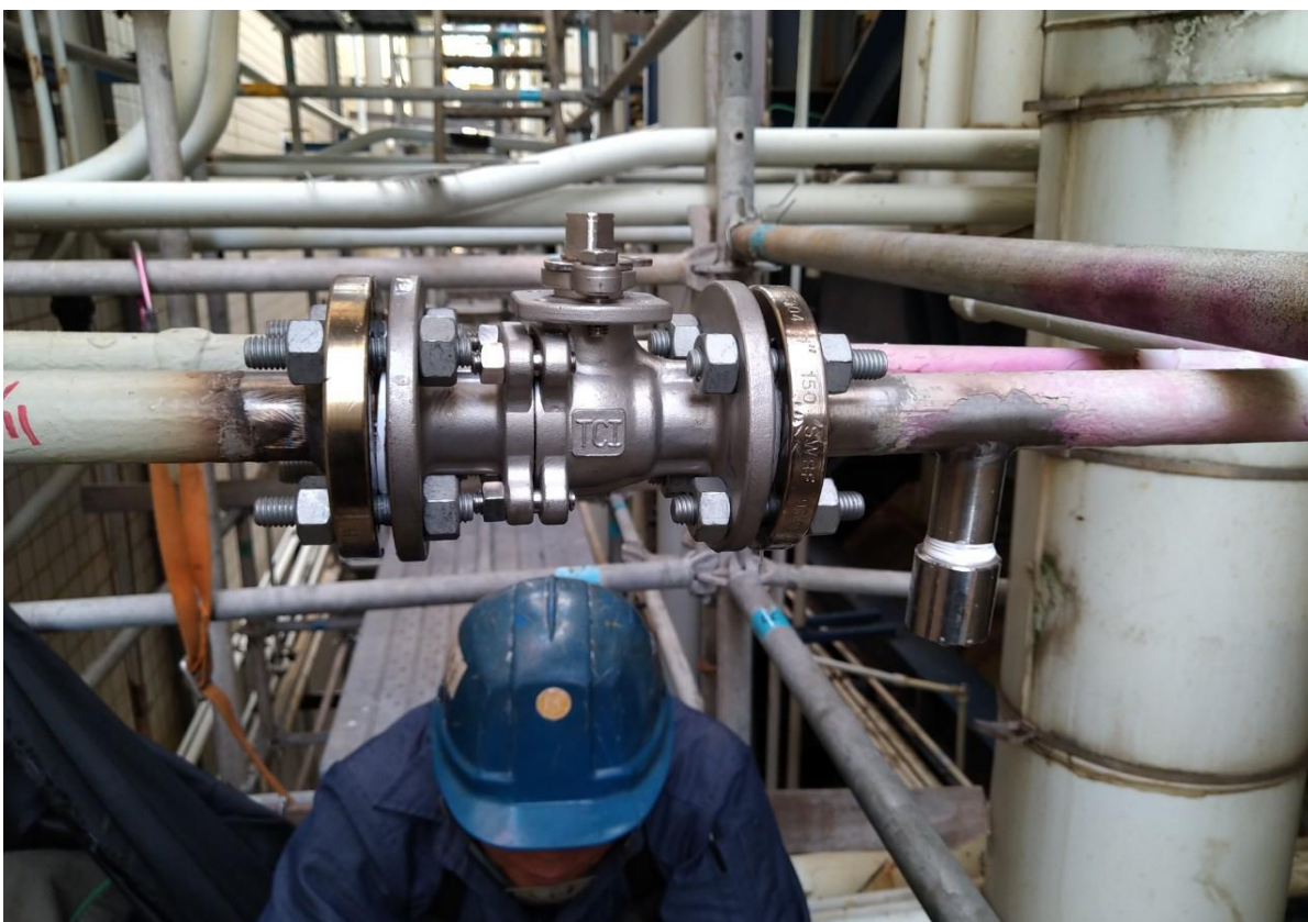
12. 線上阻斷工程施工完成
