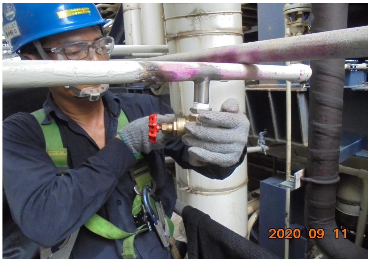
3. 閘閥安裝作業
