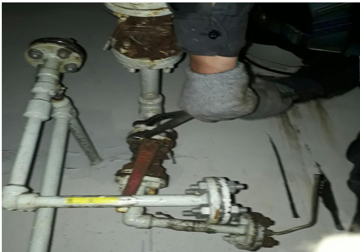
9. 閥件移除更換作業
