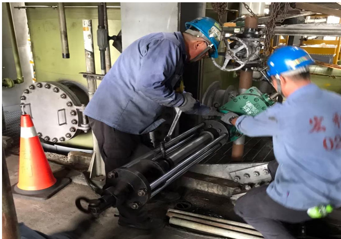
5. 管線換閥後，移除阻斷器進行下堵作業
