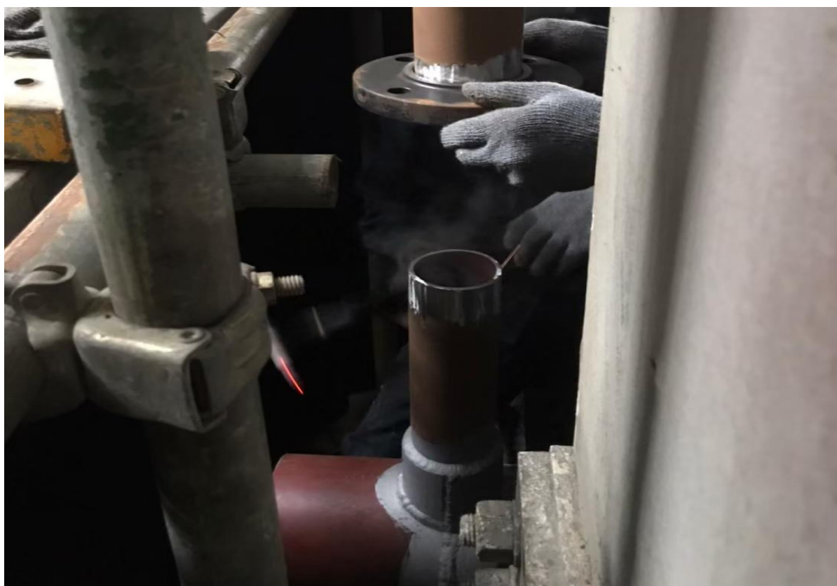
4.阻斷作業完成後進行切管焊法蘭作業
