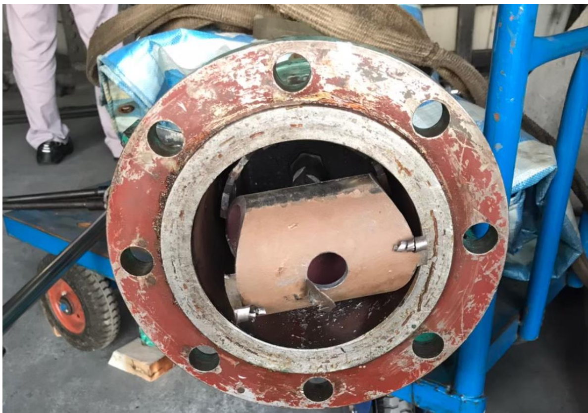
3.開孔完成，確認斷管料塊取出
